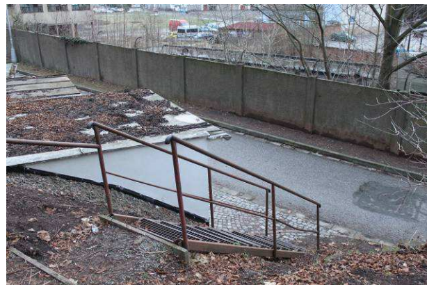
Schodiště z ulice Příkopy.
