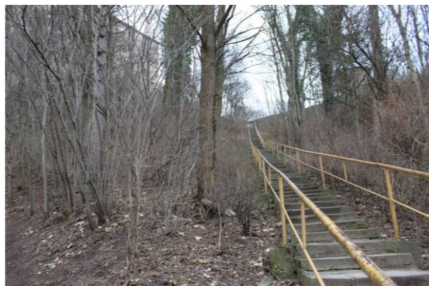
Stávající schodiště jdoucí torzem lipové aleje.
