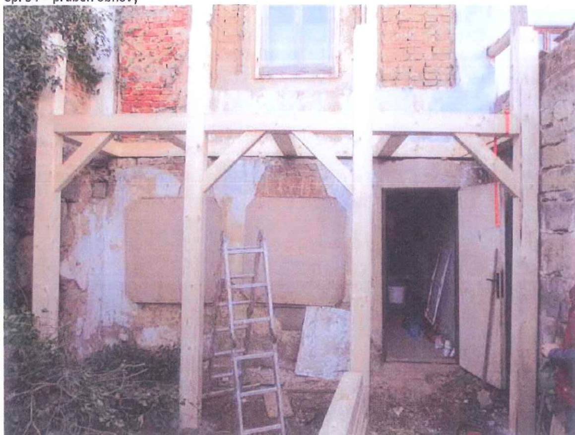
Čp. 34 – průběh obnovy
