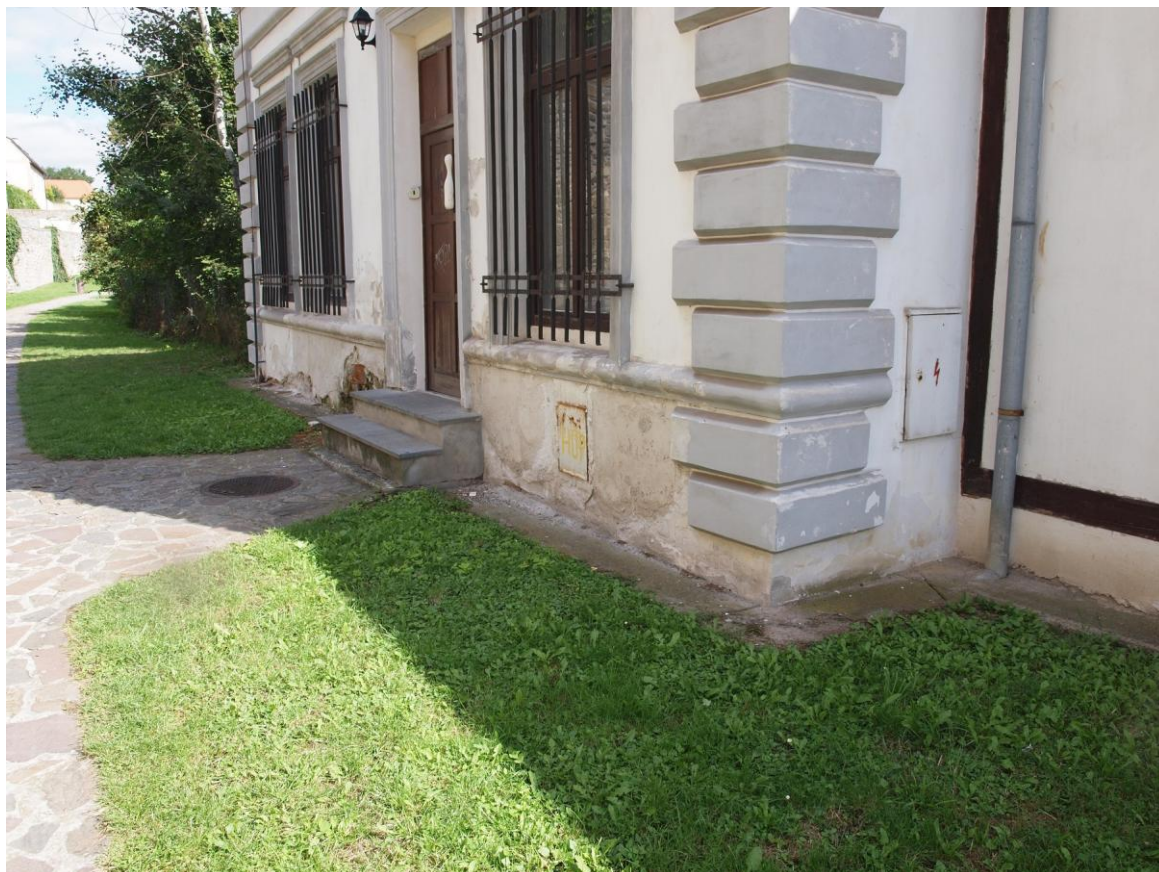
Kadaň, kuželna před opravou a po opravě
