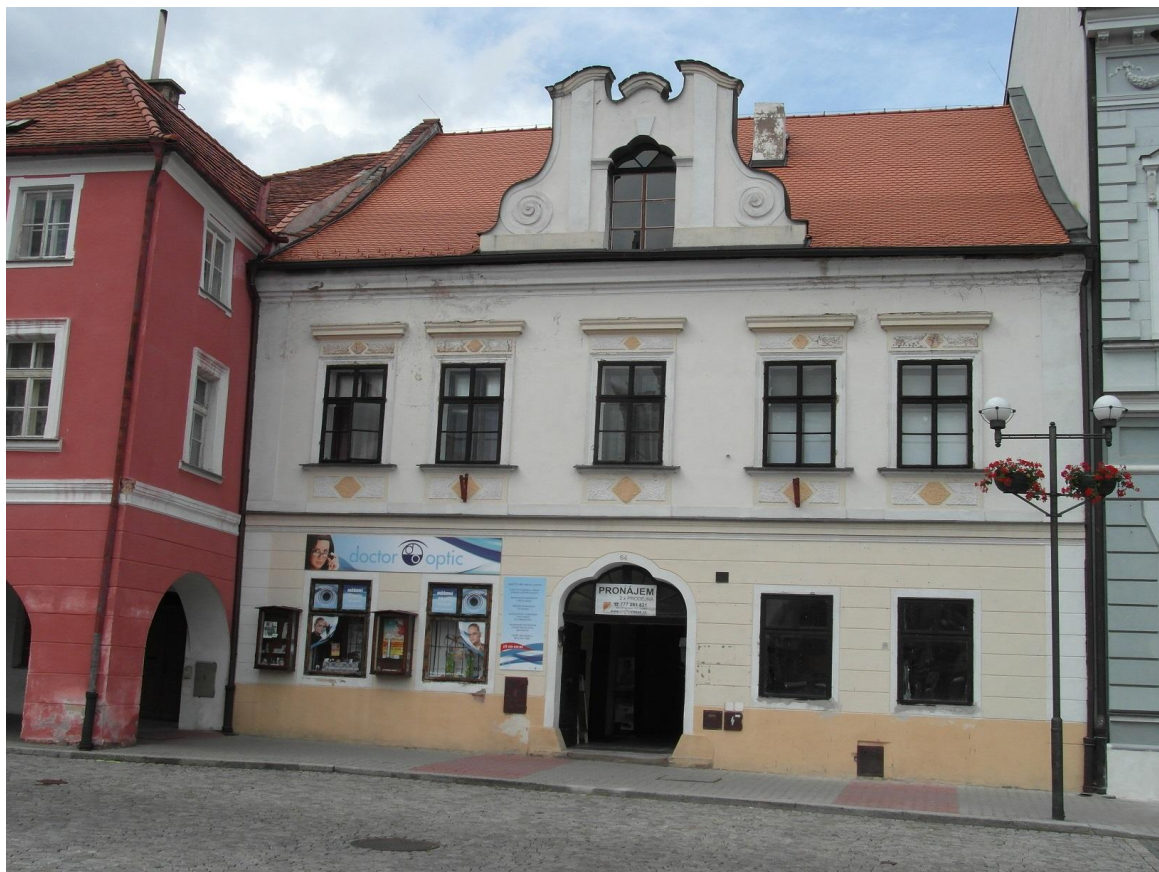
Kadaň, čp. 64 před opravou fasády a po opravě
