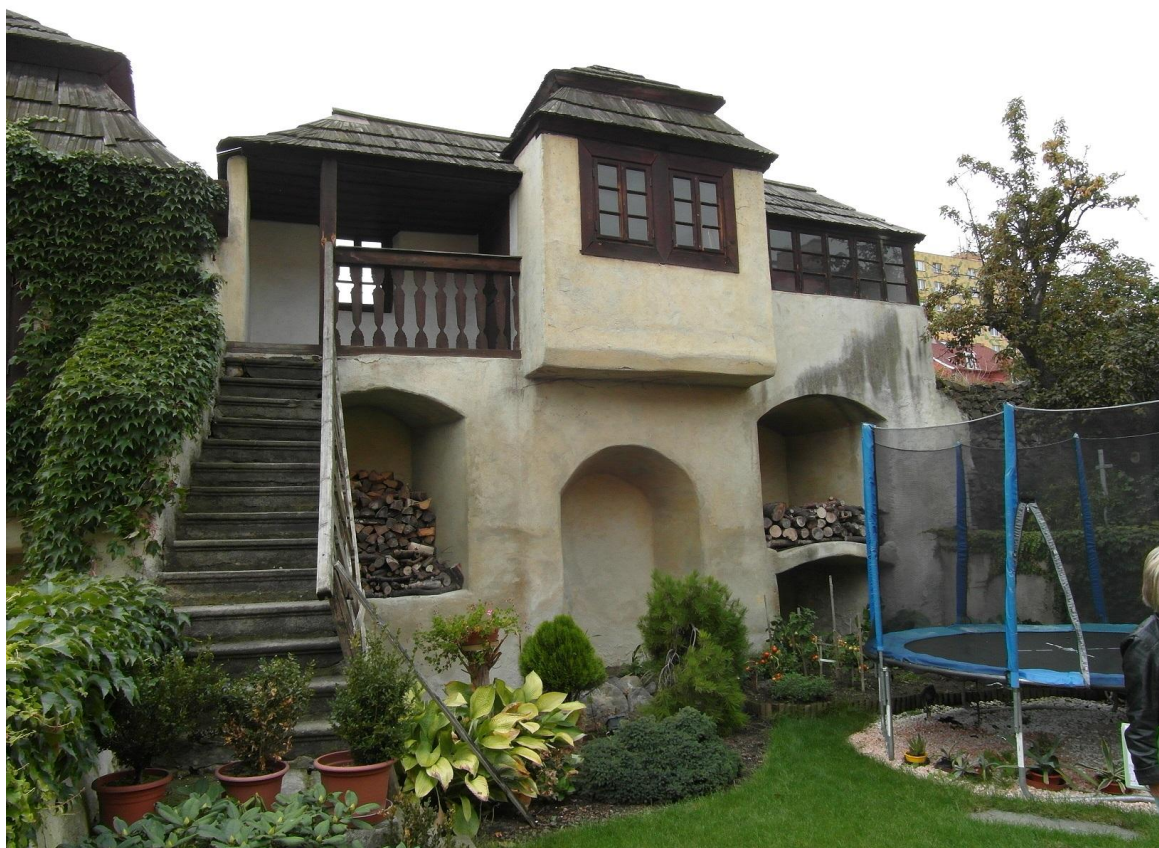
Kadaň, tzv. ptačí domek u čp. 159 před a po opravě
