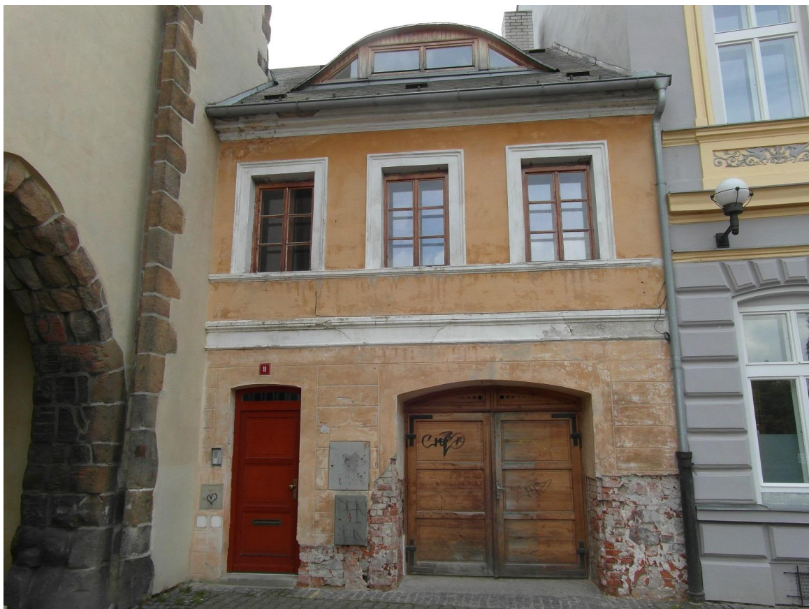
Kadaň, čp. 19 před opravou fasády a po opravě
