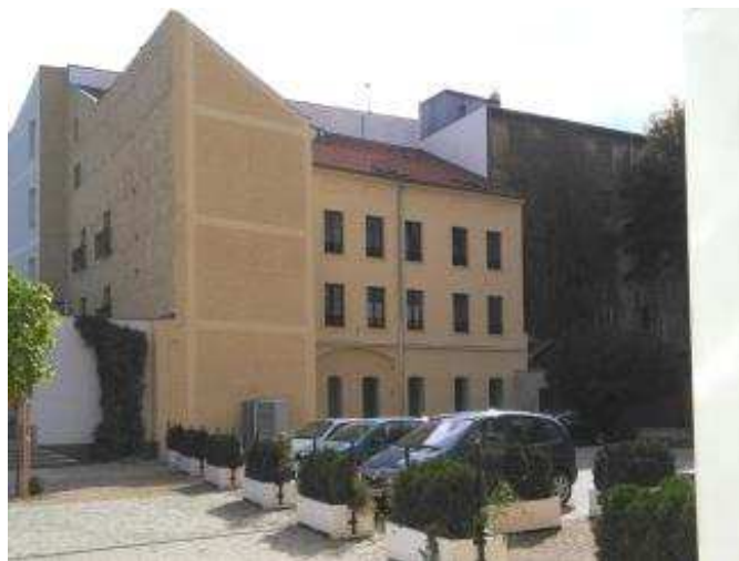
Obrázek 10: Obnova objektu na st. p. č. 348/2 k. ú. Žatec
