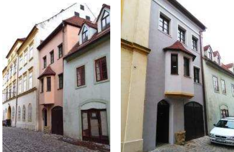
Obrázek 12: Dům čp. 96 Žatec před obnovou fasády a po obnově fasády
