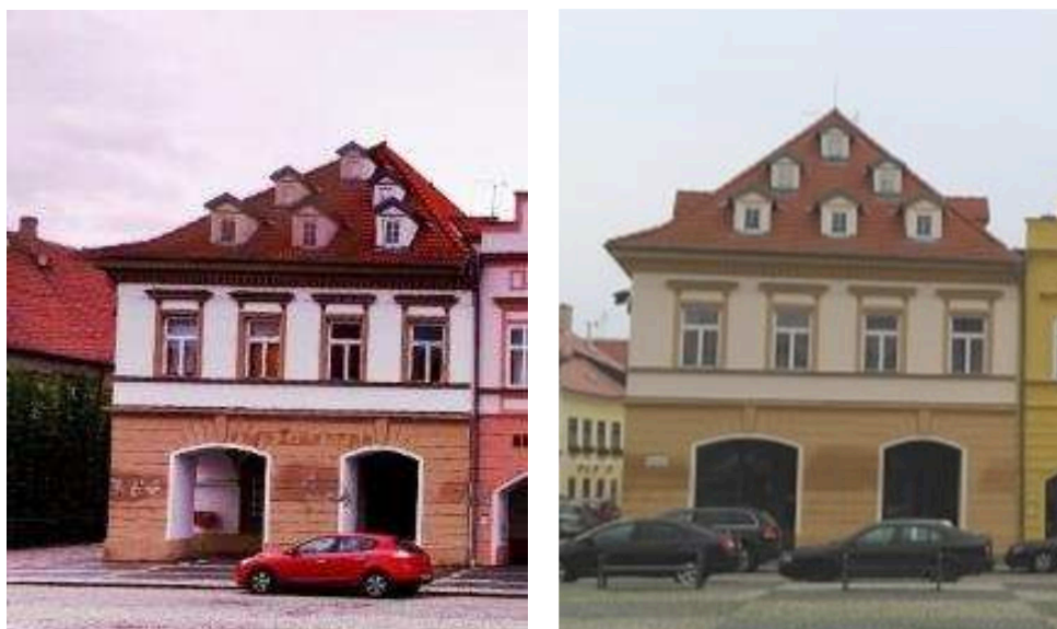
Obrázek 6: Dům čp. 149 před obnovou a po obnově
