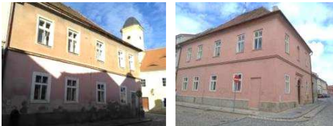
Obrázek 8: Dům čp. 152 Žatec před obnovou a po obnově
