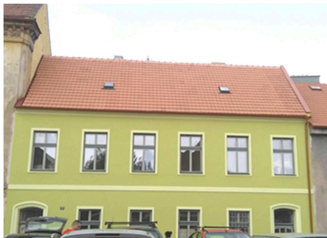
Obrázek 11: Dům čp. 148 Žatec po obnově střešní krytiny
