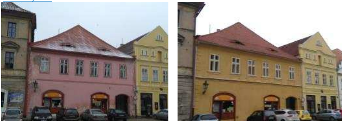
Obrázek 5: Dům čp. 137 Žatec před obnovou a po obnově
