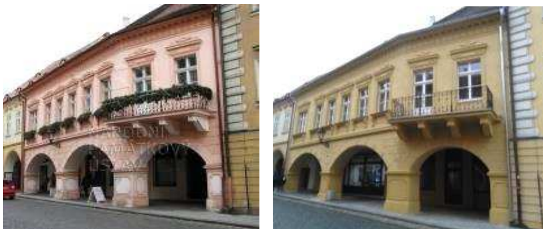
Obrázek 1: Dům čp. 8 Žatec před obnovou a po obnově
