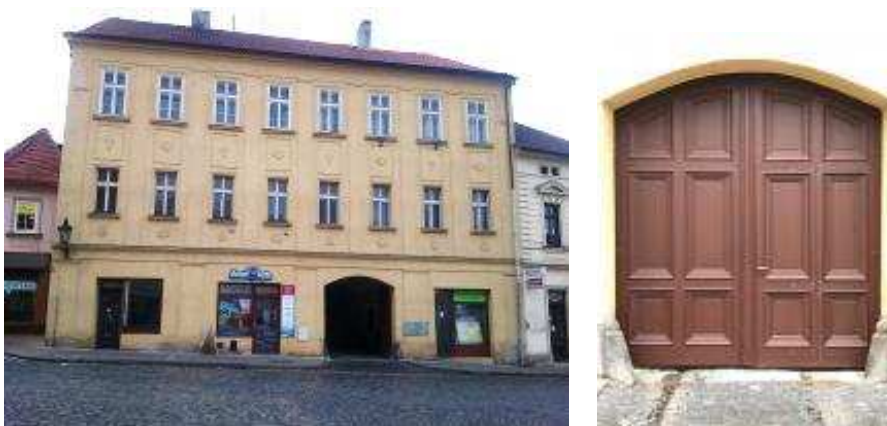
Obrázek 13: Bytový dům čp. 353 Žatec s detailem obnovy vstupních vrat
