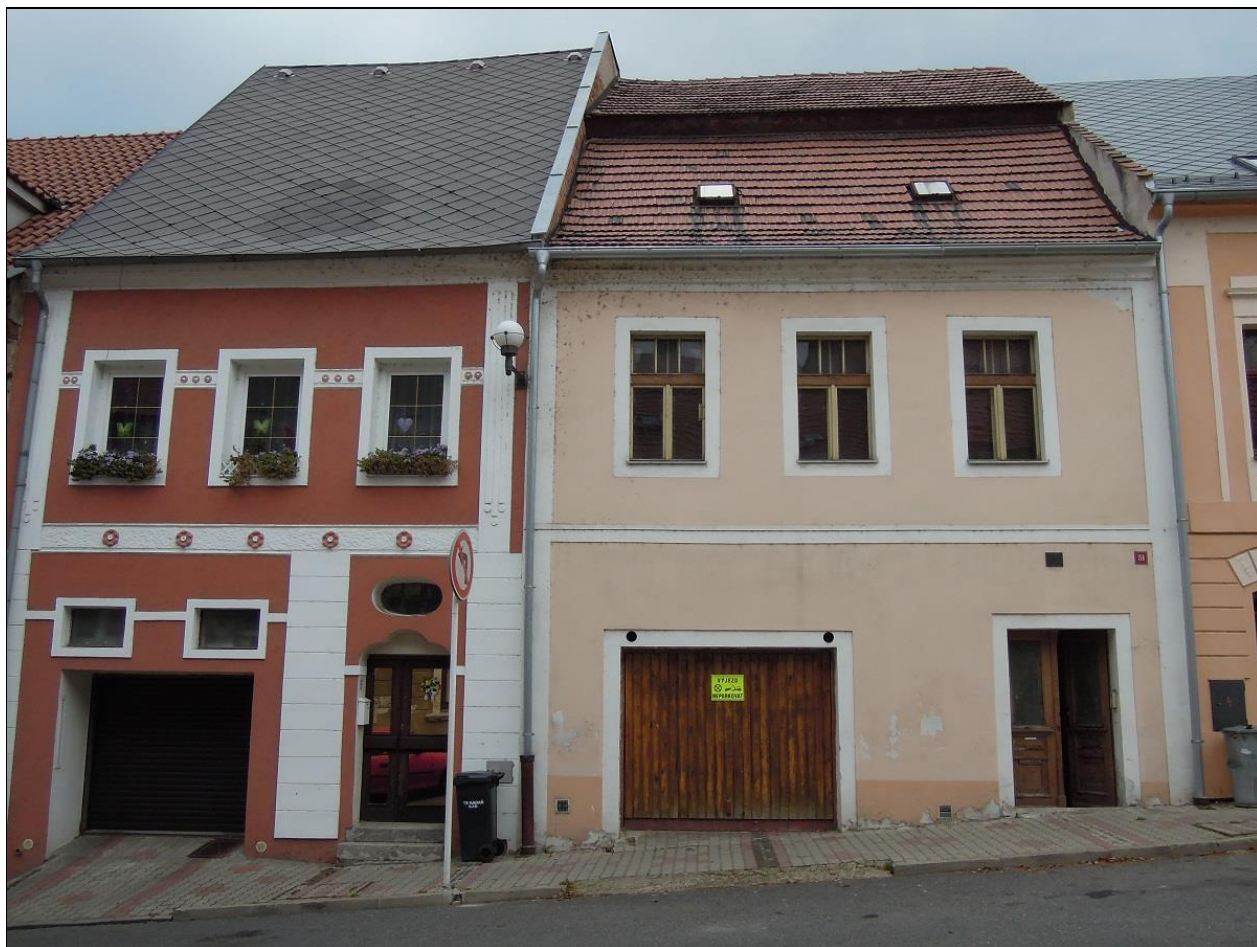
Kadaň, čp. 156 – výměna střešní krytiny – před opravou
