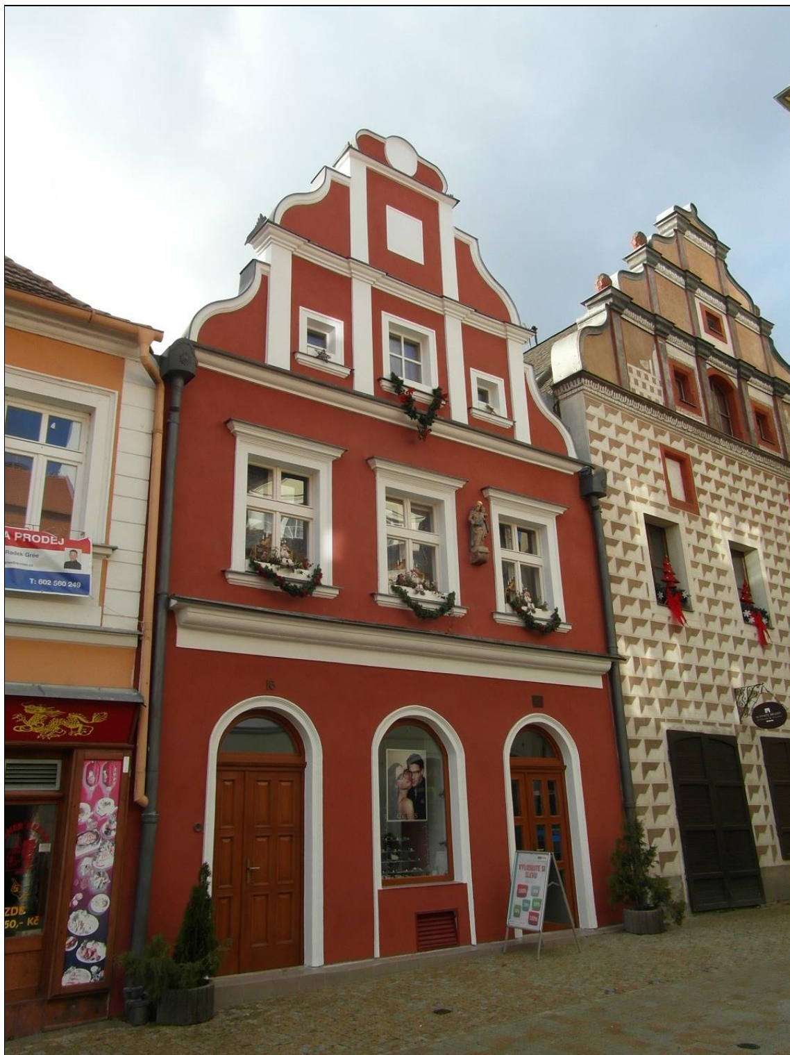
Kadaň, čp. 16 oprava fasády – po opravě
