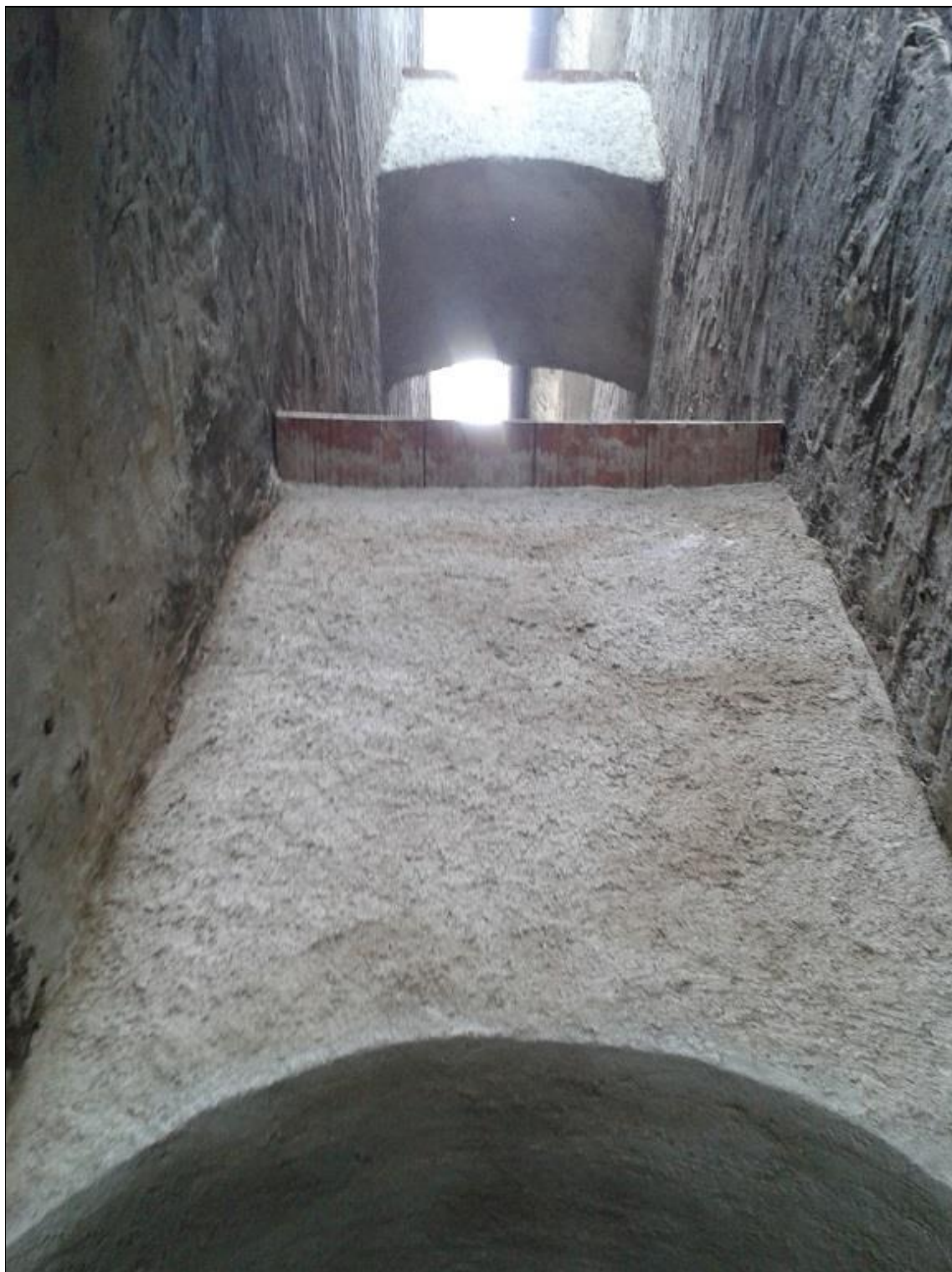
Katova ulička – oprava prampouchů a výměna pouličního osvětlení – po opravě
