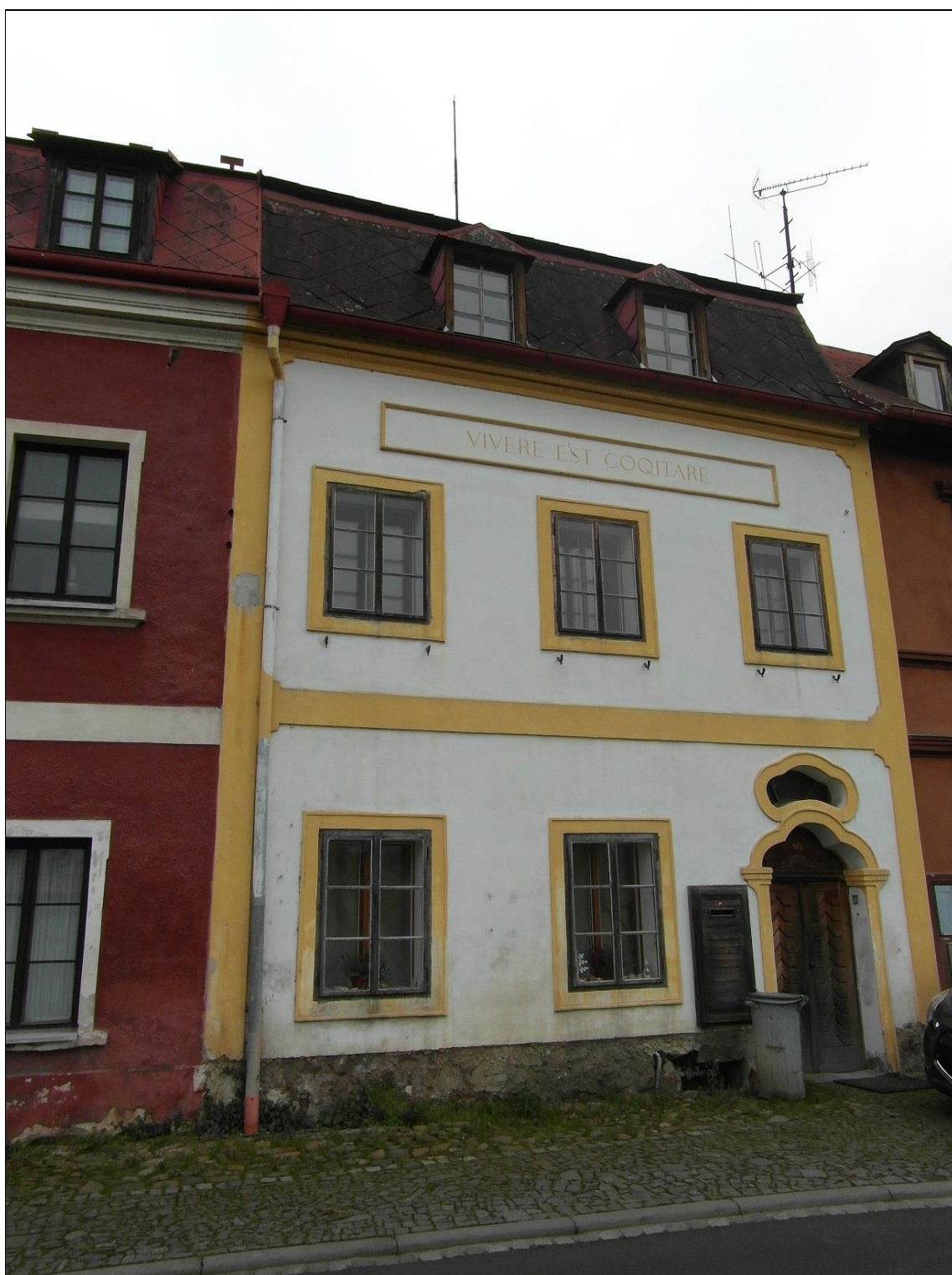
Kadaň, čp. 478 – oprava fasády a výměna vnějších křidel – před opravou
