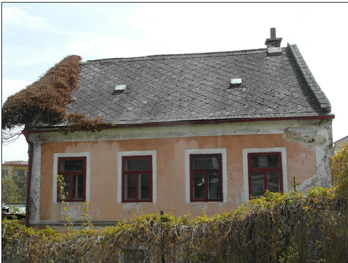
Kadaň, čp. 542 – výměna střešní krytiny
