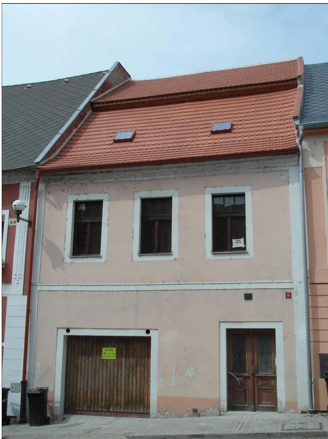
Kadaň, čp. 156 – výměna střešní krytiny – po opravě
