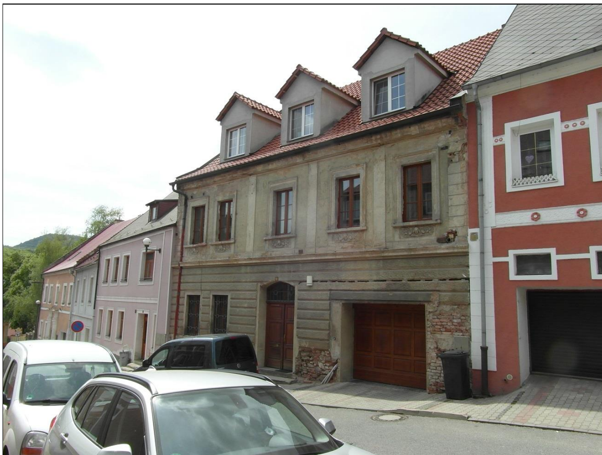
Kadaň, čp. 152 – oprava fasády
