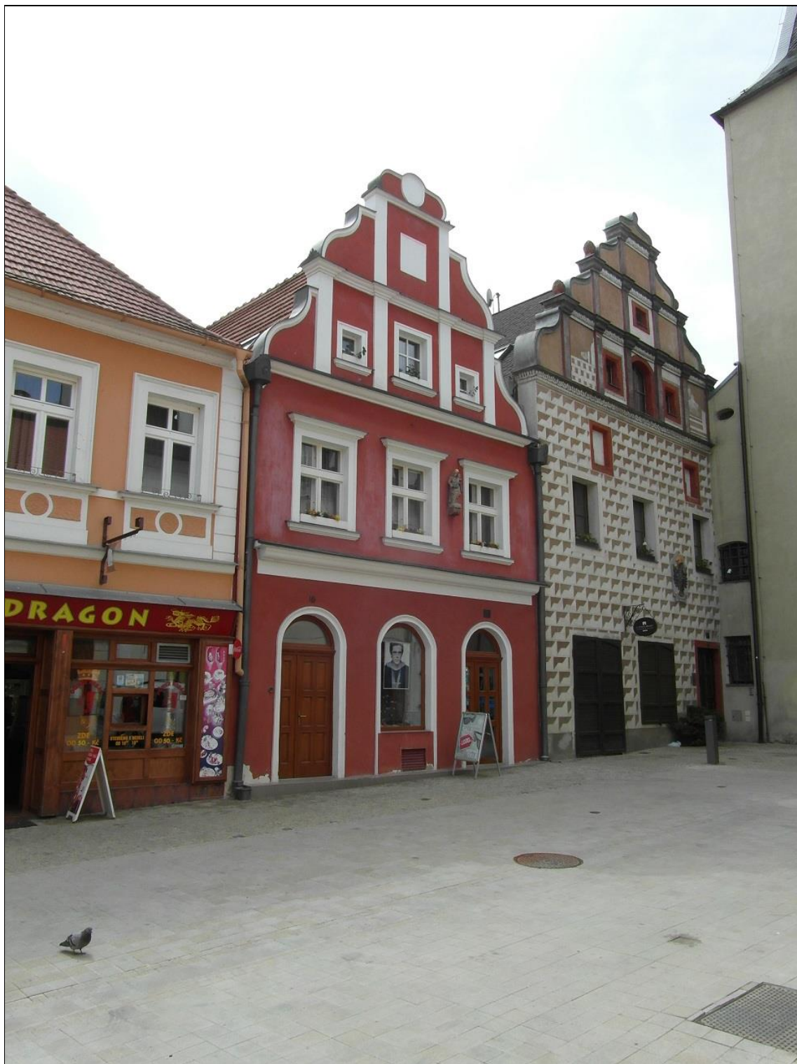
Kadaň, čp. 16 oprava fasády – před opravou
