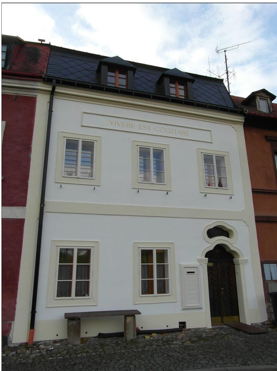
Kadaň, čp. 478 – oprava fasády a výměna vnějších křidel – po opravě
