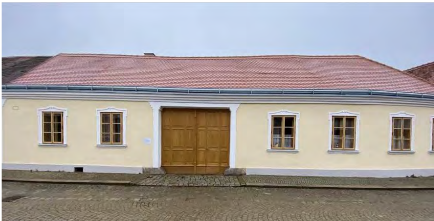
Venkovská usedlost čp. 53, ul. Zachariášova - Obnova truhlářských prvků vnějšího pláště budovy – oprava a výměna oken a vrat – pohled z ulice
