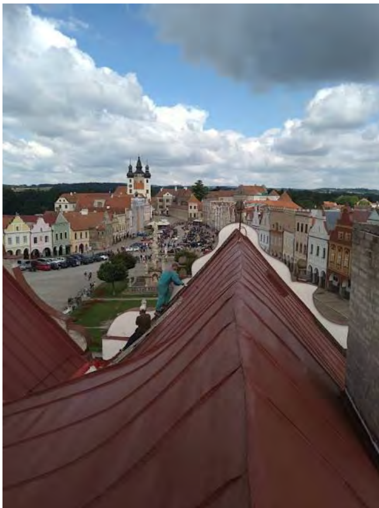
Obnova střešního pláště domu č.p. 41, nám. Zachariáše z Hradce
