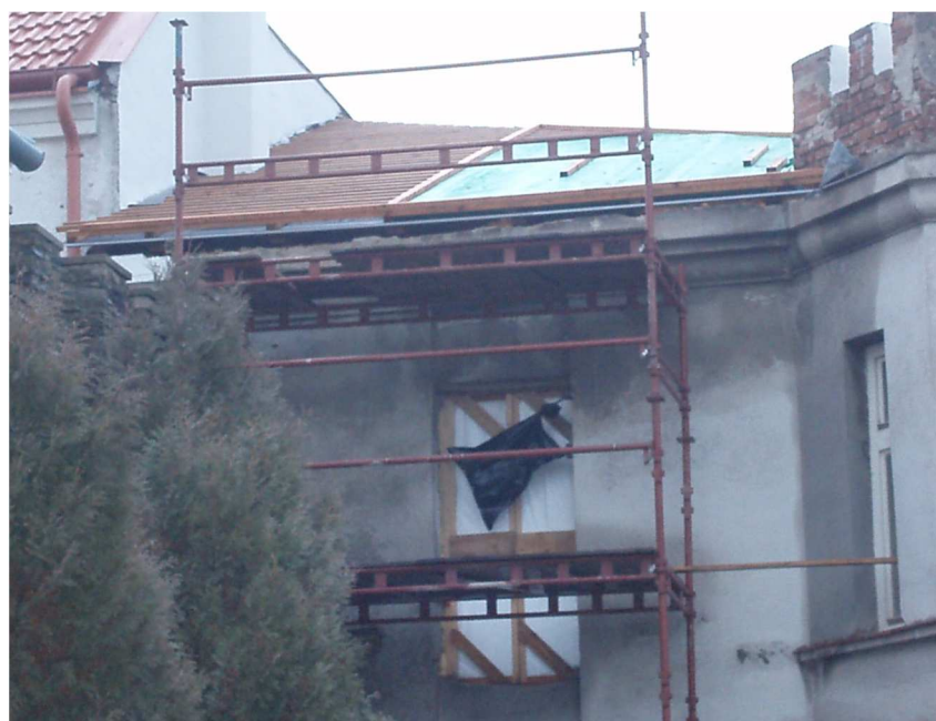
Probíhající rekonstrukce v roce 2021
