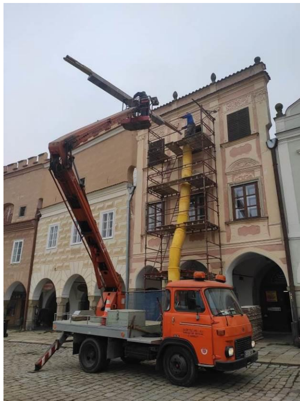
Měšťanský dům čp. 53, Nám. Zachariáše z Hradce – Obnova střešního pláště domu – výměna krytiny, oprava a výměna tesařských a klempířských prvků včetně světlíků a další související práce. Celkové náklady na obnovu památky 952 tis. Kč. Z Programu regenerace 440 tis. Kč.
