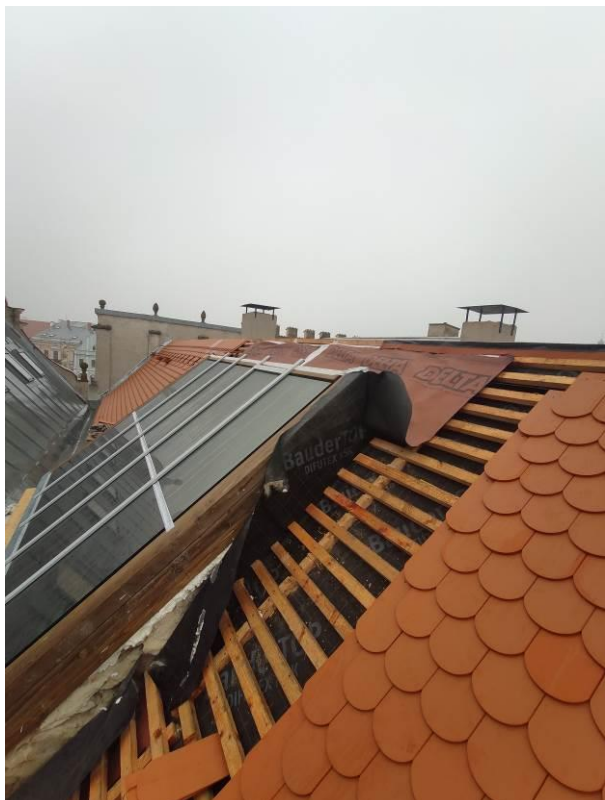
Měšťanský dům čp. 53, Nám. Zachariáše z Hradce – Obnova střešního pláště domu – výměna krytiny, oprava a výměna tesařských a klempířských prvků včetně světlíků a další související práce. Celkové náklady na obnovu památky 952 tis. Kč. Z Programu regenerace 440 tis. Kč.
