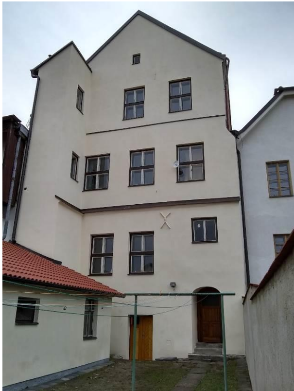
Měšťanský dům čp. 47, Nám. Zachariáše z Hradce – Obnova vnějšího pláště domu – oprava fasády (do dvora) včetně klempířských prvků, výměna vstupních dveří do sklepa a další související práce. Celkové náklady na obnovu památky 599 tis. Kč. Z Programu regenerace 200 tis. Kč.
