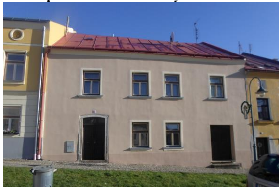
obytný dům, Karlovo náměstí č.p. 527 – obnova fasády
