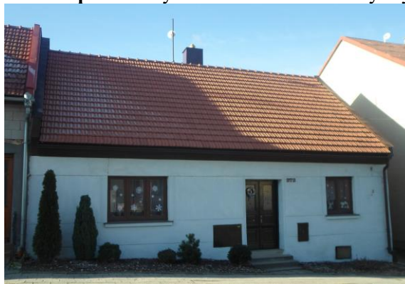
obytný dům, ulice Varhánkova č.p. 272 – výměna krovu a střešní krytiny
