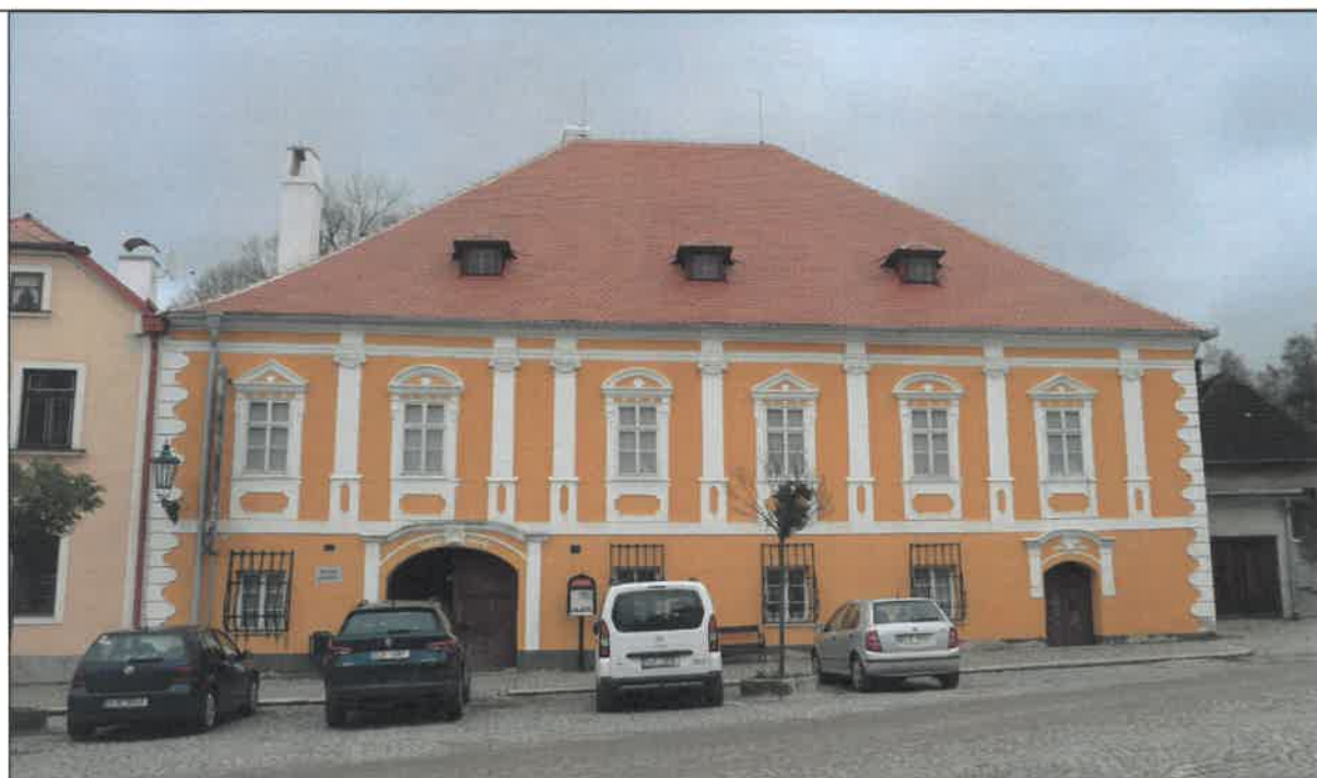
Rodný dům Josefa Hoffmanna po obnově střechy
