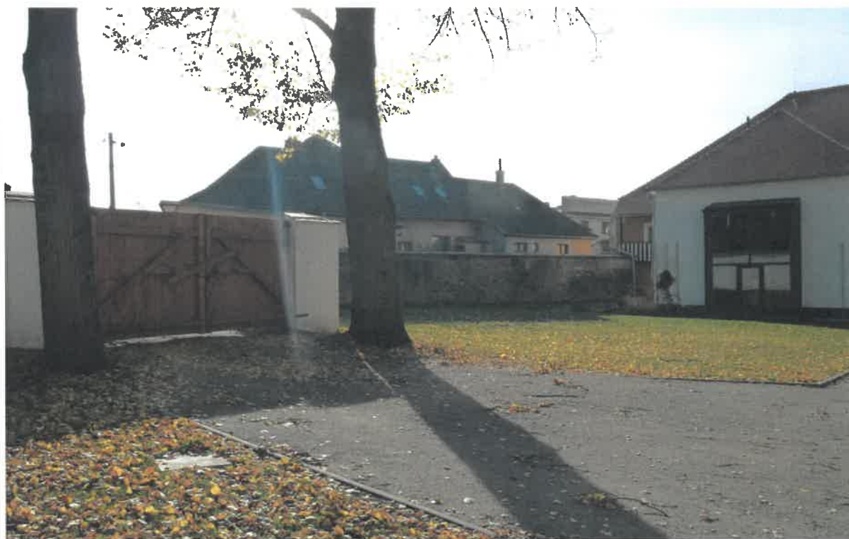
Dvůr Rodného domu J. Hoffmanna po odstranění nepůvodní budovy ze dvora
