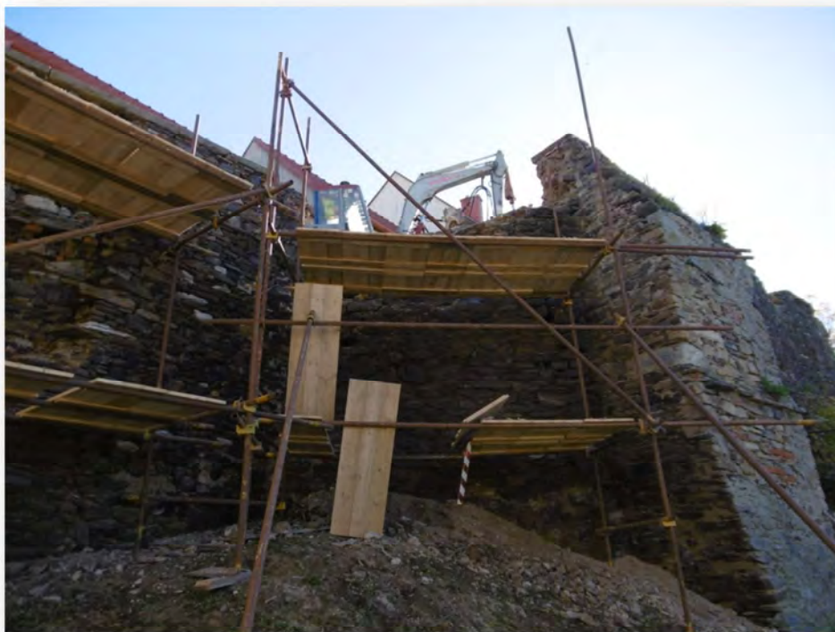
Obr. č. 1: rekonstrukce hradeb na Malé brance – 2017
