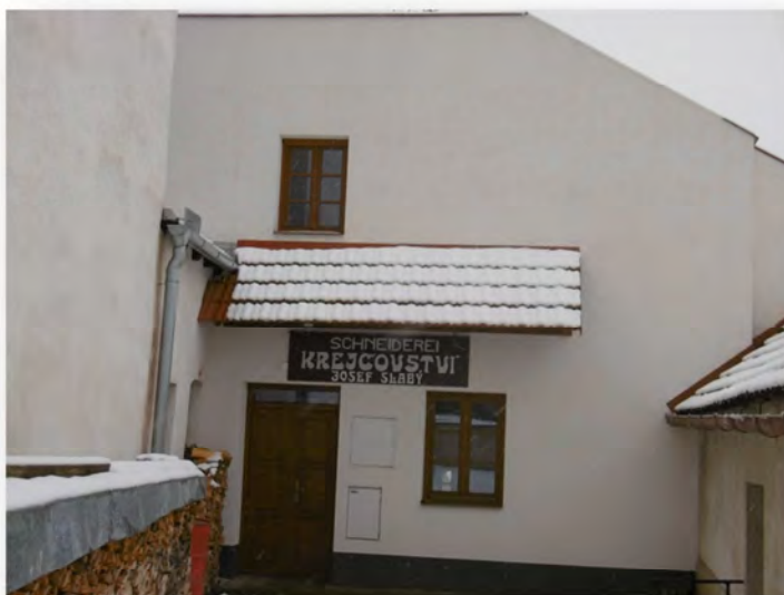
Obr. 7: citlivá rekonstrukce domu č. p. 163 v židovské čtvrti
