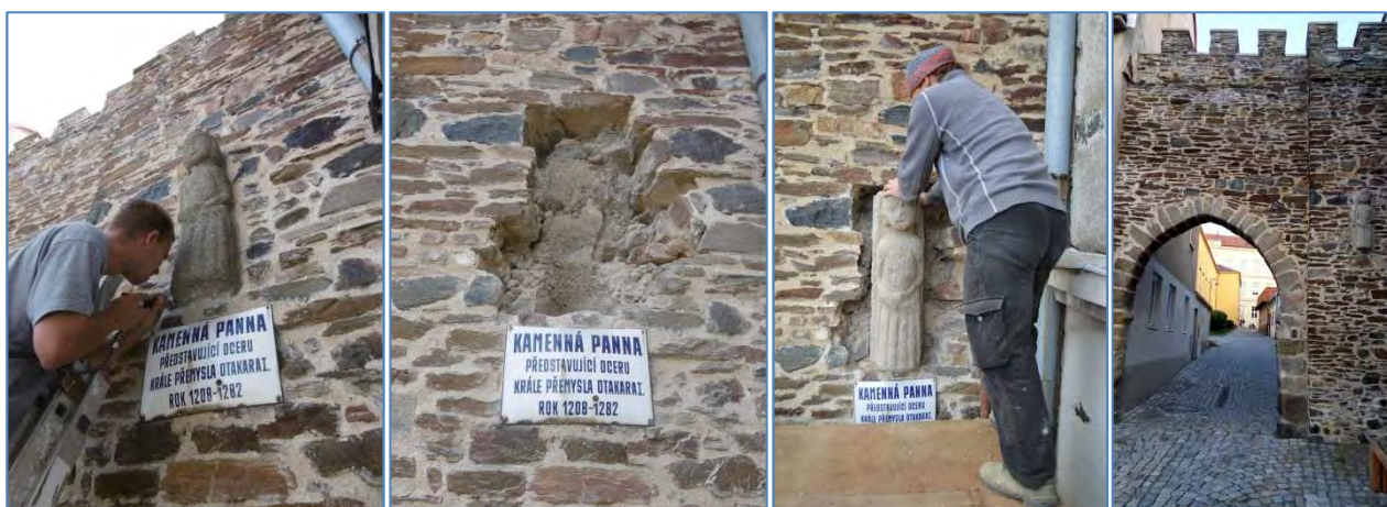
Obr. č. 4: Demontáž originálu Kamenné panny + montáž kopie
