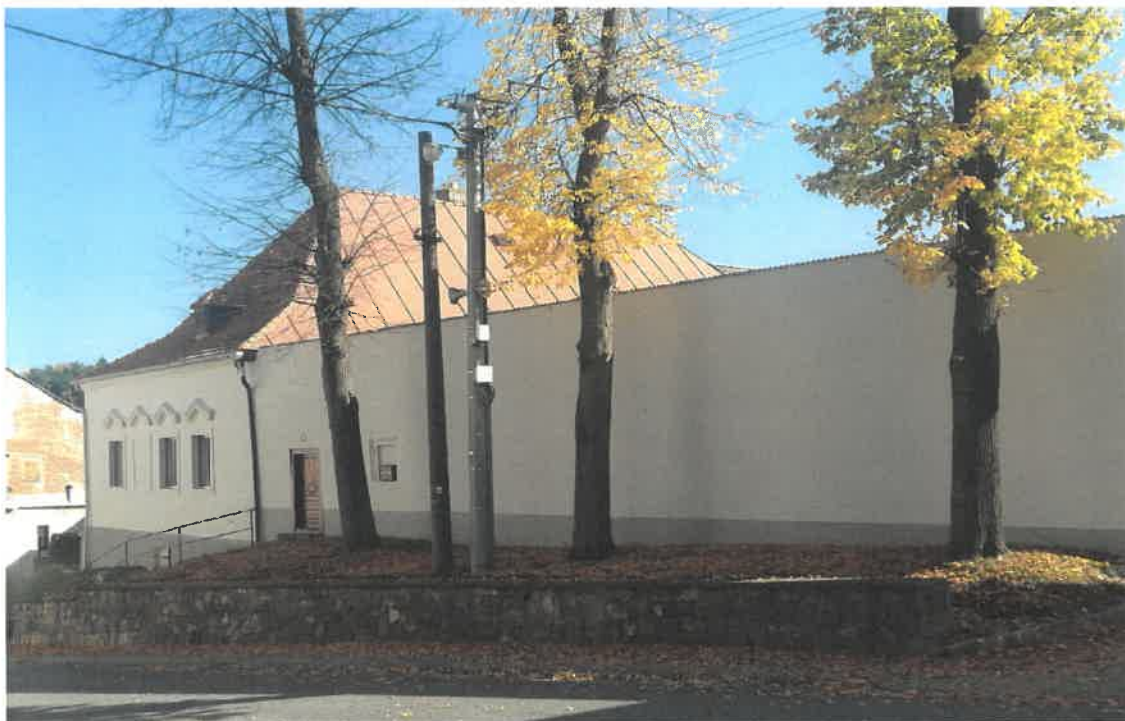
Dům č. p. 41 s obnovenou zdí a zhotovenými šambránami kolem oken (dle dobových fotografií)
