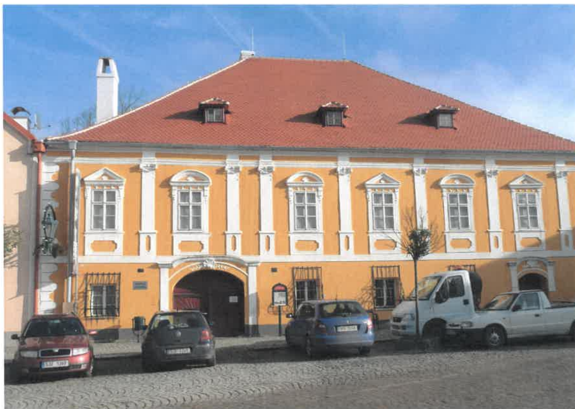
Rodný dům Josefa Hoffmanna po obnově střešní krytiny, komínů a výměně klempířských prvků.
