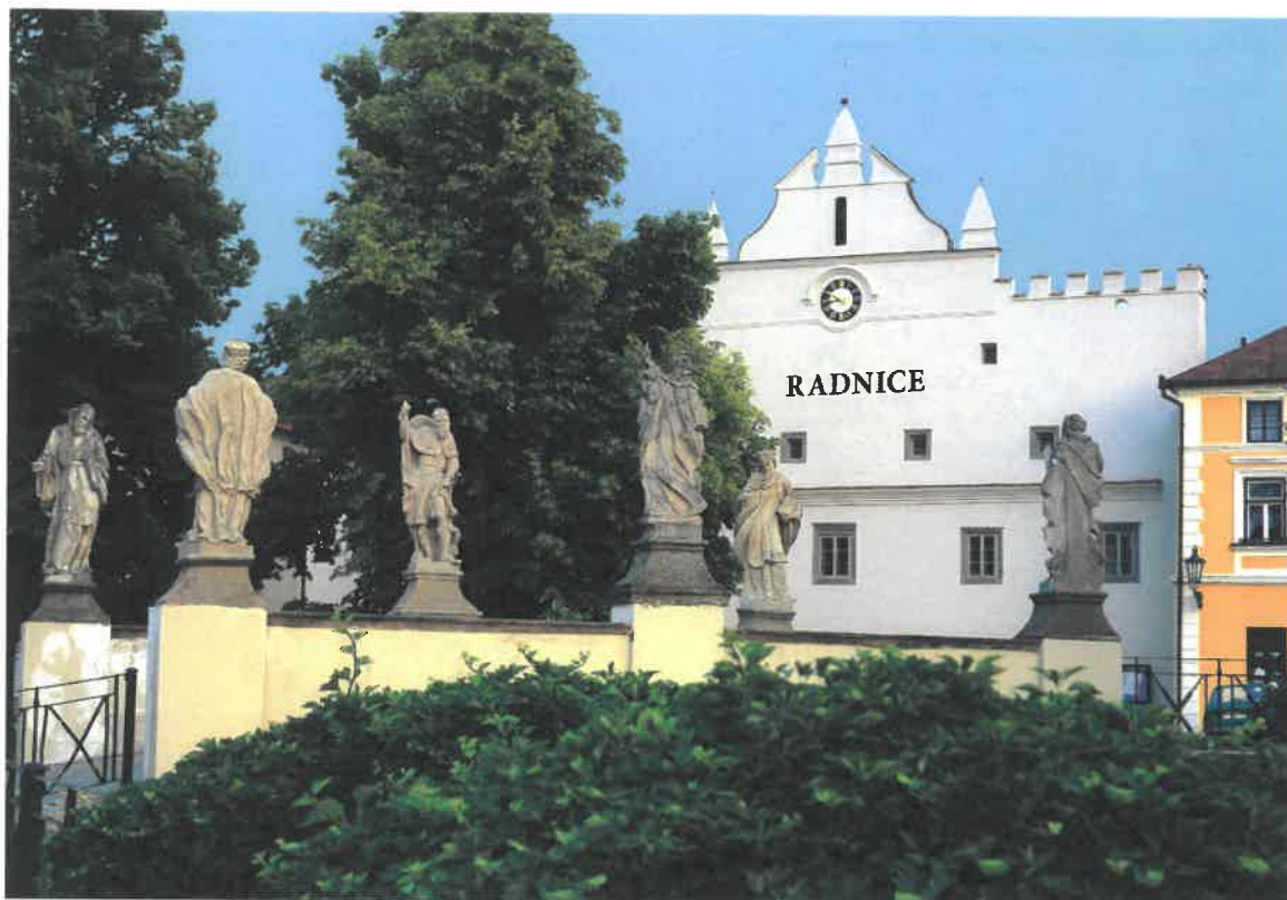
Budova radnice po obnově, v popředí most se sochami světců
