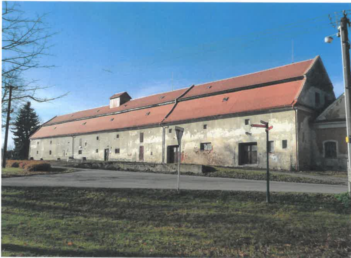
Panská sýpka s obnovenou střechou
