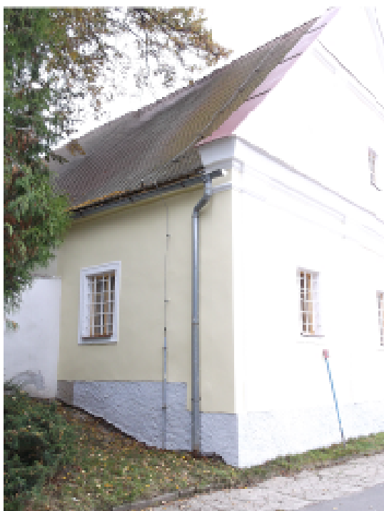
Část bočního průčelí do ulice – oprava realizována se štítem do ulice v roce 2016
