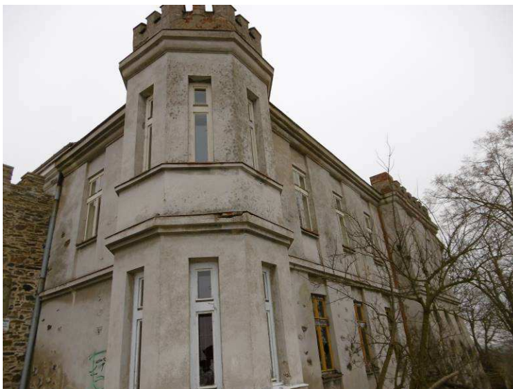
Foto č. 22 - dům č.p. 78 – Malá branka
