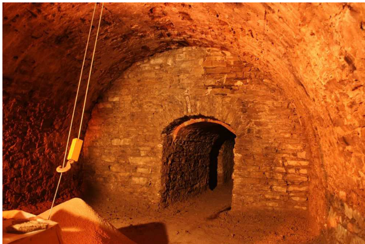
Foto č. 9 – podzemí pod kostelem svatého Víta
