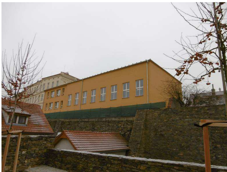
Foto č. 23 – nově zateplená budova ZŠ v Jemnici
