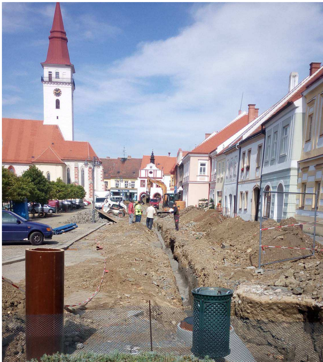
Foto č. 27 – projekt rekonstrukce kanalizace – Vodohospodářská infrastruktura, stavba Jemnice
