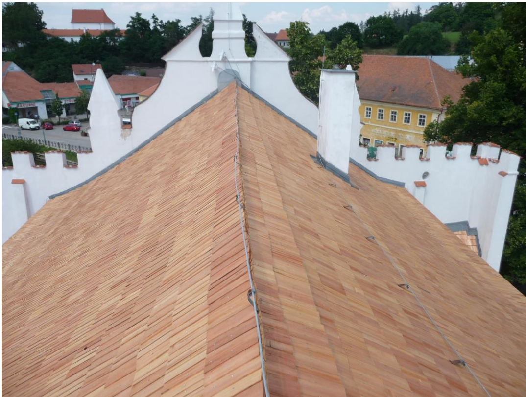
Šindelová střecha budovy radnice po rekonstrukci
