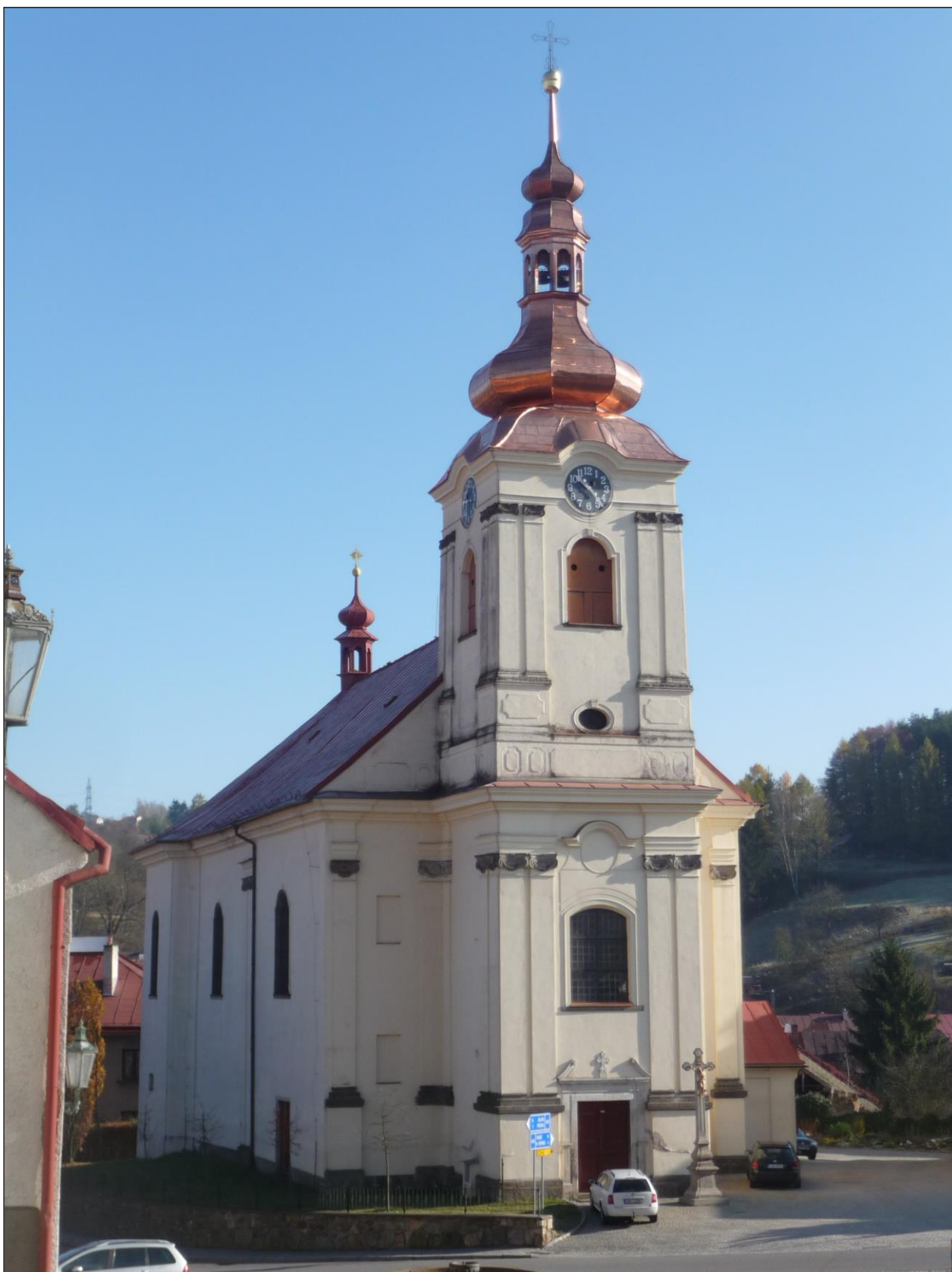
Kostel sv. Jakuba Většího po obnově věže kostela
