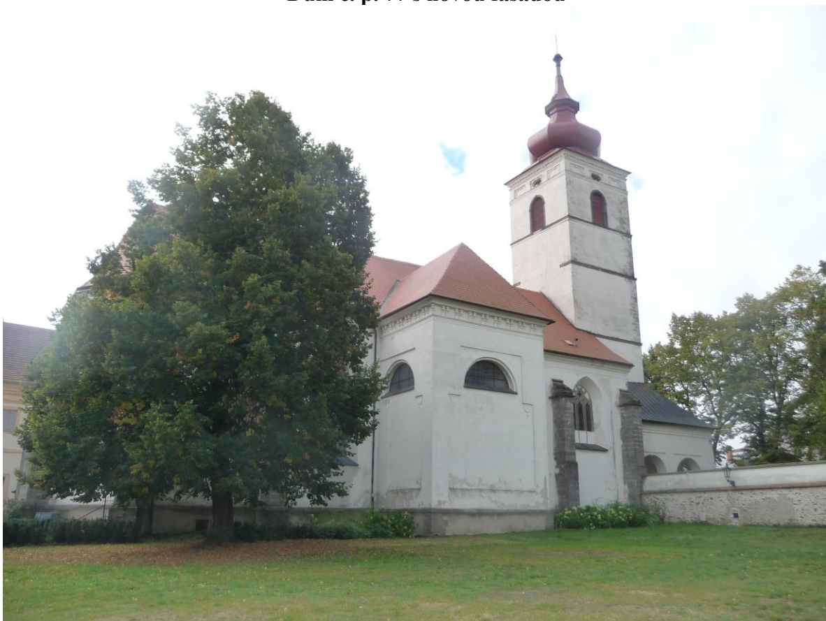
Zámecký kostel po čtyřleté obnově střechy
