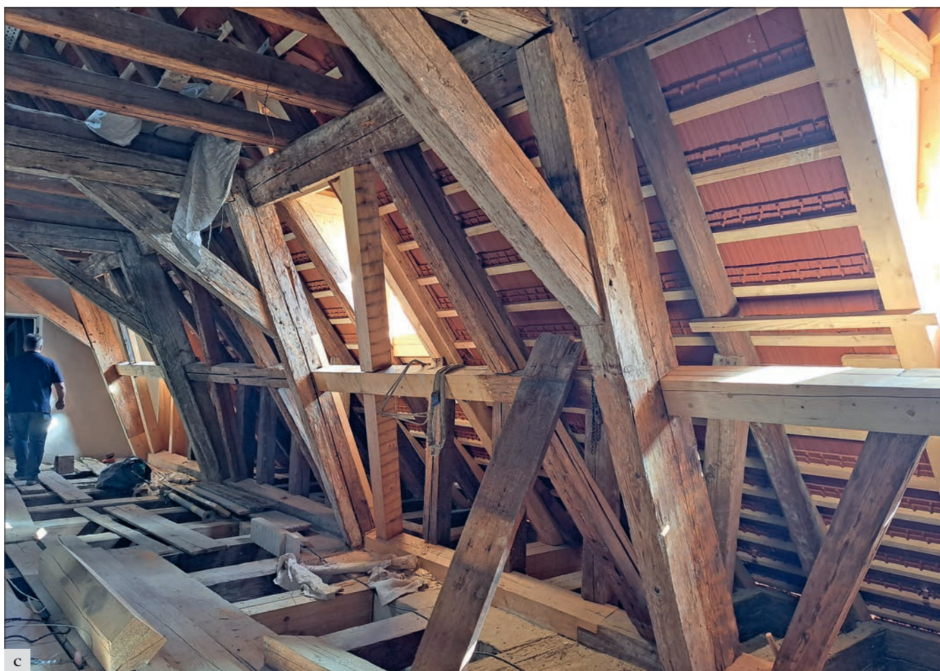
Horoměřice (správní obvod Praha západ), oprava barokního krovu a střešního pláště záměcku: a – celkový pohled na střechu z bobrovek; b – oplechování věžičky; c – práce v krovu (foto A. Musilová).
