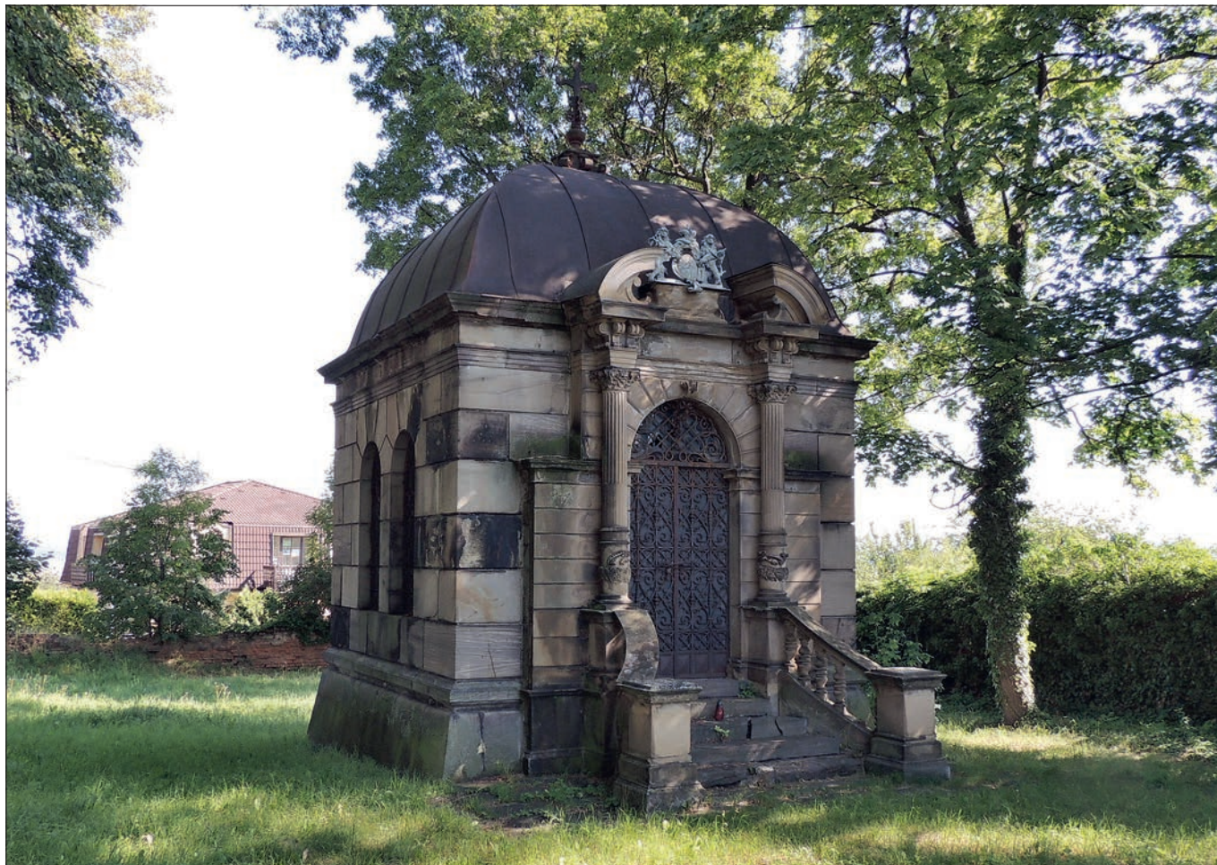
Hořovice-Velká Víska (okres Beroun), hrobka knížat z Hanau z let 1877–1879: Hrobka čtvercového půdorysu s výraznou zvoncovou střechou je vstupním průčelím orientována k jihu. Stavebním materiálem jsou žulové kvádry, doplněné pískovcovým schodištěm a portálem. Objekt člení vysoký, skarpovitě rozšířený sokl a korunní římsa s vlysem. Ve frontonu vstupního portálu je umístěn litinový erb rodu Hanavských. U sloupů nahrazuje akant okřídlená lebka a dřík je opatřen květinovou girlandou a pomačkanou stuhou. Vstupní portál i dvě dvojice oken na bočních stěnách uzavírají kvalitně provedené kované mříže. Na stavbě se kromě mříží zachovala řada původních hodnotných řemeslných prvků, mj. kazetová kupole, kamenické články a zasklení oken šestiúhelnými tabulkami (foto A. Jankulíková).
