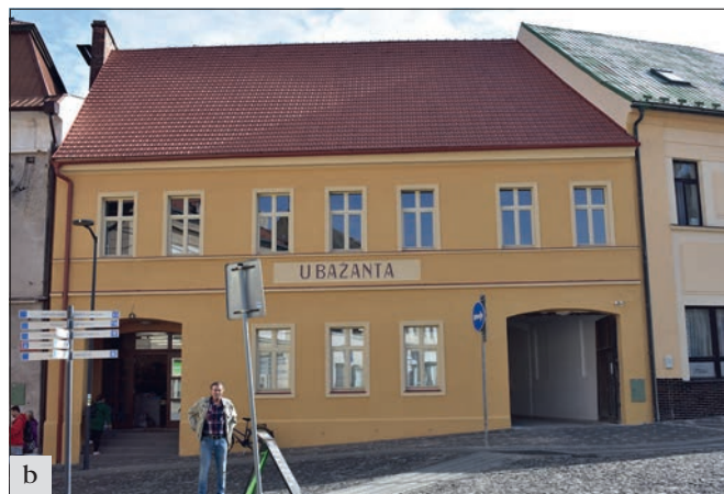
Mšeno (MPZ Mšeno), Náměstí Míru, dům čp. 21, dřívější hotel U Bažanta: a – původní stav; b – stav po rehabilitaci fasády (foto P. Kalinová).
