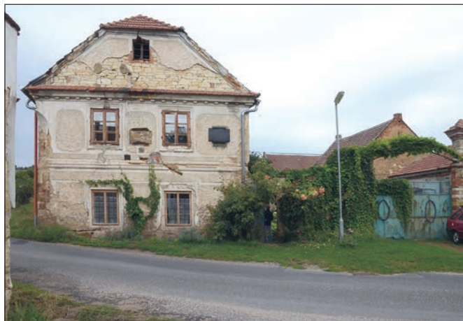
Kokovice (okres Kladno), zemědělská usedlost čp. 8. Památkově velmi hodnotný areál usedlosti s barokně klasicistním patrovým obytným domem obsahuje nejspíše i zbytky ještě starší zástavby. Statek zatím nepoživá památkové ochrany (foto J. Veselý, srpen 2023)
