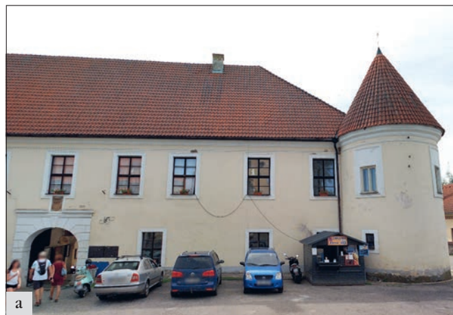
Týnec nad Sázavou (správní obvod obce Benešov), areál hradu, rotunda s věží, obnova střech. Střecha rotundy i věže byla koncem 20. století zakryta nekvalitním řezaným šindelem a do střechy rotundy již zatékalo. Navíc krov rotundy nebyl při poslední obnově opraven. Proto byl nejprve kvalitně tesařsky opraven krov, a pak vyměněna krytina na obou budovách za šindel štípaný z modřínu (foto D. Primusová).
