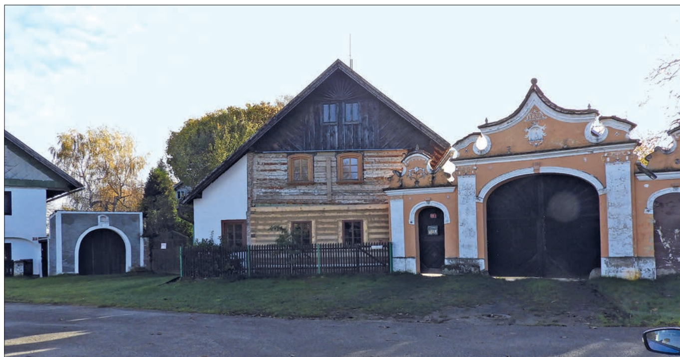
Viška (správní obvod obce Mladá Boleslav), VPR, dům usedlosti čp. 5. Stav po dokončení výměny roubení obvodových stěn světnice. Po technologické přestávce nutné pro vyschnutí nového dřeva se předpokládá obnovení fasády do původního stavu (foto J. Berková).
