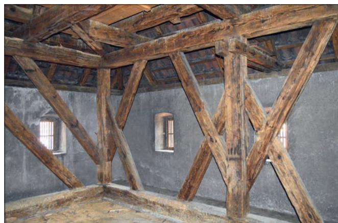
Beroun (správní obvod obce Beroun), Pražská brána městského opevnění, regotizována Josefem Mockermem s datem doloženým v krovu, celkový pohled na spodní patro krovu před opravou (foto D. Havlíková).
