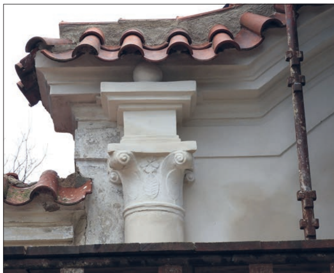
Kadlín (správní obvod obce Mělník), čp. 2. Vjezdová brána usedlosti se vyznačuje výrazně vysazenými sloupovými pilastry s bohatě zdobenými hlavicemi, jejichž obnova kladla na prováděcí firmu nemalé nároky (foto J. Berková).
