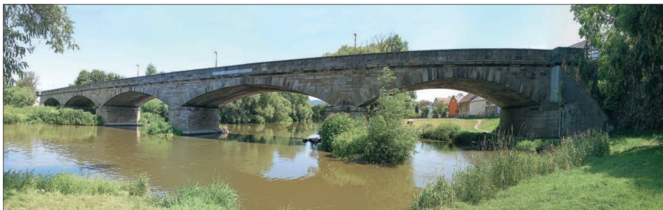
Poříčí nad Sázavou (okres Benešov), rozměrný kamenný most přes Sázavu s pěti segmentovými oblouky o rozpětí 18,3 m a vzepětí 2,5 m z let 1849–1850 nahradil krytý dřevěný most z roku 1561. Již od dávných dob tudy vedla jedna z nejdůležitějších komunikací v zemi, spojující Prahu s jihem Čech a s Rakouskem. Most se řadí k nejvýznamnějším dopravním stavbám z 19. století, které jsou dochovány bez výraznějších změn (foto V. Láska).
