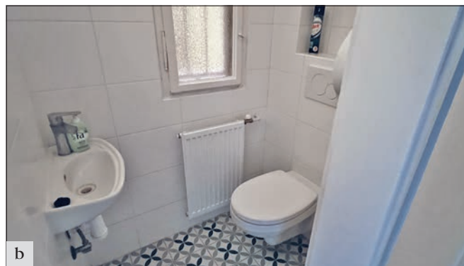
Praha 3, Sabinova 373/5, sídlo ÚOP SČ: a – renovace před síně a kuchyňky ve 2. patře zadní budovy; b – oprava sociálního zařízení v přízemí zadní budovy (foto L. Havlovic).
