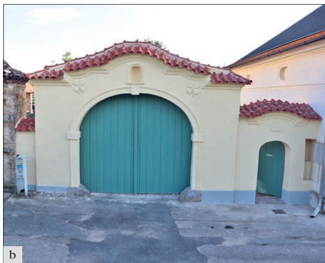
Velenka (správní obvod obce Nymburk), klasicistní brána usedlosti čp. 27: a – celkový pohled na bránu s brankou před obnovou; b – celkový pohled na bránu a branku po obnově (foto M. Hanzlíková).
