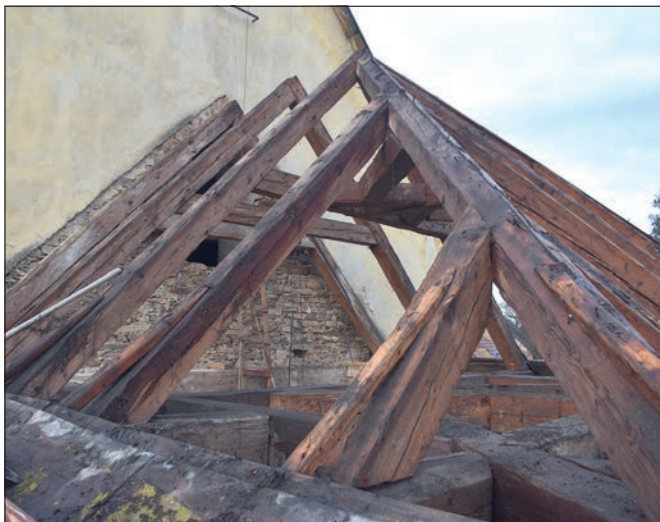
Malotice (správní obvod ORP Kolín), pohled na krov nad sakristií po snesení krytiny (foto D. Havlíková).
