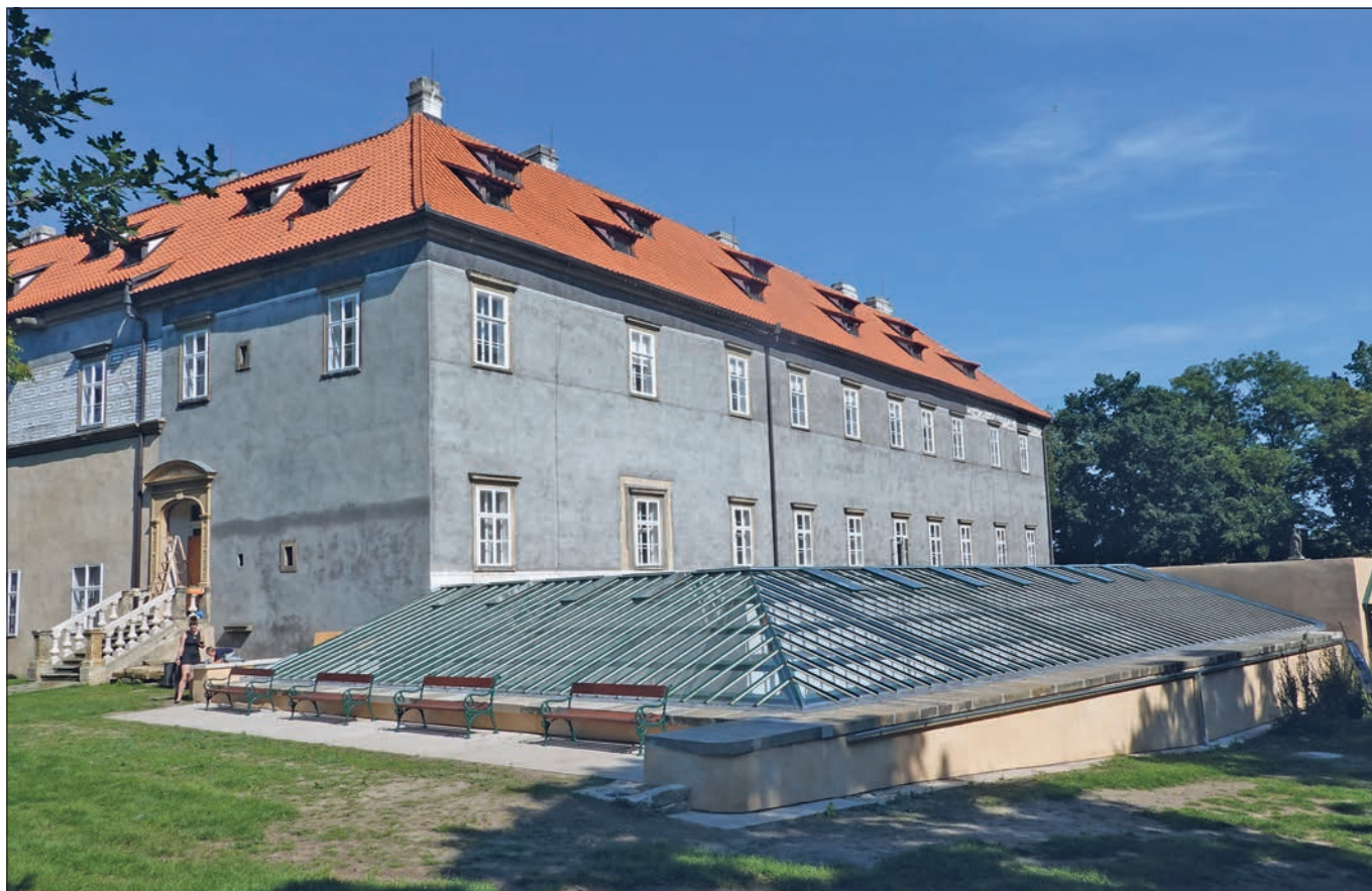
Brandýs nad Labem (správní obvod Brandýs nad Labem – Stará Boleslav), areál zámku, pohled na obnovený dvoukřídlý skleník. Do obnovy skleníku se zde dochovalo pouze narušené obvodové zdivo se zbytky omítek (foto J. Žižka).
