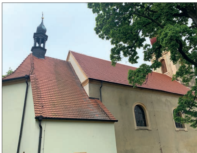
Borotice (správní obvod Dobříš), kostel Nanebevzetí Panny Marie, řemeslně kvalitní realizace výměny střešní krytiny na lodi jako další etapa postupné obnovy vnějšího pláště kostela (foto D. Hofreiterová).
