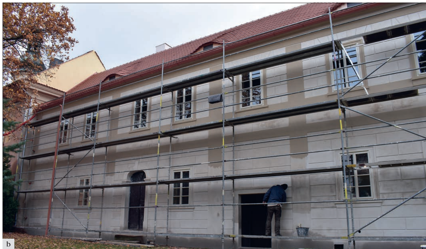
Obráštví (správní obvod obce Neratovice), zámek, obnova fasád zámeckého křídla, dvorní fasáda: a – původní stav; b – stav po dokončení obnovy (foto P. Kalinová).
