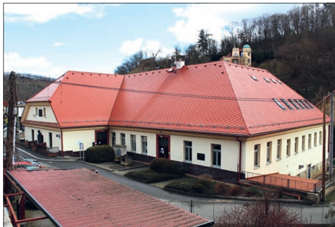
Nížbor (okres Beroun), bývalý pivovar: Dům čp. 25 v Nížbo-ru sloužil jako pivovar od 16. století až do roku 1872, kdy byl poškozen ničivou povodní a jeho provoz již nebyl obnoven. Po kratším období, kdy fungoval jako sladovna a sklad, bylo jeho patro (přízemí ze strany ulice Školní) adaptováno na základní školu, která zde sídlí dodnes (foto A. Jankulíková).
