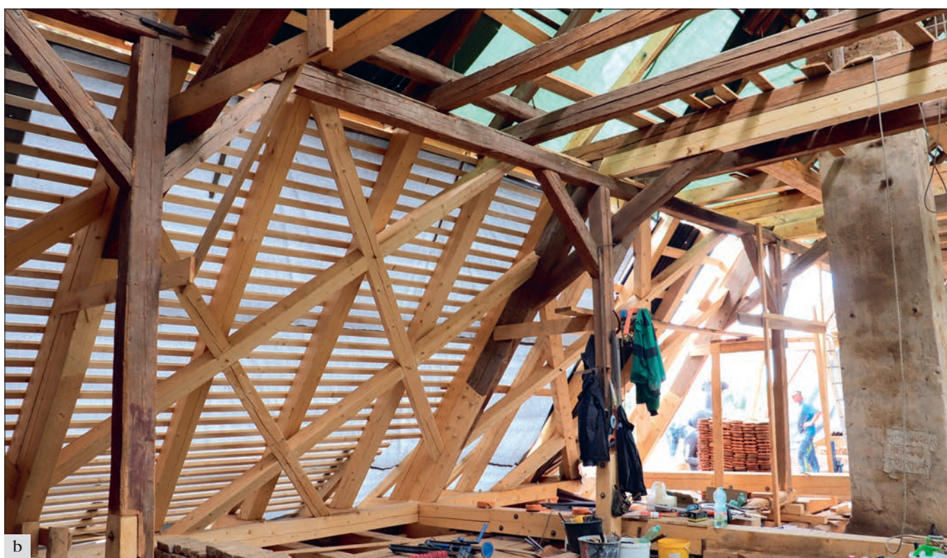
Příčovy (správní obvod obce Sedlčany), zámek: a – objekt před zahájením opravy zastřešení; b – průběh náročné opravy krovu; c – zámek po opravě zastřešení a obnově zaniklé věžičky (foto J. Černochovej).
