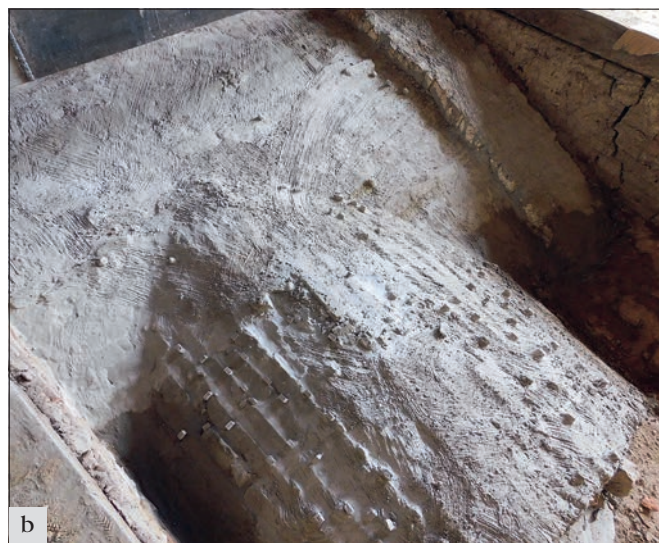
Mladá Boleslav (správní obvod obce Mladá Boleslav), dům čp. 32: a – fotografie z roku 1981 s vyznačením novodobých železobetonových průvlaků (fotoarchív NPÚ ÚOP SC); b – rub klenby po opravě (foto E. Zápalková)
