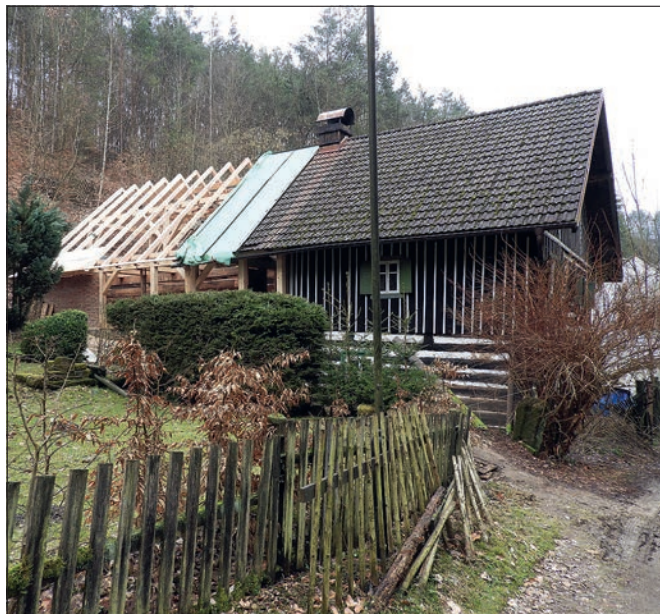
Olešno (správní obvod obce Mělník), VPR, roubený dvoutrakový dům čp. 1. Nově doplněné roubené a hrázděné konstrukce komorového dílu domu a krov před položením krytiny z eternitových šablon, které v další etapě nahradí také současnou velkoformátovou betonovou krytinu z 90. let 20. století a vrátí střeše původní vzhled z doby po přechodu na nespalné krytiny (foto J. Berková).
