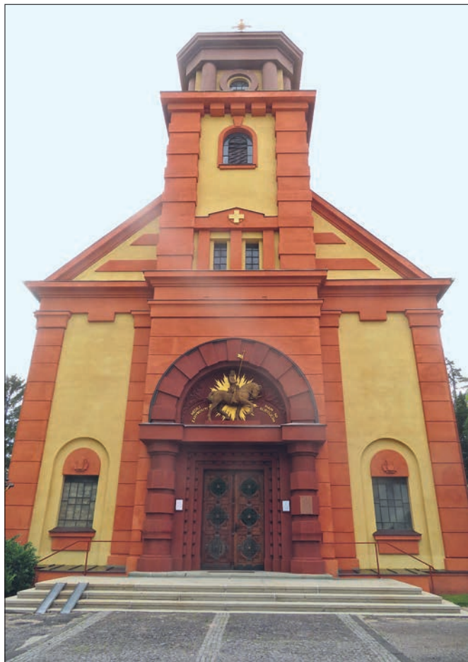
Kladno-Rozdělův (správní obvod obce Kladno), kostel sv. Václava, obnova vstupního západního průčelí: došlo k návratu probarvovaných omítek s příměsí slídy, což patřilo k původní architektonické koncepci stavby; v horní partii věže je ještě patrná předchozí podoba s druhotnými nátěry (zde je obnova plánována v další etapě) (foto E. Mikešová).
