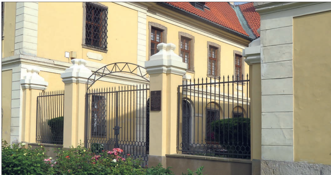
Kladno, zámek (správní obvod obce Kladno), vstupní brána: došlo k celkové rehabilitaci; kromě vysprávkování pilířů a podezdívek bylo řešeno provedení hlavic; tyto prvky byly druhotně zhotovené z maltové směsi a celkově velice poškozené za hranicí životnosti. Byly tedy provedeny nové odlitky v připravených formách z tvrdého materiálu, jejichž povrch byl barevně přizpůsoben odstínu architektonických článků zámku (foto E. Mikešová).
