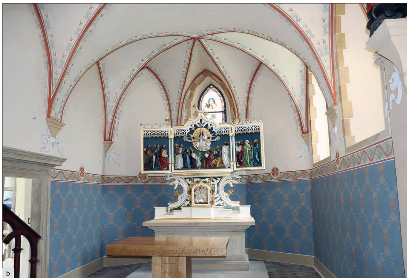
Poděbrady, (správní obvod obce Poděbrady), kostel Nanebevzetí Panny Marie: a, b – pohled do presbytáře před a po obnově omítek a restaurování šablonkové výmalby. Omítky v presbytáři i v lodi byly bohužel ve velkém rozsahu odtrženy od podkladu, a byly proto odstraněny a nahrazeny novými. Dekorativní výmalba v rozsahu soklu byla obnovena formou rekonstrukce, přičemž došlo k mírné korekci odstínů dle nálezů starších vrstev. Taktéž byl oproti stavu před opravou doplněn spodní monochromní pás (foto B. Schmidová).
