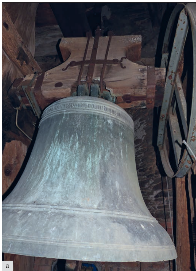
Červené Pečky (správní obvod obce Kolín), kostel Narození Panny Marie, zvon z roku 1531 od Jakuba Ptáčka: a – havarijný stav, krajní třmeny upevňující zvon byly prasklé a čep zaseklý v převalovacím ložisku; b – týž zvon po obnově (foto P. Vácha).
