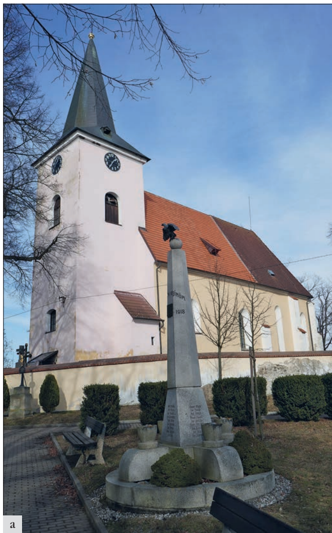
Keblův (správní obvod obce Vlašim), kostel Nanebevzetí Panny Marie. Oprava krovu, výměna krytiny a vytvoření vikýřů pokračovaly další etapou nad východní částí lodi: a – před zahájením etapy 2023; b – obnova dospěla až k závěru presbytáře; c – ležatá stolice s věšadly byla v havarijním stavu, velká část prvků musela být vyměněna (foto O. Drlík a H. Řepková).
