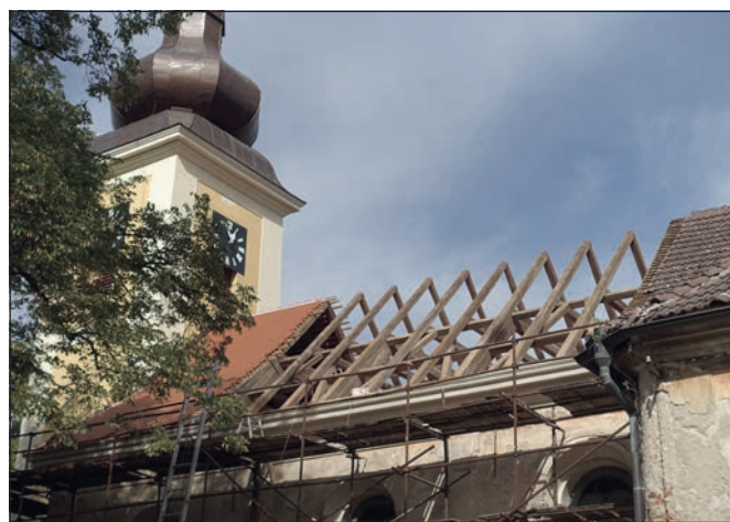
Solopyský (správní obvod obce Kutná Hora), kostel sv. Bartoloměje. Barokní kostel z poloviny 18. století vystavěný podle návrhu A. Palliardiho prochází celkovou obnovou již více jak desetiletí. V roce 2014 bylo demontováno havarijní zastřešení věže a v letech 2017–2021 nahrazeno replikou, následovala oprava omítek věže a barevný nátěr, který stratigraficky odpovídá baroknímu stavu. V roce 2022 byly zahájeny práce na obnově střešního pláště lodi, sestávající z tesařské obnovy krovové konstrukce, výměny stávající nevhodné betonové krytiny za keramickou bobrovku, výměny klempířských prvků z mědi a vytažení římsových profilů korunní římsy, včetně přezdění narušených částí (foto A. Pospíšil).
