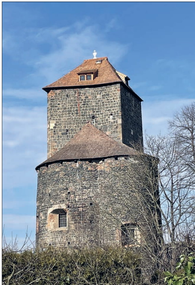
Týnec nad Sázavou (správní obvod obce Benešov), areál hradu, rotunda s věží, obnova střech. Střecha rotundy i věže byla koncem 20. století zakryta nekvalitním řezaným šindelem a do střechy rotundy již zatékalo. Navíc krov rotundy nebyl při poslední obnově opraven. Proto byl nejprve kvalitně tesařsky opraven krov, a pak vyměněna krytina na obou budovách za šindel štípaný z modřínu (foto D. Primusová).
