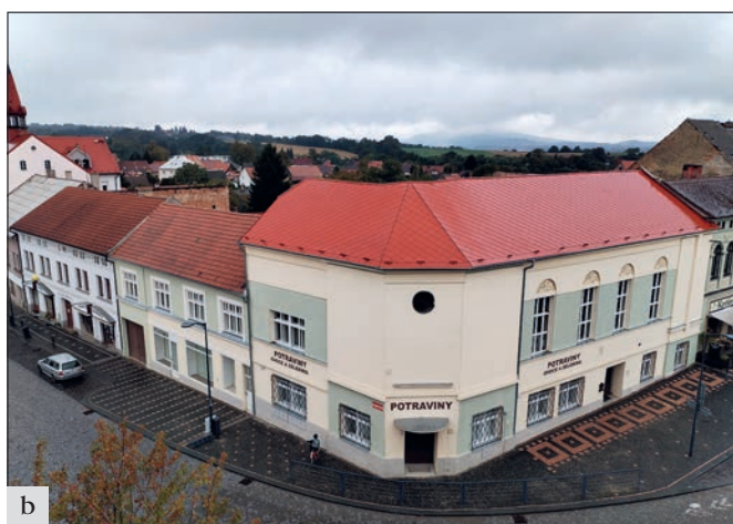
Mšeno (MPZ Mšeno), Náměstí Míru, dům čp. 35, dřívější hotel Hvězda, opravy střechy, fasád a repase výplní nárožního domu: a – původní stav; b – stav po úpravách (foto P. Kalinová).
