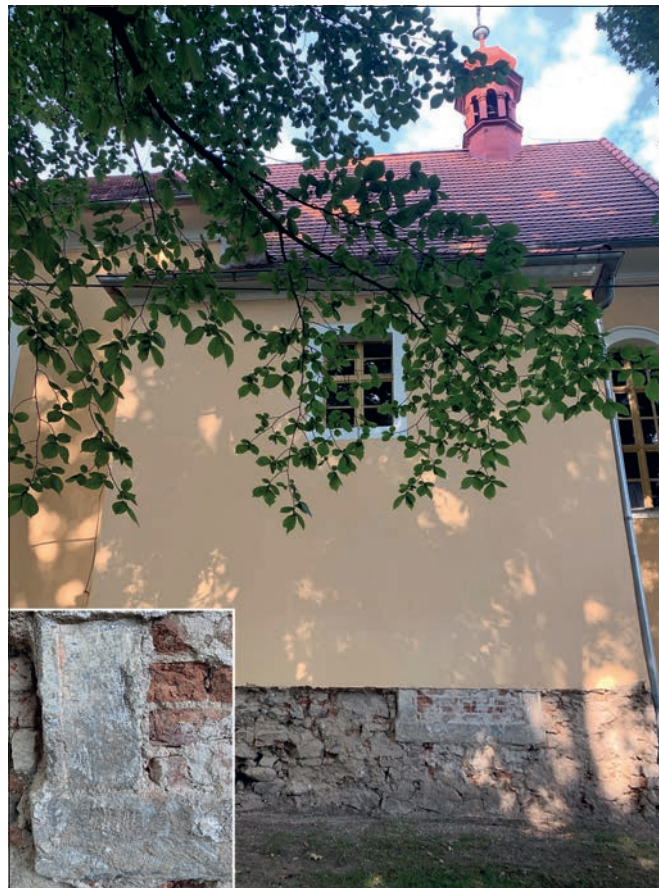
Hřímězdice (správní obvod Dobříš), kostel sv. Anny: odhalení části kamenného ostění dodatečně zazděného obdélného otvoru při finální etapě obnovy obvodového pláště, v levém rohu detail (foto D. Hofreiterová).
