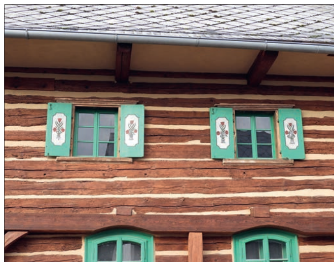
Líny (správní obvod obce Mladá Boleslav), usedlost čp. 26. V rámci celkové obnovy domu byly rovněž restaurovány malované okenice na obytné části domu. Tyto prvky, kdysi charakteristické pro lidovou architekturu Mladoboleslavska, jsou dnes posledními dochovanými kusy v celé oblasti (foto J. Berková).
