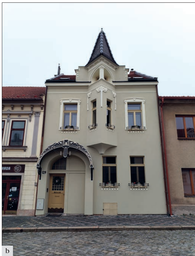
Mělník (správní obvod obce Mělník), ulice Palackého, secesní dům čp. 129: a – původní stav; b – stav po obnově (foto P. Kalinová).
