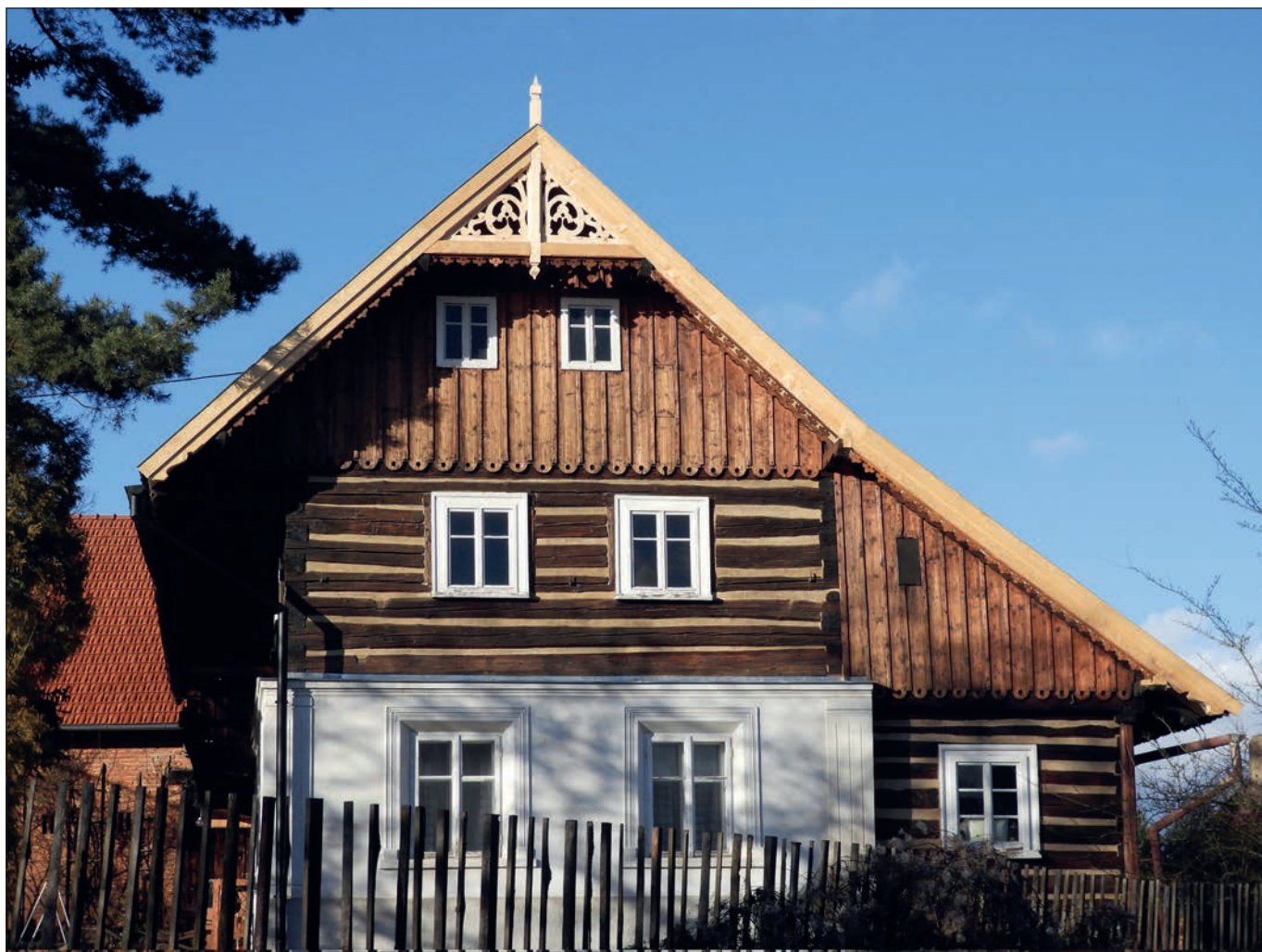
Jestřebice (správní obvod obce Mělník), VPZ, roubený dům čp. 31. V rámci realizované obnovy vnějšího pláště byla dokončena také obnova hlavního štítového průčelí s bohatě zdobenými lištami a výplní v předsazené první vazbě krovu, která je v této oblasti charakteristická pro novodobé vaznicové krovky (foto J. Berková).
