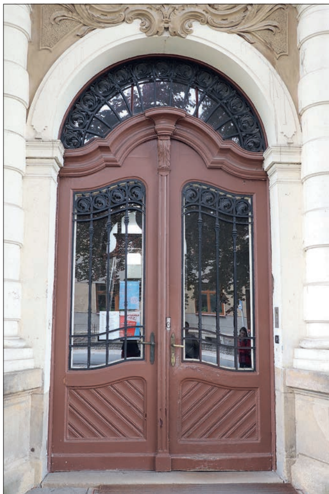
Poděbrady (správní obvod obce Poděbrady), Gymnázium Jiřího z Poděbrad, vstupní dveře před repasí byly svěšené, netěsnící s mnoha defekty a opotřebovanou okopovou lištou (foto H. Řepková).
