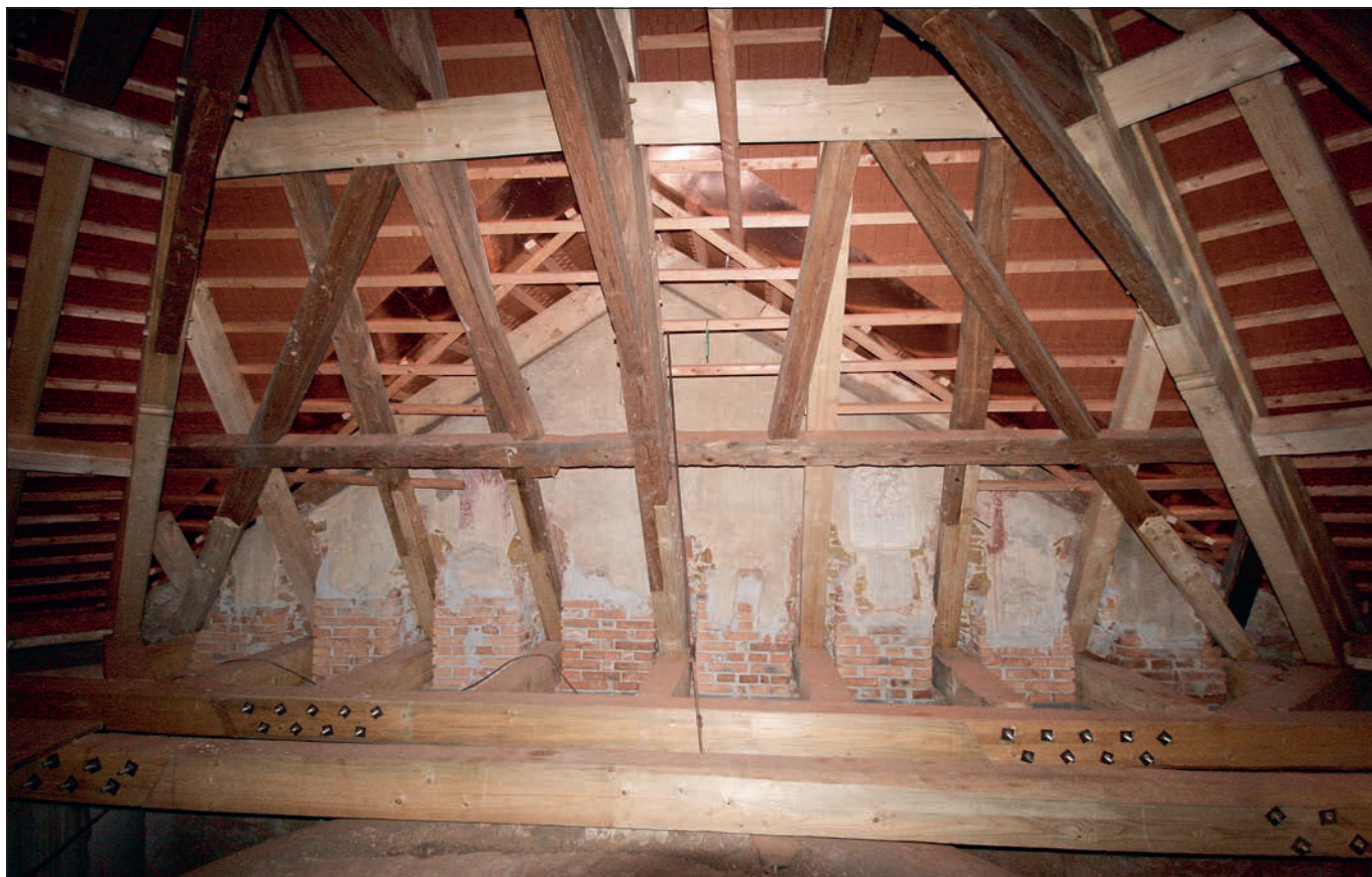
Zápy (správní obvod obce Brandýs nad Labem – Stará Boleslav), kostel sv. Jakuba většího. Započala obnova krovu a výměna střešního pláště při západním štítě nad hlavní lodí. Oprava probíhá dle schválené projektové dokumentace, a to běžným způsobem pomocí ocelových svorníků i pomocí dřevěných spojů (foto M. Gottwaldová).
