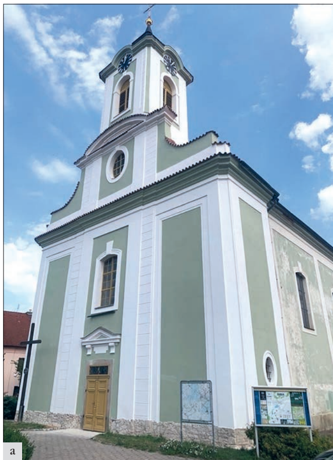
Žebrák (správní obvod obce Hořovice), kostel sv. Vavřince: a – stav po provedení obnovy fasády západního průčelí a věže; b – aplikace silikátového nátěru; c – detail římsy štítu (foto D. Hofreiterová).
