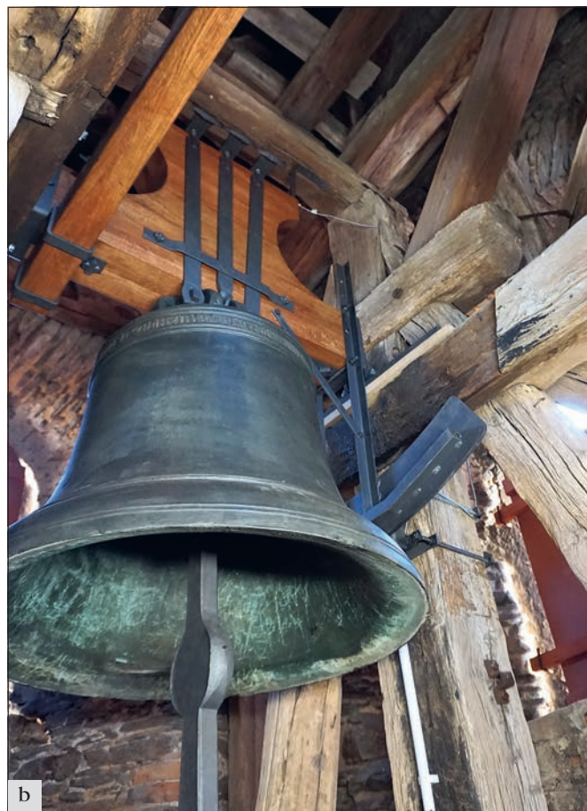
Červené Pečky (správní obvod obce Kolín), kostel Narození Panny Marie, zvon z roku 1531 od Jakuba Ptáčka: a – havarijný stav, krajní třmeny upevňující zvon byly prasklé a čep zaseklý v převalovacím ložisku; b – týž zvon po obnově (foto P. Vácha).
