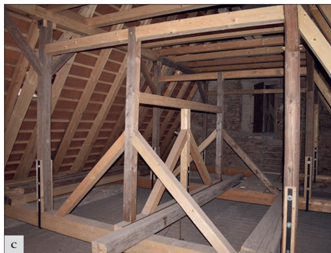
Keblův (správní obvod obce Vlašim), kostel Nanebevzetí Panny Marie. Oprava krovu, výměna krytiny a vytvoření vikýřů pokračovaly další etapou nad východní částí lodi: a – před zahájením etapy 2023; b – obnova dospěla až k závěru presbytáře; c – ležatá stolice s věšadly byla v havarijním stavu, velká část prvků musela být vyměněna (foto O. Drlík a H. Řepková).
