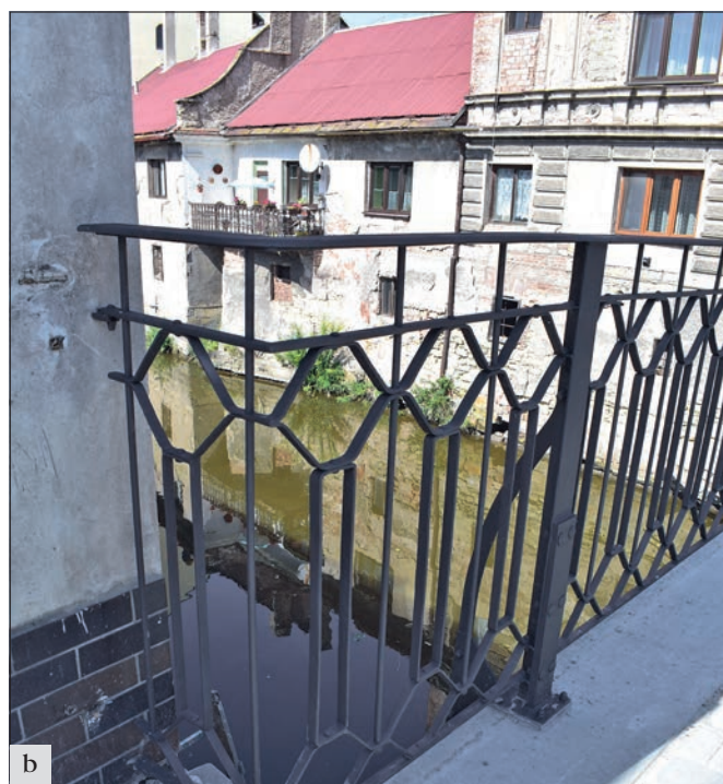
Kostelec nad Labem (správní obvod obce Neratovice), oprava mostku přes Mlýnský potok: a – původní stav; b – stav po repasi kovaného zábradlí (foto P. Kalinová).
