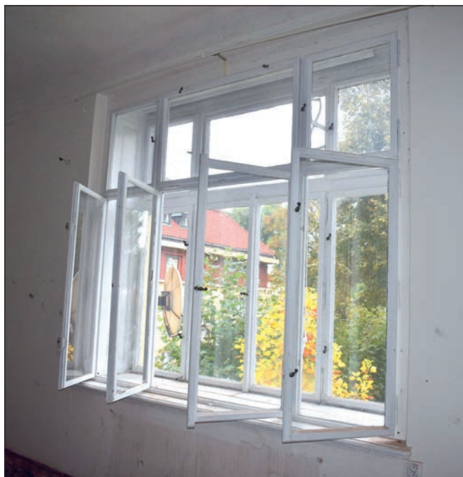
Praha, městská část Malá Strana, Hrzánský palác čp. 490/III, Velkopřevorské náměstí – celkový pohled na dokumentovanou výplň z interiérové strany při otevření okenních křídel (foto D. Havlíková).
