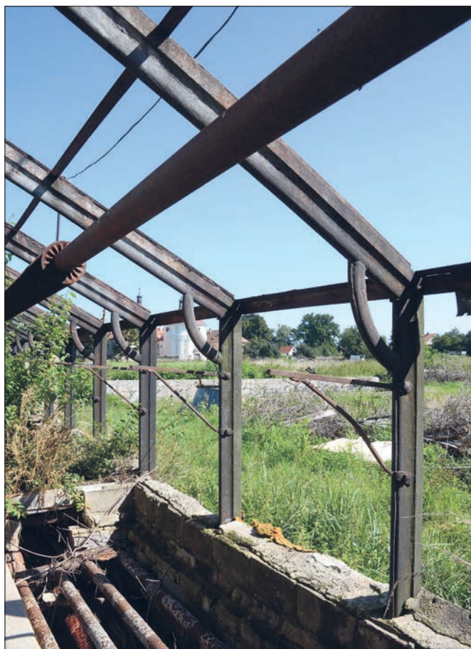
Nové Dvory u Kutné Hory (okres Kutná Hora), detail litinové konstrukce skleníku v sousedství fíkovny. Skleník byl na přelomu 19. a 20. století přistavěn k budově někdejší fíkovny s barokním jádrem a k taktéž barokní severní zdi někdejší oranžerie. Ve druhé půlce 20. století byl vícekrát upravován. Z původní konstrukce se dochovaly litinové nosné rámy, které zachycuje snímek (foto J. Veselý, září 2023)
