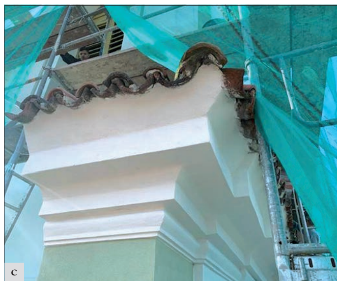
Žebrák (správní obvod obce Hořovice), kostel sv. Vavřince: a – stav po provedení obnovy fasády západního průčelí a věže; b – aplikace silikátového nátěru; c – detail římsy štítu (foto D. Hofreiterová).
