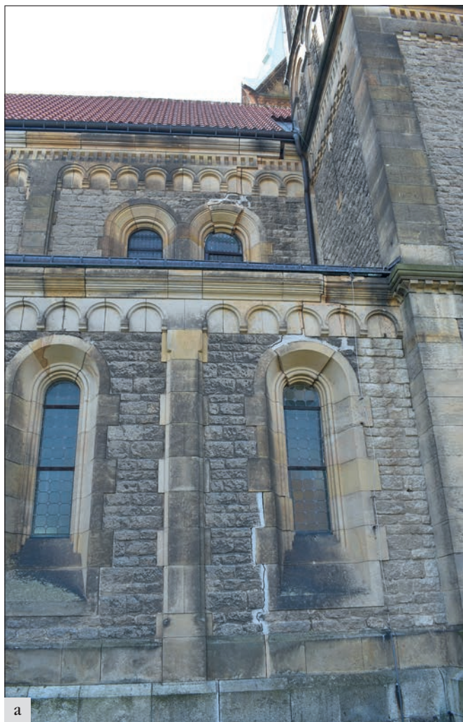
Grunta (správní obvod ORP Kolín): a – exteriér kostela Nanebevzetí Panny Marie před zahájením prací s viditelným poklesem klenáků okenních otvorů, stav 2023; b – exteriér kostela Nanebevzetí Panny Marie po statickém zajištění zdiva a restaurátorské opravě a stabilizaci klenáků okenních otvorů; c – interiér kostela Nanebevzetí Panny Marie po statickém zajištění zdiva pilotami a po restaurování výmalby, pohled lodí ke kruchtě po ukončení prací, stav 2024 (foto D. Havliková).
