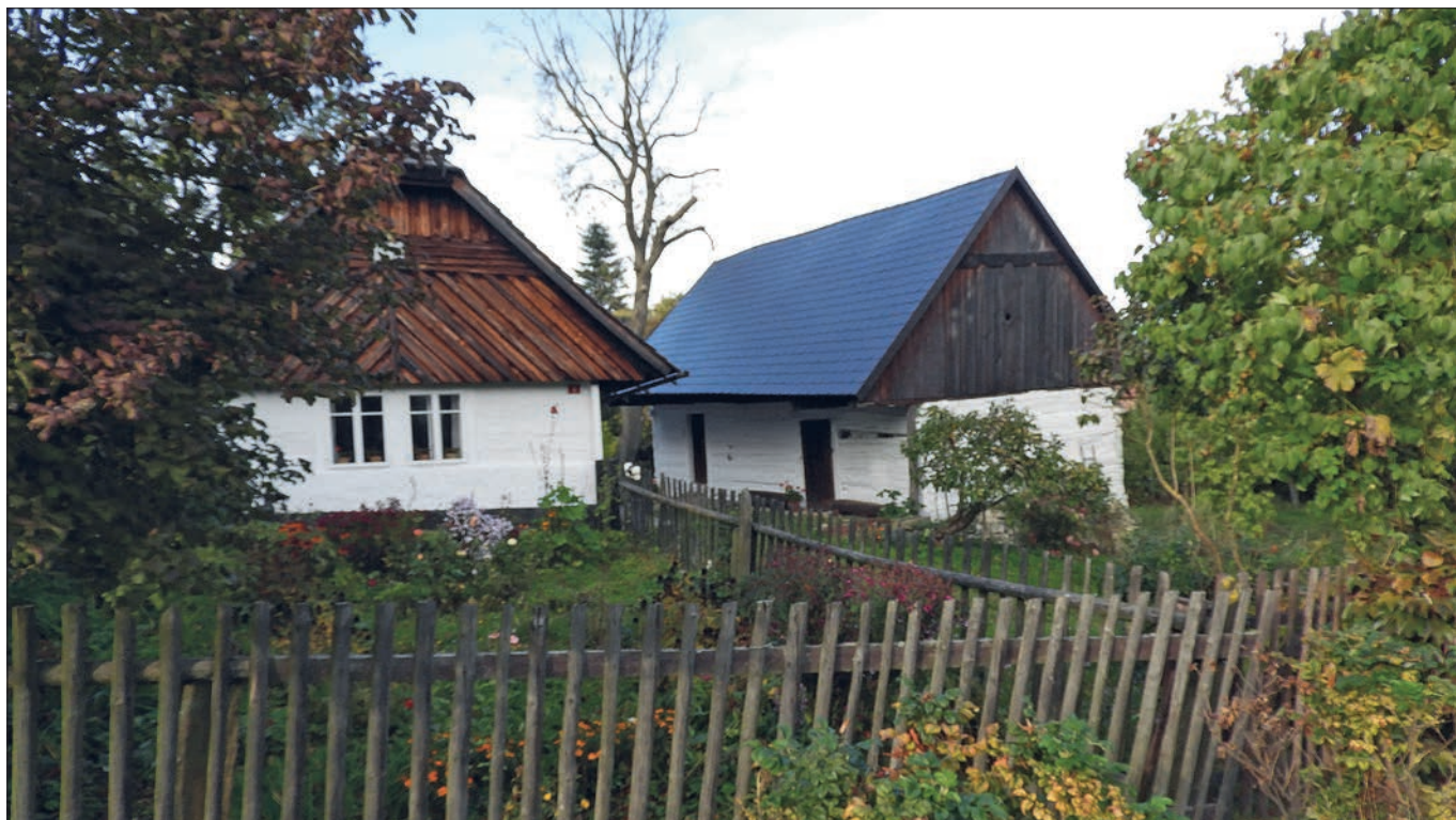
Žandov (správní obvod obce Kutná Hora). Roubený dvoukomorový špýchar s obnovenou střechou. Šablonová krytina, která nahradila předchozí lepenku, byla již dříve použita rovněž na střechu hospodářské části domu (foto J. Berková).
