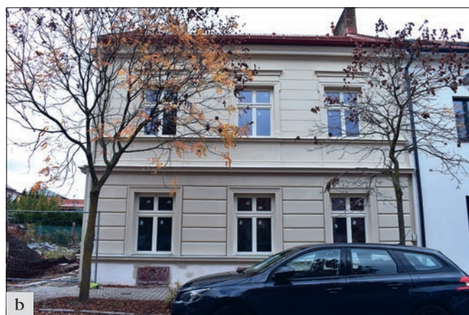
Mělník (správní obvod obce Mělník), ulice 17. listopadu, dům čp. 244: rehabilitace štítové a uliční fasády: a – původní stav; b – stav po obnově s doplněním zaniklých architektonických článků (foto P. Kalinová).
