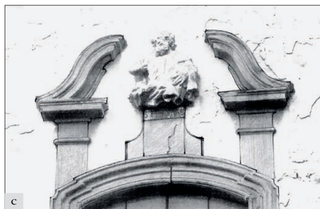
Březno (správní obvod obce Mladá Boleslav), kostel sv. Václava. Fasáda barokního kostela má bohaté architektonické členění se sochařskou výzdobou, která ale musela být z důvodu havarijního stavu sejmuta. Pro osazení kopií byly ve zdivu ponechány kapsy. Postupně probíhá oprava fasád s restaurováním pískovcových ostění: a – stav ostění s nadokenními římsami před restaurováním; b – stav po restaurování; c – fotografie před sejmutím byst se zákresem plastických i malovaných prvků, která zobrazuje celek po předpokládaném dokončení obnovy (foto E. Vyletová).
