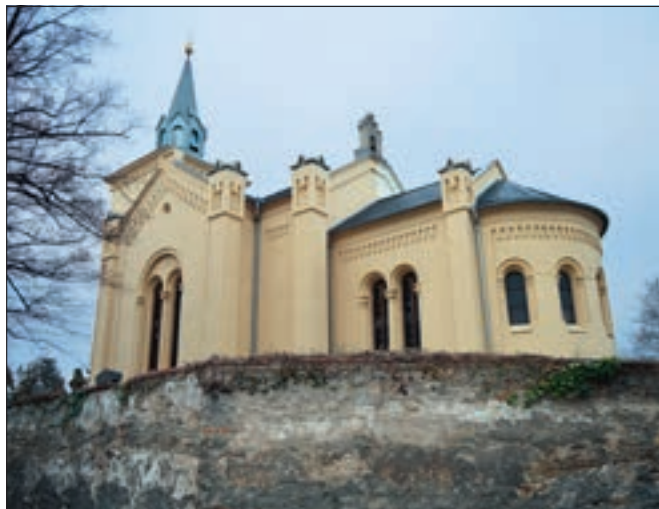
Zibohlavy (okres Kolín), kostel sv. Martina. Během několik sezón trvající postupné opravy se podařilo rekonstruovat a obnovit historizující členění i průzkumem zjištěné barevné řešení (foto D. Havlíková).
