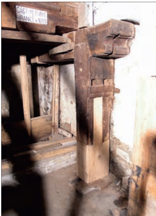
Poteplí – Malé Kyšice (okres Kladno), vodní mlýn čp. 13 – detail protězy profilovaného sloupku mlýnské stolice (foto M. Hanzlíková).
