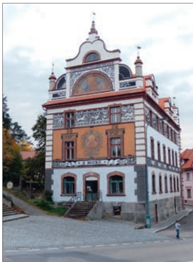
Týnec nad Sázavou (okres Benešov), dům U Micků, obnova fasád. V minulém roce pokračovala oprava fasád této významné dominanty města restaurováním sgrafitové výzdoby východního štítu (foto D. Primusová).
