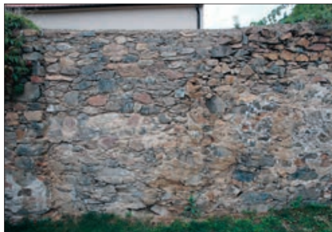
Zbečno (okres Rakovník), čp. 22. V areálu Hamousova statku stála piliřová stodola, dochovaná do dnešních dní jen v torzálním stavu. Štítová stěna, obrácená ke komunikaci, byla plně vyzděná z lomového kamene. V rámci její obnovy byla destruovaná část pečlivě dozděna opět z lomového kamene při zachování původní skladby. Koruna zdiva byla zakryta drnem (foto J. Berková).
