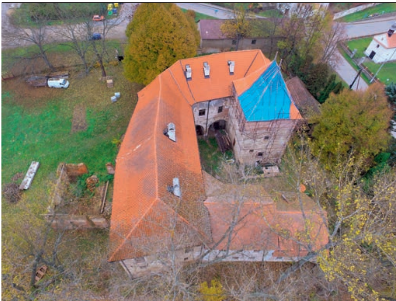
Popovice (okres Benešov), tvrz, dostavba věže. Celková obnova tvrze pokračovala zastřešením věže. Na obvodové zdivo věže, které bylo navýšeno, byl postaven nový krov, který byl v předešlých letech sestaven na zemi, a bylo započato s pokládkou prežové krytiny (foto V. David).
