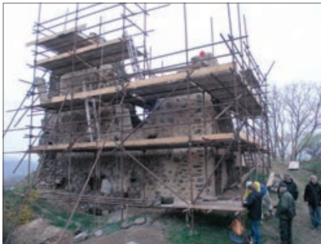
Týřov (okres Rakovník), zřícenina bradu. Po dlouhých letech příprav byla konečně zabájena oprava bavarijního stavu donjonu na západním okraji bradu. Až na místě bylo nutné přehodnotit záměr a začít zajištěním nejzápadnějšího torza oslabené obvodové zdi. Právě zde došlo po prudkém dešti začátkem července ke zřícení vnějšího líce zděného obvodového pláště. Stav pabýlu zdi byl po sesutí vnějšího líce natolik nestabilní, že bylo nutné přistoupit nejdříve ke zpevnění dvou přilehlých sousedních zdí, vymezujících původně bradní donjon, stav v říjnu 2015 (foto E. Volfová).
