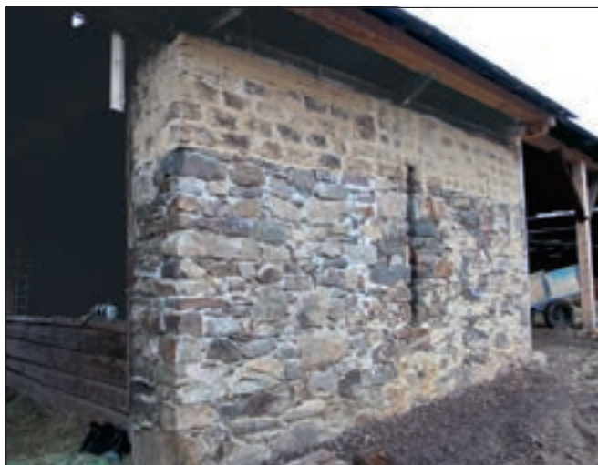
Olešná (okres Beroun), stodola s navazující kolnou v areálu usedlosti čp. 12, jižní zeď východní perny. V levé části obvodové zdi bylo v předchozích etapách obnovy přezděno utržené nároží. V nadezdívce z nepálených cihel je patrná dozdívká z cihel pálených. Obnova nadezdívky v pravé části se v letošním roce podařila bez doplnění úseků páleného zdiva i přes napažení skrytého železobetonového věnce (foto M. Hanzlíková).
