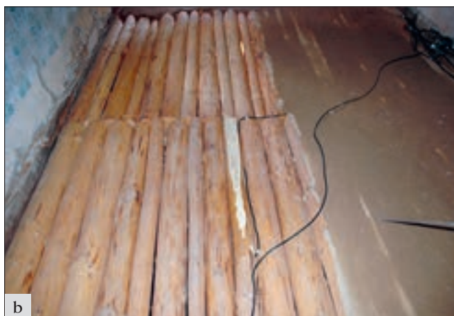
Vidím (okres Mělník), čp. 67: a – vnější plášť roubeného stavení po dokončení vymazávek spár; b – v rámci obnovy interiéru bylo nutno obnovit původní hliněné omítky a vyměnit také zcela dožilý strop nad výměnkářskou světničkou při zachování jeho původní tradiční skladby z loupaných povalů omazaných hliněnou kaší (foto J. Berková). Tento druh historické konstrukce, která plní současně funkci podlahy v 1. patře, má lepší nosnost než klasický prkenný záklop, v kombinaci s hlinou má rovněž velmi dobré tepelné izolací vlastnosti (foto J. Berková).
