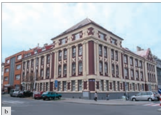
Kladno, budova čp. 1976 na náměstí Svobody před opravou: a – modernistická architektura s rondokubistickými fasádními prvky byla za dobu své existence na Kladně tak zčernalá a ušpiněná, že zcela ztratila svou původní zajímavou kontrastní okrovo-červenou barevnost; b – stav po opravě fasád, při níž se opravený povrch omítek scelil lazurním nátěrem odpovídajícím původním výrazným barvám, okrové a tmavě červené. Současně se obnovily i klempířské prvky a repasovala původní dřevěná okna (foto E. Volfová).
