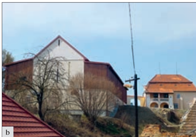
Nový Knín (okres Příbram), proměna nákupního centra: a – patrový objekt nákupního střediska ze 70. let 20. století, postavený na místě hospodářských budov mincovny a dalšího zbořeného domu v sousedství, se přes relativně zajímavou kubickou skladbu vymykal měřítku domů v MPZ; b – v roce 2015 tato budova prošla zásadní stavebně-architektonickou úpravou, která je určitou reminiscencí zaniklých hospodářských budov. Návrh, zachovávající suterén a přízemí stavby ze 70. let, prošel určitým vývojem od „historismu“ inspirovaného barokní podobou mincovny po realizovanou podobu, která budovu přiměřeněji začlenila do prostředí MPZ. Vpravo vystupuje budova mincovny s mansardovou střechou (foto H. Řepková).
