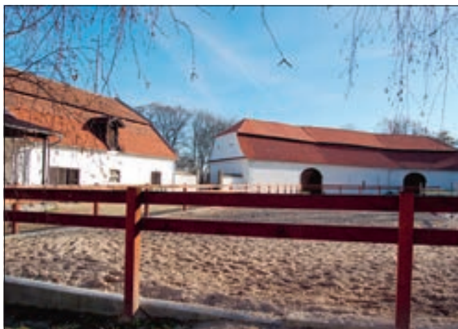
Mariánovice (okres Benešov), hospodářský dvůr, obnova střech. Postupná obnova střech dvora v tomto roce pokračovala na budově stájí a stodole, které jsou využívány pro chov a drezúru koní (foto D. Primusová).
