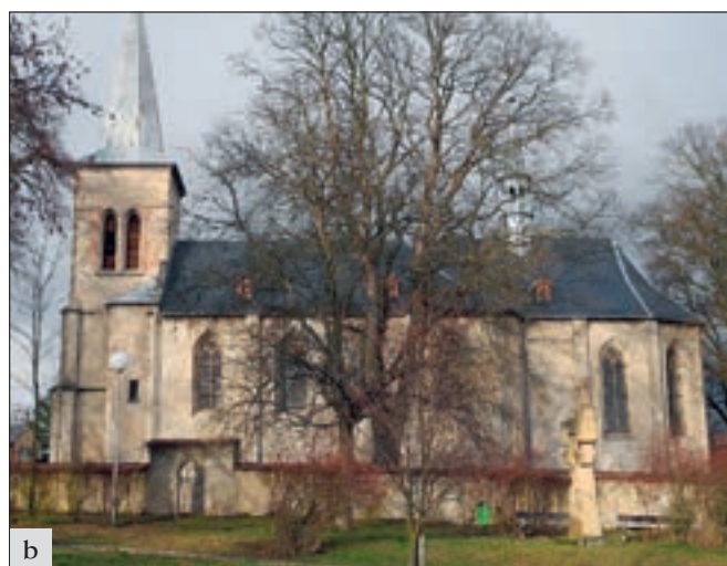
Klášteř Hradiště nad Jizerou (okres Mladá Boleslav), kostel Narození P. Marie : a – tato mimořádně hodnotná stavba s raně gotickým portálem a cenným renesančním interiérem byla od 70. let 20. století opatřena pouze provizorní střechou; b – dokončená obnova krovu je základním předpokladem k její záchraně a budoucí rehabilitaci. Návrh obnovy krovu včetně tvaru vikýřů byl zpracován na základě historické plánové dokumentace a archivních fotografií (foto E. Vyletová).
