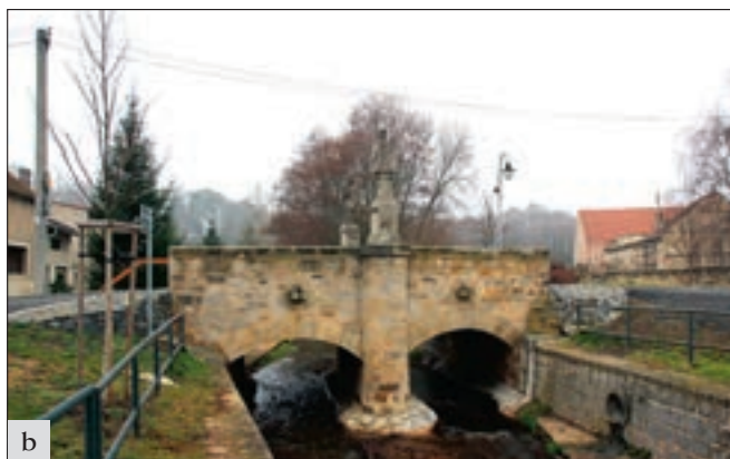
Královice (okres Slaný), kamenný silniční most přes Bakovský potok: a – stav v únoru 2015. Příprava obnovy probíhala od května 2013, vlastní akce od prosince 2014 do srpna 2015. Celková oprava zajistila funkčnost mostu na další léta, opět zprovoznila odvodnění a zlepšila dílčí závady na vzhledu stavby; b – stav v březnu 2016 po první zimě (foto A. Rákosníková).
