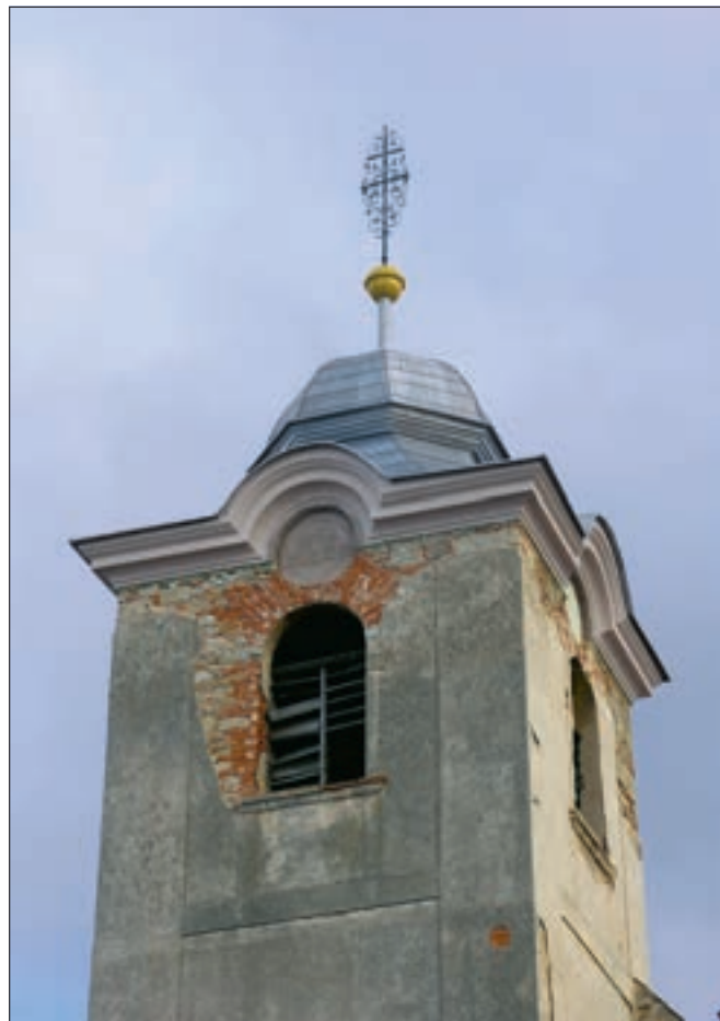
Veclov (okres Rakovník), kostel Všech svatých. Horní část západní věže kostela po dokončené opravě, provedené ve velmi dobré kvalitě. Stavebně-technický stav kostela se nadále zhoršuje, a to jak v exteriéru, tak uvnitř stavby. V pokročilém bavarijním stavu byla zejména horní část západní věže. Podílely se na něm zejména dožilá zrezavělá plechová krytina, nakloněná hrotnice s ozdobným křížem, dlouhodobě opadané fasádní omítky s obnaženým postupně se drolicím zdivem ztrácejícím soudržnost. Jelikož těsně kolem stavby prochází frekventovaná místní komunikace, hrozilo nebezpečí vážného úrazu. Proto bylo nutné neprodleně začít s opravou střechy věže s korunní římsou, stav v červnu 2015 (foto E. Volfová).
