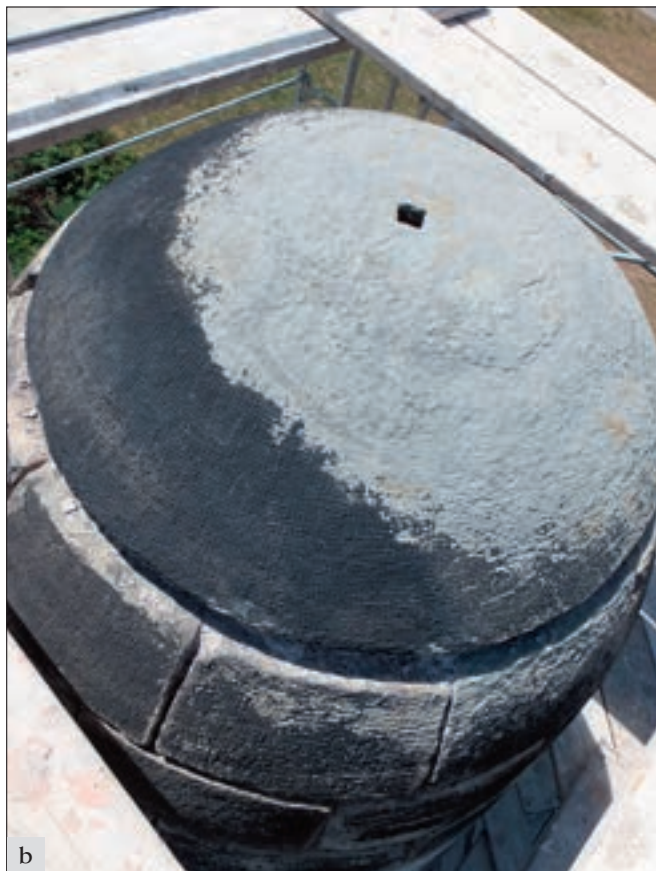
Lipany (správní obvod Český Brod), pomník bitvy u Lipan: a – celkové restaurování pláště mohyly vztyčené v roce 1881 řešilo zejména obnovu spárování a ošetření jednotlivých bloků, některé byly znovu osazeny. Konzervovány byly také původní kovové nápisové desky; b – detail vrchlíku s patrným opravným povrchu kamene pemrlováním (foto L. Maděrová).
