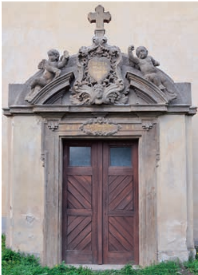
Družec (správní obvod obce Kladno), kostel Nanebevzetí Panny Marie, jižní portál, stav po restaurování. Kartuš i postavy andělů se nalézaly v bavorském stavu a restaurátorský zásah byl nevyhnutelný. Architektura portálu a její jednotlivé kamenné prvky byly opakovaně napouštěny konsolidantem. Došlo k odstranění nevhodných doplňků a biologického napadení. Po konzultacích se zástupcem NPÚ nebyly realizovány tvarové rekonstrukce chybějících částí rukou a nobou andělů, sochy byly konzervovány (foto J. Weissová).
