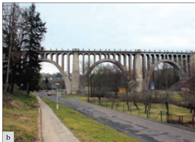
Dolní Krnsko (okres Mladá Boleslav), železniční most přes údolí Strenického potoka: a – stav v červnu 2015. Most s železobetonovými klenbami vetknutými do starších kamenných opěr a piliřů vytváří s okolním hlubokým údolím mimořádně působivý celek; b – stav v únoru 2016. V rámci jarních dokončovacích prací bude muset být řešen především problém změny barevnosti reprofilační bmoty pro železobetonovou část konstrukce v úseku, kde byla aplikována již v pokročilém ročním období (foto A. Rákosníková).
