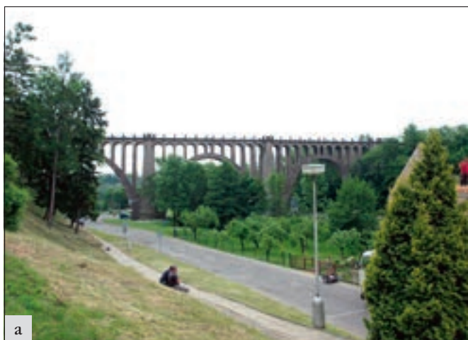
Dolní Krnsko (okres Mladá Boleslav), železniční most přes údolí Strenického potoka: a – stav v červnu 2015. Most s železobetonovými klenbami vetknutými do starších kamenných opěr a piliřů vytváří s okolním hlubokým údolím mimořádně působivý celek; b – stav v únoru 2016. V rámci jarních dokončovacích prací bude muset být řešen především problém změny barevnosti reprofilační bmoty pro železobetonovou část konstrukce v úseku, kde byla aplikována již v pokročilém ročním období (foto A. Rákosníková).
