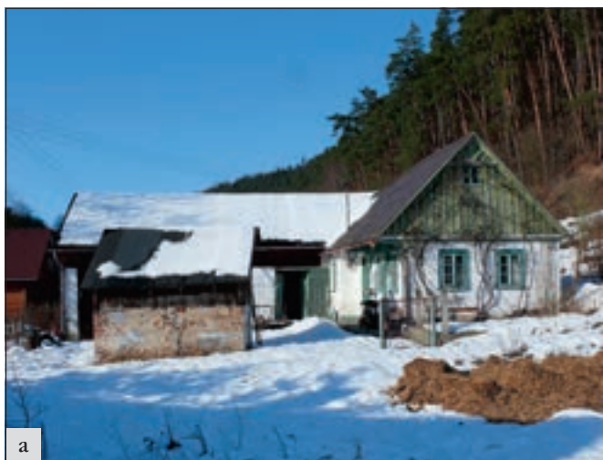
Podboře (okres Mladá Boleslav), usedlost čp. 5: a – stav v lednu 2012 (foto J. Tichá). Obnova roubení světnice proběhla již v roce 2014, dokončení vymazávek a obilnění na jaře 2015; b – stav v květnu 2015 (foto A. Rákosníková).
