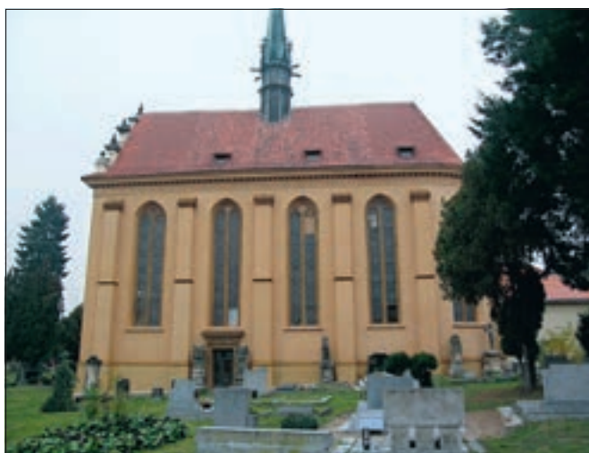
Velvary (okres Kladno), kostel sv. Jiří, pobled od jihu po obnově. V roce 2015 pokračovala obnova fasád kostela. Kvalitně byla opravena štuková zavíjená výzdoba vlysového pásu i kamenické details. Celek sjednotil poměrně sytý, zemitý okrový nátěr, navazující na zjištěný stav. Za touto, vcelku příznivě působící úpravou, kontrastuje materiálová analytika s téměř černě upravenými kamennými články dosud neopraveného štítového průčelí (foto M. Jedlička).
