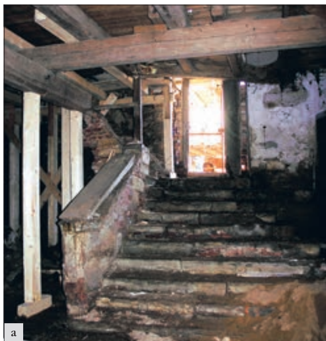
Vepřek (okres Mělník), čp. 19.: a – schody do sníženého přízemí mlýnice. Stav před obnovou. V pozadí vlevo poškozený peron s propadlou klenbou, který vynášel schody do zvýšeného přízemí; b – schody do sníženého přízemí mlýnice. Vlevo obnovený peron s navazujícími žebříkovými schody do zvýšeného přízemí. V popředí parapetní zídka s korunou z masivní kamenné desky a s profilovaným sloupkem při nástupu na schody (foto M. Hanzlíková).
