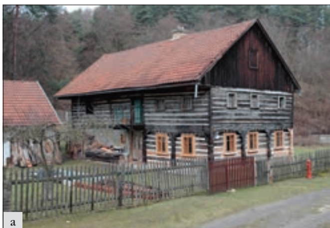
Vidím (okres Mělník), čp. 67: a – vnější plášť roubeného stavení po dokončení vymazávek spár; b – v rámci obnovy interiéru bylo nutno obnovit původní hliněné omítky a vyměnit také zcela dožilý strop nad výměnkářskou světničkou při zachování jeho původní tradiční skladby z loupaných povalů omazaných hliněnou kaší (foto J. Berková). Tento druh historické konstrukce, která plní současně funkci podlahy v 1. patře, má lepší nosnost než klasický prkenný záklop, v kombinaci s hlinou má rovněž velmi dobré tepelné izolací vlastnosti (foto J. Berková).
