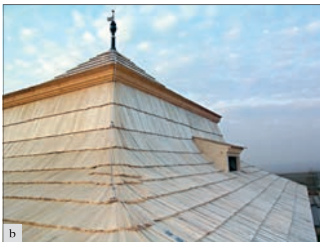
Hradenín (okres Kolín), tvrz čp. 13. Dokončování šindelové střechy na replice historického krovu tvrze dle výkresů zachycujících renesanční krov, v baroku dodatečně upravený na mansardovou střechu; byly prováděny tesařské spoje a ruční opravování povrchů trámů: a – celkový pohled na tvrz po rekonstrukci historického krovu dle archivních fotografií a zaměření; b – detail šindelové krytiny (foto D. Havlíková).
