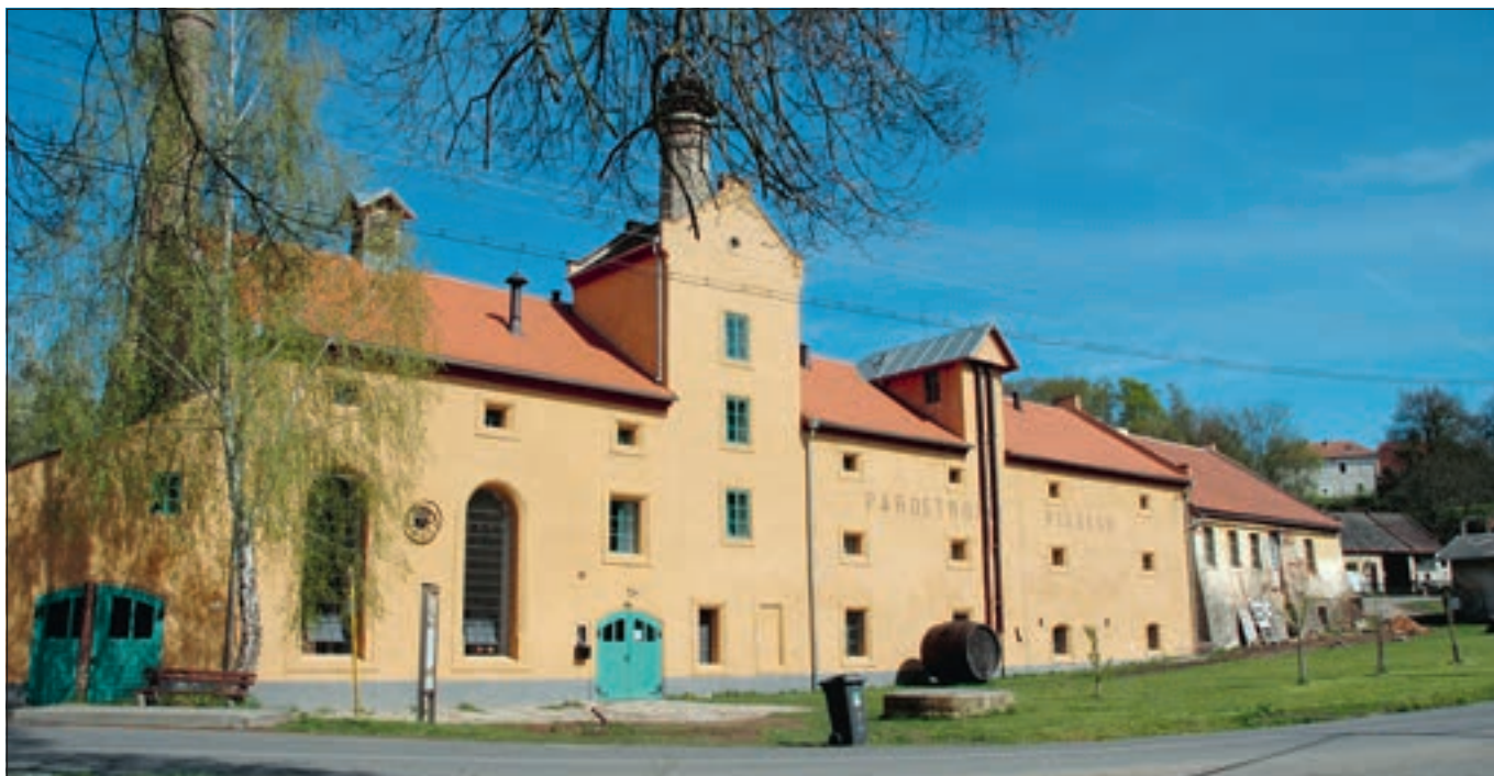
Lobeč (okres Mělník), areál pivovaru. Hlavní budova se sladovnou, hvozdem varnou a strojovnou byla zpřístupněna veřejnosti k prohlídkám. Zbývá pouze dokončit obnovu sladovny a hvozdů. Stav v době obnovení provozu pivovaru (foto J. Berková).
