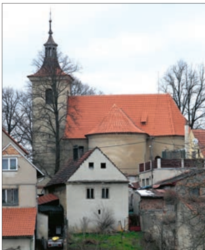
Svárov (okres Kladno), kostel sv. Lukáše. V roce 2015 se dokončovala oprava cenného barokního krovu v prostoru nad jihozápadní částí lodi spolu s krovem nad jižní kaplí sv. Jana Nepomuckého. Na opravený krov a nové laťování se pokládala krytina z nových pálených prejzů. Na fotografii je pobled na celek opravené střechy od jihu. Zbývá ještě přeložit dožilé prejzy na spodní části střechy věže, neboť padající kusy tašek brozí poškodit nově položenou krytinu pod nimi (foto E. Volfová).
