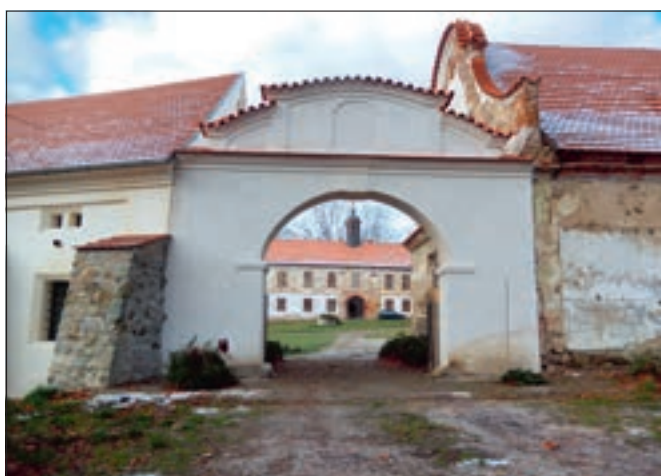
Třebešice (okres Benešov), areál zámku, obnova vstupní brány. Barokní brána vjezdu do hospodářského dvora zámku byla navržena a znovu postavena podle historické fotografie a pozůstatků a otisků zjištěných průzkumem (foto D. Primusová).
