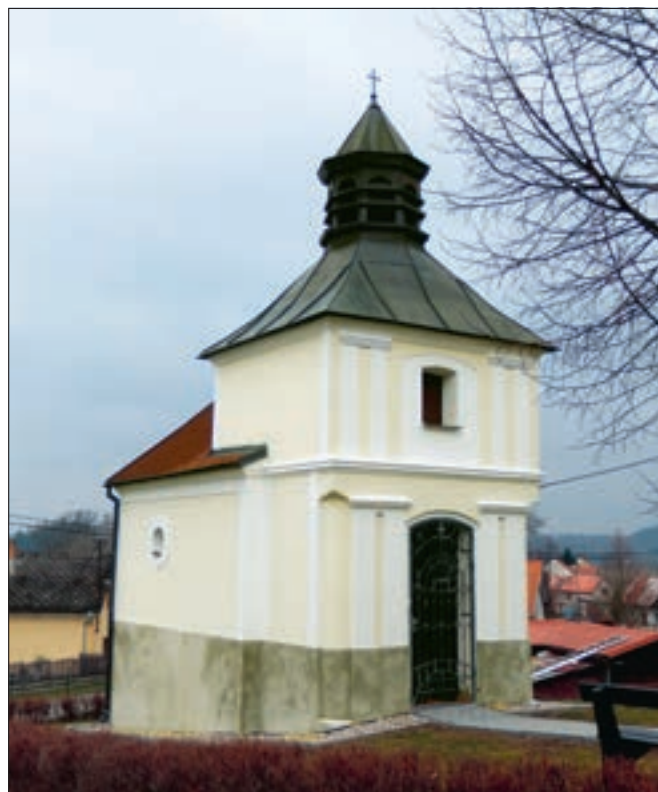
Drabňovice (okres Benešov), kaple, obnova vnějších omítek. Při opravě novodobých vnějších omítek byla využita příležitost k obnově původního členění vstupního průčelí kapličky. Návrh obnovy byl vypracován podle historické fotografie (foto D. Primusová).
