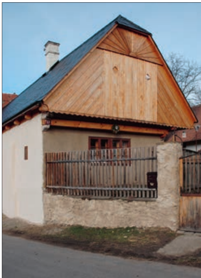
Zbyslav (okres Kutná Hora), čp. 57. Obnova vnějších omítek následovala po předchozí celkové obnově roubené světnice. Na zděné části byly obnoveny tradiční vápenné omítky, roubené stěny byly opatřeny podle původního stavu bliněnou omazávkou, tzv. kožichem. Stav před dokončením svrchního vápenného nátěru (foto J. Berková).
