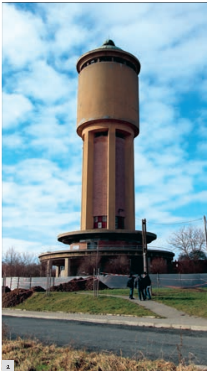
Kolín (okres Kolín), věžový vodojem na Pražském předměstí: a – stav v lednu 2015. Významná vodohospodářská památka byla upravena na vyblůdkovou věž. Opravu pláště, opatřenébo různobarevnými kamenicky opracovanými drťovými omítkami se však nepodařilo provést tak, aby byl podtržen působivý efekt této úpravy, typické pro 1. třetinu 20. století; b – stav v listopadu 2015 (foto A. Rákosníková).
