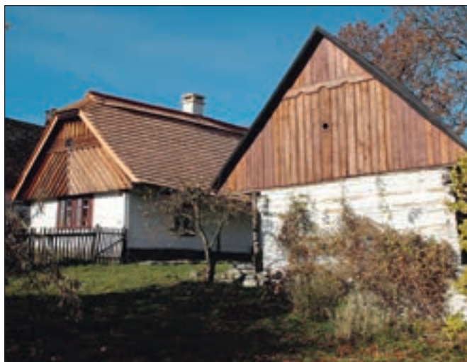
Žandov (okres Kutná Hora), čp. 5. Nová šindelová krytina zachovala celkový tradiční malebný vzhled této usedlosti, avšak větrací průduch pod břebenem vnáší do tohoto prostředí novodobý technicistní prvek (foto J. Berková).
