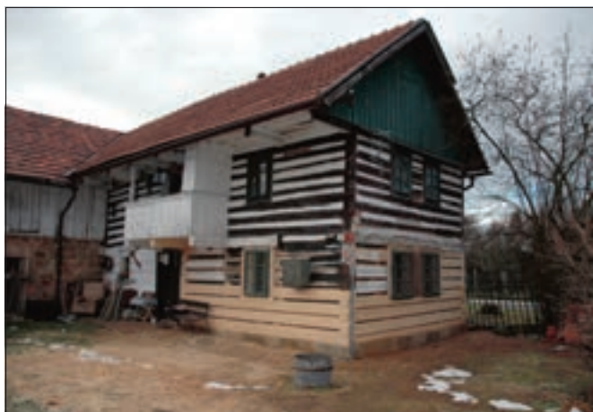
Lobeč (okres Mělník), čp. 7. Obnova roubených stěn světnice si vyžádala v důsledku velmi špatného stavu trámů téměř celkovou výměnu. Součástí prací bylo rovněž přezdění podezdívky z pískovcových kvádrů. Po vyschnutí nového dřeva bude v příštím roce následovat vymazání spár a obnova vnitřních hliněných omítek (foto J. Berková).
