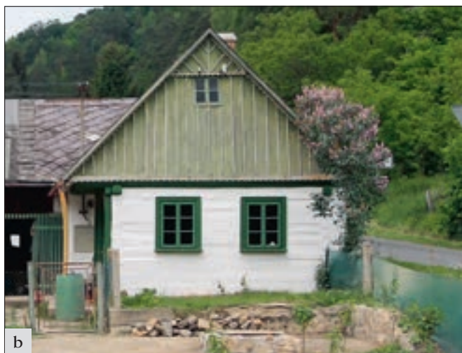
Podboře (okres Mladá Boleslav), usedlost čp. 5: a – stav v lednu 2012 (foto J. Tichá). Obnova roubení světnice proběhla již v roce 2014, dokončení vymazávek a obilnění na jaře 2015; b – stav v květnu 2015 (foto A. Rákosníková).
