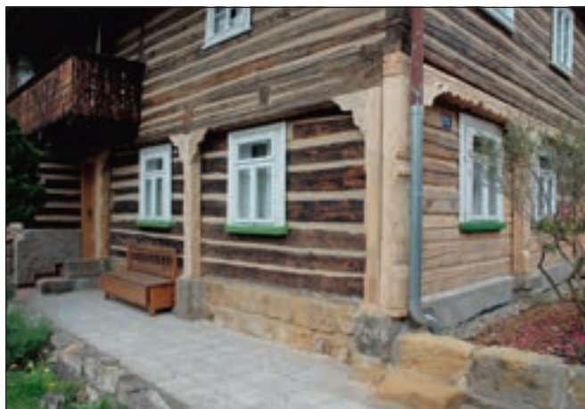
Nové Osinalice (okres Mělník), čp. 16. Roubený patrový dům není zapsanou památkou, přesto však významně ovlivňuje charakter památkové rezervace. Díky citlivému přístupu vlastníků byl odstraněn novodobý obklad z eternitových šablon a obnovena původní podoba vnějšího pláště, jehož nezdobnějším prvkem je bohatě profilovaná podstávka, obnovená podle místních analogií (foto J. Berková).
