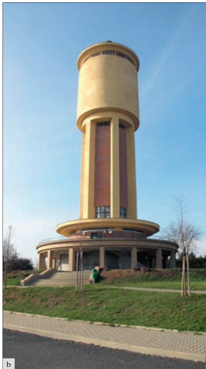
Kolín (okres Kolín), věžový vodojem na Pražském předměstí: a – stav v lednu 2015. Významná vodohospodářská památka byla upravena na vyblůdkovou věž. Opravu pláště, opatřenébo různobarevnými kamenicky opracovanými drťovými omítkami se však nepodařilo provést tak, aby byl podtržen působivý efekt této úpravy, typické pro 1. třetinu 20. století; b – stav v listopadu 2015 (foto A. Rákosníková).
