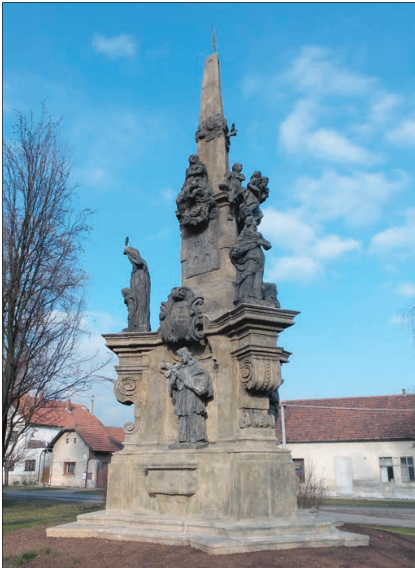
Chlumín (správní obvod Neratovice), sloup Nejsvětější Trojice, stav po restaurování. Dílo Jana Pursche z roku 1729, které vzniklo na objednávku Anny Marie Františky velkovévodkyně Toskánské, bylo ve špatném stavu. Restaurování probíhalo ve dvou etapách. Bylo zaměřeno na odstranění řady nevhodných doplňků, především celoplošných tmelů z předchozích restaurátorských zásabů. Velká pozornost byla také věnována celkovému odvodnění architektury sloupu a jeho zpevnění (foto J. Weissová).
