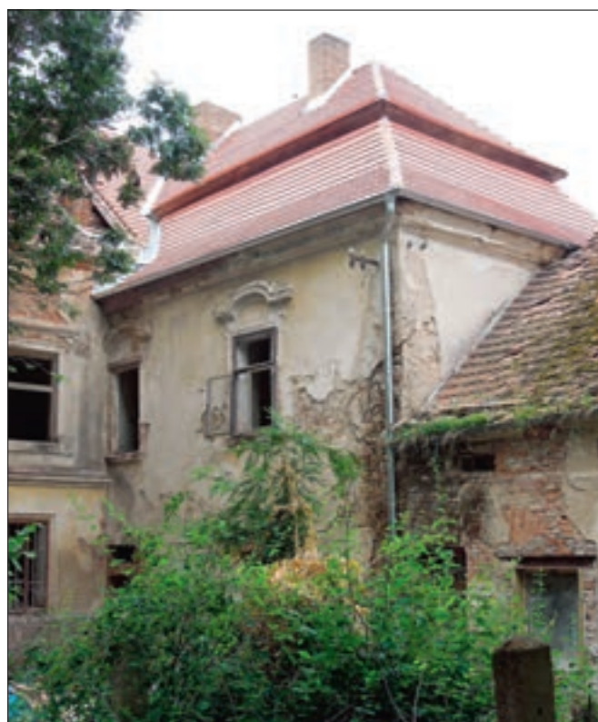
Chotýšany (okres Benešov), zámek, oprava střechy. Zámek je v důsledku chybějící údržby v posledních letech v havarijním stavu. V minulém roce byla konečně provedena oprava střechy barokního jižního křídla. Byly vyklizeny zřícené stropy nad patrem a osazeny nové stropní trámy, z nichž byl postupně tesařsky opraven poškozený krov a položena nová krytina z pálených bobrovek. Souběžně byla také opravena poškozená koruna obvodového zdiva a hlavní římsa (foto D. Primusová).
