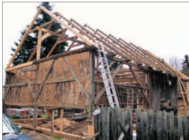
Pšovky (okres Rakovník), brázděná stodola u čp. 23 – probíhající tesařská obnova brázdění a krovu (foto M. Hanzlíková).
