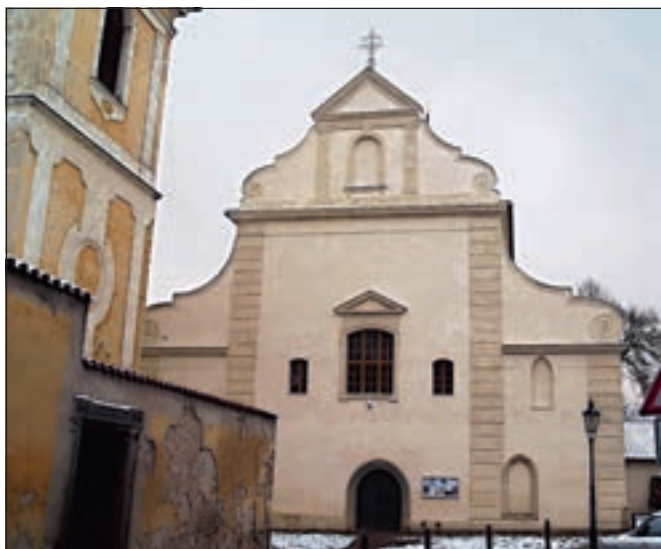
Brandýs nad Labem (okres Praha-východ), průčelí kostela Obrácení sv. Pavla. V rámci poslední etapy bylo obnoveno západní průčelí kostela. Byly provedeny opravy omítek, architektonických článků, klempířských prvků, okenních výplní, restaurátorským způsobem bylo opraveno kamenné ostění vstupního portálu a okenních otvorů. Restaurátorsky byla zhotovena repase dveří do jižní před síně a vstupu na kruchtu na jižním průčelí stavby. V rámci obnovy proběhl restaurátorský průzkum omítek, který přinesl některé další dílčí poznatky o stavebním vývoji průčelí (foto. P. Kroupa).
