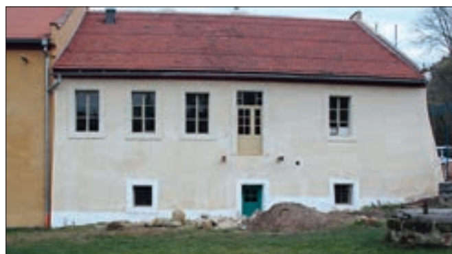
Lobeč (okres Mělník), tzv. sládkův dům v průběhu obnovy vnějšího pláště. Velmi pozitivní vliv na vzhled stavby mělo navrácení tradičně členěných oken podle původního stavu. Před dveřmi v patře byl podle dobového stavu obnoven dřevěný zdobený arkýř (foto J. Berková).
