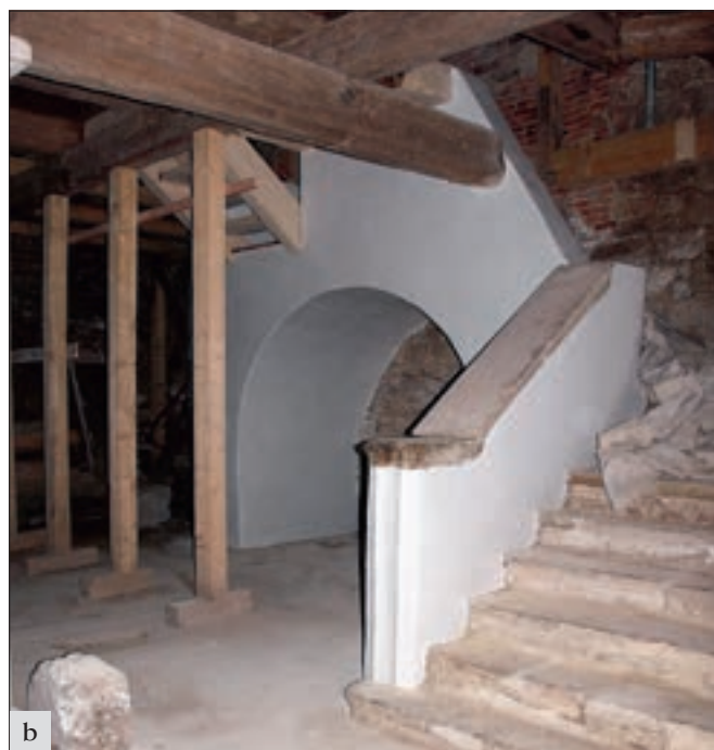
Vepřek (okres Mělník), čp. 19.: a – schody do sníženého přízemí mlýnice. Stav před obnovou. V pozadí vlevo poškozený peron s propadlou klenbou, který vynášel schody do zvýšeného přízemí; b – schody do sníženého přízemí mlýnice. Vlevo obnovený peron s navazujícími žebříkovými schody do zvýšeného přízemí. V popředí parapetní zídka s korunou z masivní kamenné desky a s profilovaným sloupkem při nástupu na schody (foto M. Hanzlíková).
