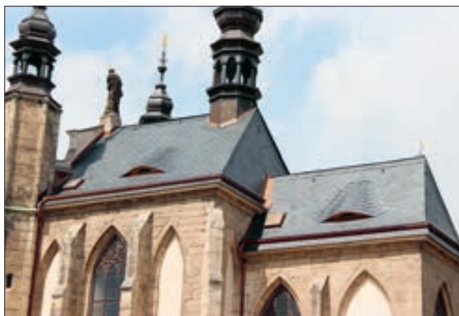
Kutná Hora-Sedlec, kaple Věch Svatých s kostnicí. Náročná akce generální obnovy kaple Věch Svatých s kostnicí v Sedlci pokračovala další etapou, v rámci níž byla dokončena obnova střech horní kaple a jižní terasa spodní kostnice. Při obnově střech se na podnět odborných pracovníků NPÚ podařilo prosadit neobvyklé řešení spodního ukončení střechy pod žlabem, kde namísto podkladního plechu je pás šablony. Toto řešení spolu s odlišnou skladbou krytiny střechy lodí a presbytáře navazuje na stav po obnově v 70. letech 19. století a zachycují jej historické fotografie (foto A. Pospíšil).
