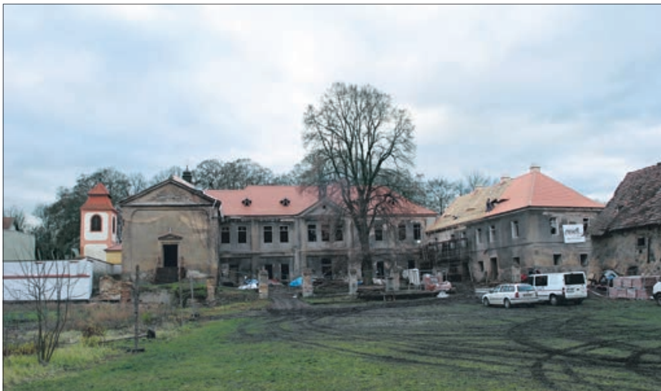
Koleč (okres Kladno), areál zámku s kostelem Nejsvětější Trojice od severu, z prostoru přileblého bývalého hospodářského dvora. V roce 2015 byla zahájena rekonstrukce celého západního křídla (na fotografii vpravo) s pokládkou nové krytiny z bobrovek. Stav přízemí renesančního křídla, barokně a klasicistně přestavěného, byl před opravou baviřijní. Díky získání finančních prostředků z Norských fondů se jej doslova „na poslední chvíli“ podařilo stavebně zachránit (foto E. Volfová).
