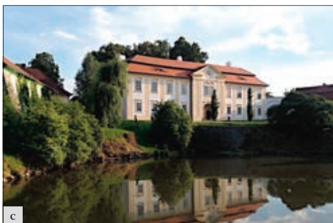
Skřýšov (okres Příbram), obnova zámku. Zámek ve Skřýšově prošel několikaletou obnovou, která vyvrcholila obnovou fasád: a – řada architektonických článků byla ve špatném stavu. Opravě předcházelo provedení operativního průzkumu a dokumentace; b – architektonické články, jak ukazuje např. detail šambrány se suprafenestrou, se podařilo kvalitně štukatérsky opravit; c – úspěšný výsledek dokládá nejen předešlý detail, ale i celkový pohled na zámek z prostoru dvora (foto H. Řepková a K. Roden).
