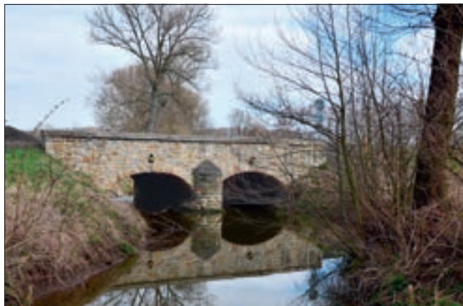
Vyšehořovice (okres Praha-východ) – kamenný most přes potok Výmolu, nejspíše starší než z roku 1826, který byl uveden na datovacím kvádru. Dokumentace proběhla těsně před demolicí, k níž došlo přes námítky památkové péče v létě 2015 (foto V. Jesenský).
