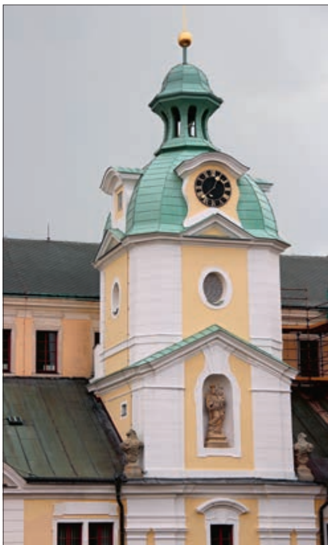
Kutná Hora-Sedlec, čp. 1. Mimořádné práce se v roce 2015 odebrávaly také v areálu firmy Philip Morris ČR a.s. Započala zde první etapa obnovy střech na budově mohutného trojlodního konventu, resp. Santiniho věže. Vážně napadená konstrukce krovu, datovaná do let 1716–1718, byla obnovena za použití celodřevěných spojů a měděnou krytinu nabradila nová, s uměle vytvořenou ušlechtilou patinou, dovezená z Finska. Současně bylo důkladně opraveno architektonické členění fasád věže (foto A. Pospíšil).
