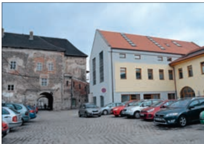
Kolín (MPR), areál zámku, přístavba jižního křídla bývalého purkrabství. Pobléd na novostavbu podnikatelského inkubátoru z nádvoří pivovaru. Novostavba stojí na půdorysu zaniklé spilky z roku 1863, suterén tvoří původní konstrukce spilky s litinovými středovými pilíři. Novostavba, zejména díky industriálním kovovým okenním výplním, zachovala charakter průmyslové stavby a svým hmotovým řešením se zdařile zapojila do prostoru předpolí areálu zámku s další chátrající budovou samotného pivovaru (foto D. Havlíková).
