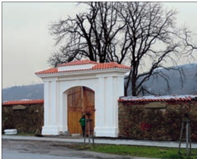
Králův Dvůr (okres Beroun), obnovená brána zámeckého parku. V roce 2015 konečně došlo na opravu brány a úseku obradní zdi části někdejší zámecké zabradly, po stavbě dálnice odtržené od vlastního zámku. Brána byla ve velmi špatném stavu. Podařilo se obnovit omítky s architektonickými články, korunu a do brány osadit nová dřevěná vrata vycházející z typických soudobých předloh. Obradní zeď nebyla prozatím omítána (foto E. Kosová).
