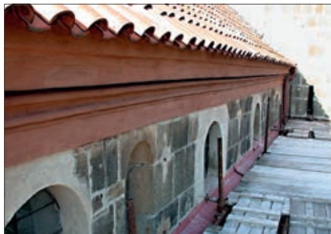
Tismice (okres Kolín) , bazilika Nanebevzetí P. Marie . Pobled na převyšenu hlavní loď ze severu po plošném zpevnění kvádríkového zdiva s hrubým spárováním před začištěním, po začištění barokně upravených půlkruhových oken a po úpravě hlavní římsy s navrácenou terakotovou barevností (foto E. Zápalková).
