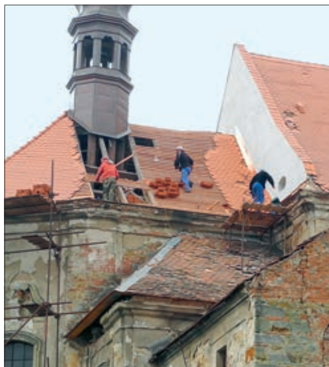
Březno (okres Mladá Boleslav), kostel sv. Václava v průběhu prací při obnově krytiny nad presbytářem (foto E. Vyletová).
