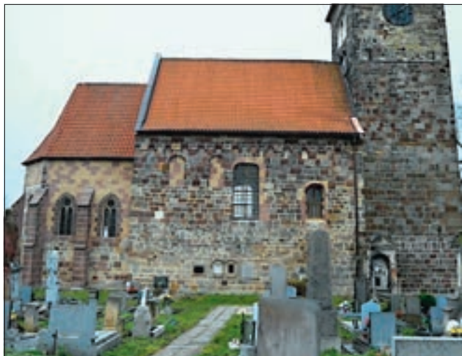
Plaňany (okres Kolín), kostel Zvěstování Panny Marie. Pobled na severní fasádu lodě po restaurování kvádríkového zdiva a obnově omítek s rekonstrukcí kvádríkového zdiva z roku 1892 v prosinci 2015. Omítková imitace kvádríků navazuje na románské zdivo tří barev (tři druhů pískovců), doložené již na vyobrazení z konce 18. století. Patrně se jedná o barokní úpravu opakovanou při rekonstrukci dle návrhu Josefa Mockera v roce 1892. U presbytáře došlo k atypickému řešení, kdy kvádríkováání nebylo provedeno v celé ploše a je na značné části nahrazeno reznou hrubou omítkou s imitací pouze nárožních armovacích kamenů. Zde došlo v průběhu realizace 2015 k neshodě mezi investorem a památkovou péčí, která chtěla akceptovat náleзовou situaci bez dobarvení kvádríků v chybějící ploše (foto D. Havlíková).
