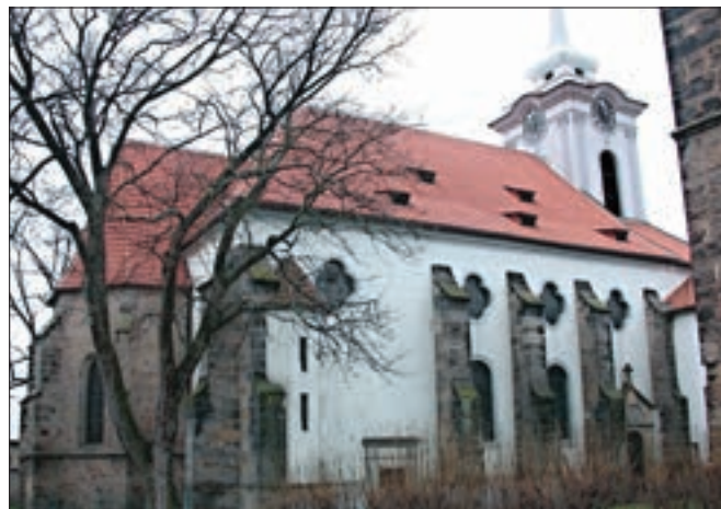
Český Brod (okres Kolín), kostel sv. Gotharda . Letos byla dokončena poslední etapa výměny střešní krytiny na rozměrné sjednocující střeše původně gotického bazilikálního trojlodí a na nižším polygonálním presbytáři (foto E. Zápalková).
