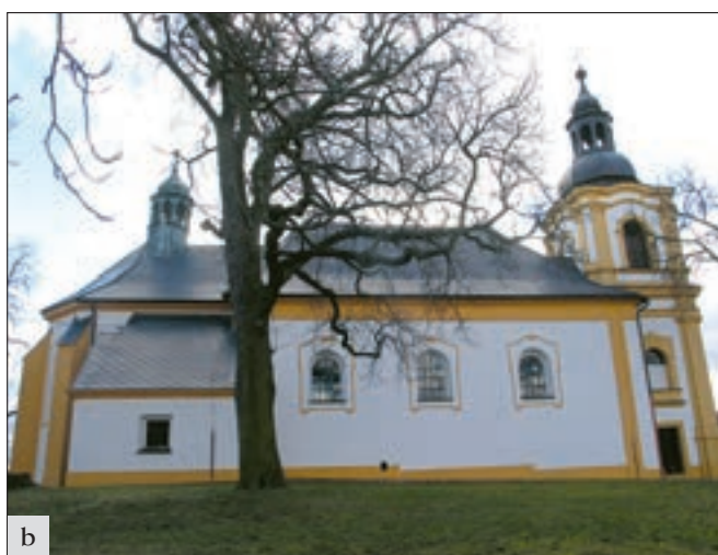
Čistá (okres Rakovník), kostel sv. Václava: a – severní strana kostela na počátku oprav v prosinci 2006; b – severní fasáda kostela po dokončení opravy obvodového pláště, zde při ukončení opravy fasádních omítek v srpnu 2015 (foto E. Volfová).
