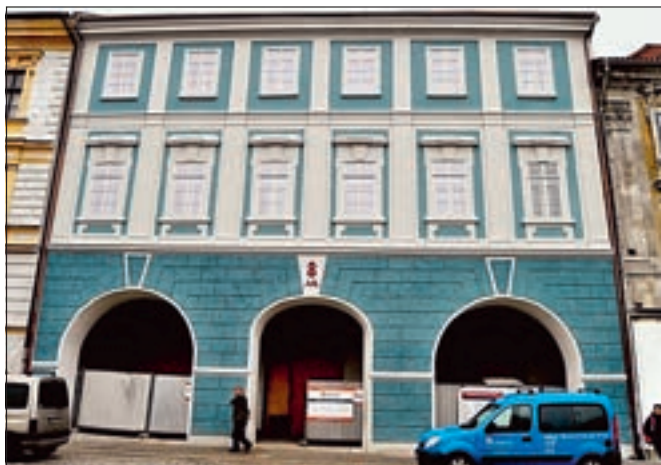
Kolín (MPR), dům čp. 8 na Karlově náměstí. Pobléd na uliční fasádu měšťanského domu, stav po obnově s barevností dle náleзовé situace stratigrafického průzkumu z lešení a s osazenými novými špaletovými okny. Rekonstrukce domu byla přerušena v roce 1989 a od té doby dům chátral. Nyní je přestavován pro potřeby Regionálního muzea Kolín s novostavbou depozitáře na nádvoří. Rekonstrukce, financovaná z dotací IOP a realizovaná firmou GEOSAN s. r. o., se od září 2015 potýká s finančními problémy (foto D. Havlíková).
