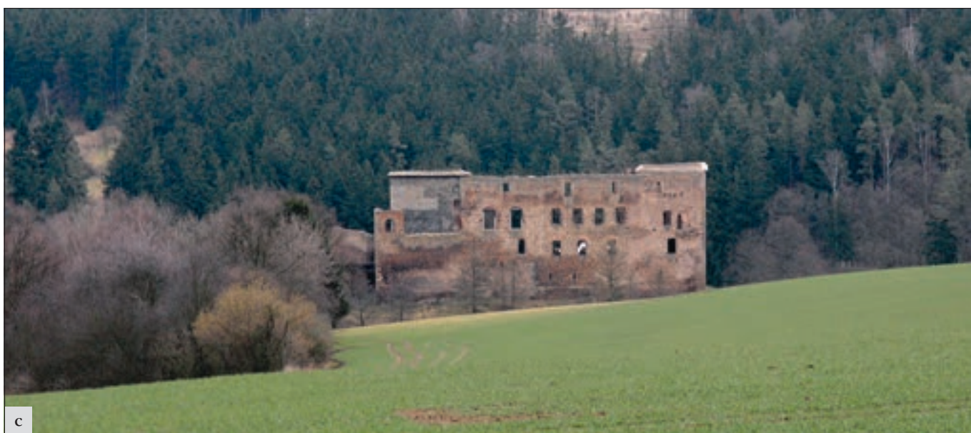
Krakovec (okres Rakovník), bradní nádvoří, východní závěr jižního křídla: a – dokončování konstrukce experimentálního zastřešení pokládkou jutových pytlů se zeminou smíchanou s travním semenem v listopadu 2015; b – prostor kaple v březnu 2016, zakrytí novou konstrukcí z odkorněných smrkových kmenů kladených na sraz; c – celek bradní zříceniny se střechou nad věží a na jižním křídle nad kaplí v únoru 2016, v pobledu od západu ze silnice od Šípů. Experimentální zastřešení, chránící nejcennější části bradu, je plně reverseibilní a rozrůstající porost jej postupně promění v „drnové“ koruny (foto J. Sobek, E. Volfová).
