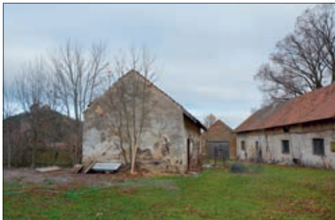
Točnick (okres Beroun) – usedlost čp. 4. Dokumentace klasicistní vesnické usedlosti s chlévem (se seníkem a bolubníkem v patře – vlevo), podsklepeným obytným stavením s černou kuchyní (vpravo) a zadní stodolou byla provedena nedlouho před demolicí předních budov. Bezobledně tak byl zničen hodnotný doklad tradiční zástavby i historického urbanismu (foto V. Jesenský).
