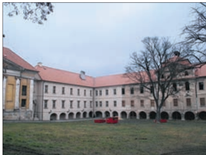
Buštěhrad (okres Kladno), západní křídlo zámku v pobledu přes vnitřní nádvoří. Tato část patří městu a byla v minulých letech rekonstruována pro potřeby městského úřadu. V roce 2015 se opravovaly omítky uliční a dvorní fasády, oplechování parapetů a vápenný okrový nátěr. Zbytek zámku, na fotografii vpravo, patří Středočeskému kraji (foto E. Volfová).
