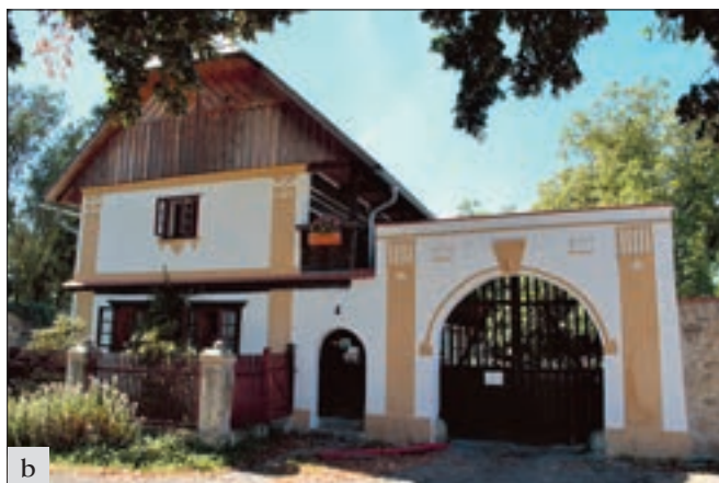
Skalsko (okres Mladá Boleslav), brána usedlosti čp. 6: a – tradiční vjezdová brána z roku 1833 se na jaře roku 2013 výrazně vychýlila od svislé osy a brozila zřícením; b – po náročném statickém zajištění, realizovaném v roce 2014, byla akce dokončena obnovou fasády brány a hlavního průčelí domu. Celá usedlost tak opět získala svoji malebnou podobu, jíž velmi pozitivně dotváří charakter památkové zóny (foto J. Berková).
