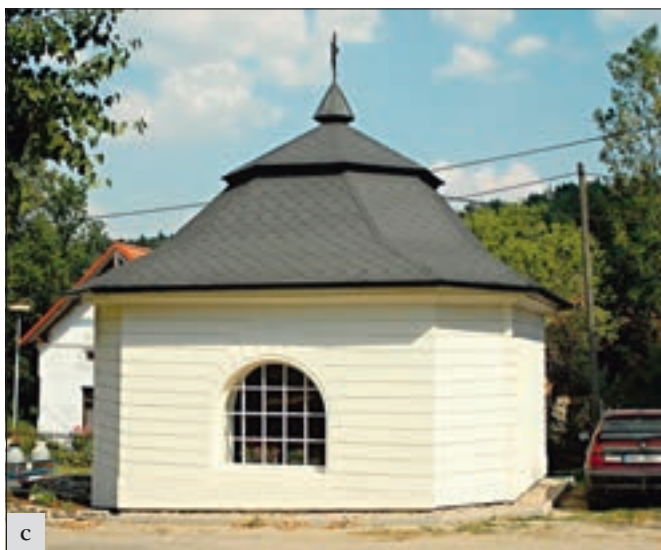
Sudějov (okres Kutná Hora), areál kostela sv. Anny, studniční kaple. Stávající studniční kaple nahradila v nové poloze starší stavbu s vodním pramenem krátce před rokem 1850. V průběhu času došlo k různým opravám a úpravám a původní členění fasád pásovou rustikou zaniklo: a – průzkum provedený před opravou odkryl dochovanou část původní úpravy; b – na základě průzkumu byla v rámci odborné pomoci ÚOP SČ zhotovena rekonstrukční skica, která byla podkladem pro realizaci obnovy; c – stav po obnově, kdy chybí jen navrácení odpovídající krytiny (foto M. Jedlička a J. Žižka).
