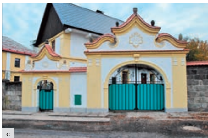
Skalsko (okres Mladá Boleslav), brána u domu čp. 19: a – původní štuková výzdoba této mimořádně honosné brány z roku 1833 zanikla při necitlivé opravě v 80. letech 20. století. Podkladem pro její obnovu byla dohledaná dobová fotodokumentace a analogie s jinými branami tohoto souboru štítových bran; b – nejnáročnější částí prací byla obnova hlavního prvku výzdoby – štukové kartuše s datací (návrh zpracoval památkový dozor); c – výsledek obnovy je příkladem dobré úzké spolupráce NPÚ s vlastníkem a štukatérskou firmou (foto J. Berková).
