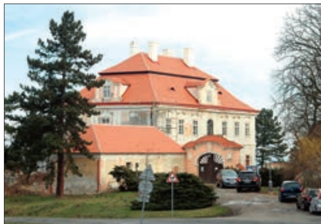
Panenské Břežany (okres Praha-východ), pohled na horní zámek. V roce 2015 probíhala první část rozsáhlé obnovy zámku, při které byla především obnovena mansardová střecha s komíny a okenní výplně (foto J. Žižka).
