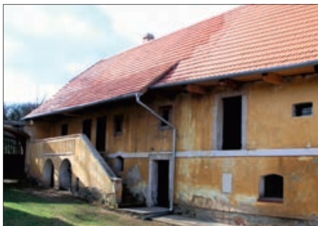
Třebíz (okres Kladno), usedlost čp. 2, přední část stavby – dokončená poslední etapa obnovy stropů, krovu a střešního pláště stáji (foto M. Hanzlíková).
