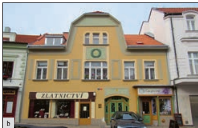
Mělník, dům čp. 25 před a po obnově v roce 2015. Secesní dům čp. 25 patří mezi mělnické domy s nejlépe dochovaným průčelím: a – stav před opravou; b – při opravě průčelí, které předcházela obnova krytiny, se podařilo fasádu očistit, tvarově kvalitně opravit a opatřit novým nátěrem včetně vrat (foto A. Burešová).
