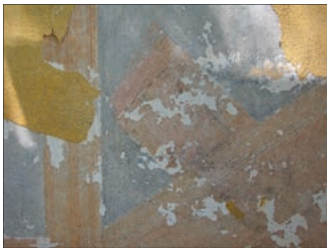
Skryšov u sv. Jana (okres Příbram) – zámek čp. 1. Detail iluzivního malovaného okna na jižní fasádě zámku. Při podrobné operativní dokumentaci, prováděné před obnovou průčelí z lešení, bylo možné studovat také techniku provedení výmalby – malba al fresco s předcházejícím vyrytím hlavních linií. Tvar čel perspektivně zobrazených trámů v pootevřeném okně byl během provádění korigován (foto J. Veselý).
