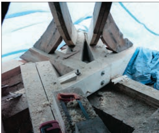
Bošín (okres Nymburk), kostel Nanebevzetí Panny Marie – detail výměny a doplnění dožilých prvků krovu helmice (foto M. Hanzlíková).
