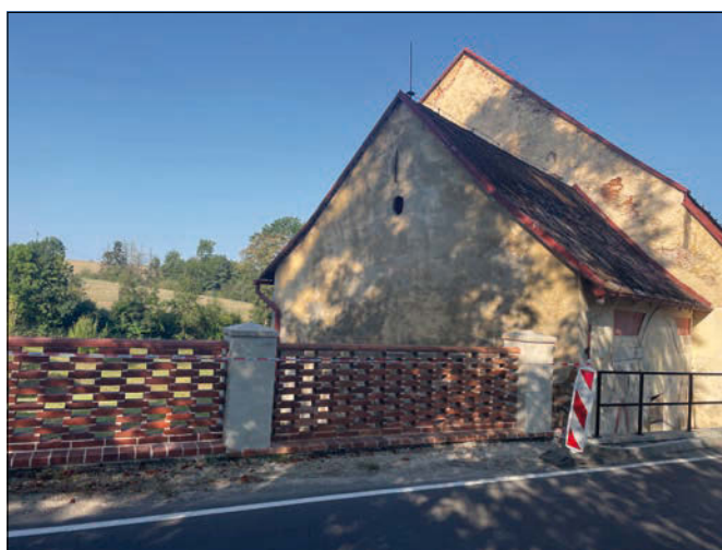
Komorní Hrádek (správní území obce Benešov), areál zámku, oplocení ovocného sadu. Součástí obnovy bylo také provedení nové kamenné opěrné zdi podél silnice II. třídy, jejíž nadzemní část tvořily zděné pilíře kryté kamennými deskami s výplněmi z pálených cihel a tvarovek. Vzhledem k tomu, že oplocení se zachovalo jen v torzálním stavu, bylo z původního materiálu provedeno pouze jedno pole a další byla vyzděna z nového páleného materiálu, který se tvarově shoduje s původním a byl vyroben na zakázku (foto D. Primusová).
