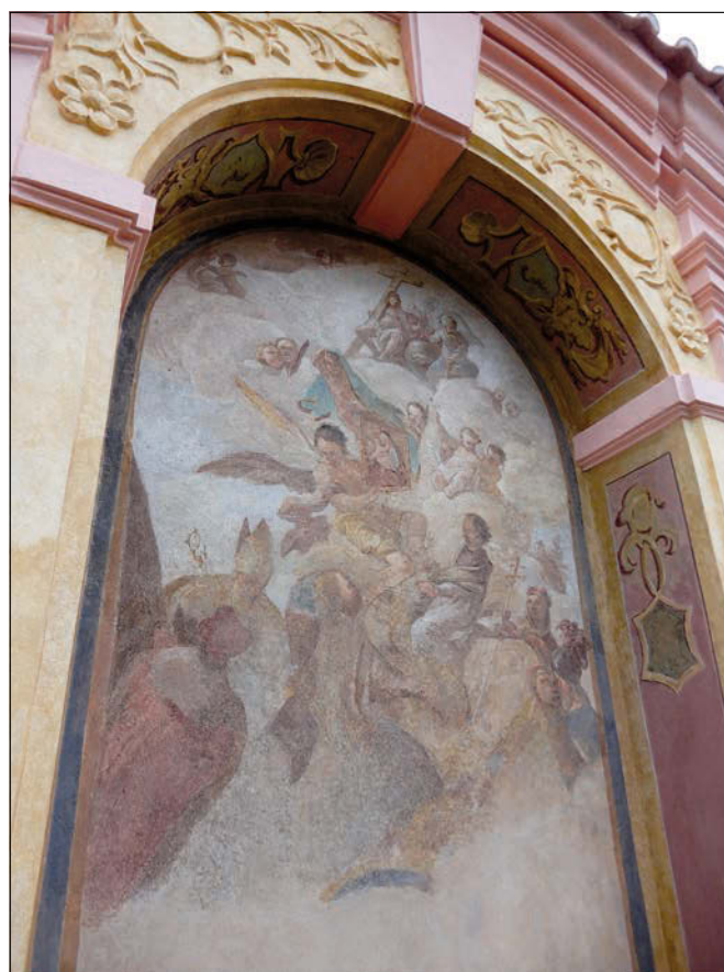
Hradištko (správní obvod obce Černošice), zámek, nástenná malba ve výklenkové kapli č. 2 v ohradní zdi areálu po restaurování (foto T. Cachová).
