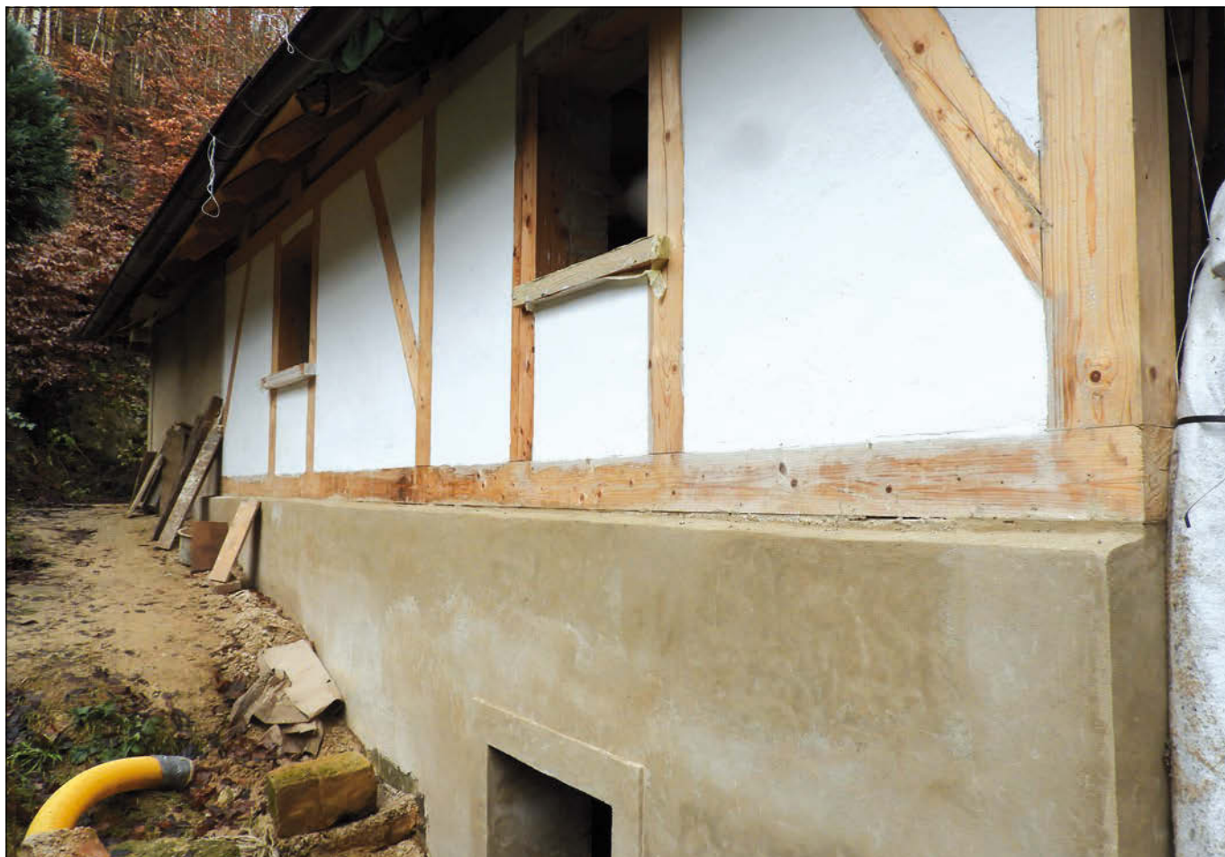
Olešno (správní obvod obce Mělník), VPR, poloroubený dům usedlosti čp. 1. V rámci celkové sanace hospodářského dílu domu zničeného dřevomorkou byla obnovena (rekonstruována) také hrázděná konstrukce druhého (výměnkářského) traktu v patře, založená na koruně přezděného přízemí, které je z větší části zapuštěno do okolního svažitého terénu (foto J. Berková).
