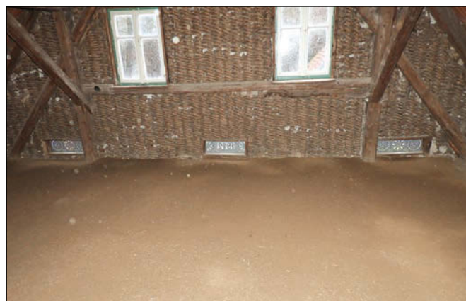
Vidím (správní obvod obce Mělník), VPZ, dům čp. 80. Pohled do prostoru půdy nad obytnou částí s obnovenou hliněnou podlahou a ojediněle zachovaným vyplétaným štítem, dokládající původní lidové stavební techniky a technologie (foto J. Berková).
