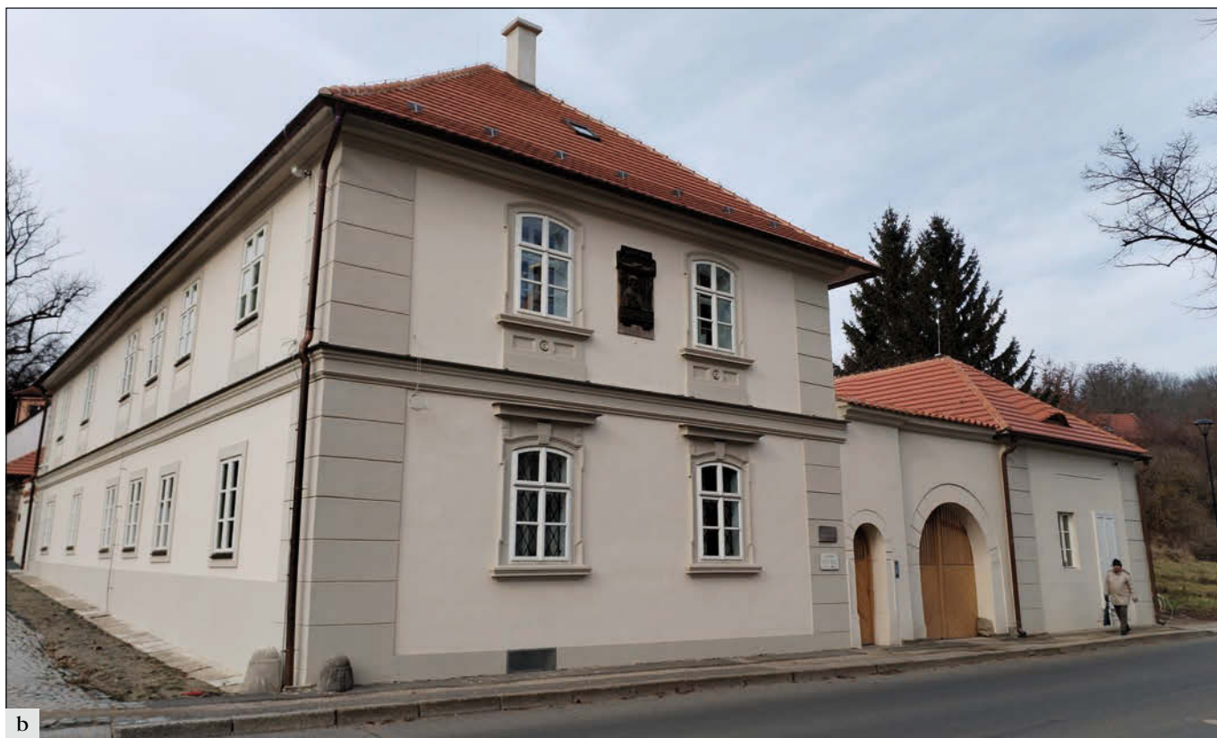
Nelahozeves (správní obvod obce Kralupy nad Vltavou), Památník Antonína Dvořáka čp. 12: a – stav před opravou; b – stav po první stavební etapě (foto P. Kalinová).
