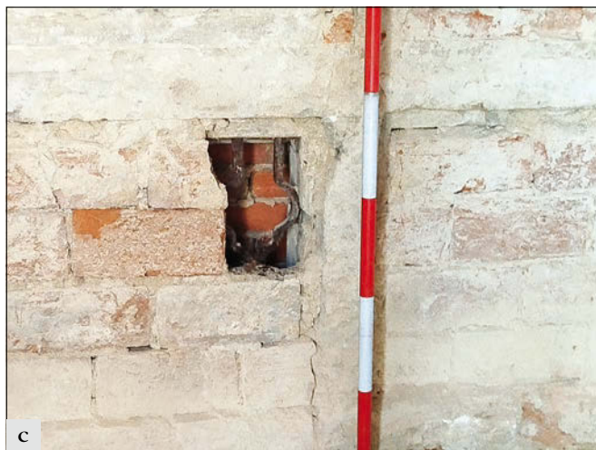
Lysá nad Labem (správní obvod obce Lysá nad Labem), západní křídlo kláštera, prostor bývalé garáže barona Dr. Leitenbergera z konce 19. století: a - nález půdorysu odstraněného barokního klášterního kostela; b - odhalení jihozápadní partie s levým úsekem barokního zdiva, se zazděným termálním oknem a zazděnými světlíky v kamenném ostění; c - detail odhalené barokní mříže ve světlíku (foto E. Zápalková).
