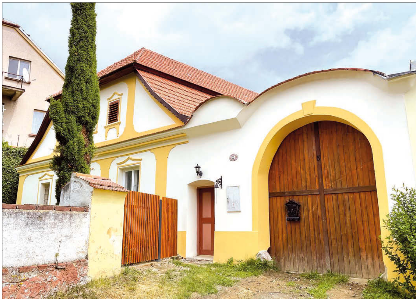
Načeradec (správní území obce Vlašim), venkovská usedlost čp. 5. V loňském roce byla po nedávné obnově střechy obytná budova usedlosti rehabilitována kvalitní opravou zdobného barokního průčelí, při které byly napraveny některé nevhodné zásahy do omítek provedené v minulosti. Zejména byla věnována pozornost tvarování a profilaci štukových článků (foto D. Primusová).
