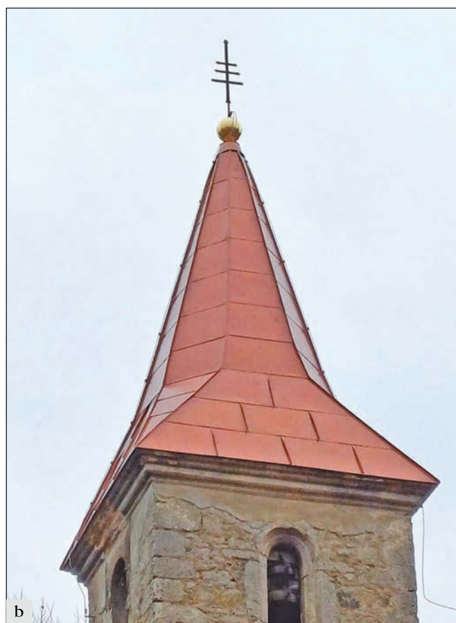
Hostín (správní obvod obce Kralupy nad Vltavou), kostel Nanebevzetí Panny Marie: a – stav střechy věže před opravou; b – stav střechy po opravě krovu a novém oplechování (foto P. Kalinová).
