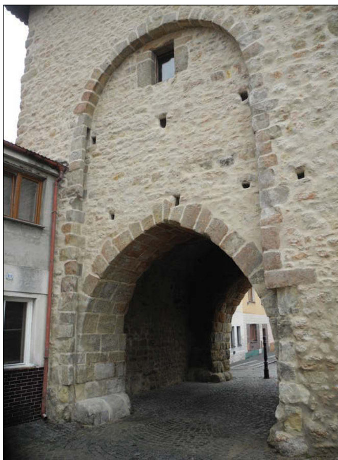
Bělá pod Bezdězem (správní obvod obce Mladá Boleslav), Česká brána, západní průčelí po konzervaci zdiva a tesaných prvků. Stav pískovcového zdiva a části tesaných prvků byl před zahájením prací již na mnoha místech havarijní. Pískovcové zdivo bylo narušeno zvětráváním a docházelo k odlučování vrstev kamene, které je pro pojizerský pískovec typické. Konzervační práce zahrnovaly restaurátorské zajištění tesaných prvků včetně injektáží trhlin a doplňků z umělého kamene. Ve velkém rozsahu musela být doplňována spárovací malta, která byla pečlivě přitažena k povrchu kamene (foto E. Vyletová).
