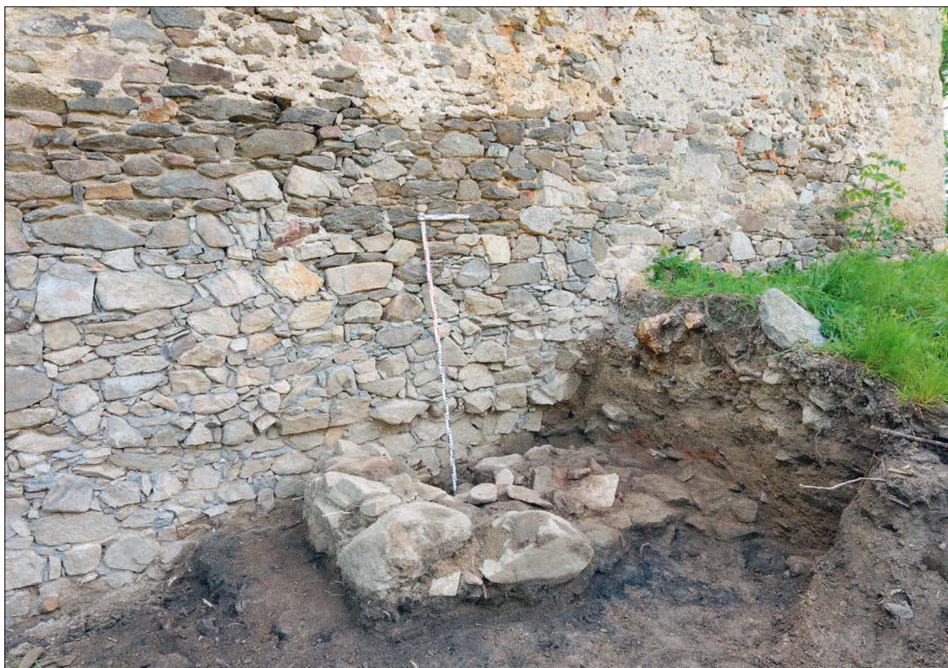
Beztahov (okres Benešov), západní průčelí tvrže, pohled od severozápadu. V popředí vystupuje fragment nároží základového zdiva či podezdívky starší konstrukce. Ta byla zavezena navážkovou vrstvou, zřejmě z velké části svou vlastní destrukcí (viz řez terémem na snímku vpravo). Z povrchu tohoto zásepů byla vyhloubena stavební jáma pro založení současné tvrže (foto Z. Neustupný).
