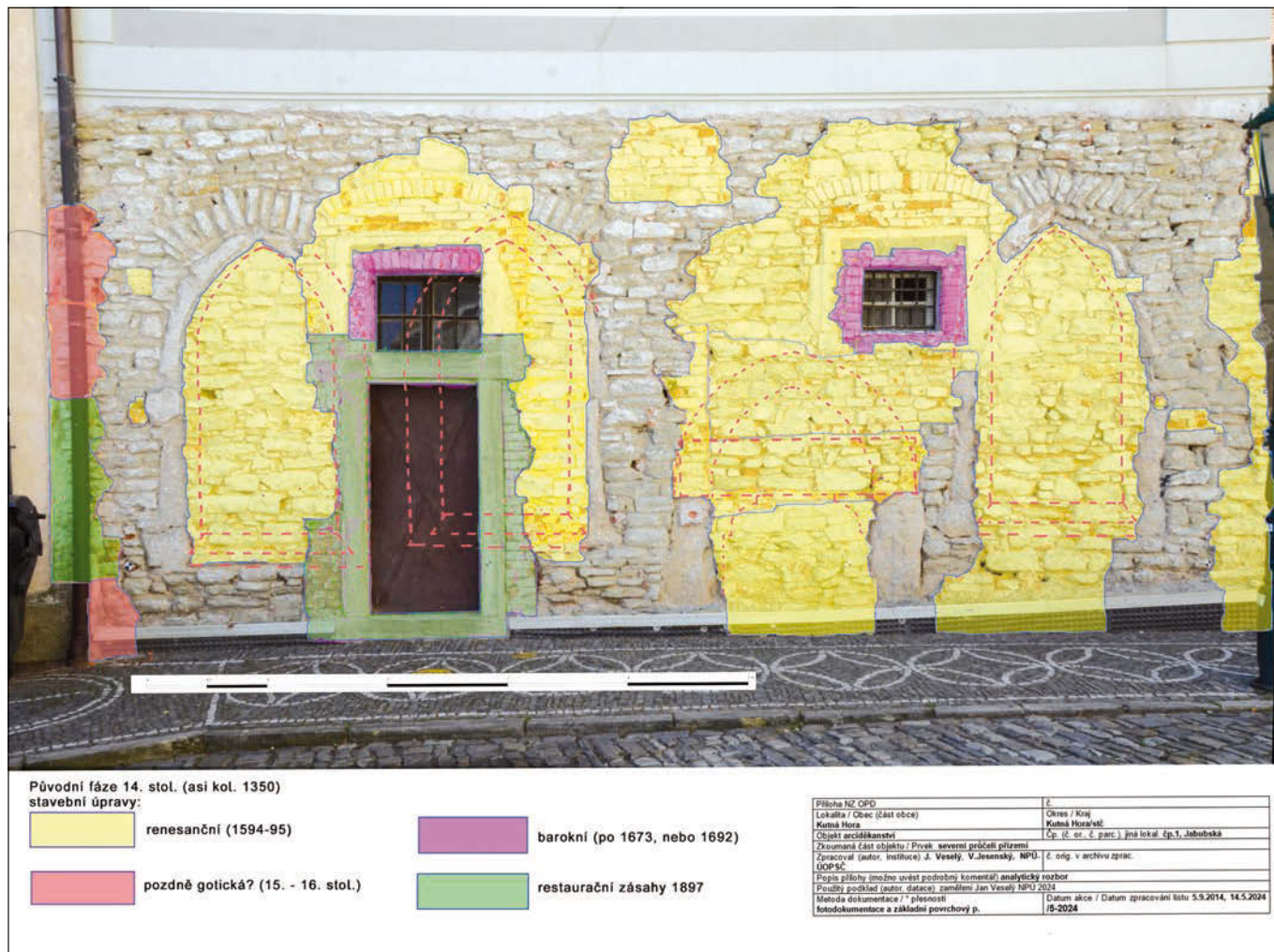
Kutná Hora (okres Kutná Hora), arciděkanství čp. 1, Jakubská – Unikátní gotické průčelí předhusitské školy odkryté nešetrným otlučněním fasády bylo zkoumáno hloubkovým průzkumem s odpovídající dokumentací. Interpretace stratigrafie zdiva byla provedena ve vyhotoveném fotoplánu (foto a dokumentace V. Jesenský a J. Veselý, 2024).
