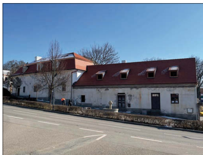
Pyšely (správní obvod obce Benešov), areál zámku, domy čp. 5 a 6. V posledních letech probíhá záchrana domů, které vznikly barokní přestavbou renesančních objektů a tvoří východní stranu náměstí v Pyšelích. Noví majitelé započali práce obnovou střech, které byly vzhledem k havarijnímu stavu původních provedeny nově (foto D. Primusová).
