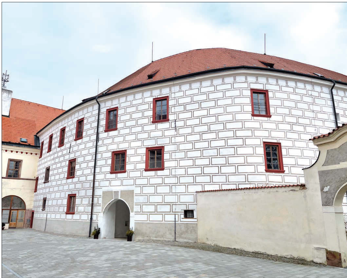
Komorní Hrádek (správní území obce Benešov), zámek. V loňském roce proběhla restaurátorská obnova jižní a západní fasády Starého zámku, která je pokryta sgrafity (foto D. Primusová).
