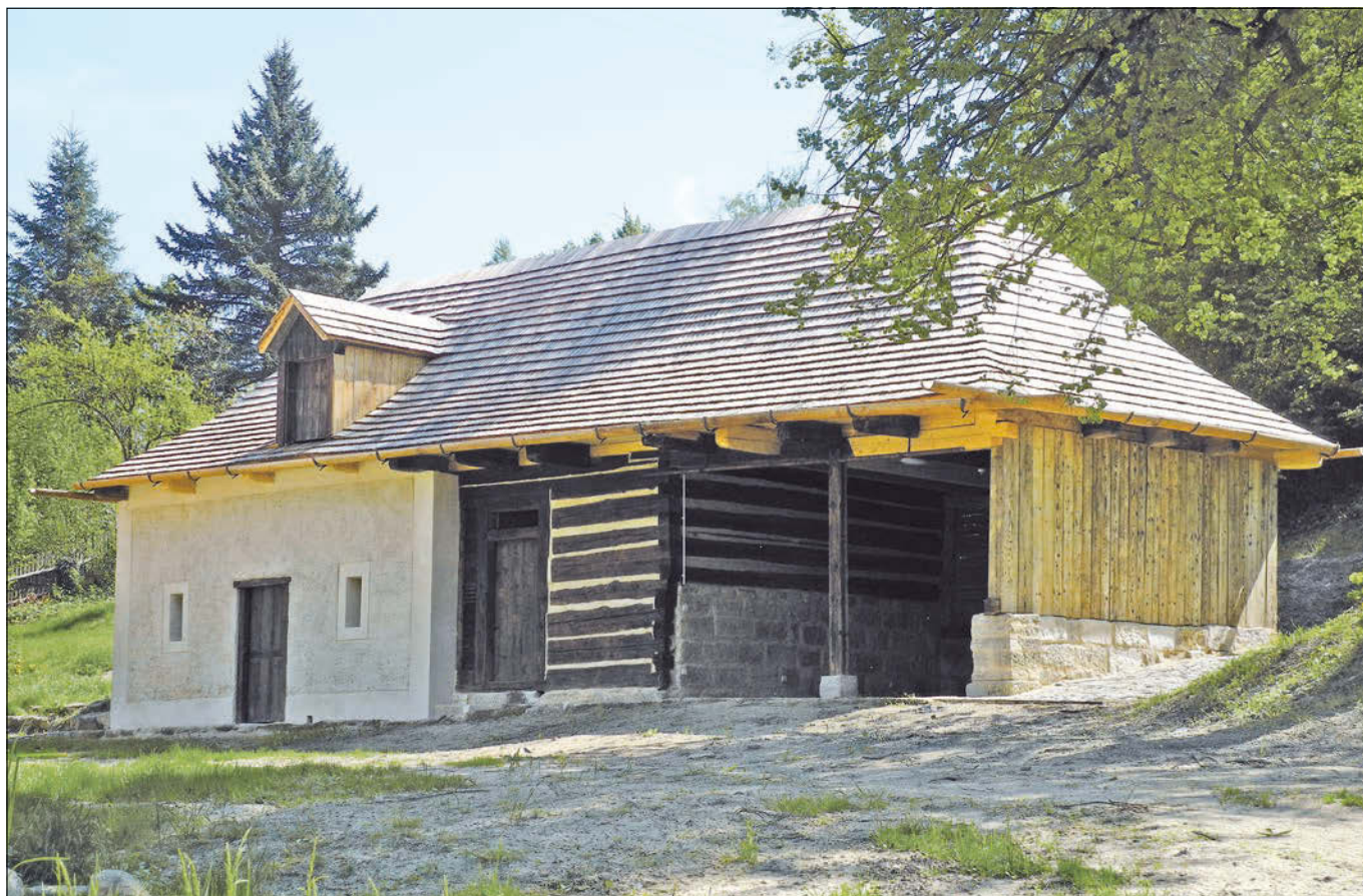
Dolní Krupá (správní obvod obce Mnichova Hradiště), hospodářská budova v areálu fary po celkové obnově. Objekt byl ve špatném stavu s dožilou krytinou. V rámci obnovy byly řešeny některé nevhodné zásahy z minulých oprav včetně obnovy odstraněné části roubené stěny a krovu. Původní dlažby a další autentické prvky byly zachovány. Obnovena byla krytina z dřevěného šindele. (foto E. Vyletové).
