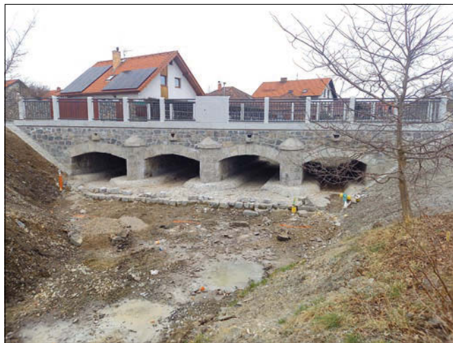
Podlešín (správní obvod obce Slaný), železniční most, stav po dokončení opravy, listopad 2024 (foto O. Hrdlička).
