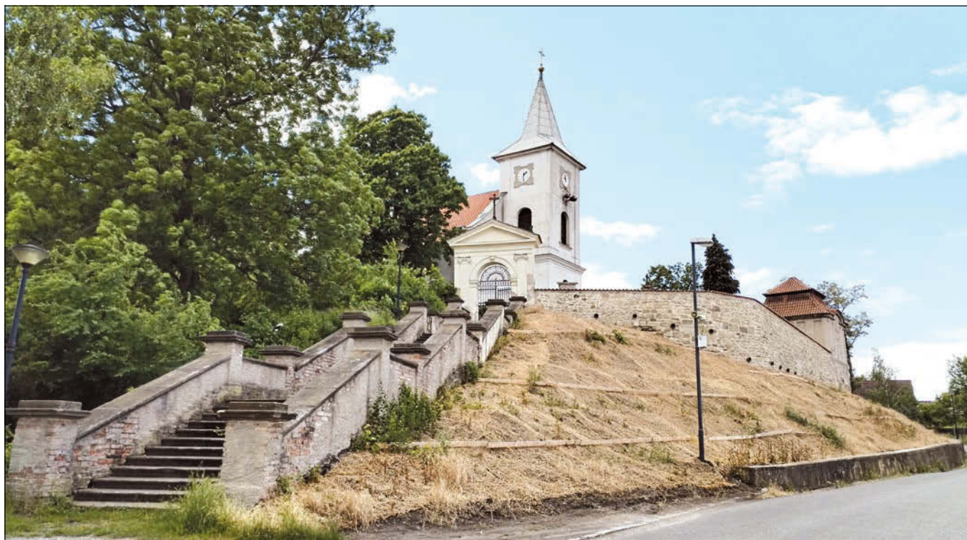
Kostelec nad Labem (správní obvod obce Netarovice), kostel sv. Martina, obnova západní ohradní zdi (foto P. Kalinová).
