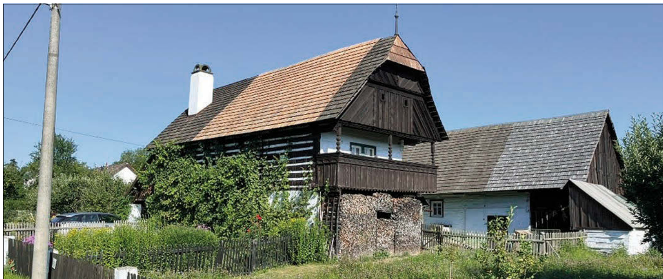
Žďár (správní obvod obce Mnichovo Hradiště)), dům čp. 7 s kovárnou. Unikátně dochovaná kovárna je jednou z nejcenějších památek tohoto druhu ve středních Čechách. Je zachovaná nejen v původní architektuře, ale také kompletním technickým vybavením. Proto je pravidelná údržba stavby a zejména střešního pláště zcela zásadní. Snímek zachycuje stav po dokončení opravy šindelové krytiny (foto T. Horáková).
