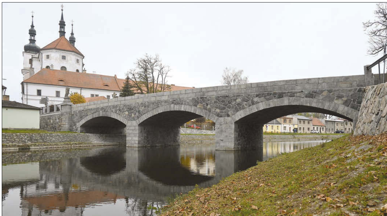
Březnice (správní obvod obce Příbram), silniční most přes Vlčavu, stav po dokončení opravy, listopad 2024 (foto O. Hrdlička).
