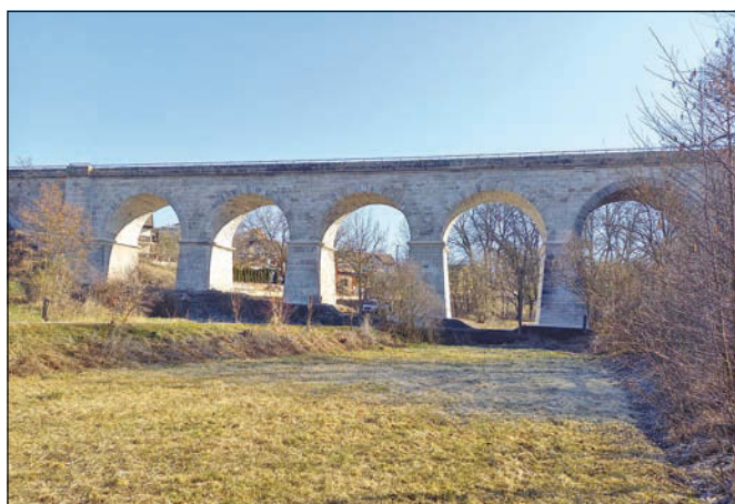
Dobříš (správní obvod obce Dobříš), silniční most přes Pilský potok, stav po dokončení opravy, prosinec 2024 (foto O. Hrdlička).
