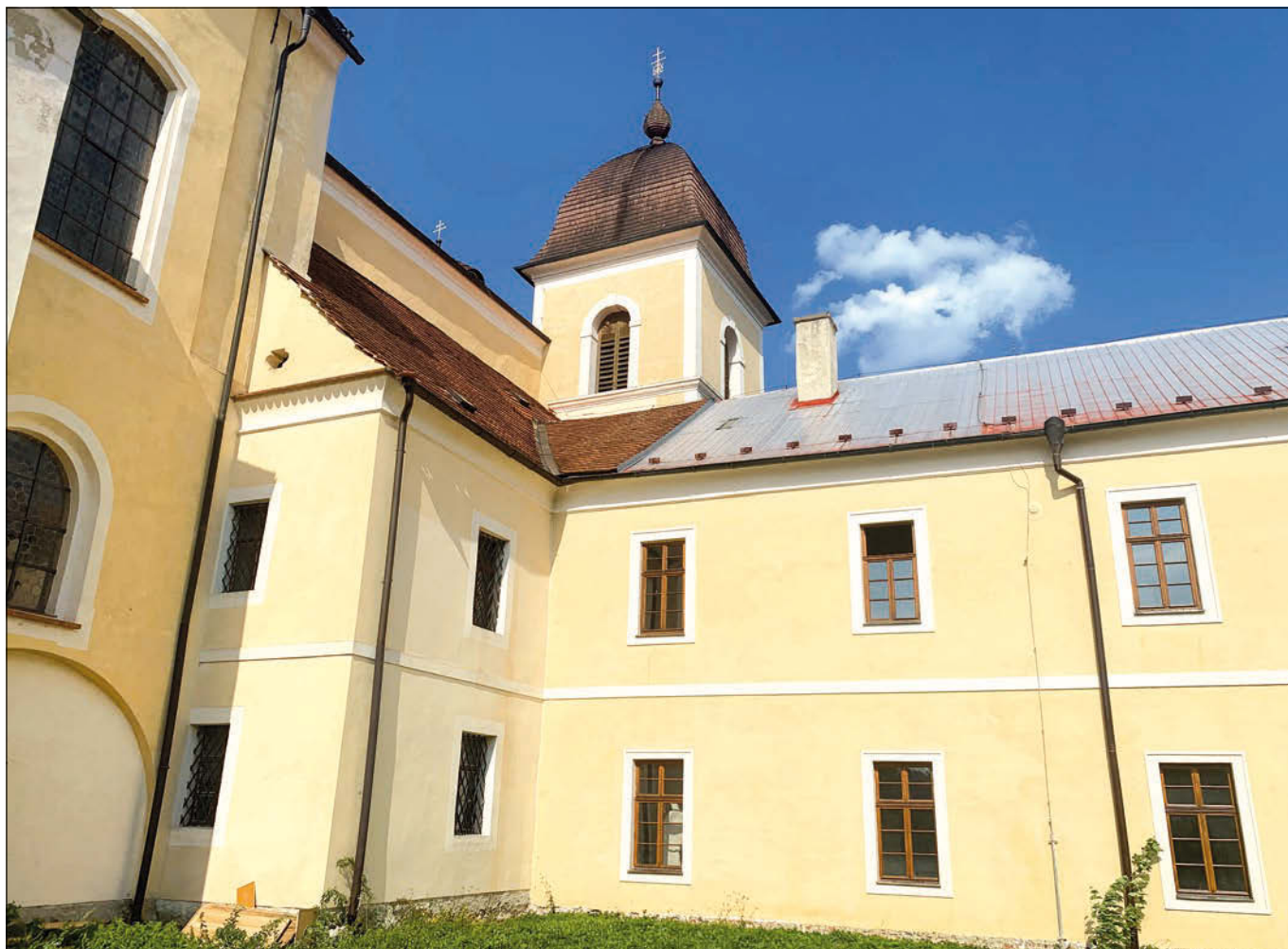
Zaječov (správní obvod obce Hořovice), klášter sv. Dobrotivá, záběr na část západní fasády východního křídla, jež byla se severní fasádou kolmého jižního křídla zdařile obnovena vápennou technologií. Provedený nátěr přirozeně navázal na kostel rekonstruovaný před více jak dvaceti lety (foto D. Hofreiterová).
