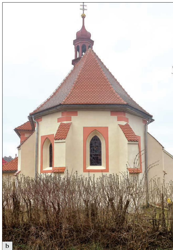
Řitovice (správní obvod obce Mladá Boleslav), kostel sv. Štěpána: a – stav presbytáře před opravou; b – presbytář po obnově omítek a malovaného členění podle nálezů z průzkumu. Starší vrstvy rezné omítky s paspartami oken byly restaurátorský konzervovány a překryty omítkou (foto E. Vyletová).
