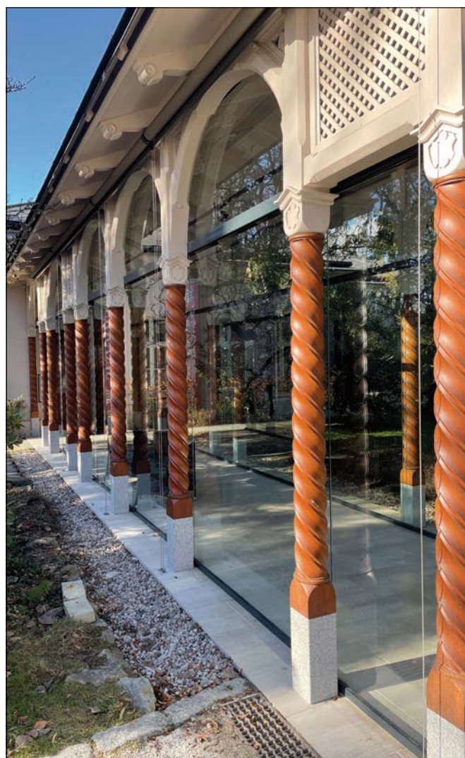
Ratměřice (správní území obce Votice), zámek. V areálu zámku v Ratměřicích byla v tomto roce provedena velmi zdařilá obnova spojovací chodby. Její dřevěná konstrukce byla velmi kvalitně repasována a propojení hlavní budovy s vedlejším pavilonem bylo ochráněno velmi citlivě, bezrámovým zasklením provedeným z vnitřní strany konstrukce (foto D. Primusová).
