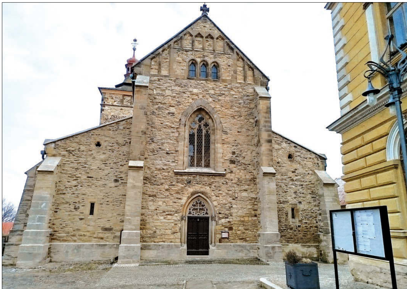
Kouřim (správní obvod obce Kolín), chrám sv. Štěpána, pohled na restaurované západní průčelí a repasované dvoukřídlé vstupní dveře (foto E. Zápalková).
