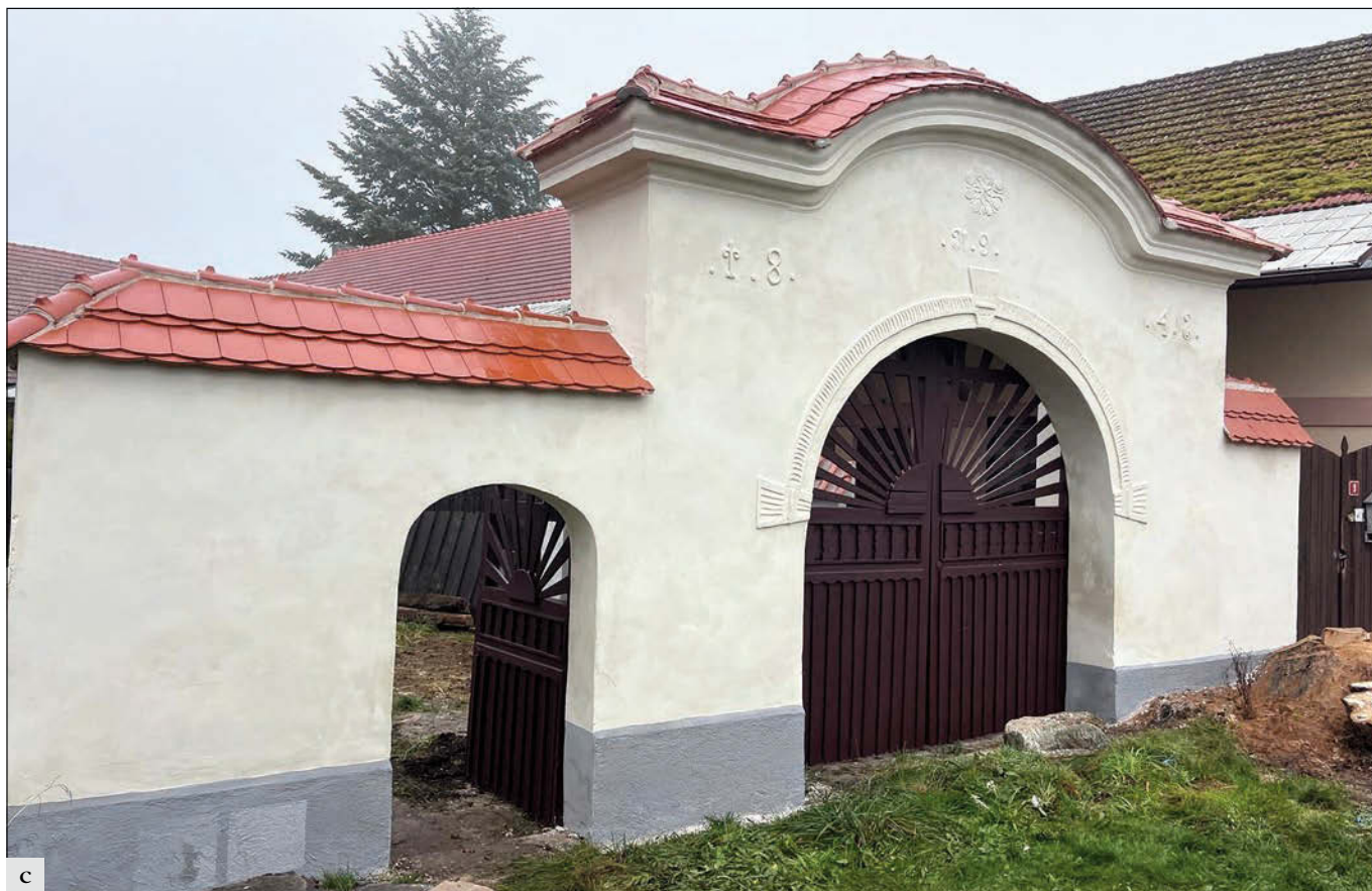
Březinka (správní obvod obce Mladá Boleslav), VPZ, usedlost čp. 9: a – stav brány před zahájením obnovy; b – statické narušení brány před obnovou; c – stav po dokončení prací (foto T. Horáková).
