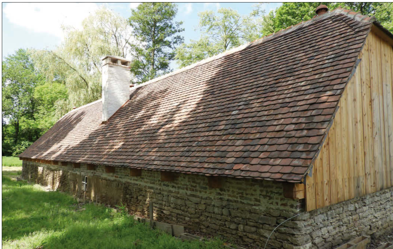
Bylany (správní obvod obce Kutná Hora), areál Feldekova mlýna čp. 78. Hospodářské stavení po obnově a částečné rekonstrukci střechy s nově položenou, druhotně použitou krytinou z tašek bobrovek (foto J. Berková).
