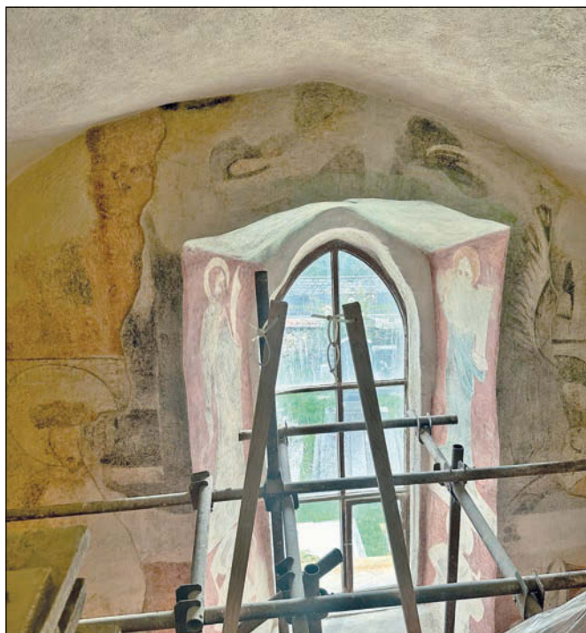
Vysoká (správní obvod obce Kutná Hora), kostel Navštívení Panny Marie, stav po restaurování. Po čtyřech letech byl dokončen odkryt a restaurování nástěnných maleb v presbytáři (foto L. Maděrová).
