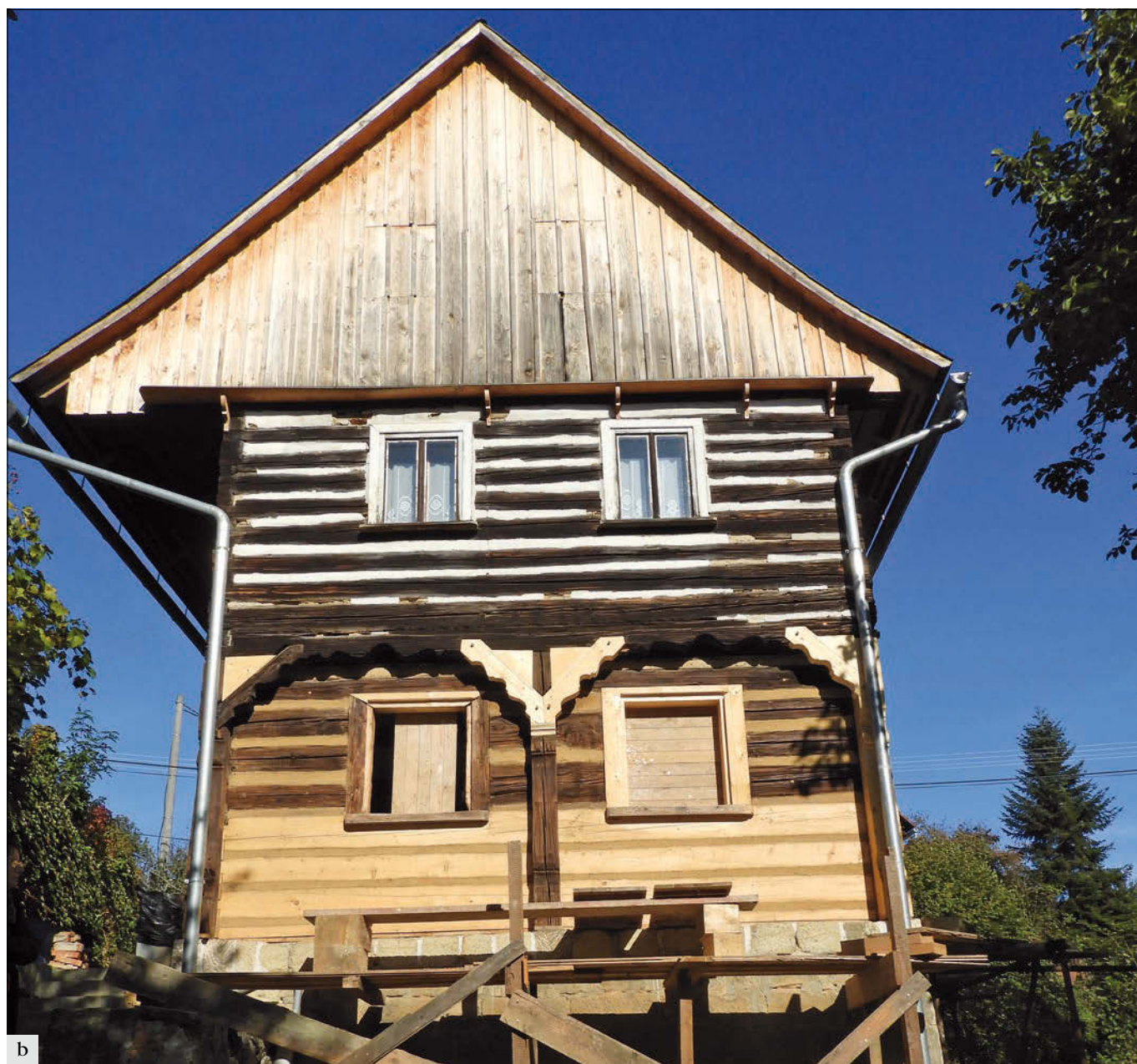
Dobřehň (správní obvod obce Mělník), VPR, roubený dům čp. 25: a – obnova roubených konstrukcí světnice vyžadovala výměnu spodních partií stěn do úrovně parapetů; b – stav v průběhu obnovy po výměně poškozených trámů světnice, doplnění opravené podstávky a před osazením okenních výplní (foto J. Berková).
