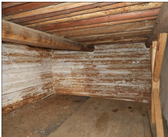
Pořešice (správní obvod obce Sedlčany), špýchar v usedlosti čp. 2. Po obnově krovu a zajištění trámových stropů nad zděnou částí patra, realizovaném v předchozích letech, byla v roce 2024 dokončena rovněž obnova roubených konstrukcí druhé komory v patře. V rámci prací byla opravena a stabilizována roubená stěna v napojení na zděnou část a vložena podpůrná konstrukce, která snižuje zatížení obvodové stěny od vazného trámu. Stav před dokončením obnovy podlahy (foto J. Berková).
