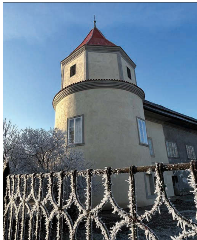
Lochovice (správní obvod obce Hořovice), zámek, pohled ze severovýchodu krátce po ukončení akce v roce 2024 (foto R. Schumová).
