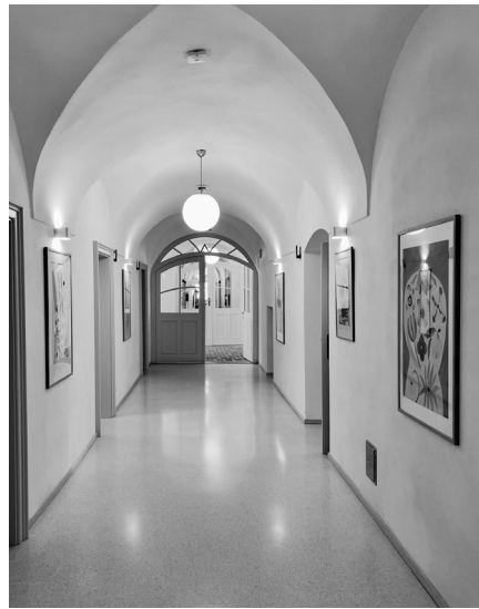
CHODBA PO OBNOVĚ
