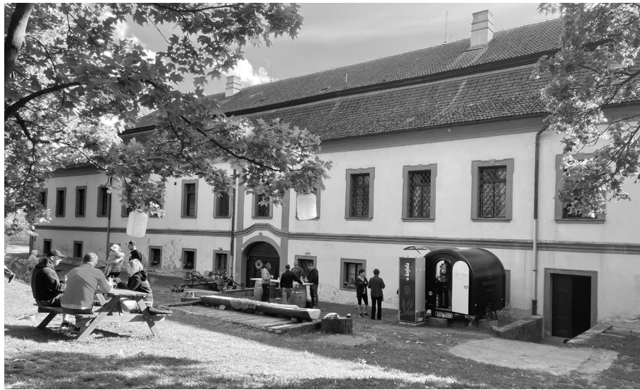
OBNOVENÉ PRŮČELÍ ORIENTOVANÉ DO ZÁMECKÉHO PARKU
