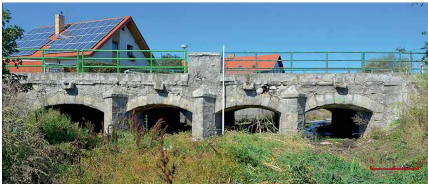
Dobříš (okres Příbram), most přes Pilský potok, Pražská ul. Početné typové stavby mostů na císařských silnicích z 1. pol. 19. stol. začínají jako neprohlášené technické památky v posledních letech mizet z naší krajiny, ve které hrají roli hmotných dokumentů historického urbanismu, rozvoje techniky i osídlení. Průzkum, dokumentace a návrhy na prohlášení za kulturní památky jsou maximálními nástroji ochrany těchto objektů ze strany státní památkové péče. Podpora jiných institucí je však zcela ojedinělá a především jsme v těchto případech konfrontováni s realitou omezeného vztahu široké veřejnosti ke kulturní dědictví (reklifkovaná fotografie V. Jesenský).
