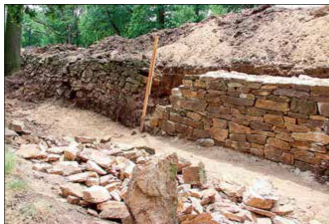
Kačina (správní obvod obce Kutná Hora), areál zámeckého parku. Oprava příkopu typu HA-HA byla provedena ve dvou krocích: Jako první bylo provedeno vyčištění příkopů od splavené zeminy, z prostoru příkopu a zdiva byly odstraněny dřeviny a pařezy s vegetací, jen několik hodnotných stromů bylo respektováno a zeď dle aktuální situace domodelována. Ve druhém kroku byly opěrné zdi kompletně přezděny z původního materiálu s příměsí chybějícího identického kamene a respektováním původního charakteru zdění (foto A. Pospíšil).
