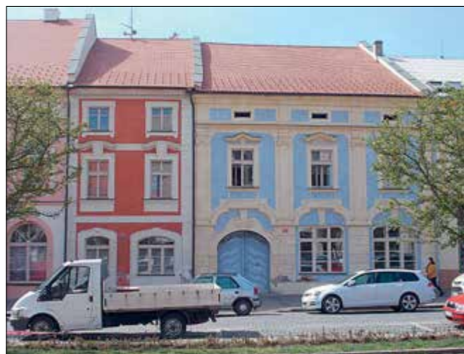
Rakovník (správní obvod obce Rakovník), radniční domy čp. 29 a 30. Po dokončení opravy krovu s výměnou střešní krytiny z hliníkových šablon Alukryt na pálenou z bobrovek (foto E. Volfová).
