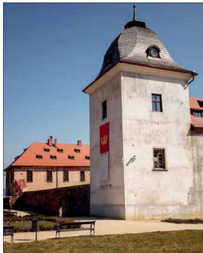
Králův Dvůr (správní obvod obce Beroun), zámek, výměna krytiny věže (foto M. Součková).
