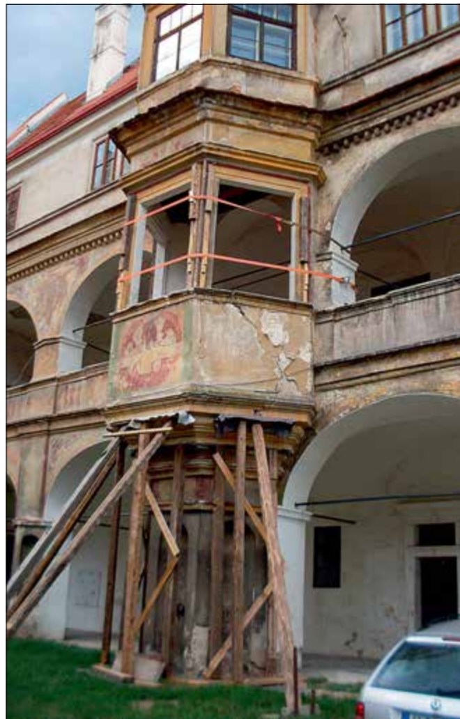
Bělá pod Bezdězem (správní obvod obce Mladá Boleslav), zámek. V návaznosti na zajištění kleneb arkád severního křídla pokračovaly práce statické zajištění arkýře, jehož konstrukce byla narušena výraznými trhlinami prostupujícími římsou včetně parapetů. V průběhu prací byla ve zdivu parapetů odhalena původní ztužující konstrukce z trámů, která musela být vzhledem k poškození vyjmuta. Práce byly prováděny v součinnosti s restaurátorem, aby nedošlo k poškození dochovaných renesančních maleb (foto J. Müller).
