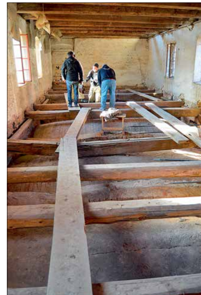
Kněževsi (správní obvod obce Rakovník), areál zájezdniho hostince čp. 51, patro stavby. Zajištění statiky hospodářského objektu ve dvoře, oprava kleneb, příčné zajištění ocelovými tyčovými táhly (foto E. Volfová).
