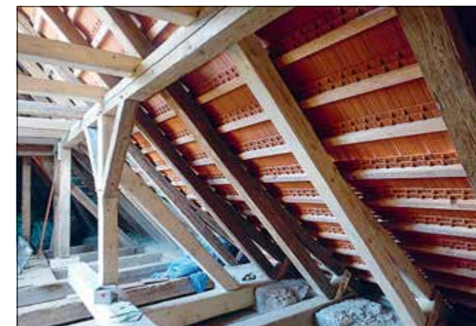
Lukov (správní obvod ORP Slaný), kostel sv. Jiří, krov nad lodí po obnově (foto M. Lindauerová).
