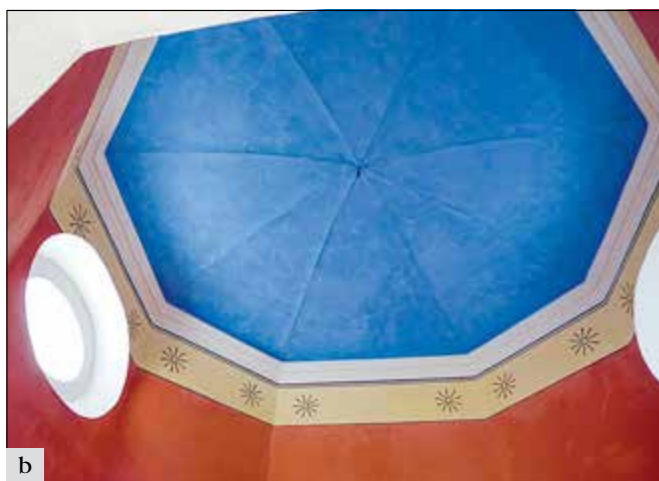
Buštěhrad (správní obvod ORP Kladno), kaple sv. Máří Magdalény: a – stav stropu před opravou; b – stav stropu po celkové obnově (foto M. Lindauerová).
