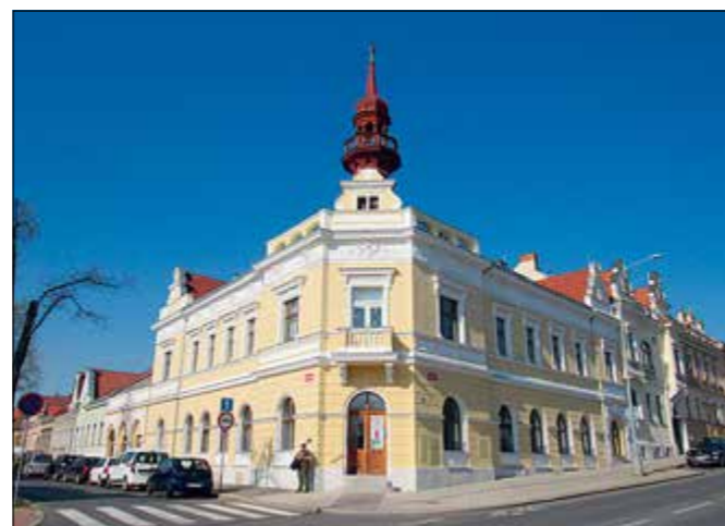
Mělník (správní obvod obce Mělník), městský dům čp. 343 v Pražské ulici; pohled na rekonstruované uliční fasády a střechu bývalé dětské nemocnice. Prováděcí firma práce provedla v průměrné kvalitě, což se projevilo zejména na nekvalitně provedených opravách štukatérských prvků, rozbarvení a po několika měsících také na degradaci a sprášování nátěrů fasád, které zřejmě byly provedeny ve špatných klimatických podmínkách (foto V. Hlaváčková).
