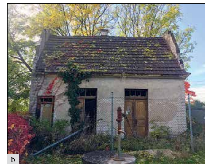
Libice nad Cidlinou (správní obvod obce Poděbrady), a – fasádní oprava evangelického kostela, barevnost byla vybrána na základě průzkumu jednotlivých vrstev předchozích úprav; b – márnice evangelického hřbitova bude brzy odstraněna (foto D. Hofreiterová).
