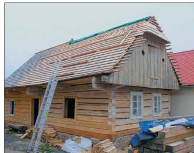
Starý Rožmitál (správní obvod obce Příbram), roubený dům čp. 59. Fotografie zachycuje dvorní a hlavní štítové průčelí stavby s probíhající obnovou střešního pláště ze štípaných dřevěných šindelů. Zajímavý je detail rozpracované pokládky kabřince (foto M. Hanzlíková).
