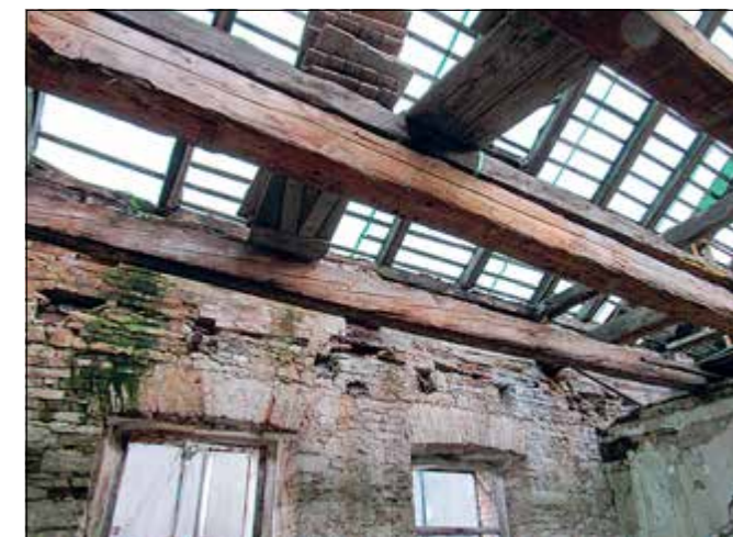
Brandýs nad Labem (správní obvod obce Brandýs nad Labem-Stará Boleslav), městský dům čp. 98. Stále se zhoršující stav domu díky neúdržbě, komplikované majetkové vztahy a táhnoucí se projekční práce přispěly k dalšímu úbytku hodnotných konstrukcí domu (foto V. Hlaváčková).
