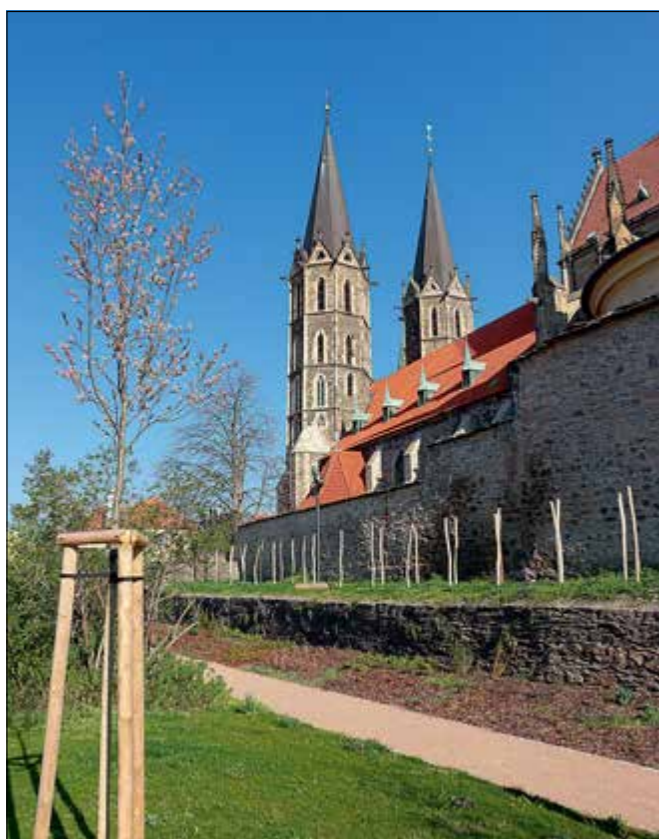
Kolín (správní obvod obce Kolín), obnova parkánu u kostela sv. Bartoloměje v centrální části městské památkové rezervace se již blíží ke konci. Parkán bude po dokončení prací zpřístupněn návštěvníkům (foto A. Rudl).
