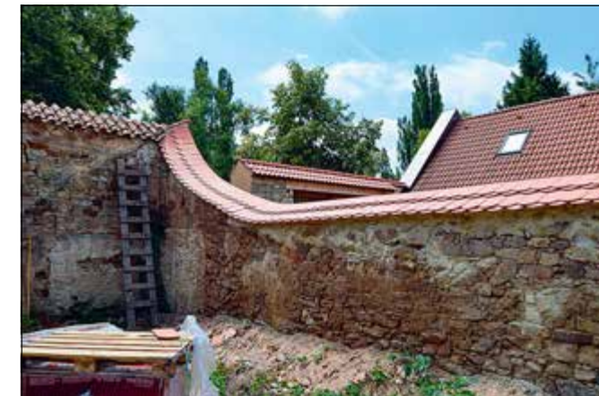
Kněževsi (správní obvod obce Rakovník), areál fary. Oprava jihozápadního úseku ohradní zdi (foto E. Volfová).
