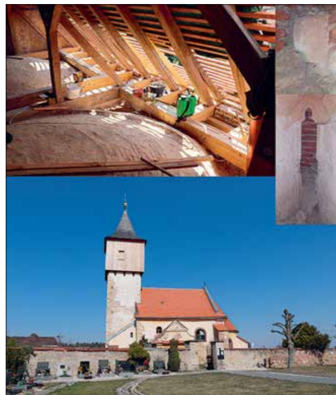
Kozojedy (správní obvod obce Říčany), osamocený kostel sv. Martina se zaniklou raně středověkou vsí. Oprava krovu nad lodí a sakristií a výměna střešní krytiny této části kostela navázaly na práce z minulých let, kdy probíhala obnova bednění a zastřešení věže. Po dobu oprav byly nad sakristií na severní straně lodí poměrně dobře přístupné prvky ze středověké fáze kostela – konzola a okno (foto J. Černochová).
