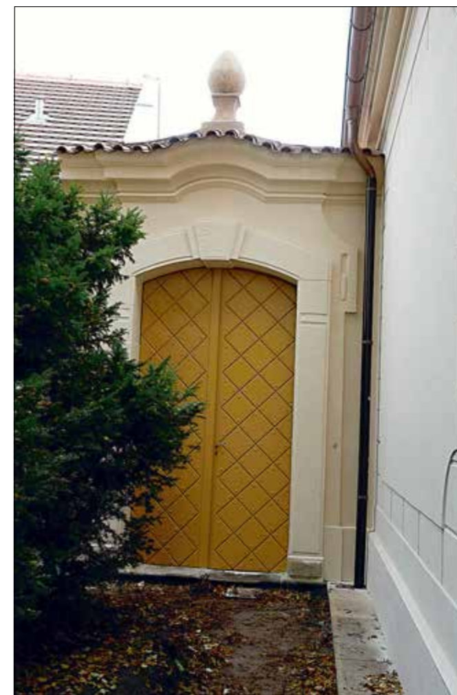
Stará Boleslav (správní obvod obce Brandýs nad Labem-Stará Boleslav), areál kostela Nanebevzetí Panny Marie, pohled na obnověný portál barokní brány na bývalý hřbitov, doplněný novou piniovou šiškou. Vpravo v popředí část opravené vnější fasády severního křídla ambitu (foto J. Žižka).
