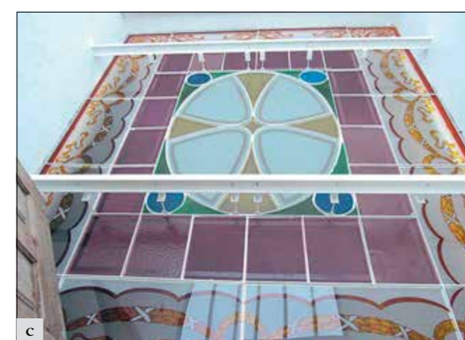
Mělník (správní obvod obce Mělník), městský dům čp. 3 na nám. Míru. V roce 2019 proběhla oprava zasklení a stěn světlíku a restaurování vitráží: a – vitrážová výplň světlíku nad schodištěm z interiéru (foto V. Hlaváčková); b – nosná konstrukce pro vyrovnání, posílení a nátěru (foto V. Hlaváčková); c – nosná konstrukce s osazenými vitrážovými skličky po restaurování a doplnění nových sklíček místo nepůvodních (foto T. Cachová).
