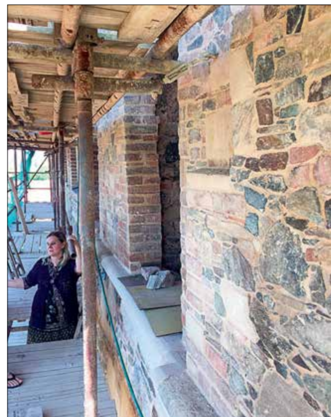
Chvatěruby (správní obvod obce Kralupy nad Vltavou), pohled na detail opravy hradu. Nově jsou osazovány chybějící parapety novým pískovcem a následně budou opatřeny olověným plechem (foto D. Hofreiterová).
