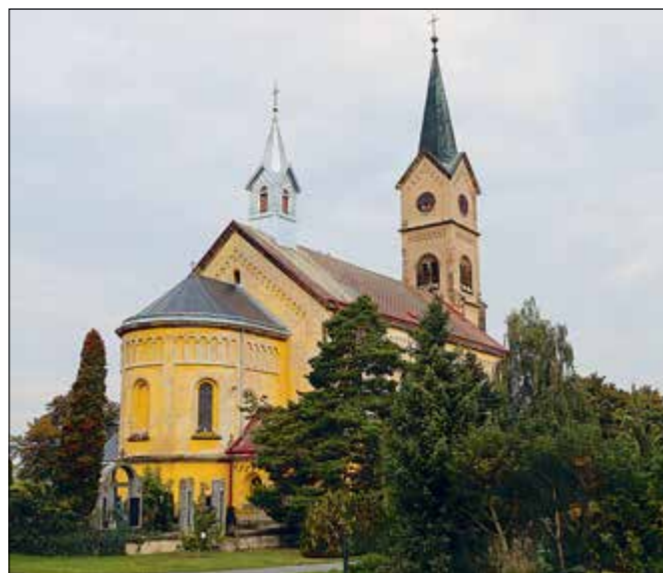
Velelíby (správní obvod obce Nymburk), kostel sv. Václava postavený na místě původní gotické stavby v letech 1876–1878. Proběhla obnova sanktusníkové věže kostela, která byla sejmuta a práce probíhaly na zemi. (foto M. Gottwaldová.)
