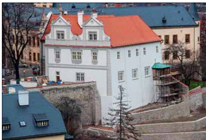
Kutná Hora (správní obvod obce Kutná Hora), Jakubská ulice, čp. 1. Objekt Arciděkanství vstoupil do kutnohorského panoramatu běloskvoucími fasádami v jižním a západním pohledu. Během obnovy fasády proběhlo statické zajištění havarijního nadpraží renesančních oken a tvarově byla zrekonstruována barokní štuková výzdoba západní fasády. Konstrukce arkýře byla kompletně rozebrána, nejvíce poškozené prvky protézovány a jako střešní krytina se použila stará měd s charakteristickou ušlechtilou patinou, získaná z pultových střech chrámu sv. Barbory, kde byla nahrazena novou. V následující etapě přibude na soklu treláž s popínavou zelení (foto A. Pospíšil).
