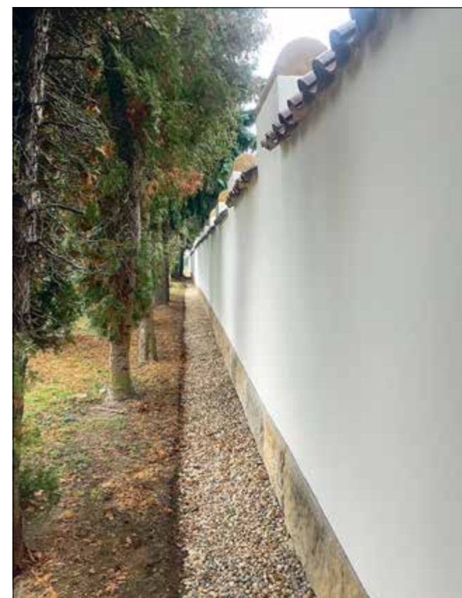
Poděbrady (správní obvod obce Poděbrady), městský hřbitov Kluk. Vnější strana severovýchodní části ohradní zdi po odstranění nesoudržných novodobých omítkových vrstev byla staveništní vápennou maltou nahozena, řádně roztočena a uhlazena, a teprve po důkladném zatvrdnutí na podzim uzavřena dvojím modifikovaným vápenným nátěrem (foto D. Hofreiterová).
