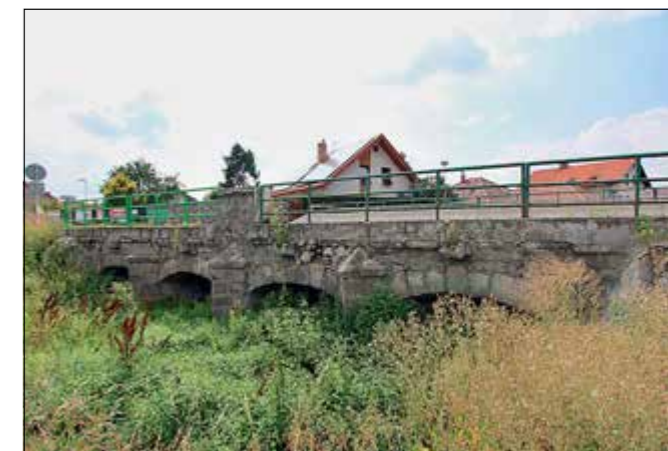
Dobříš (správní obvod obce Dobříš), silniční most přes Pilský potok v Pražské ulici. Příklad klasicistního mostu, který i přes novodobé utilitární úpravy projevuje pozoruhodné architektonické kvality a disponuje také zajímavou historií. Po citlivé rehabilitaci a vhodné úpravě okolí by se jednalo o velmi reprezentativní stavbu v místě, které místní obyvatelé využívají k četným procházkám. Červenec 2019 (foto A. Rákosníková).
