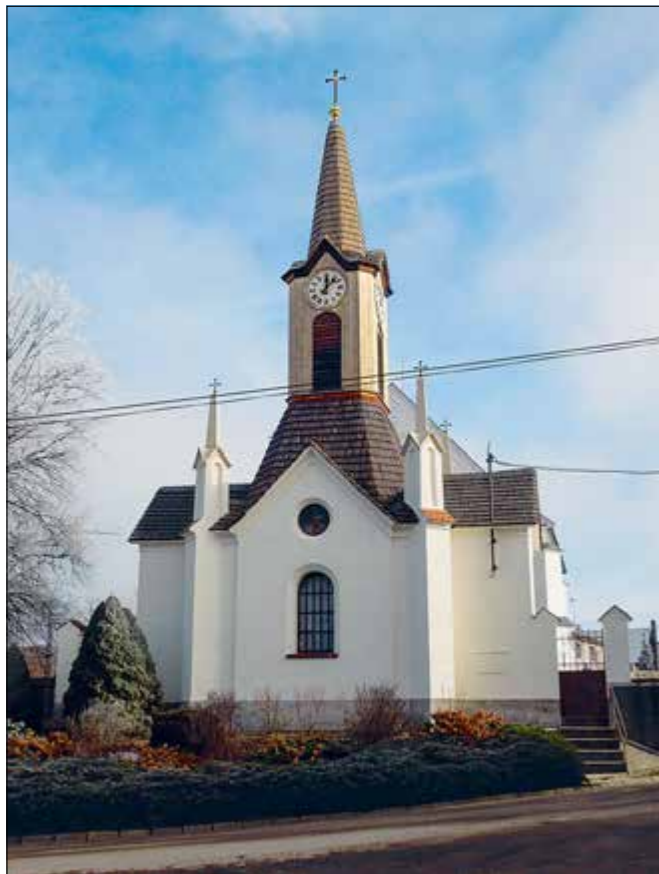
Psáře (správní obvod obce Vlašim), areál kostela Nejsvětější Trojice, zvonice s márnicí, celková obnova. Po opravě krovu a zvonové stolice, bednění věže a pokládky nového štípaného šindele byla v tomto roce dokončena oprava celého objektu obnovou kamenných bočních fiál a vnějších i vnitřních omítek (foto D. Primusová).
