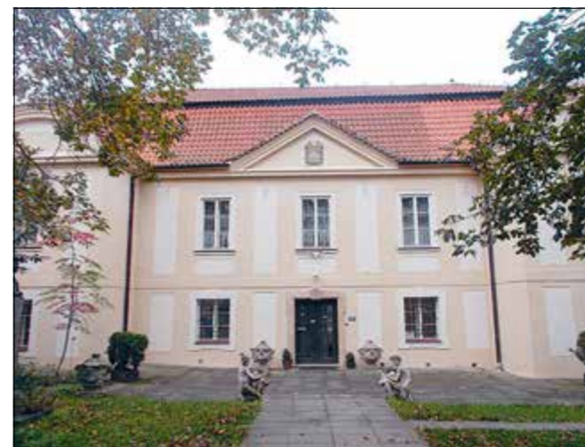
Rakovník (správní obvod obce Rakovník), muzeum čp. 1. Průčelní fasáda po dokončené opravě omítek s vápenným nátěrem ve 2 odstínech světlého okru (foto E. Volfová).
