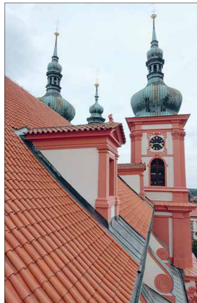
Stará Boleslav (správní obvod obce Brandýs nad Labem-Stará Boleslav), kostel Nanebevzetí Panny Marie, pohled z lešení na západním štítu přes střechu jižní boční lodi k věži. Obnova fasád měla charakter profesionálně provedené velké údržby s lokálními opravami omítek a obnovou nátěru podle předcházející opravy. K rozhodnutí o pokrytí římsy na věži plechem vedla především snaha obnovit tvarovou čistotu z pohledu vnímaných bohatě odstupněných nároží, do nedávna poškozenou nevhodně položenou prejzovou krytinou (foto J. Žižka).
