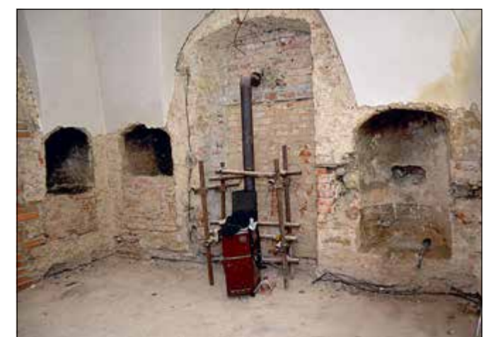
Kutná Hora, bývalá škola – přízemí, Jiřího z Poděbrad čp. 289. Nenápadně zazděné výklenky, které považujeme za barokní vytápěcí komory, bylo třeba dokumentovat detailně, abychom mohli zpřesnit hypotézy o provozně funkčním řešení těchto zařízení. Budeme to moci využít v případech podobných nálezů nejen v Kutné Hoře, které tím pádem budeme ochraňovat a s větší porozuměním a pečlivostí (foto V. Jesenský).
