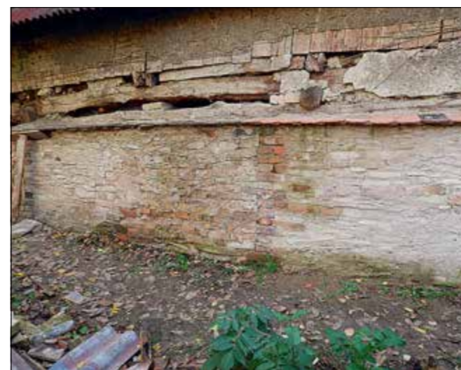
Vinice (správní obvod obce Poděbrady), roubený dům v usedlosti čp. 9 je dlouhodobě ve velmi špatném stavu. V rámci první etapy oprav byly sanovány zděné konstrukce související s blokem někdejšího topeniště včetně navazující stěny síně. V levé části obrázku je z větší části přezděná zeď síně. V rámci prací se podařilo zhotoviteli velmi věrně zachovat původní charakter zdiva (foto J. Berková).
