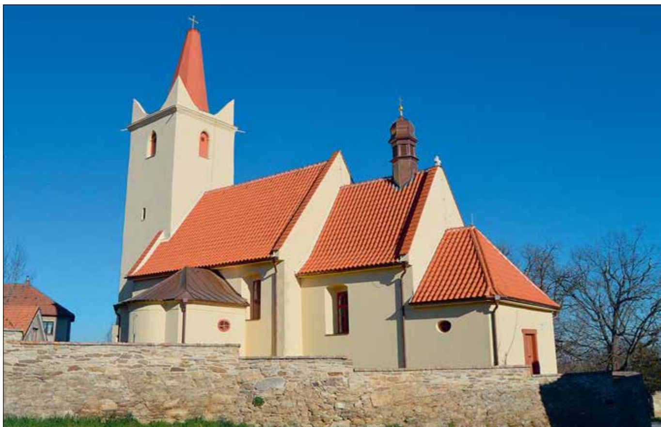
Červené Pečky (správní obvod ORP Kolín), areál kostela Nanebevzetí Panny Marie, stav po celkové rekonstrukci (foto D. Havlíková).
