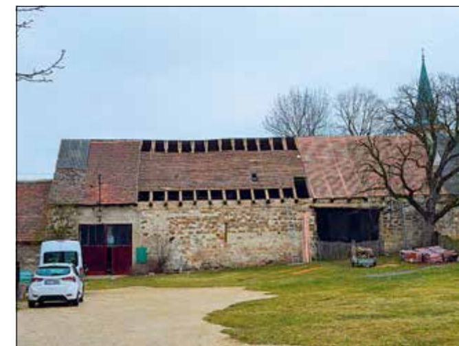
Srbeč (správní obvod obce Rakovník), areál zámku. Začala oprava střech stodol na východní straně, s příložkováním krokví a částečným přeložením a položením nové krytiny (foto E. Volfová).
