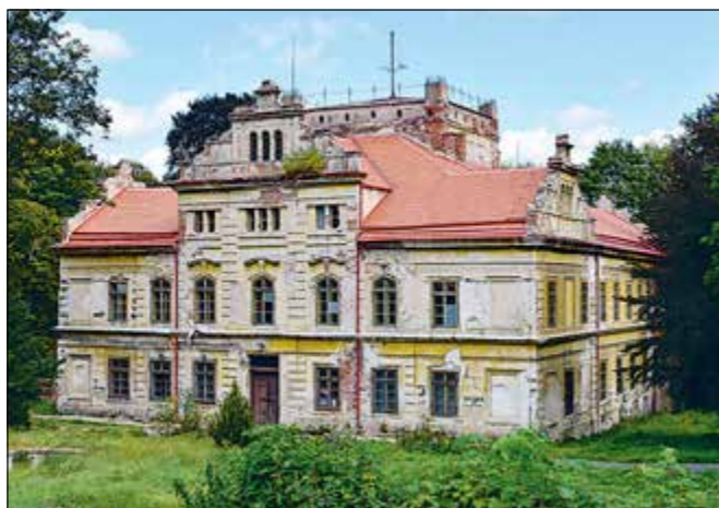
Soutice (správní obvod obce Vlašim), zámek, celková obnova střechy. Střecha zámku, který byl donedávna ohroženou památkou bez využití a základní údržby, byla během tří posledních let celá opravena. Tesařsky byl opraven krov a položena nová krytina z pálených bobrovek, protože stávající tašky již dožívaly a do střechy začínalo zatékat (foto D. Primusová).
