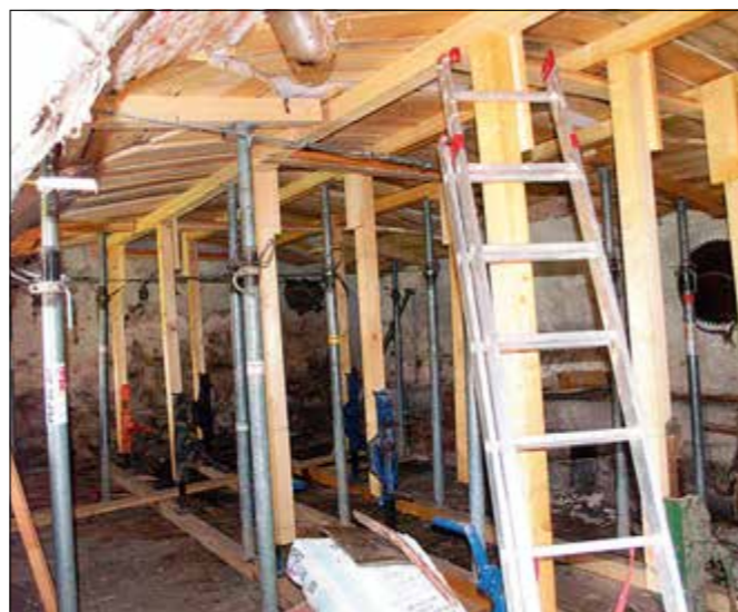
Lážovice (správní obvod obce Hořovice), KPZ Osovsko, hospodářské stavení v usedlosti čp. 10. Při sanaci statických poruch zděných chlévů byla vyzvednuta pokleslá klenba v celé délce pomocí výdřevy a hydraulických zvedáků. Díky zdařilé akci nebylo nutné přistoupit k lokálnímu přezdění klenby (foto M. Hanzlíková).
