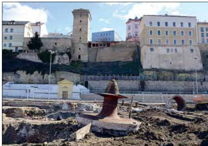
Mladá Boleslav, náhon a turbína bývalé elektrárny na místě bývalého Podstupenského mlýna, Ptácká čparc. 2804 a 1376/12. Nalezená Kaplanova turbína na místě bývalého Podstupenského mlýna pod renesanční vodárenskou věží v Mladé Boleslavi je symbolickým mementem propojení techniky a výroby s celou historií města. Cílem památkářů je, aby se tyto hmotné doklady nelikvidovaly, ale integrovaly a rozvíjely. V okolí místa nálezu se to však v posledních letech daří minimálně (foto V. Jesenský).
