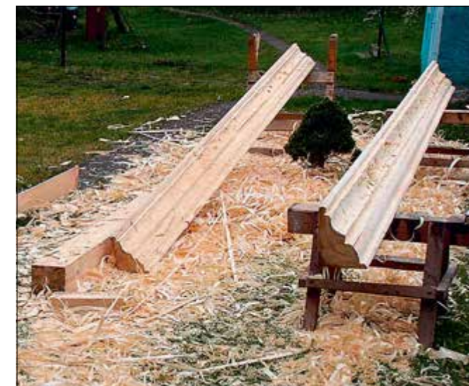
Žebrák (správní obvod obce Hořovice), dům Konráda z Vechty čp. 97, postupná obnova mansardového krovu. Mansardové římsy ručně opracoval tesař František Ungr (foto J. Procháčka).
