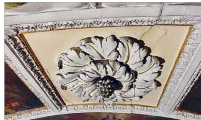
Stará Boleslav (správní obvod obce Brandýs nad Labem-Stará Boleslav), kostel Nanebevzetí Panny Marie, detail štukové výzdoby na klenbě presbytáře před zahájením prací (foto J. Žižka).
