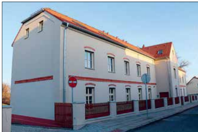
Dobříš (správní obvod obce Příbram), někdejší bytový dvojdům čp. 5 a 6, dokončení celkové obnovy, kdy kvůli prokazatelně havarijnímu stavu objektu byla v podstatě vystavěna jeho replika (foto M. Gottwaldová).
