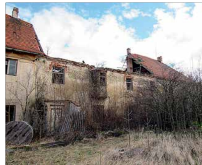
Chlumín (správní obvod obce Neratovice), hospodářská budova v areálu zámku. V areálu zámku dochází i přes všechny snahy zástupců památkové péče k chátrání hospodářských budov (foto V. Hlaváčková).
