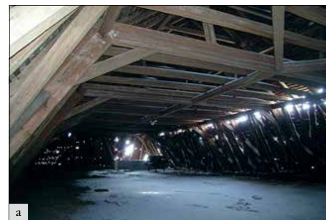
Hořín (správní obvod obce okres Mělník), a – barokní sýpka v hospodářském dvoře při zámku, pohled na půdu s vynikající konstrukcí krovu, objekt prezentovaný v této zprávě již v roce 2018 nadále chátrá, a pokud jeho majitel, přímý potomek původních stavebníků, konečně nezmění svůj postoj, nenahraditelná stavba v dohledné době zanikne; b – detail cenného a mimořádně kvalitně provedeného krovu z poloviny 18. století, takto, s poškozenou a na mnoha místech chybějící krytinou taškové střechy, nemá žádnou naději na další existenci. Přitom tato střecha byla ještě v době před patnácti lety v dobrém stavu, ale svým majitelem ponechaná naprosto bez údržby (foto J. Mrázek).
