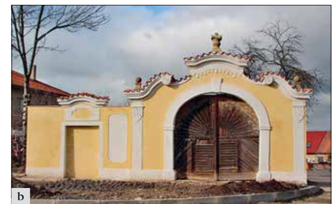
Dřevčice (správní obvod obce Brandýs nad Labem-Stará Boleslav): a – brána usedlosti čp. 28, stav před zahájením prací, březen 2017; b – stav po obnově fasády a sochařské výzdoby, před dokončením parteru a nátěru soklu. Únor 2020 (foto A. Rákosníková).
