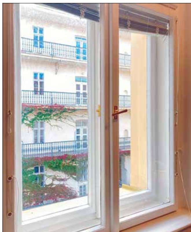
Pohled renovovaným oknem na přední budovu (foto V. Tutr).
