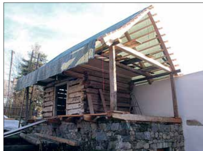
Starosedlský Hrádek (správní obvod obce Příbram), areál roubeného, tzv. Panského, mlýna čp. 4. První etapa obnovy přeneseného špýcharu do areálu usedlosti, který je posazen na obnovený kamenný sklep, jenž byl původně součástí zaniklých drobných chlévů. V pozadí obnovená ohradní zeď (foto M. Hanzlíková).
