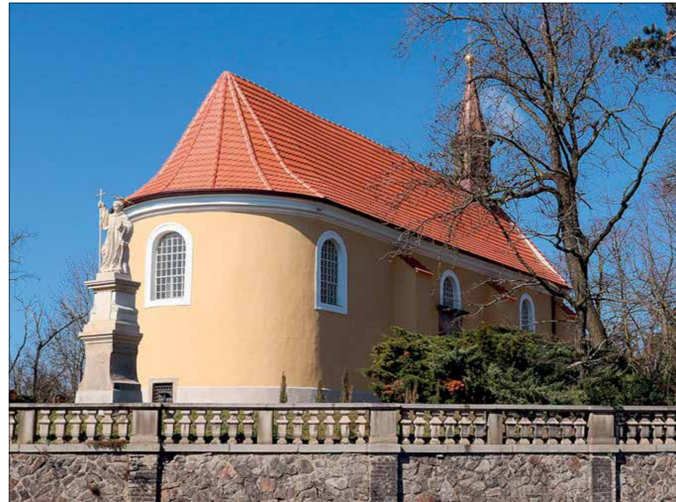
Dobříš (správní obvod obce Příbram), hřbitovní kostel Povýšení sv. Kříže, celková obnova kostela byla završena výměnou dožlých, nepůvodních okenních výplní za nová historizující okna, která byla navržena dle dochované historické fotodokumentace (foto M. Gottwaldová).
