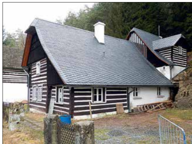
Kokořínský Důl (správní obvod obce Mělník), roubený dům čp. 58 v osadě Hlučov - stav po obnově střešky (foto J. Berková).
