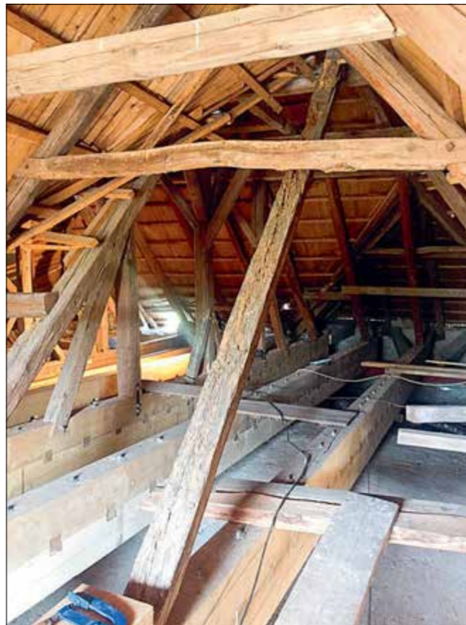
Dymokury (správní obvod obce Poděbrady), kostel Zvěstování Panny Marie. Vazný trám je v konečném výsledku sprážený ze dvou trámů, do styčných ploch jsou mezi svorníky vloženy dubové hmoždíky z hranolů (foto P. Šverma).
