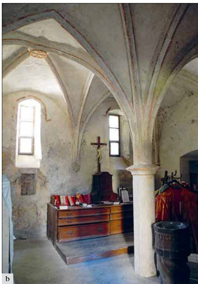
Bělá pod Bezdězem (správní obvod obce Mladá Boleslav), kostel Povýšení sv. Kříže. Gotická sakristie patří k vzácně dochovaným prostorům sklenutým na střední pilíři. Sakristie byla poškozena nejen v důsledku předchozího zatékání, ale i nevhodnými stavebními zásahy, zejména nešetrným provedením elektroinstalace i některými povrchovými úpravami: a – na základě restaurátorského průzkumu, který prokázal ve velkém rozsahu dochovanou pozdně gotickou omítku s fragmenty figurální malby, bylo rozhodnuto o odkryvu a restaurování této vrstvy; b – celkový pohled do prostoru sakristie po odstranění novodobého olejového nátěru pilíře a restaurování omítek s fragmenty maleb a červené polychromie žeber klenby (foto E. Vyletová).
