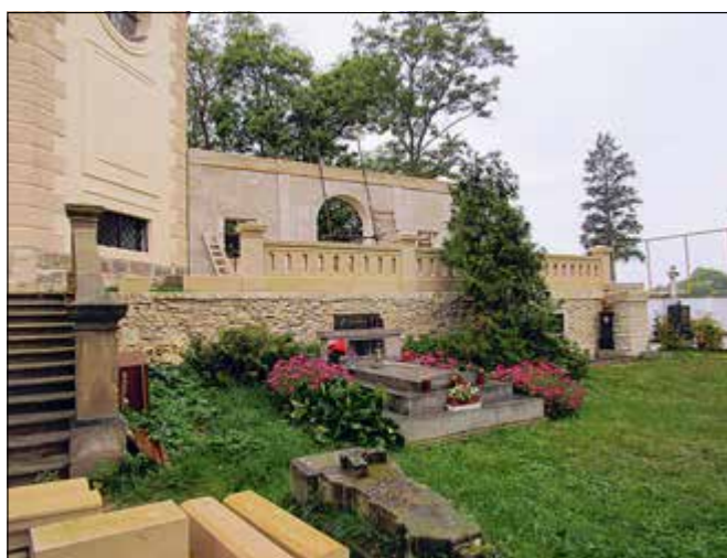
Hořín (správní obvod obce Mělník), pohřební kaple Lobkoviců. Pohled na jednu z nově dostavených bran a nové balustrády v průběhu stavebních prací (foto V. Hlaváčková).
