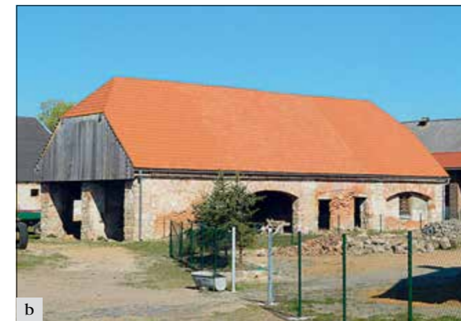
Mnichovo Hradiště, hospodářský dvůr Hněvousice (okres Mladá Boleslav): a – Bývalá kočárová kolna stojící uprostřed dvora, byla v důsledku zanedbané údržby v havarijním stavu (foto E. Vyletová); b – v letošním roce byla dokončena obnova krovu a krytiny, prováděná postupně po etapách v průběhu několika let (foto E. Zápalková).
