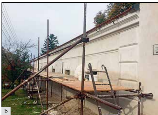
Činěves (správní obvod obce Poděbrady), chlév barokního areálu fary: a – stav před opravou; b – štukatéry byla zdařile prováděna obnova nárožní kvádrové bosáže, profilované římsy, subtilního architrávu a klenáků v nadpraží ležatě obdélníkových oken (foto D. Hofreiterová).
