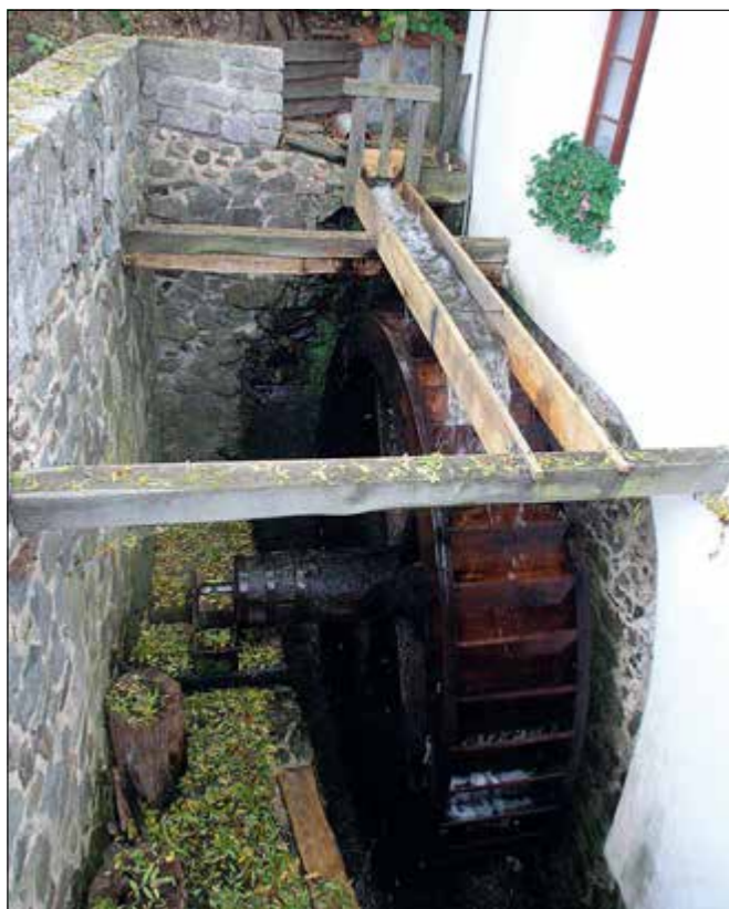
Mnichovice (správní obvod obce Říčany), areál roubeného vodního mlýna čp. 69. Po upravení dna lednice bylo osazeno nové mlýnské kolo na svrchní vodu. Z předchozího kola z roku 2003, jenž bylo přesnou kopií původního, byla využita dubová hřídel (foto M. Hanzlíková).
