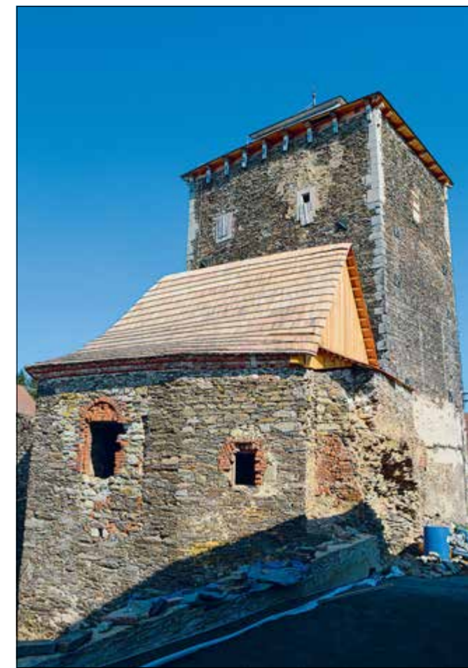
Hradenín (správní obvod ORP Kolín), areál pozdně středověké tvrze, stav po rekonstrukci střechy dle archivních fotografií (foto D. Havlíková 2020).
