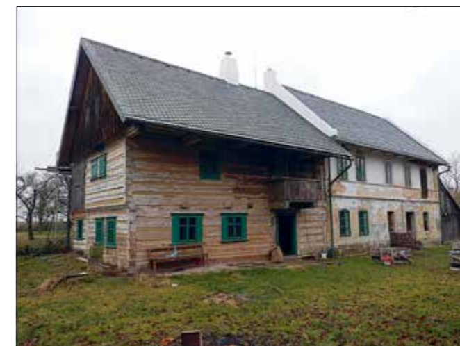
Viska (správní obvod obce Mladá Boleslav), VPR, dům čp. 6. Nová krytina z přírodní břidlice sjednotila střešní plášť domu, který až dosud kryly na roubeném jádru eternitové šablony a na zděné části drážkové pálené tašky (foto J. Berková).
