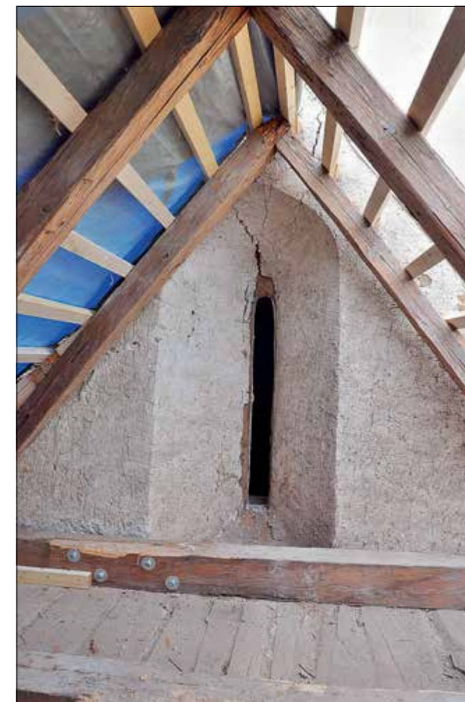
Zdebuzeves (okres Benešov), kostel sv. Anny, východní stěna presbytáře v pohledu z půdy sakristie. Při opravách střež kostelních přístavků se pravidelně stává, že je po omezenou dobu možné navštívit prostory, jinak bez rozebrání krytiny nepřístupné. Často se při takových příležitostech objeví opravdové skvosty zachované v neobvykle intaktním stavu. Na snímku je patrné dnes zaslepené raně gotické východní okno presbytáře s dochovaným dřevěným rámem vyrobeným z jednoho kmene (foto J. Veselý).
