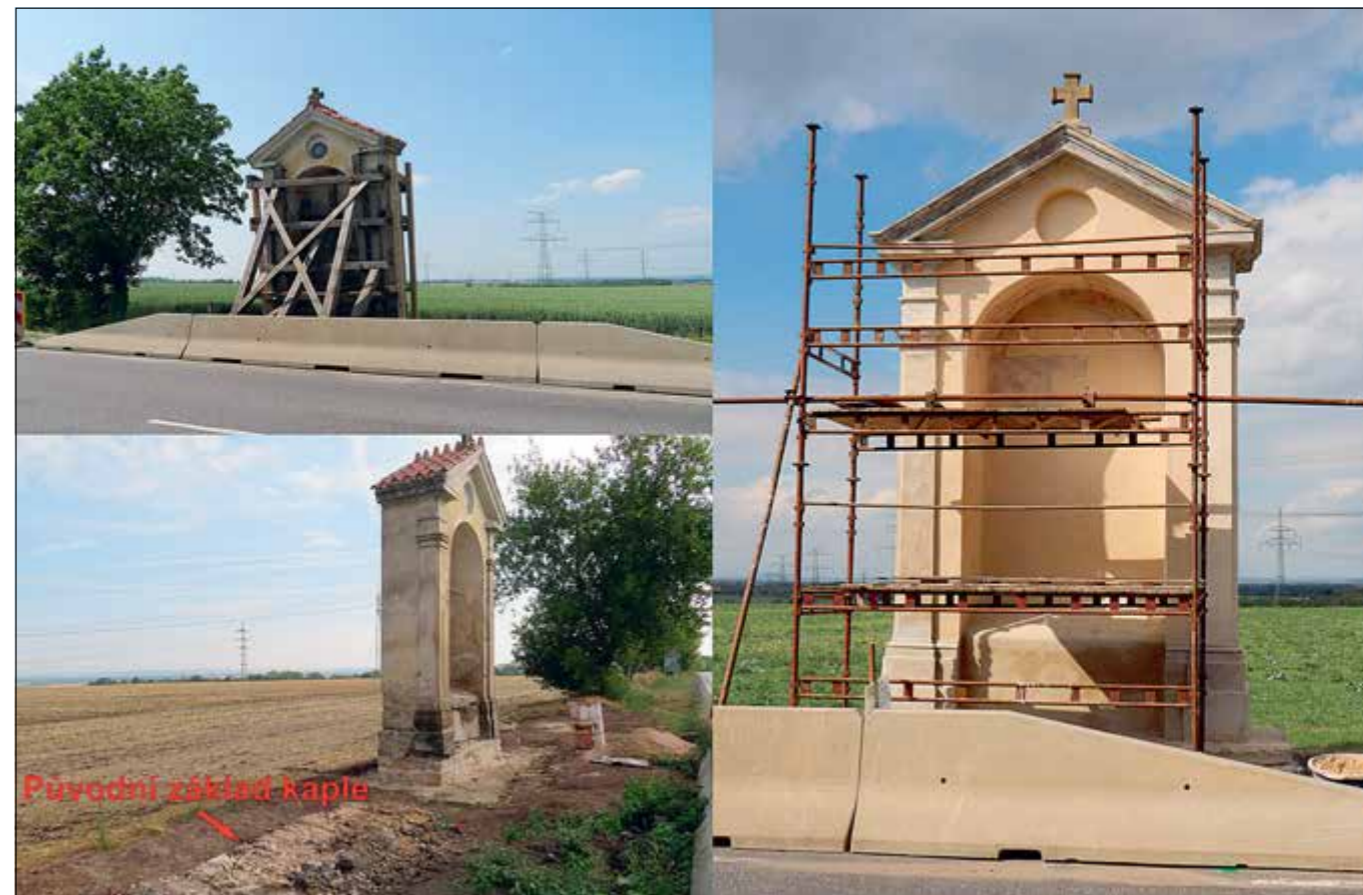
Dřevčice (správní obvod obce Brandýs nad Labem-Stará Boleslav), Strašenská kaple – kaple výrazně vykloněná do silnice byla po dobu deseti let provizorně zajištěná výdřevou (foto P. Kalinová). S ohledem na blízkost silnice a špatný základ kaple bylo rozhodnuto o přesunu kaple pomocí jeřábové techniky na nový základ (foto P. Kalinová). Při opravě kaple byly v ní nalezeny zbytky původní výmalby, které byly prezentovány. Při obnově fasád bohužel stále nedošlo ke korekci chybné opravy profilací a jednotnému nátěru fasád včetně architektonických článků (foto J. Černochovej).
