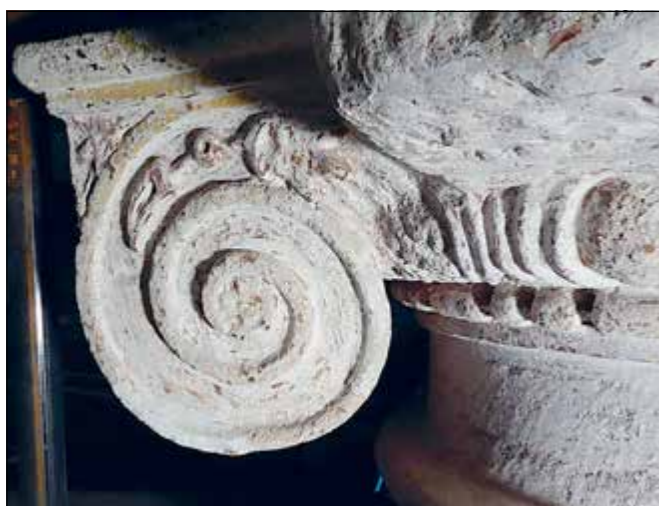
Stará Boleslav (správní obvod obce Brandýs nad Labem-Stará Boleslav), kostel Nanebevzetí Panny Marie, detail nejlépe provedené hlavice sloupů západní krucht. Kamenné hlavice sloupů s vyzděnými a omítanými dřívky byly nepochybně osazeny v podobě polotovaru a dosekávány na místě. Kamenická práce je místy značně hrubá, na některých méně viditelných místech nebyly detaily vůbec vysekány (foto J. Žižka).
