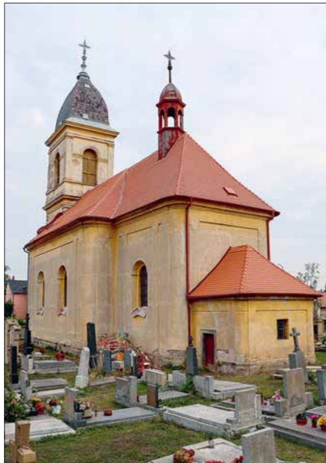
Chleby (správní obvod obce Nymburk), kostel sv. Vavřince – byla dokončena obnova střešního pláště a došlo též k opravě a zajištění konstrukce krovu (foto M. Gottwaldová).
