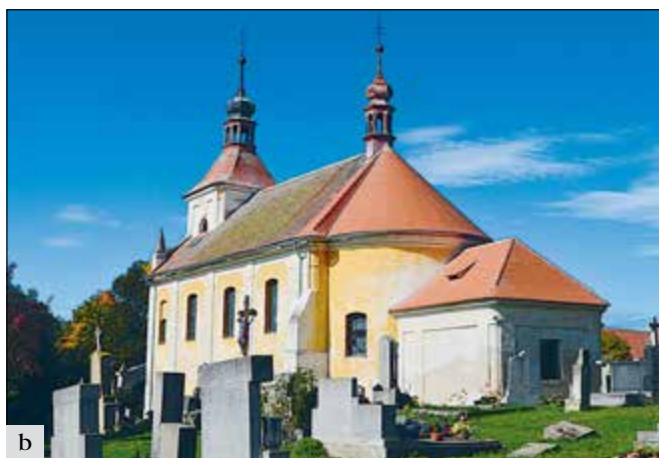
Panoší Újezd (správní obvod obce Rakovník), kostel Nanebevzetí P. Marie: a – tesařská vazba sakristie po snesení krytiny, vyklízení letitého nánosů holubích exkrementů ztížilo práci při výměně střešní krytiny (foto E. Volfová); b – kostel s dokončenou opravou střechy sakristie z nových bobrovek pokládáných na korunkovou vazbu, (foto E. Volfová).
