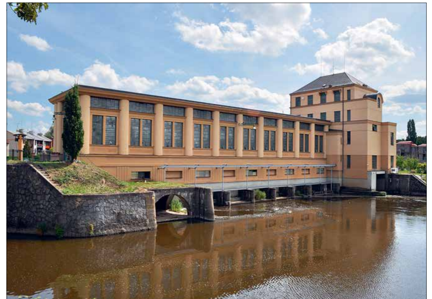
Nymburk, vodní elektrárna čp. 1508. Technická památka z let 1914–1924 ve stylu střídmého modernismu, jejímiž autory jsou František Roith (architektonické řešení), Emil Zimmerler a Josef Bartovský (technická a vodohospodářská část) (foto I. Minář).
