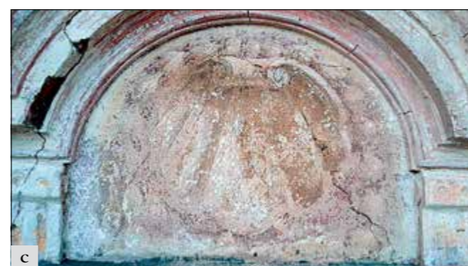
Křinec (správní obvod obce Nymburk), zámek čp. 1 – pokračování obnovy jižního průčelí hlavního křídla zámku. V průběhu prací byly ve frontonech nad okny učiněny významné nálezy iluzivní malované výzdoby (lastury, maskaron, mouřenín) související se zcela původním pojetím fasády zámku, a to buď pozdně renesančním, či spíše raně barokním: a – převážná část jižního průčelí po letošní části obnovy; b – iluzivní výzdoba zachycující mouřenina, kterého měl ve znaku rod Morzínů, jenž nechal zámek v polovině 17. století postavit; c – iluzivní výzdoba ve formě lastury (mušle) oblíbeného barokního prvku (foto M. Gottwaldová).
