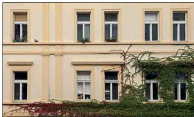
Sídlo NPÚ ÚOP SČ v Sabinovské ulici čp. 5, Praha 3. Pohled na zadní trak po renovaci oken (foto V. Tutr).
