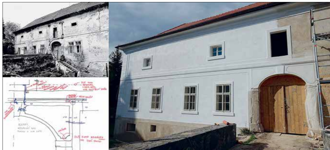
Pakoměřice (správní obvod obce Brandýs nad Labem-Stará Boleslav), zámek – fotografie z roku 1989 poukazuje na dlouhotrvající havarijný stav zámku (foto archiv NPÚ). Obnově fasády předcházely průzkumy dílčích úseků (V. Jesenský). V roce 2019 bylo obnoveno hlavní průčelí – zachycen stav po osazení levé části průčelí, fasáda prozatím bez finálního nátěru. I přes intenzivní kontroly stavebních úprav zámku se bohužel nepodařilo zcela ovlivnit některé detaily probíhající opravy. I tak lze ale vnímat opravu zámku jako jeho záchranu (foto J. Černochová).
