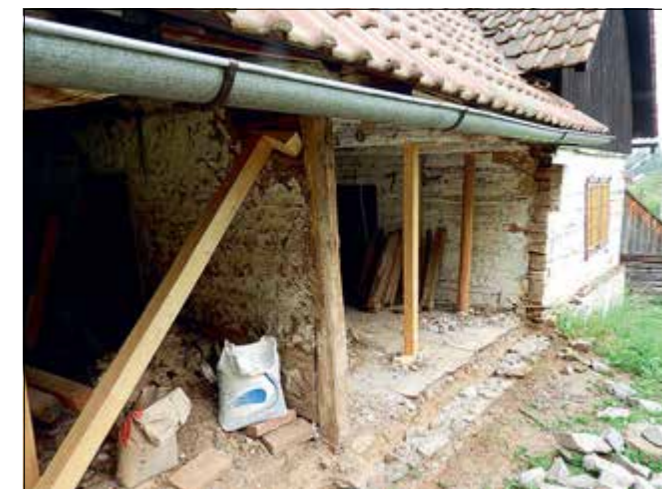
Losiny (správní obvod obce Kutná Hora), VPZ, dům usedlosti čp. 2. Výměnkářský přístavek byl v atypické pozici napojen na stěnu hlavní světnice pomocí sloupku s drážkou, do které byly vsazeny stěnové trámy přístavku. V důsledku stárí a degradace zdiva došlo k vybočení sloupku a stěna se vyklonila ze své osy. V rámci obnovy musela být rozebrána včetně podezdívky a následně založena na nový základ. Prahové trámy byly tesány na místě z jedlového dřeva (foto J. Berková).
