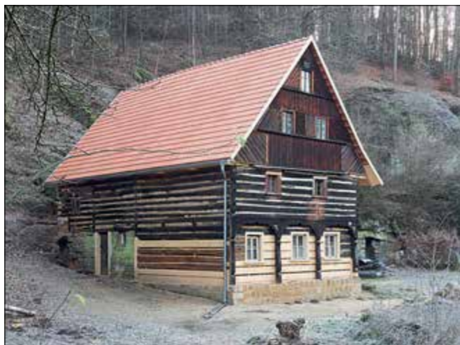
Vidím (správní obvod obce Mělník), VPZ, roubený dům čp. 80 je součástí ojediněle dochovaného uceleného souboru vesnické zástavy někdejší Dolní Vidimi z období kolem přelomu 18. a 19. století. Stav po opravě roubených konstrukcí a výměně krytiny (foto J. Berková).
