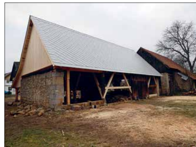
Kluky (správní obvod obce Mladá Boleslav), VPZ, původně hrázděná stodola byla v závěru 19. století doplněna o zděnou kolnu a zděné nárožní pilíře. V rámci její záchrany bylo nutno staticky stabilizovat jak zděné konstrukce, tak opravit s maximálním respektem k původní materiálu hrázděné konstrukce. Střešní plášť byl opět pokryt eternitovými šablonami (foto J. Berková).
