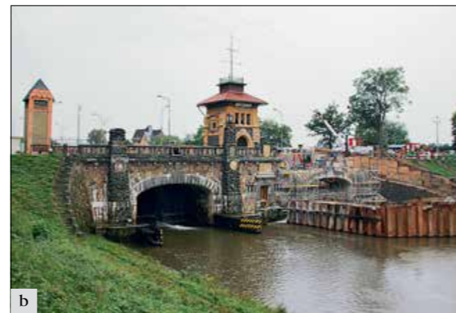
Hořín (správní obvod obce Mělník), zdymadlo vraňansko-hořínského plavebního kanálu: a – stav před započatím modernizace, prosinec 2017 (foto A. Rákosníková); b – stav v průběhu rozebírání přemostění dolního ohlavi velké plavební komory, srpen 2019 (foto A. Rákosníková).
