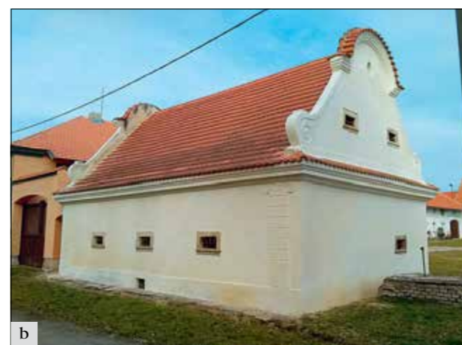
Chotouň (správní obvod obce Český Brod), sýpka usedlosti čp. 8: a – stav před obnovou fasády, srpen 2018; b – stav po obnově omítek, listopad 2019 (foto A. Rákosníková).
