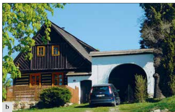
Mušský (správní obvod obce Mnichovo Hradiště), brána usedlosti čp. 11: a – stav před obnovou, prosinec 2016 (foto A. Rákosníková); b – stav po opravě, duben 2020 (foto E. Zápalková).
