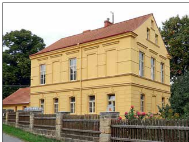
Nosálov (správní obvod obce Mělník), VPR, budova bývalé školy stojí v návěsním prostoru. Obnova fasády podle původního stavu velmi prospěla vzhledu celé návsi. Po předloňské výměně oken má budova kompletně opravený vnější plášť, který je dokladem velmi vstřícného postoje současného vedení obce k památkovým hodnotám (foto J. Berková).
