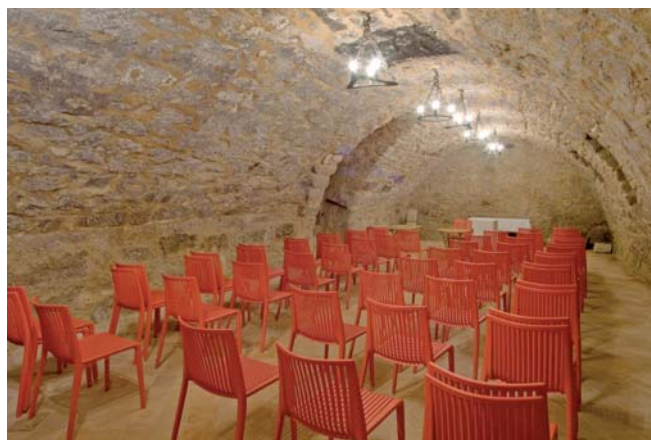
Historické sklepení domu U Zlatého slunce
