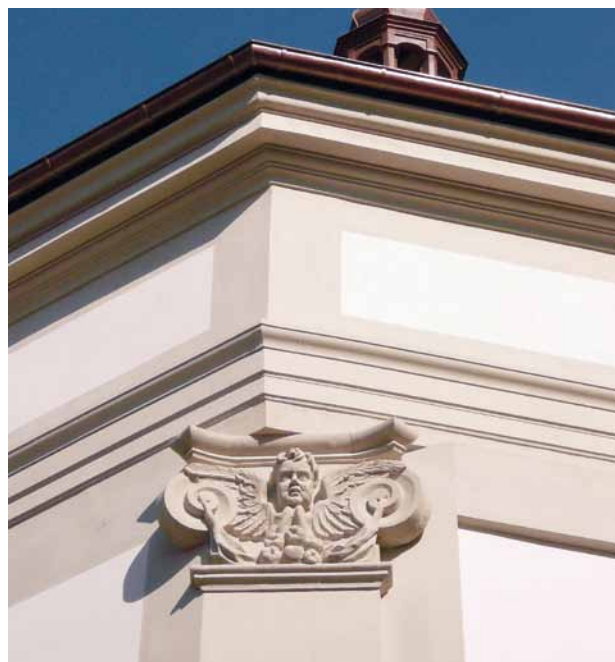
Obr. 11. Ostrov, kaple sv. Anny. Jihovýchodní nároží. Detail hlavičky pilastru, kladí a hlavní římsy. (Foto P. Danda, 2007)
