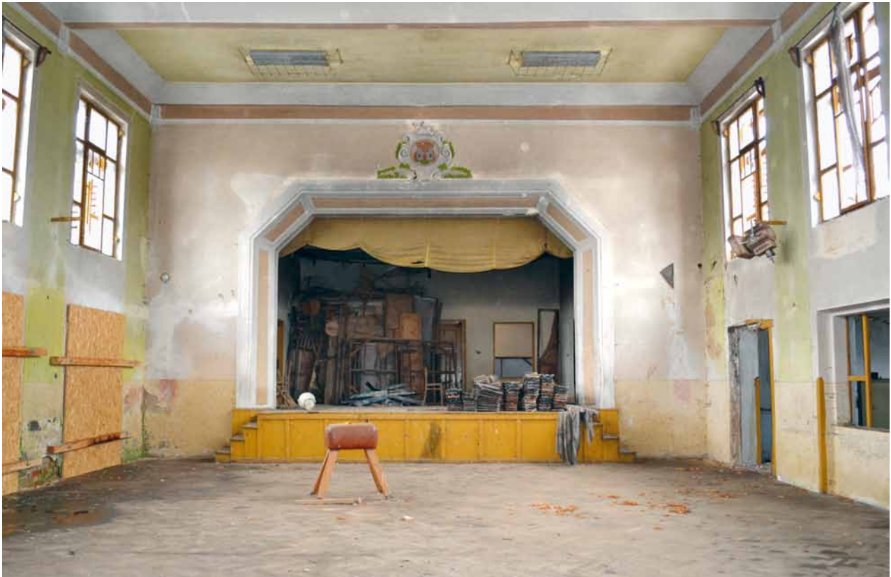
Obr. 6. Chudenice, sokolovna. Sál (tělocvična). Pohled k jevišti. (Foto D. Tuma, 2013)
