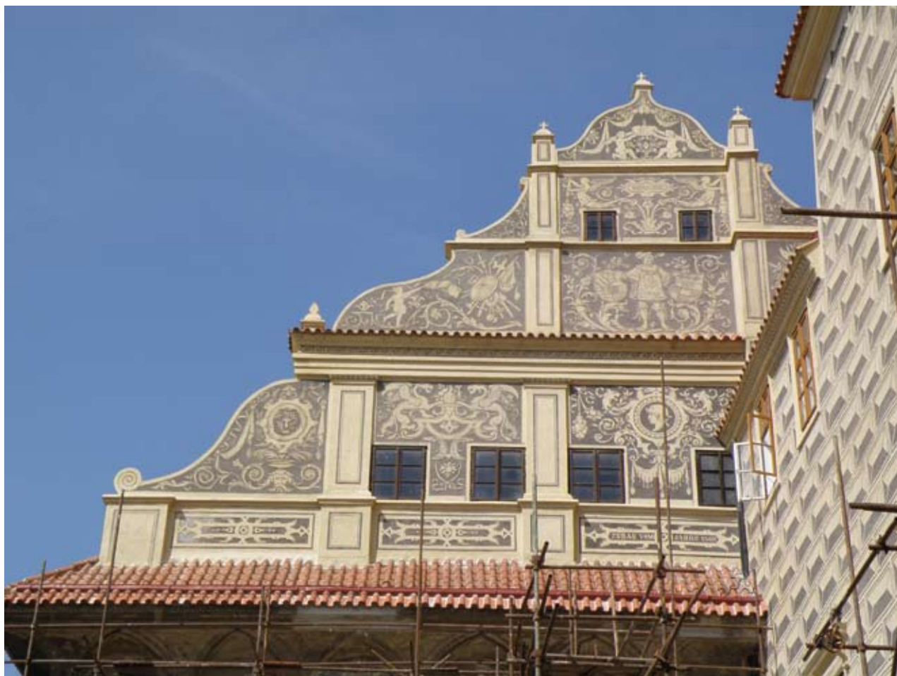
Obr. 18., 19. Horšovský Týn, zámek. Obnova sgrafitové fasády východního štítu nebyla součástí oprav střechy jižního křídla. Prováděla ji až společnost Archkaso, s. r. o., v roce 2008. Restaurátorské práce jsou dílem akad. soch. J. Jelínka. Stav před obnovou a po obnově. (Foto M. Solar, 2004, 2009)
