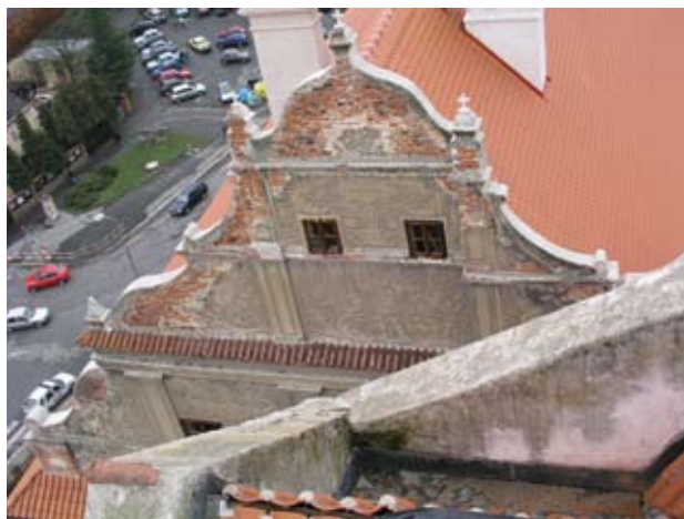
Obr. 18., 19. Horšovský Týn, zámek. Obnova sgrafitové fasády východního štítu nebyla součástí oprav střechy jižního křídla. Prováděla ji až společnost Archkaso, s. r. o., v roce 2008. Restaurátorské práce jsou dílem akad. soch. J. Jelínka. Stav před obnovou a po obnově. (Foto M. Solar, 2004, 2009)
