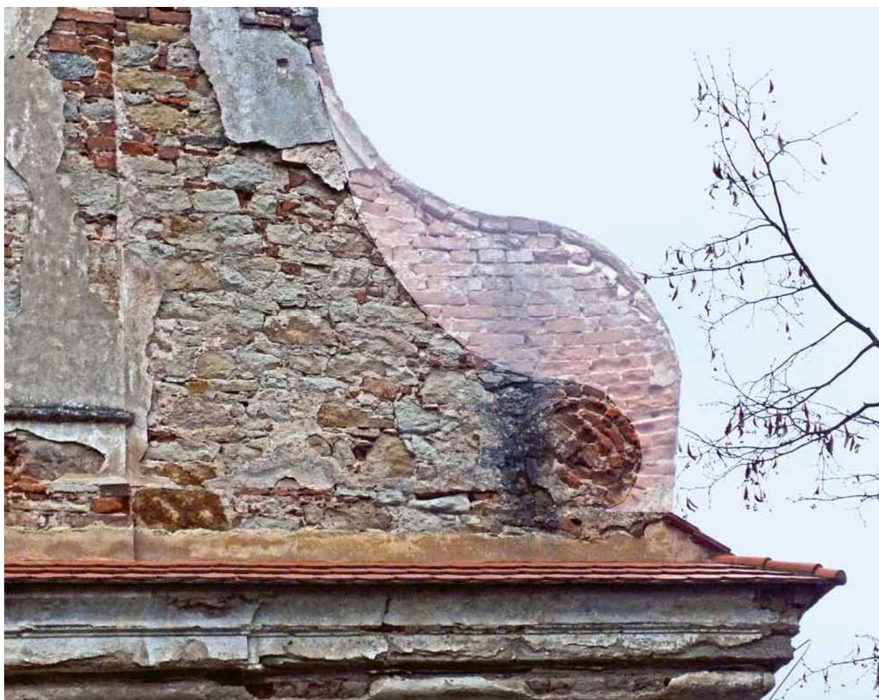
Obr. 8. Ostrovec, kostel sv. Jana Křtitele. Detail volutového štítu hlavního průčelí (dodatečně přizdělá část je zeslabena). (Foto P. Vlček, 2013)
