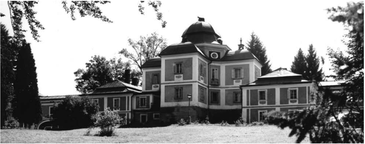
Obr. 3. Diana, zámek. Pohled na střední část zadní strany zámku. (Fotoarchiv Národního památkového ústavu, ú. o. p. v Plzni, foto J. Gryc, 1991)
