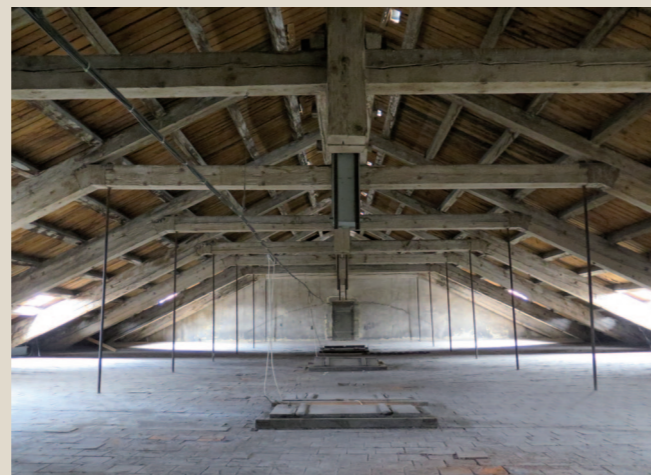
Konstrukce krovu nad kaplí. (Foto D. Tuma, 2017)
