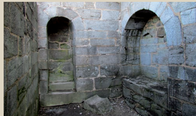
Přístavek obytné věže - románské zdivo, záchod a vpravo výklenek na sezení.
