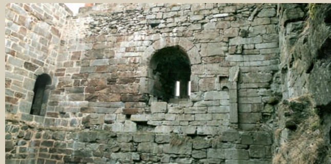
Severní stěna 1. patra obytné věže. Vlevo původní průchod ze vstupního přístavku. Uprostřed výklenek se sdruženým oknem, vpravo pozůstatky krbu.
