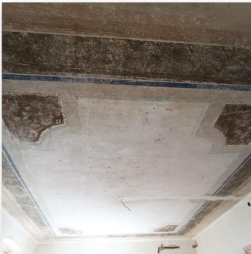
Místnost č. 2 – před a po restaurování
