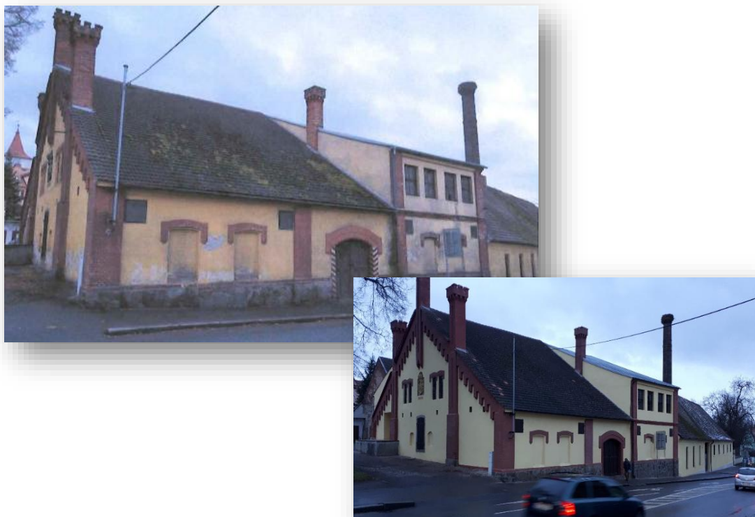
Stav před obnovou
