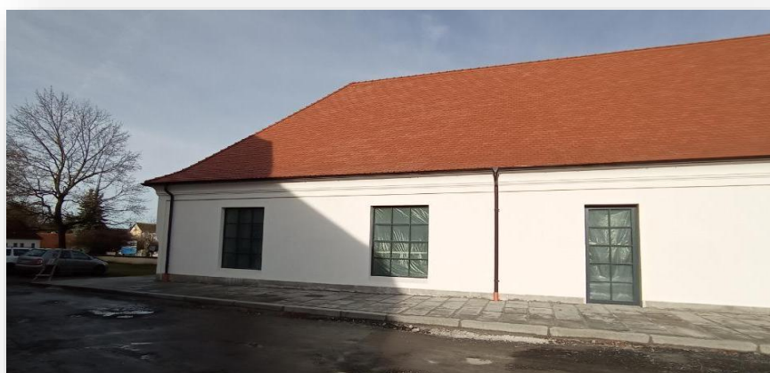
Chodníček kolem objektu maštali
