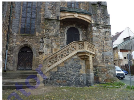
Arciděkanský kostel – restaurování schodiště
