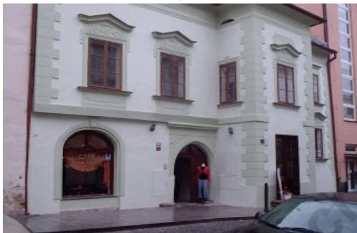
objekt č. p. 165/l - oprava a nátěr fasády
