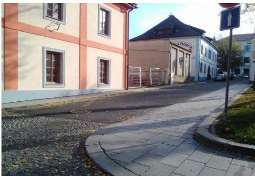
Pavlíkova – oprava povrchu chodníku oprav
