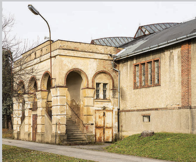
Arkádový rizalit uprostřed jihozápadního průčelí objektu
