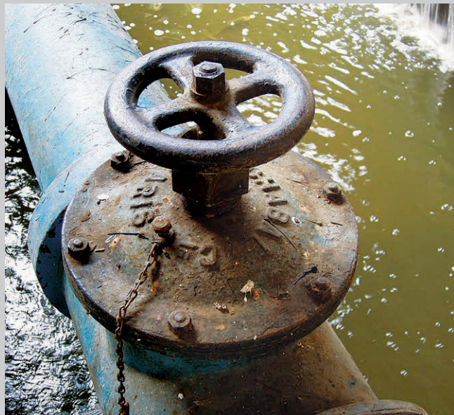
Jeden z 324 litinových ventilů na potrubí se stlačeným vzduchem s nápisem „Henri Chabal et Cie, Paris“
