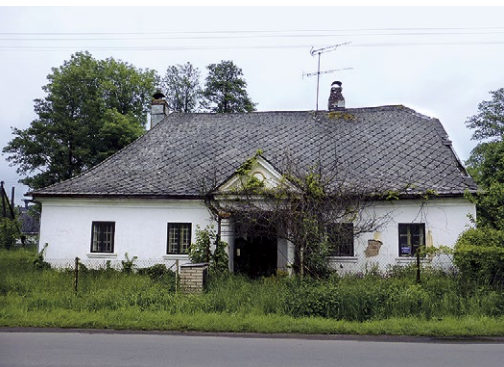
Dům č.p. 5 před obnovou, foto J. Švec
