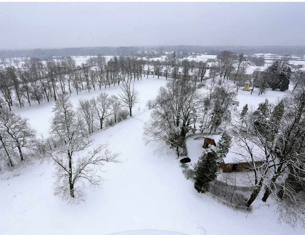
Na snímku bývalá stáj pro plnokrevníky, situovaná jižně od stájového dvora Kladruhy n. L.
