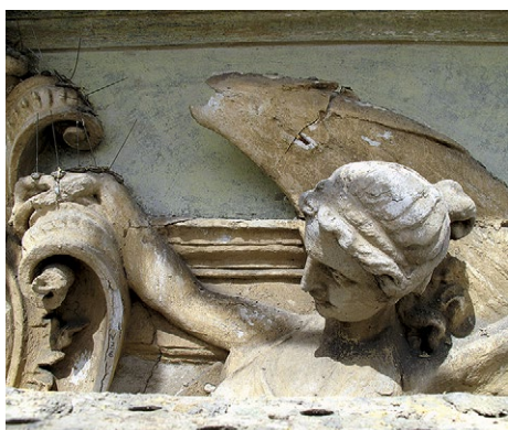
Svitavy, Langrova vila, poškozená výzdoba, 2019, foto V. Paukrt
