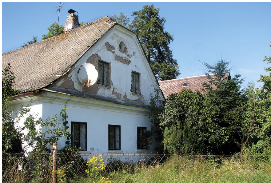
Dům č.p. 5 před obnovou, foto J. Švec
