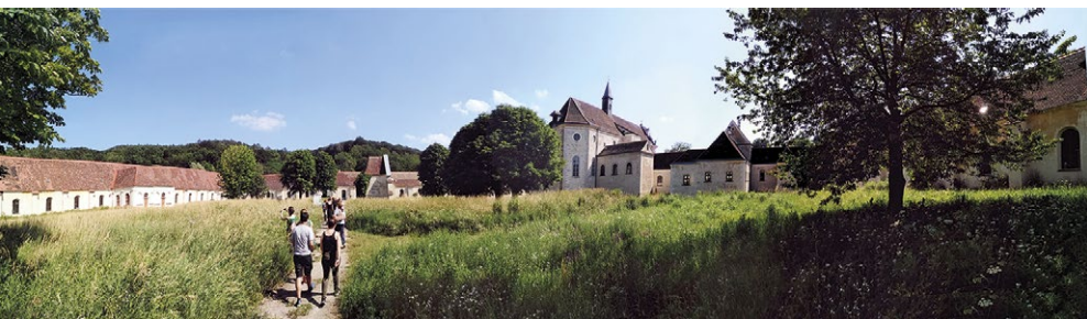
Vnitřní dvůr klášterního komplexu. Zdroj: foto autorky
