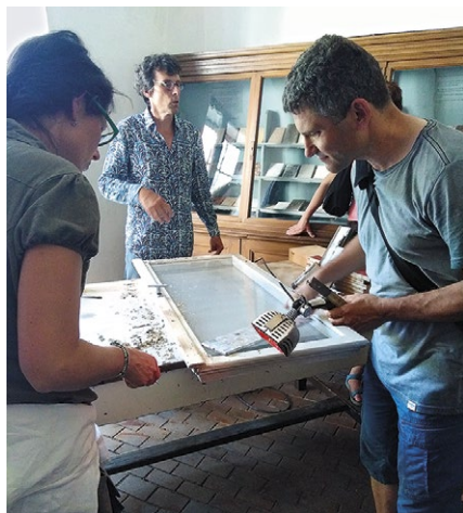
Technika zbavování se starých vrstev nátěrů u dřevěných oken. Zdroj: foto autorky
