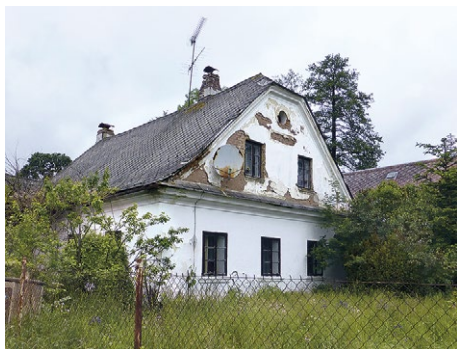
Dům č.p. 5 před obnovou, foto J. Švec
