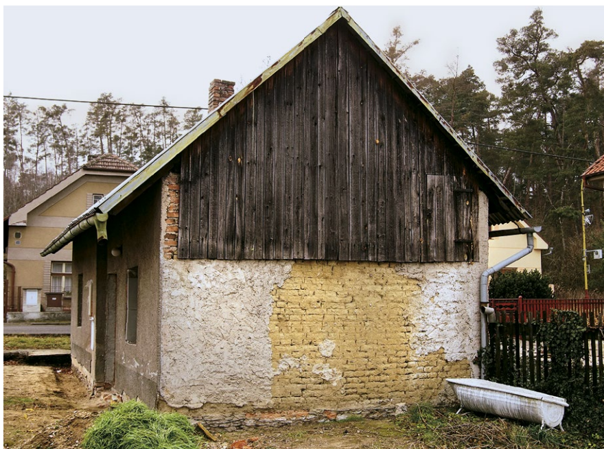
Pohled na zdivo z nepálených cihel čp. 1 – Bílé Vchynice, foto M. Křištof
