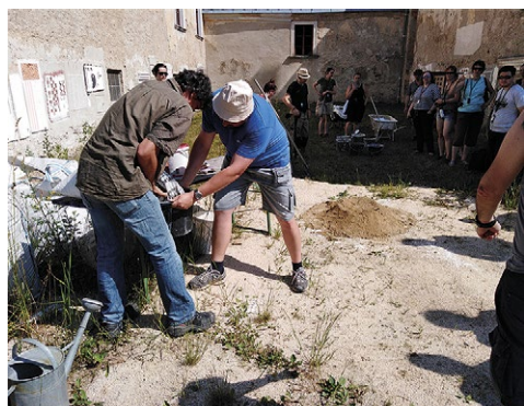
Výroba hašeného vápna. Zdroj: foto autorky
