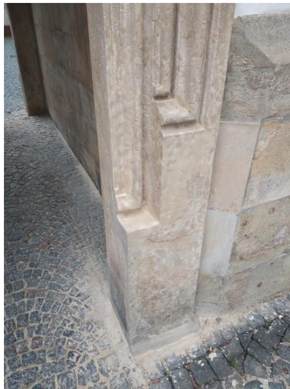
pískovcové prvky po zásahu restaurátora
