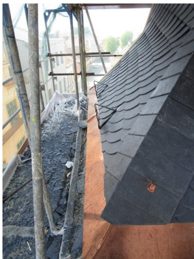
detail měděné okapové hrany
