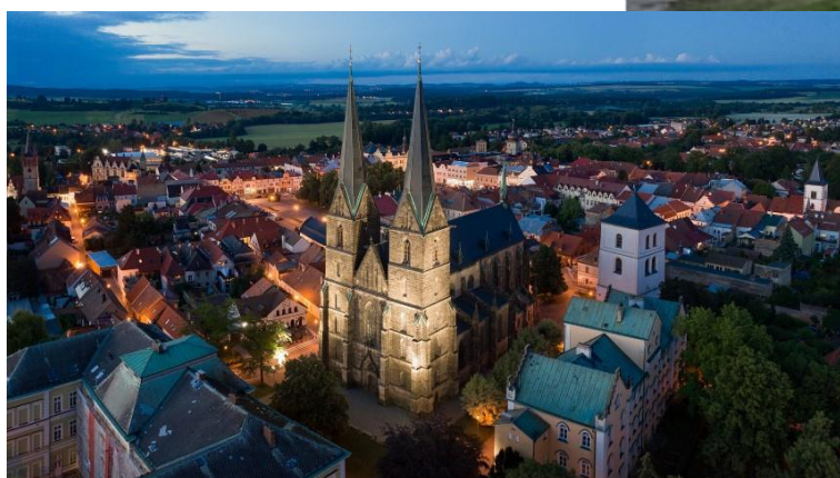
náměstí Otmarův po rekonstrukci
