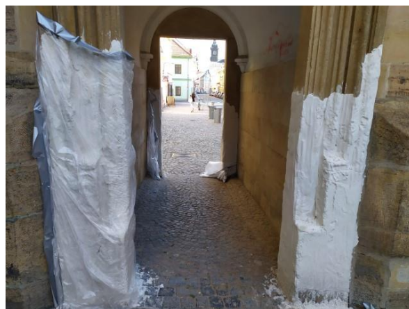
odsolovací bandáž pískovcového portálu
