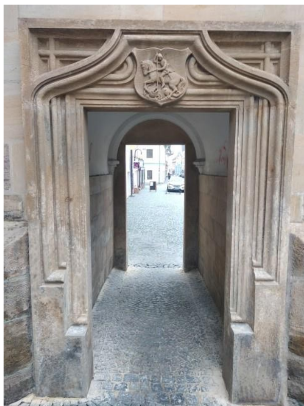
pískovcové prvky po zásahu restaurátora
