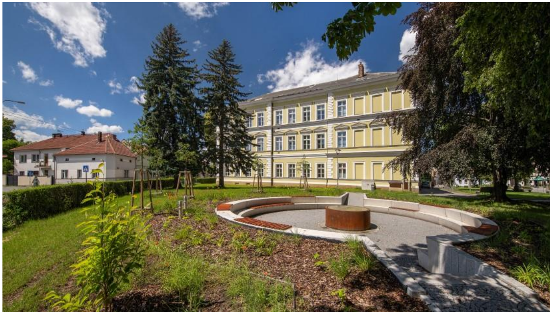
nová kašna vedle budovy gymnázia
