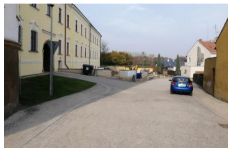
ulice Soudní po rekonstrukci v r. 2019
