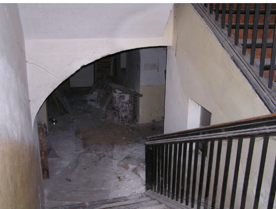
16 Dvouramenné schodiště do patra před obnovou budovy, 2017. Foto Eva Pulkrtová.
