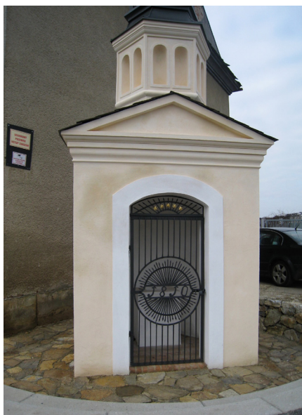
⑩ Lutín, kaple sv. Floriána, detailní pohled na čelní fasádu kaple po rekonstrukci, 2020. Foto Dobroslava Neckařová.
