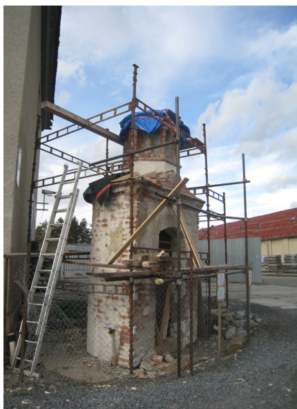
⑦ Lutín, kaple sv. Floriána, celkový pohled na kapli v průběhu rekonstrukce, 2019. Foto Dobroslava Neckařová.
