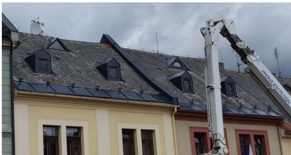
Střechy domů čp. 11 a 12 na Masarykově náměstí
