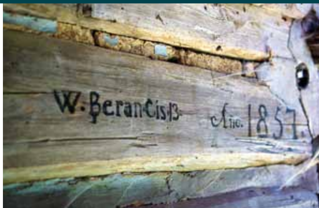
Malovaný nápis s datací nacházející se na stěně komorového patra
