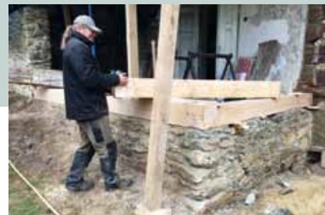
Práce zručného tesaře Tomáše Kracíka
