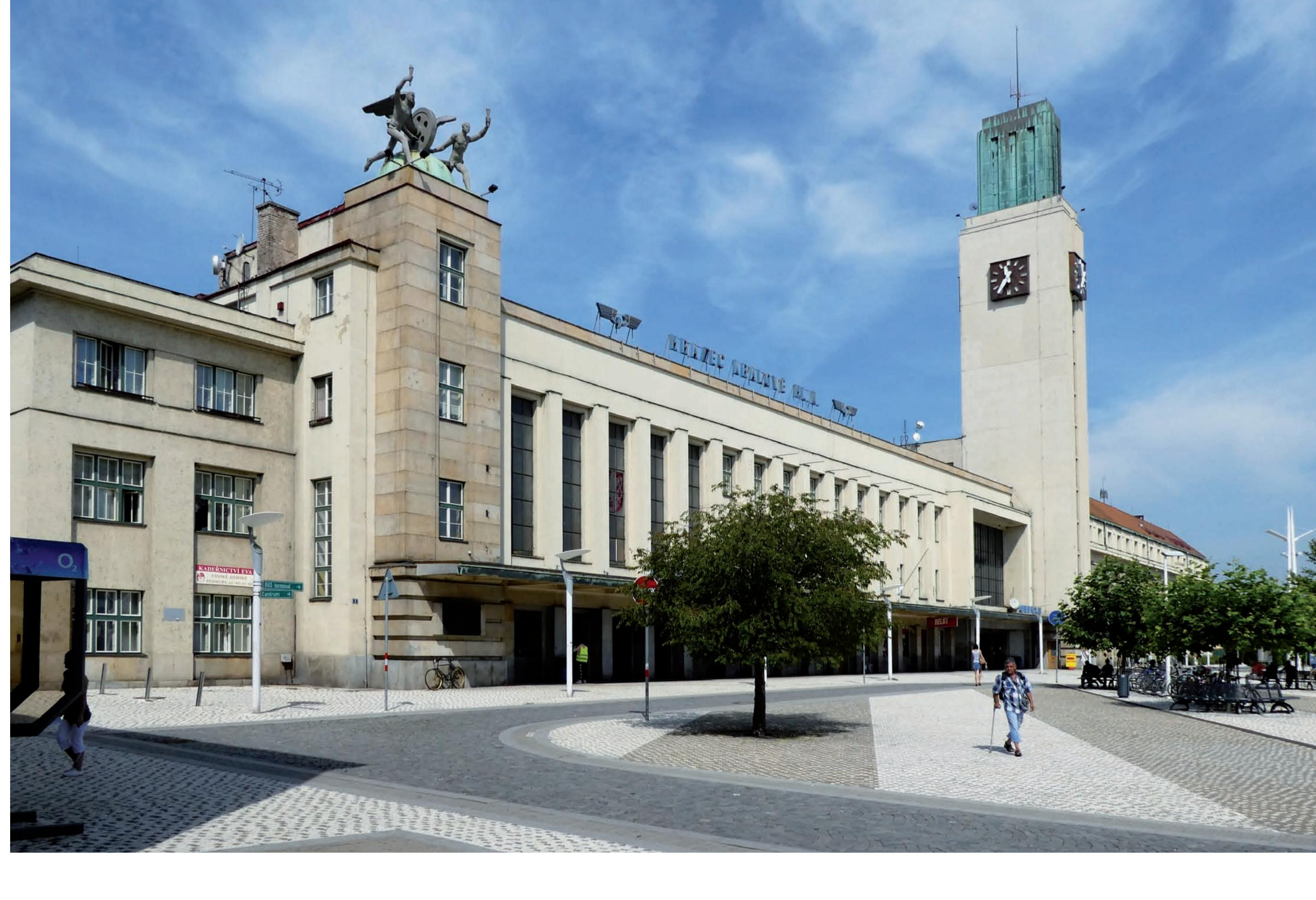
Velkoryse pojatá novostavba multifunkční výpravní budovy, navržená v důstojném stylu klasicizujícího funkcionalismu, nahradila nedostačující starší stavbu. Hlavní výpravní budovu tvoří monolitický železobetonový skelet. Zvolená konstrukce umožnila bohatě prosvětlit odbavovací halu velkoplošně prosklenou střechou, stropními světlíky a stěnami.
