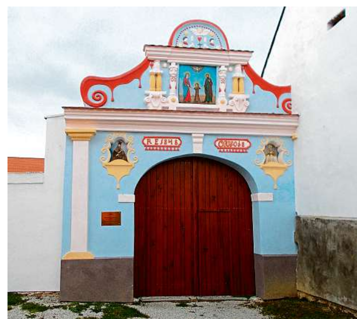
Od mistra Brána dnešního Muzea venkovského života v Předslavicích je typickým dílem zednického mistra Jakuba Bursy. Foto: Václav Jungwirth
