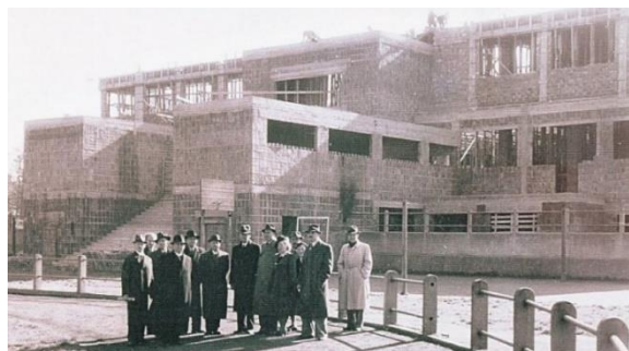
Výstavba sokolovny; zdroj: archiv. TJ Sokol Č. Budějovice
