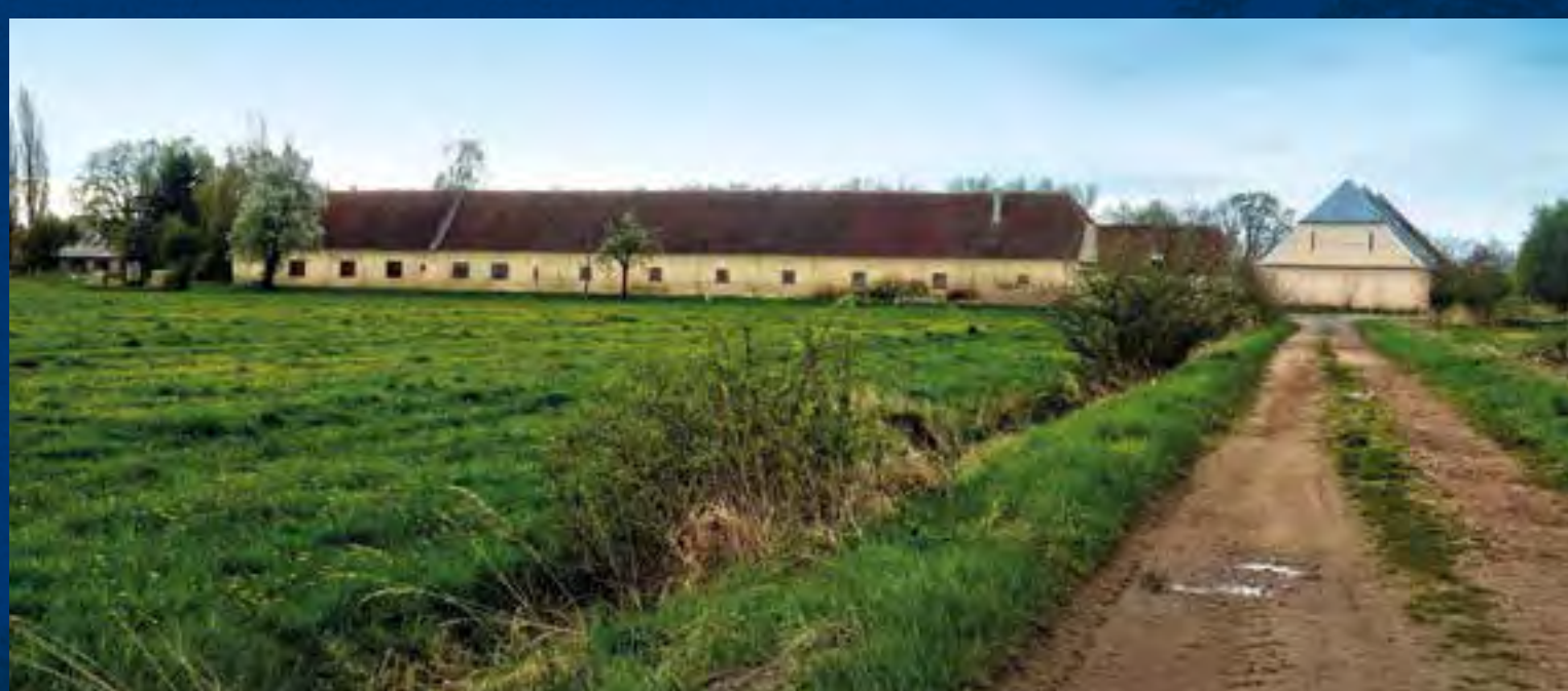
Lhota u Dynína, pohled na dvůr od severu s přímým úsekem cesty
