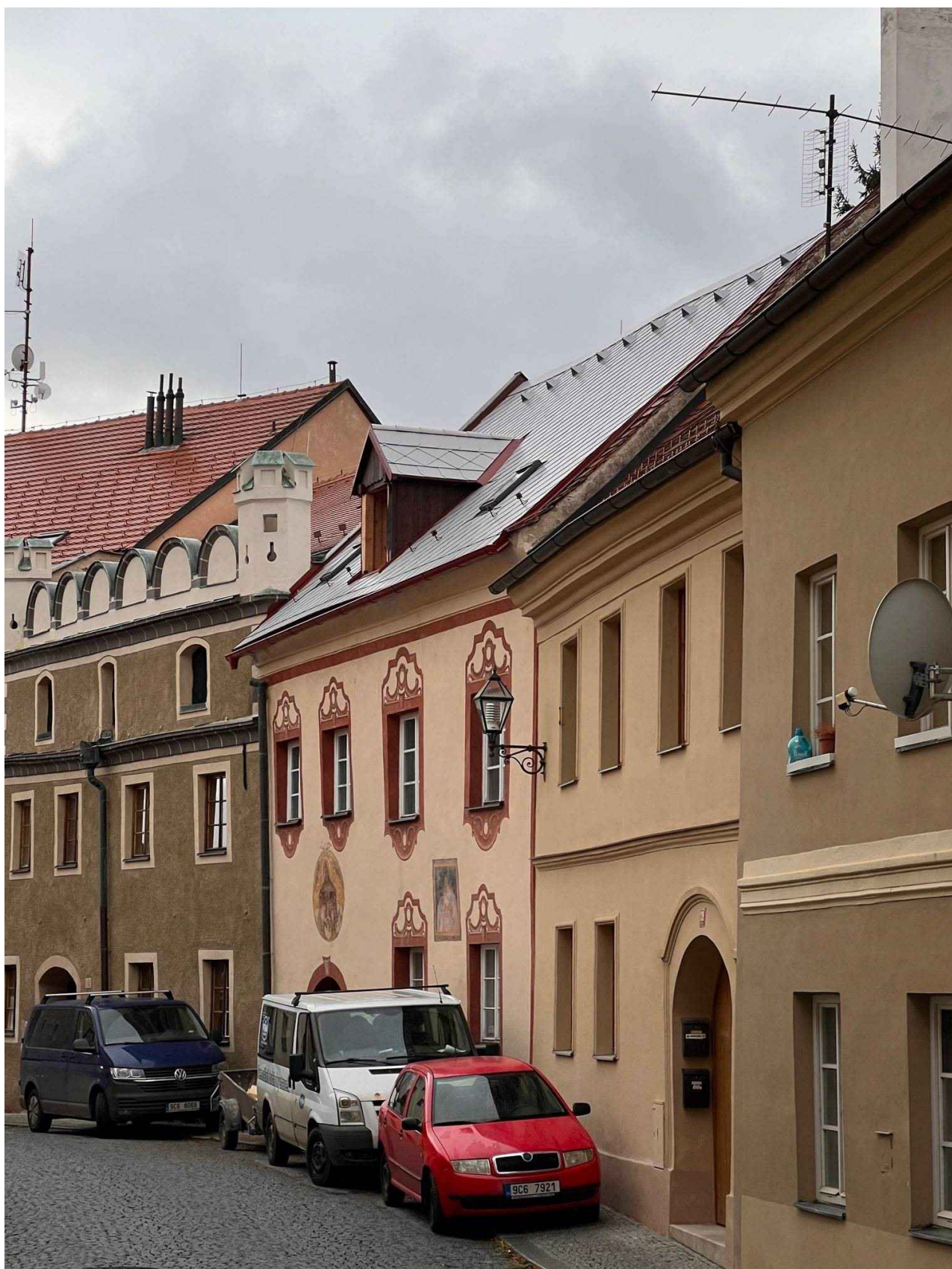
Měšťanský dům č.p. 138 – obnova střešního pláště domu pro účely domácího hospice, stav listopad 2023
