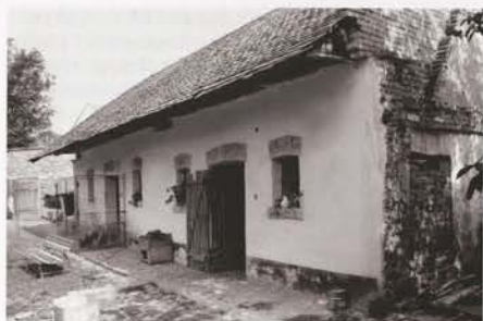
Chlévové křídlo usedlosti čp. 26. Foto 1997.
