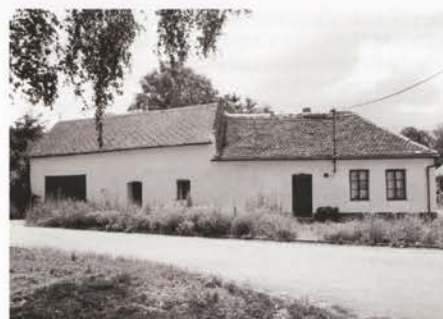
Chalupa čp. 76 – stav po odstranění žudru. Foto 1997.
