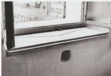
Široký Důl čp. 25 – opuková parapetní deska u okna v kuchyni. Žlábký zachycovaly vodu ze zapocených oken a otvor v desce vodu odváděl do hrnku ve výklenku (foto Zdeněk Holomý, 1996).
