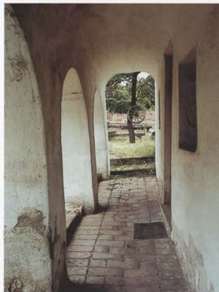
Pavlov, dům čp. 49, náspí, stav před rekonstrukcí.
