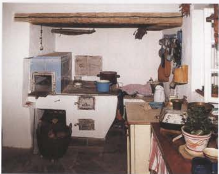
Dům čp. 107, kuchyně dymníkového typu v koutě síně s vestavěným zděným sporákem.
