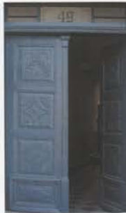
Pavlov, dům čp. 49, vstupní dveře po opravě.
