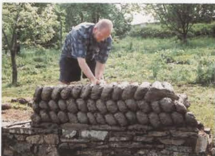
Lysovice čp. 33. Rekonstrukce válkového zdíva.
