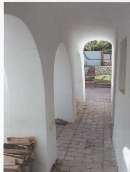
Pavlov, dům čp. 49, náspí, stav po rekonstrukci.
