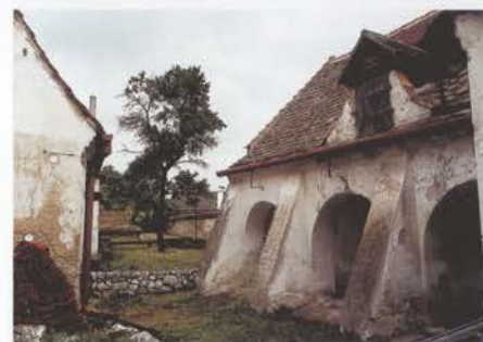
Pavlov, dům čp. 49 – pohled do dvora, stav před rekonstrukcí.
