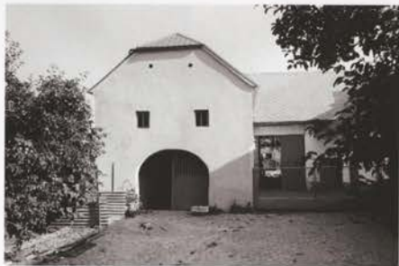
Podélně průjezdná kolna usedlosti čp. 41. Foto 1997.
