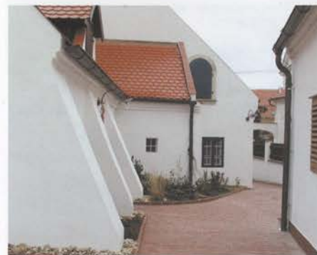
Pavlov, dům čp. 49 – pohled ze dvora, stav po rekonstrukci.
