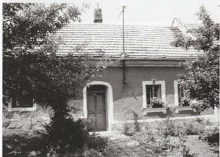
Chalupa čp. 63 – uliční průčelí. Foto 1997.
