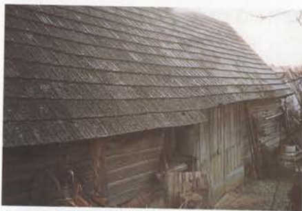
Roubená stodola v Pavlicích č. 19, okr. Znojmo, pohled na severní stěnu od SV.
