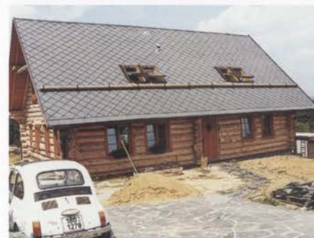
Hořice (Blansko). Novostavba roubeného domu z kuláčů opírající se o cizí kulturní tradice. Foto 2003.
