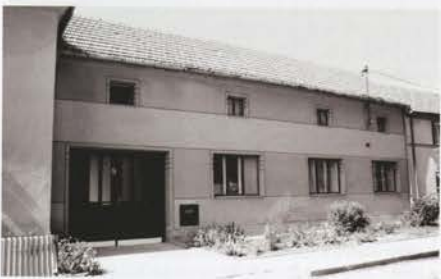
Usedlost čp. 9 – uliční průčelí. Foto 1997.
