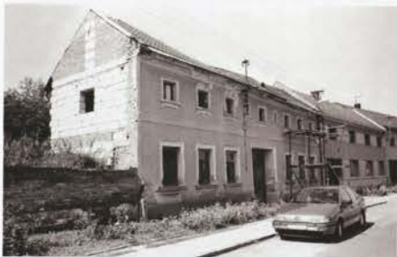
Usedlost čp. 5 se zvýšeným půdním polopatrem. Foto 1997.
