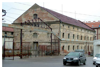
Budova E od severozápadu před demolicí (foto Zavadil 2008).
