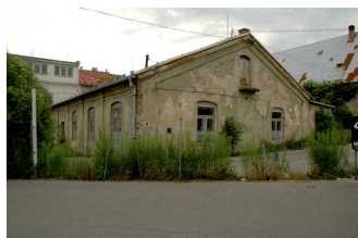
Budova B2 – pohled od východu (foto Šabatová 2008).
