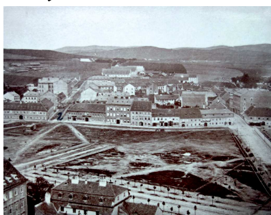
Pohled z věže kostela sv. Jakuba severozápadním směrem – v pozadí sledovaný areál, 1866 (AMB, fond US Sběrka fotografií, inv. č. Xc6).
