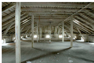
Budova F před demolicí – podkroví (foto Zavadil 2008).
