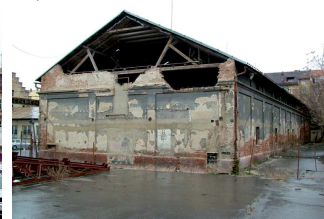
Budova D před demolicí – pohled od jihovýchodu (foto Zavadil 2008).
