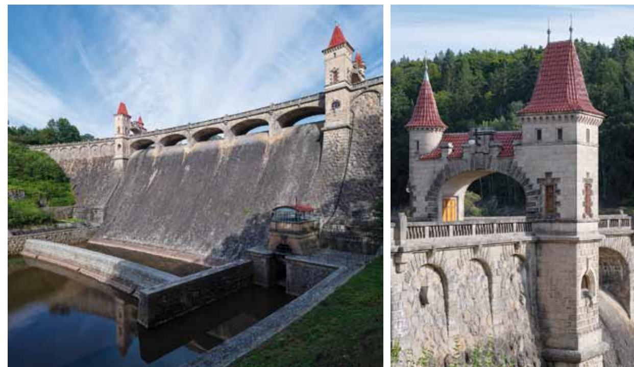
Fig. 4.38: The Les Království dam (1910–1919) – masonry gravity dam. Photograph by Viktor Mácha, 2020.
