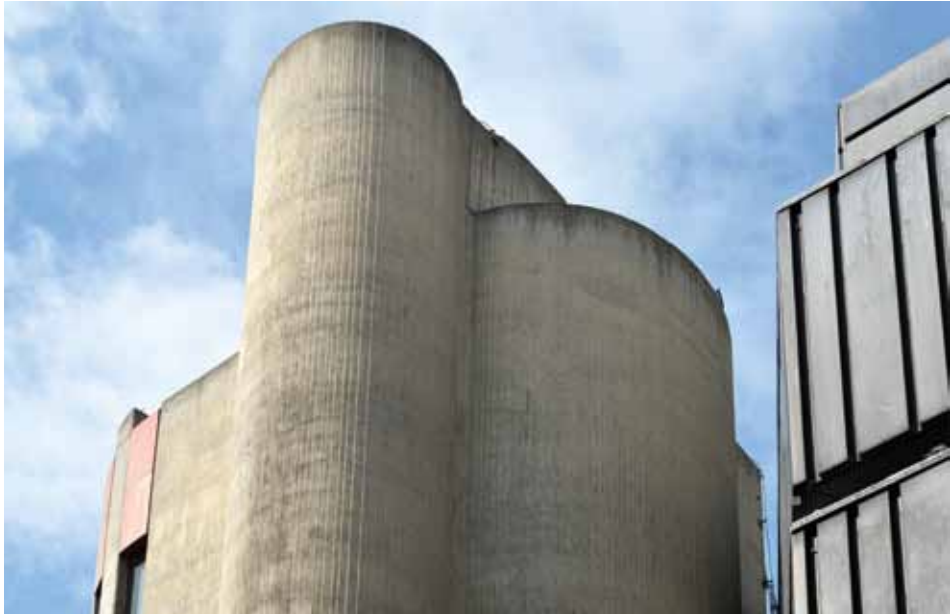
☞ Pohledový beton nadzemní části objektu (foto Roman Polášek, 2017).
