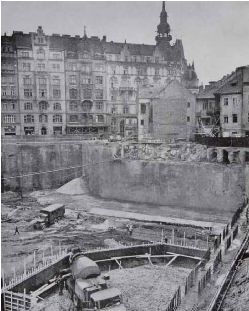
◁ Vybetonované stěny ve výkopu (archiv oddělení informací a propagace ORTEI VHI Vodní stavby o. p.)
