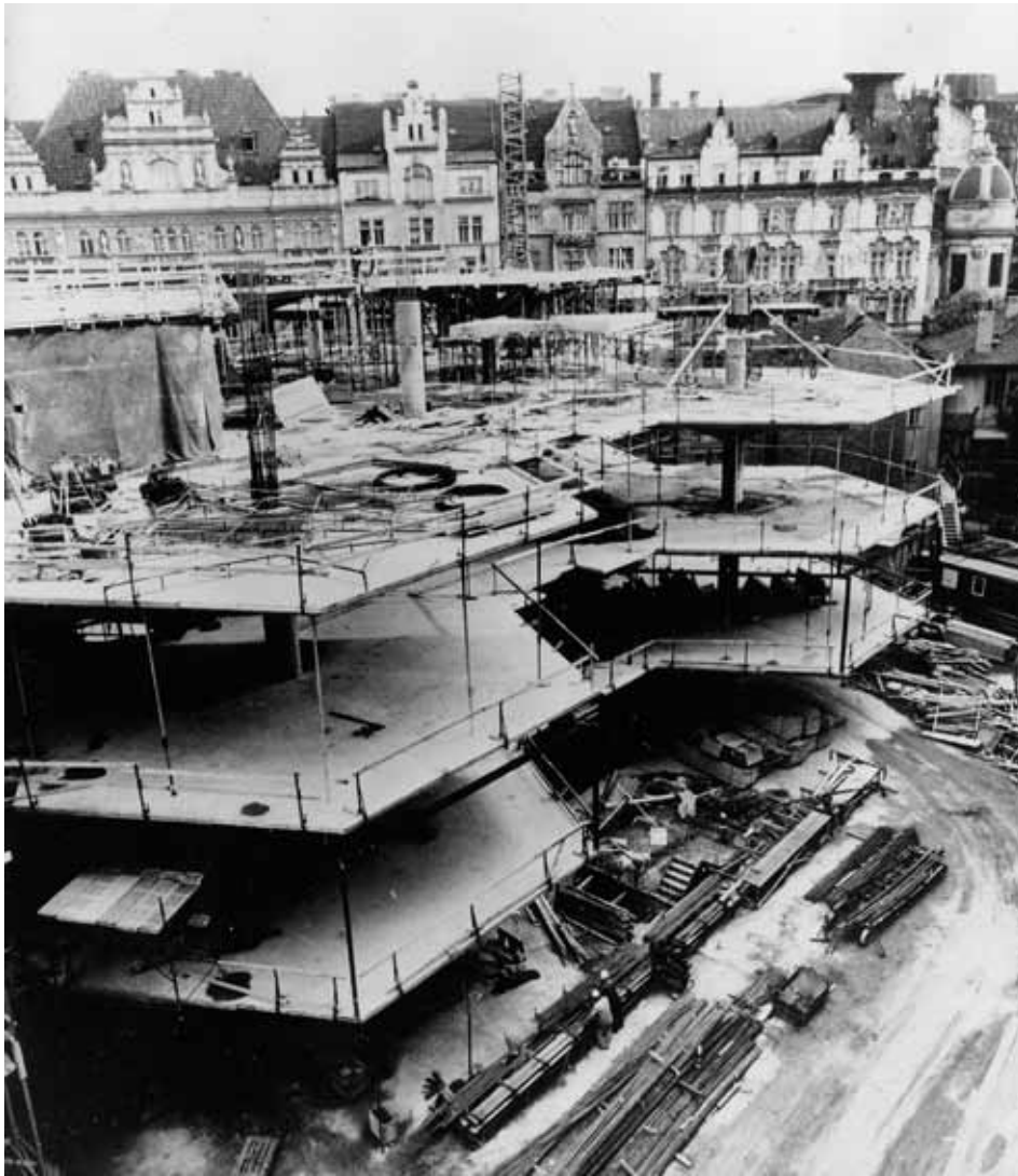
⊞ Dobový snímek rozestavěné konstrukce OD Kotva (archiv Oldřicha Schwarze).
