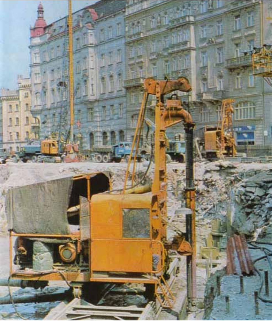
➤ Realizace výstavby pilotů tlakovou injektáží pažnic (foto archiv oddělení informací a propagace ORTEI VHJ Vodní stavby o. p.).
