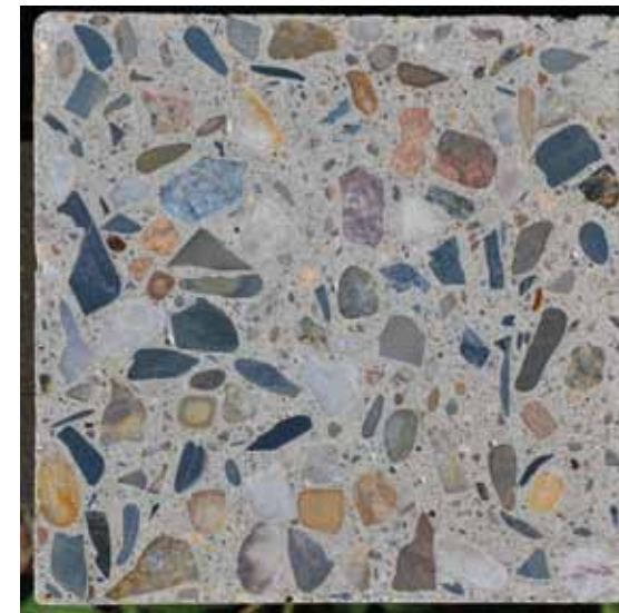
↗ Vzhled betonu ze spodní stavby (foto Petr Cikrle, 2018).
