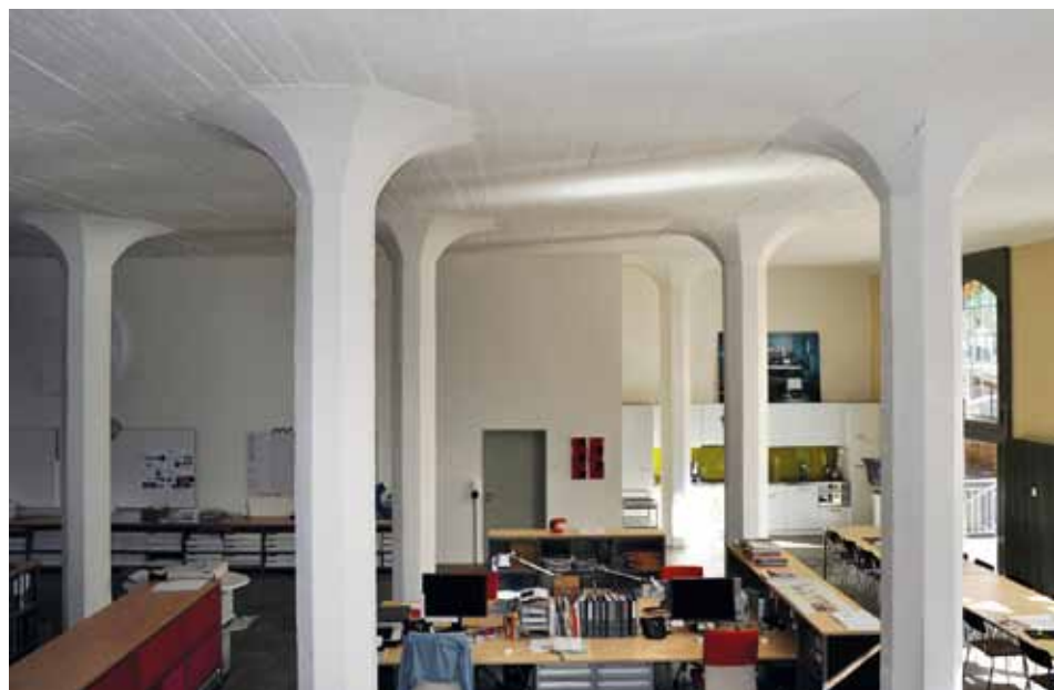
⌂ Robert Maillart, hřibové stropy v bývalém skladišti Gieshübel v Curychu, 1910 (© Chriusha (Хрюша)/CC-BY-SA-3.0/Wikimedia Commons).
