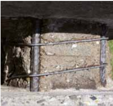
Stav ocelových armatur po očištění a ošetření inhibitorem koroze kovů (foto Tomáš Skalík, květen 2015).
