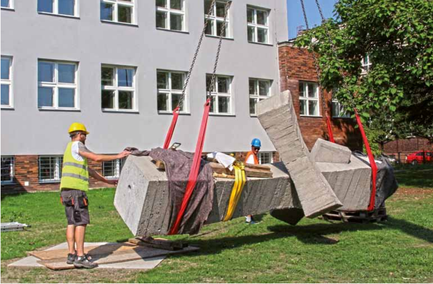
Montáž díla na místě (foto Tomáš Skalík, červenec 2015).
