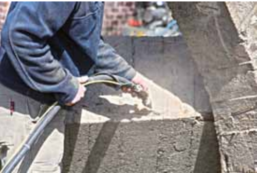
Čištění povrchu technologií mikroabrazivního nízkotlakého tryskání (foto Tomáš Skalík, květen 2015).
