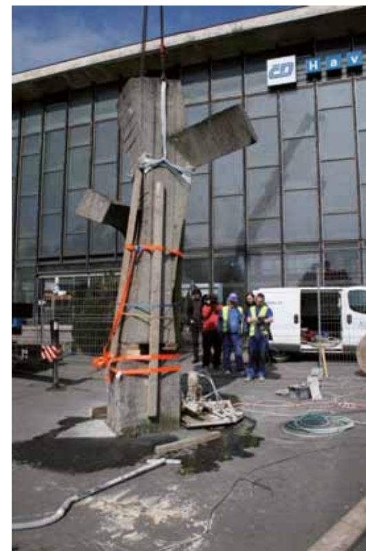
Demontáž plastiky (foto Tomáš Skalík, 28. března 2014).
