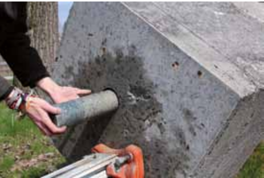
Duté vrtání otvoru pro čep – vytažení jádra z provedeného vrtu (foto Tomáš Skalík, duben 2015).
