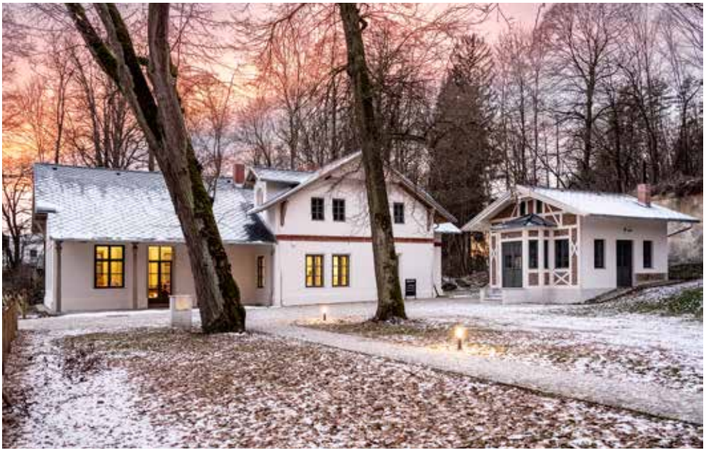
Obr. 9. Jindřichův Hradec, Nežárská čp. 121, výletní restaurace Rudolfov a altán po obnově, pohled od severovýchodu, foto: Jan Strojek, 2024
