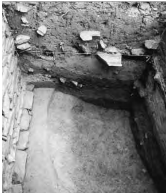
Kouřim (okres Kolín). Projekt sanace reliktů středověkého opevnění Kouřimi vychází z poznatků o způsobu založení a výstavby hradeb. Řez souvrstvím přiléhajícím k hlavní bradbě ukazuje, že základ hradební zdi dosahoval bloušky pouze několika desítek centimetrů. Do mělkého žlábků vybloubeného do podloží, jehož povrch se ve 13. století v podstatě shodoval s povrchem terénu, byla položena rovná řada kamenů, jejíž okraje byly zakryty blínou. Teprve poté navázala stavba nadzemní části bradby, jejíž mocnost se oproti základu poněkud zmenšila. Opadávající malta vytvořila kompaktní kru na novém povrchu terénu. Aktivity odehrávající se zde během středověku zanechaly své stopy v podobě několika vrstev a vkopů, jež starší horizont porušily. V průběhu následujících staletí se úroveň terénu v tomto místě zvýšila navážkami přibližně o 1,5 m (foto Z. Neustupný).
