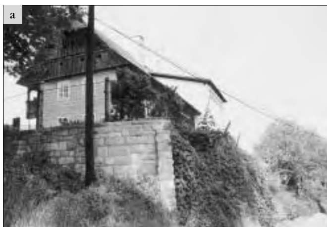
Dědibaby (okres Mělník), sýpka v usedlosti čp. 4. Objekt po obnově krovu a střechy. Tvar střechy se štítovými nadezdívkami byl rekonstruován podle starší dobové fotodokumentace (foto J. Berková, 2002).
