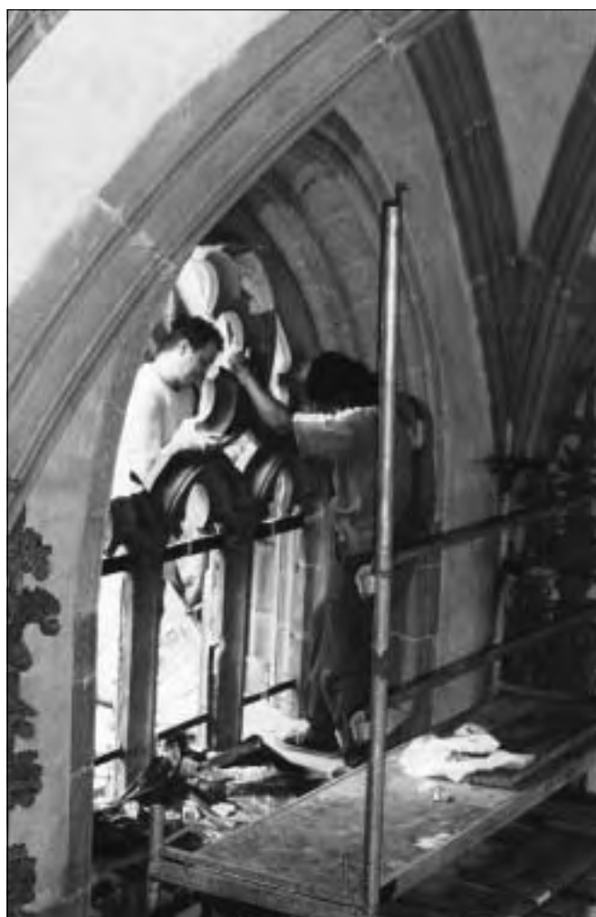
Hrad Křivoklát, kameníci snímají kružku severního okna bradní kaple, zhotovitel společnost GEMA art, Praha (foto z archivu bradu Křivokláta).
