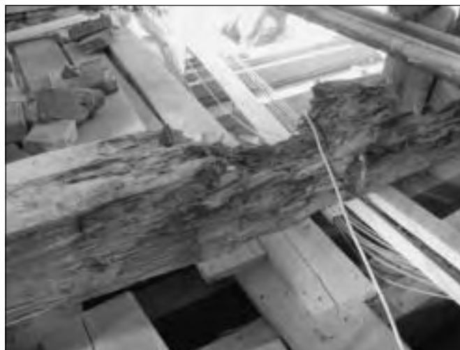
Zámek Konopiště, po odstranění násypu a záklopových prken nad II. patrem jižního křídla zámku bylo zjištěno výrazné napadení stropních trámů dřevokaznou houbou (foto M. Dropka).
