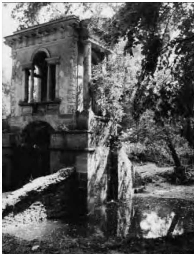
Veltrusy, Laudonův pavilón v zámeckém parku těsně po povodni v srpnu roku 2002. Prudký proud zničil pravou nižší část tohoto architektonického a terénního díla včetně hluboké eroze podloží. Střední část pavilonu proud vody nadzvedl a ta poklesla do poněkud změněné polohy. Na této střední části se projevuje prnutí a trhliny. Poruchy jsou exaktními technickými metodami sledovány, je realizováno prozatímní zabezpečení pavilonu (srov. obr. na s. 96, foto V. Láška).
