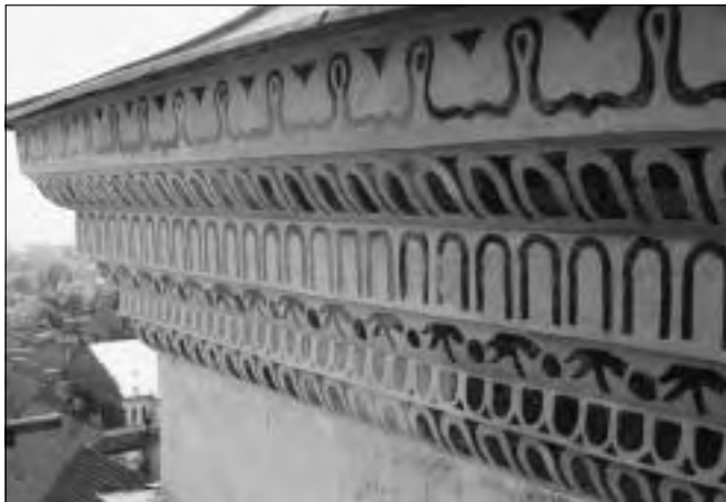
Smečno (okres Kladno), kostel Nejsvětější Trojice, detailní pohled na část římsy věže. Sgrafitová výzdoba, již v minulosti novodobě obnovena, byla zajištěna, doplněna a konzervována (foto E. Volfová, 2002).
