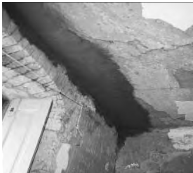
Saky (okres Kladno), detail stropu v interiéru domu. Při obnově interiéru domu čp. 7 byly použity tradiční technologie. Původní bliněné omítky zůstaly zachovány, jejich narušené části byly doplněny stejným materiálem. Na snímku je zachycen strop světnice v patře s nově doplněnou bliněnou omítkou (foto J. Berková, 2002).
