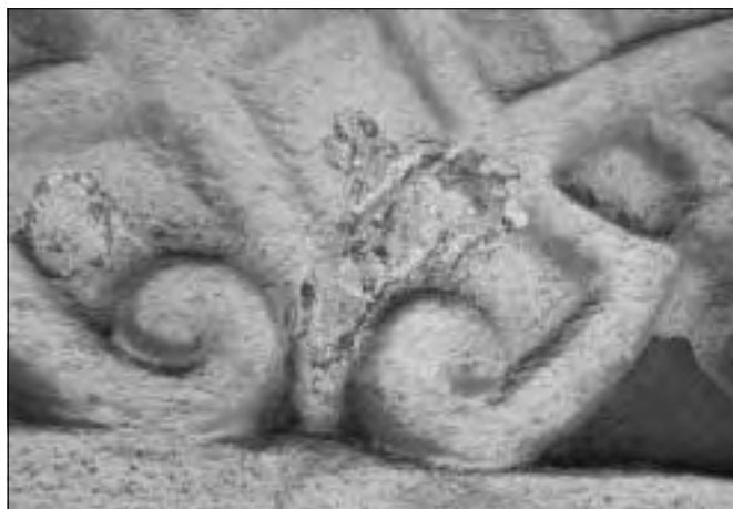
Beroun, dům čp. 89, detail štukové výzdoby průčelí. Dům čp. 89 si snad jako jediný z domů na náměstí v Berouně dochoval přes překrytí tvrdým štukem autentické architektonické členění průčelí, pocházející z pozdního 18. století. Zachování původních tvarů s nátery doložil i orientační sondážní průzkum, prováděný „narychlo“ z výsuvné plošiny. Prosazení kvalitní opravy původních článků bude vzhledem k přístupu majitele, vyžadujícího jinou kvalitu, kterou může zaručit pouze nové dílo, značně náročné (foto J. Žižka, 2002).
