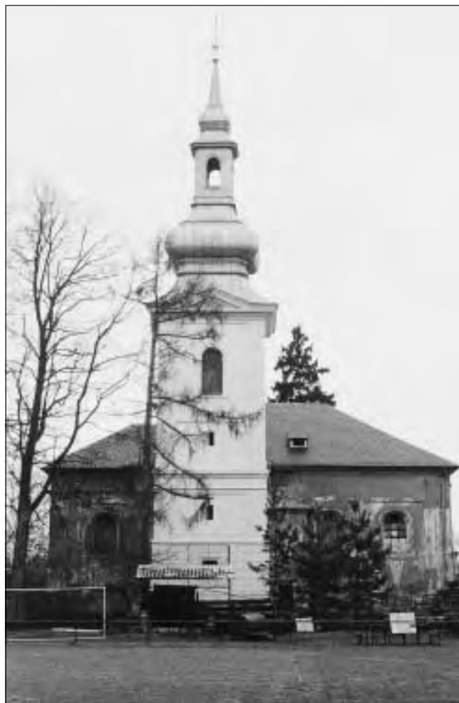
Kráňec (okres Nymburk), kostel sv. Jiljí s opravenou věží. Omítky fasády byly před opravou z velké části narušené nebo zaniklé. Průzkum omítek odhalil pozůstatky barokních vrstev s plastickými články a iluzivními malovanými cihlami, které byly restaurovátorůsky zajištěny a následně překryty omítkou. Při opravě byla respektována celistvost pozdně klasicistní přestavby. Dobrý výsledek opravy poněkud hyzdí bezprostřední okolí kostela s nevhodnými jehličnany a přístřešky (foto E. Vyletová, 2002).
