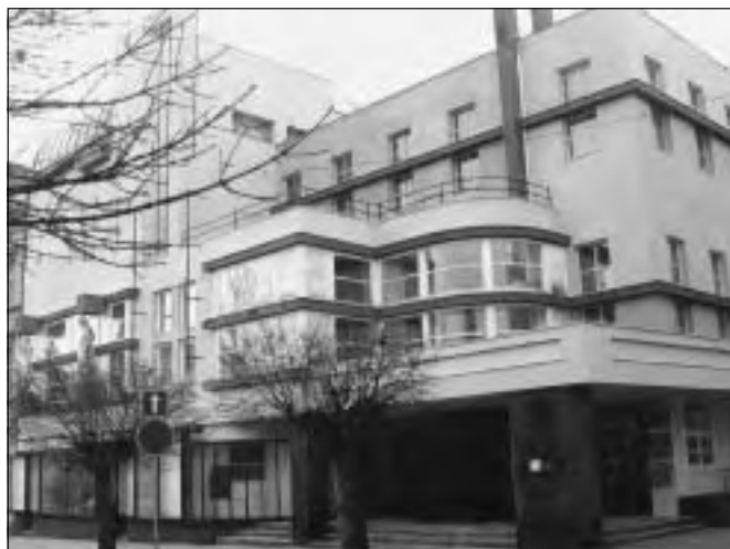
Benátky nad Jizerou (okres Mladá Boleslav), konstruktivistická budova od arch. J. Krohy. Při opravě bylo důležité zachovat původní charakter fasád obnovením omítek probarvených ve hmotě bez vrchního nátěru. Sjednocení starých a nových omítek bylo provedeno překrytím novou tenkou vrstvou, jejíž struktura a barevnost byla přizpůsobena původnímu stavu (foto E. Vyletová, 2002)
