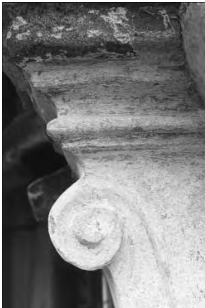
Bečváry (okres Kolín), detailní pohled na část architektonického členění vikýře na východní straně zámku. Součástí bohatého architektonického členění východního průčelí zámku v Bečvářech jsou pochopitelně i střešní vikýře, jejichž oprava byla prováděna v rámci obnovy střechy. Nezbytnou součástí přípravy kvalitní opravy byl průzkum upřesňující profilace a tvary deformované chybně provedeným omítkovým překryvem a doplňky. Záběr ukazuje část profilace římsy a volutu, ukončující páska lemující vikýř (foto J. Žižka, 2002).
