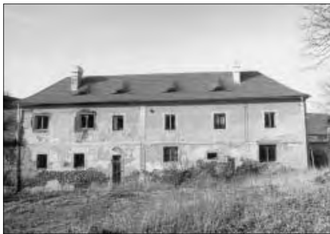
Prácheň (okres Benešov), obytný dům v areálu zámku. Jednou z dlouhodobých akcí, subvencovaných z Programu záchrany architektonického dědictví, je i obnova areálu zámku. Uplynulá léta pochopitelně patřila krovům a střechám. Na všech budovách je obnovována krytina z pálených tašek bobrovek i s uplatněním tradičních volských ok (foto J. Žížka, zima 2003).
