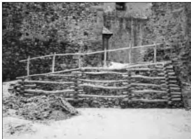
Hrad Točník, předložená samonosná opěrná zeď rampy na 2. nádvoří, zhotovená podle projektu ing. V. Mlázovského plzeňskou firmou Pegisan, s. r. o. (foto z archivu hradu Točník).
