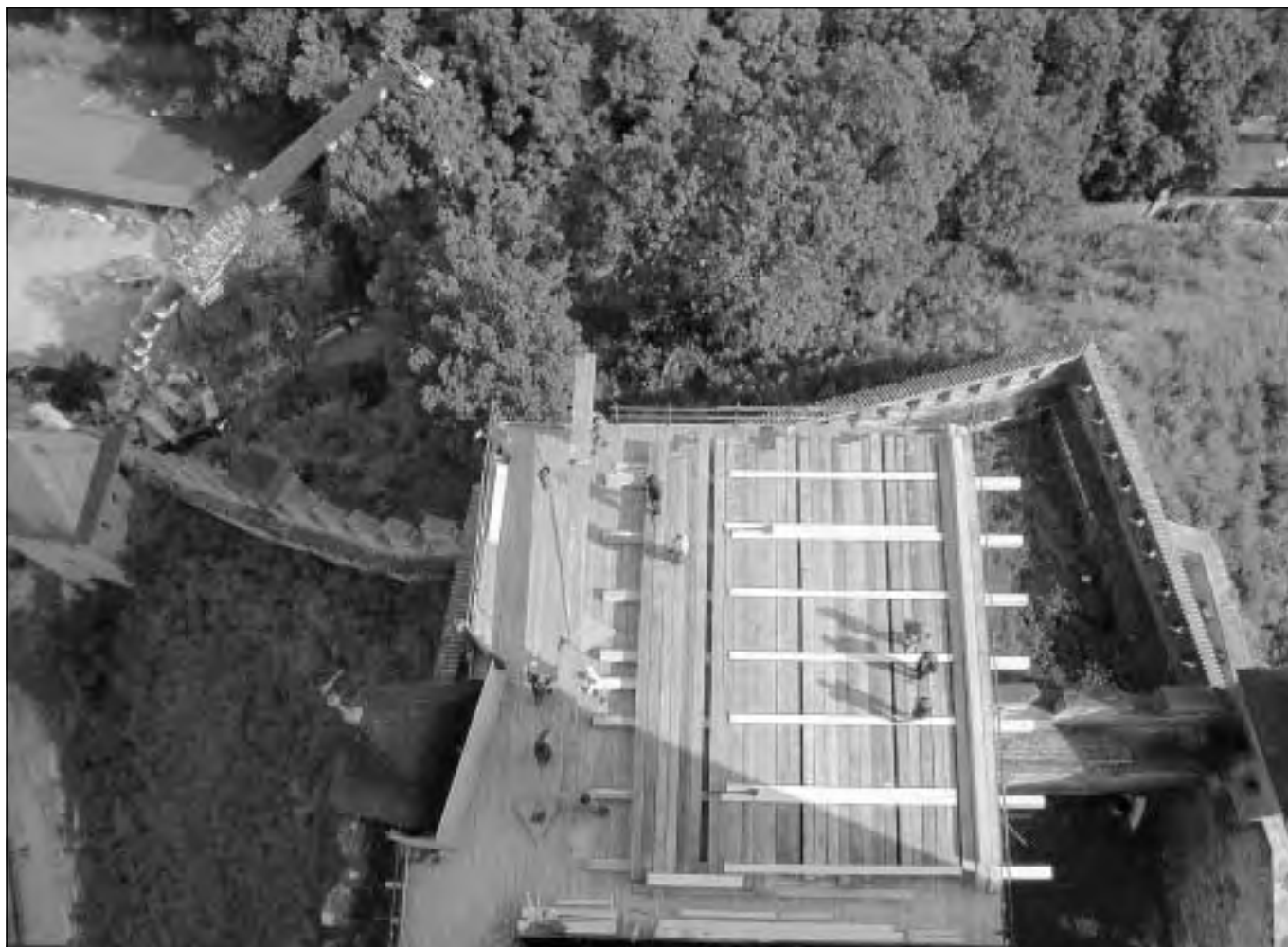
Hrad Karlštejn (okres Beroun). Jednou z nejobtížnějších etap stavby byla doprava trámů povalového stropu, který byl prováděn nad klenbou kaple sv. Kříže. Na fotografii je lešenová plošina nad hřbitůvkem, kde byly trámy dočasně uloženy. V další fázi se trámy ručně vytabovaly do prostoru 3. patra Velké věže. Na plošinu byly trámy vyneseny jeřábem firmy HANYŠ s vyložením cca 50 m. Vzhledem k tomu, že plošina nebyla z pohledu jeřábníka viditelná, celá akce vyžadovala profesionalitu a dokonalou koordinaci všech zúčastněných (foto M. Dropka).
