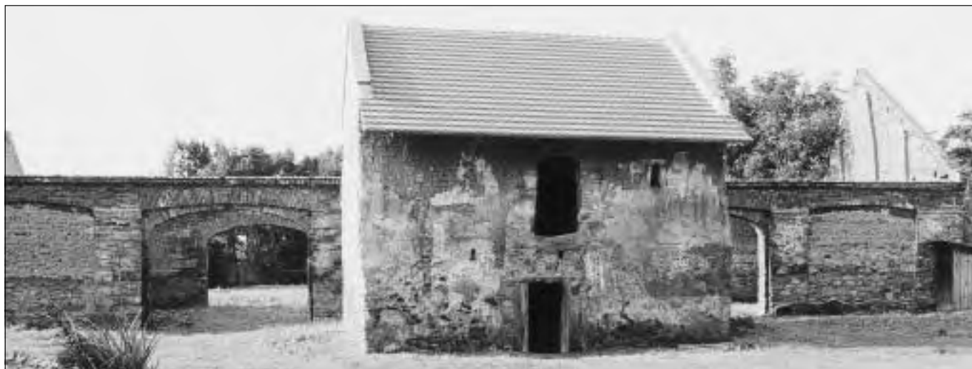
Dědibaby (okres Mělník), sýpka v usedlosti čp. 4. Objekt po obnově krovu a střechy. Tvar střechy se štítovými nadezdívkami byl rekonstruován podle starší dobové fotodokumentace (foto J. Berková, 2002).
