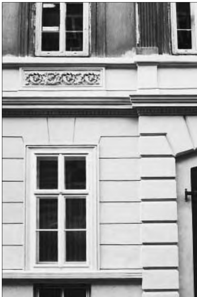
Praha 3, Sabinova 5/373, detail opravené části průčelí domu v rozsahu přízemí. Oprava fasády sídla Státního památkového ústavu středních Čech je ukázkou špičkové štukatérské práce, respektující dochované členění. Způsob provedení je včetně v lici osazených, ven otevíravých oken nepochybně dobrým vzorem jak pro majitele památek, tak i pro řadu prováděcích firem (foto J. Žižka, 2002).
