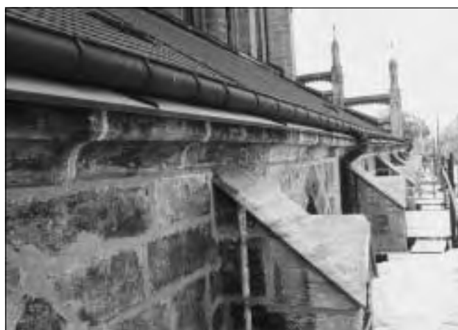
Kutná Hora – Sedlec, bývalý konventní kostel Nanebevzetí P. Marie, pohled na severní obvodovou stěnu boční lodi během restaurování. V první etapě restaurování fasád, prováděném v rámci celkové obnovy kostela, byly opraveny opěrné pilíře, římsa i kvádřové zdivo včetně spárování této části kostela. Poměrně zdařilý výsledek lze pokládat za vzorek pro další postup (foto J. Žižka, 2002).
