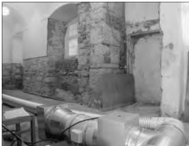
Zámek Veltrusy, rozvody klimatické jednotky v interiéru přízemí zámku po srpnových záplavách (foto M. Dropka).
