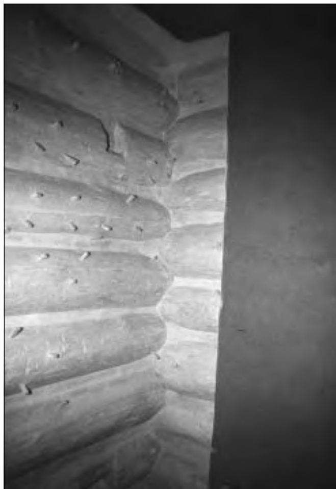
Saky (okres Kladno), dům čp. 2, detail části roubené stěny po restaurátorském zásahu. Hliněné omítky jsou zachyceny před provedením vápenného nátěru (foto J. Berková, 2002).
