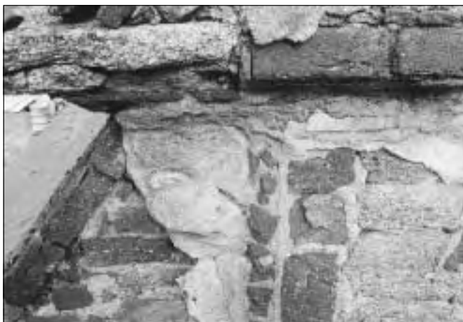
Vysoký Chlumec (okres Příbram), areál bradu, detail štítu domu v předbradí. Při průzkumu štítu, který byl dlouhou dobu téměř bez omítek, se podařilo zachytit zbytky barokního členění. Na snímku je vlevo pod vysazením římsy patrný fragment drobné voluty, který je přiložený k vysazenému rámu, jehož obrys se rýsuje po pravé straně voluty (foto J. Žižka, 2002).
