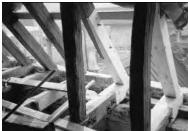
Hostín u Vojkovic (okres Mělník), probíhající oprava krovu a střechy kostela Nanebevzetí P. Marie. V roce 2002 byla realizována oprava pozoruhodného renesančního krovu kostela a obnova krytiny z tašek bobrovek. Zvolený běžnější způsob protézování v daném případě zřejmě do jisté míry minimalizoval rozsah zásahu do jednotlivých prvků a z hlediska nákladů umožnil realizaci opravy a obnovy střechy nad celou lodí. Realizované řešení současně nevyloučilo provedení jiného, řemeslně náročnějšího způsobu opravy v budoucnosti (foto D. Hladíková, 2002).
