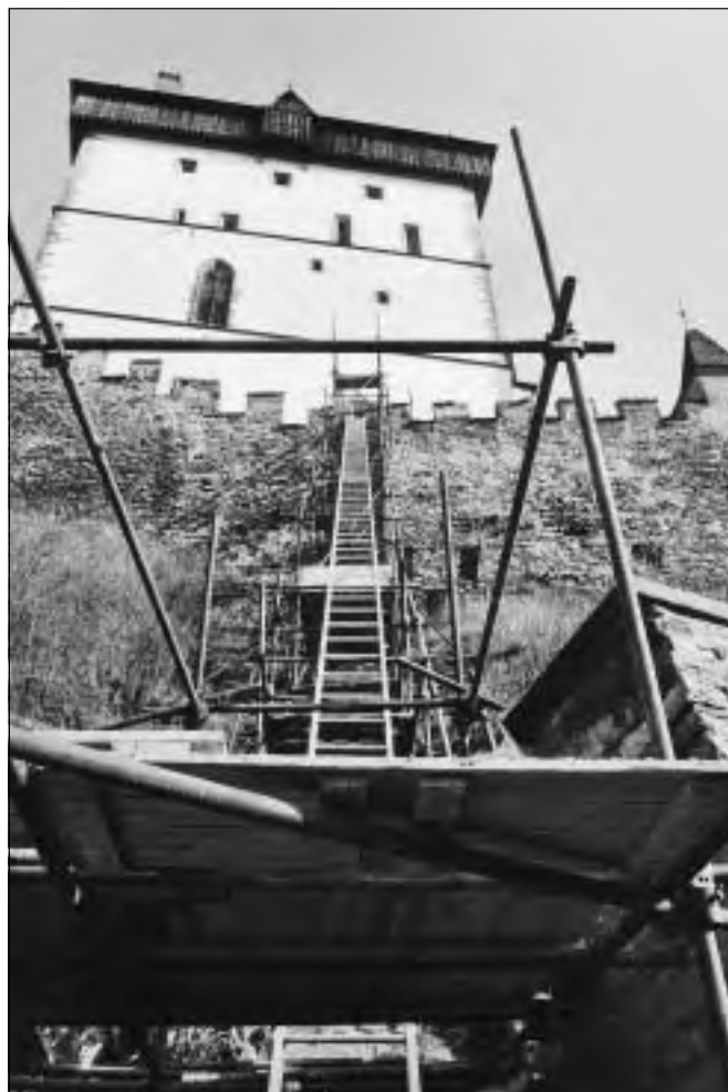
Hrad Karlštejn, doprava stavebního materiálu k Velké věži (foto z archivu hradu Karlštejna).
