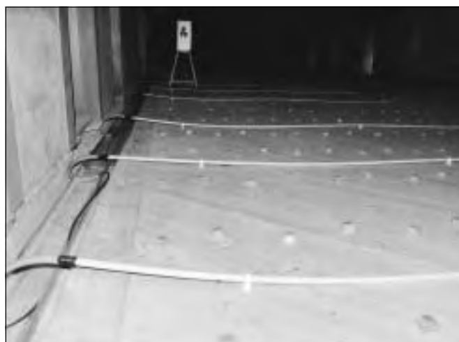
Hrad Karlštejn, konstrukce podlahy 3. patra Císařského paláce včetně rozvodů nasávacích trubic EPS, stav při dokončování 2. etapy rekonstrukce (foto z archivu hradu Karlštejna).
