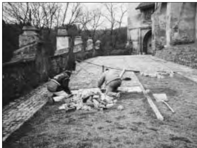
Hrad Křivoklát, zádlažba přístupové komunikace k bradu, provedla firma Česká žula, s. r. o. (foto z archivu bradu Křivokláta).
