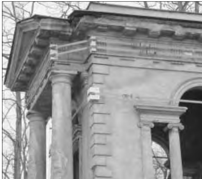
Zámek Veltrusy, zámecký park. Stažení Laudonova pavilonu s osazeným měřicím na trblině. Stabilita stavby byla narušena velkou vodou v srpnu 2002 (foto M. Dropka, srov. obr. na s. 115).
