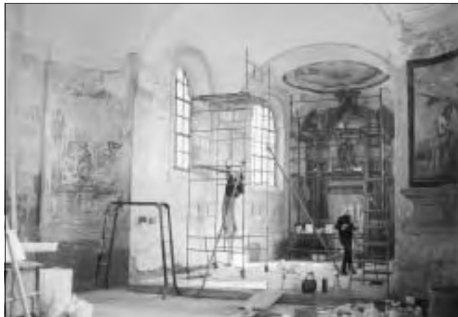
Podbořánky (okres Rakovník), pohled do interiéru kostela sv. Jakuba Většího během restaurování. Obrožený a opuštěný kostel v havarijním stavu se podařilo během několika let za subvencování z Programu zachrany architektonického dědictví zachránit a obnovit. V roce 2002 probíhalo restaurování iluzivních oltářů a výmalba interiéru (foto E. Volfová, 2003).
