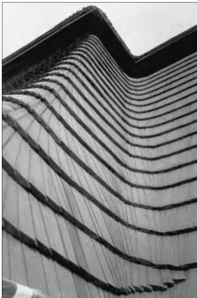
Dráhbudice (okres Kolín), detail úžlabí obnovené šindelové krytiny mansardové střechy kostela Nejsvětější Trojice. Kvalitně položená šindelová krytina nabírající značně poškozenou a chybně položenou krytinu břidličnou, která pokrývala střechu po požáru na sklonku 80. let 20. století. Navrátila se tak původní krytina. Náročná oprava významného pozdně barokního kostela je realizována za podpory z Programu zachrany architektonického dědictví (foto E. Juříková, 2002).
