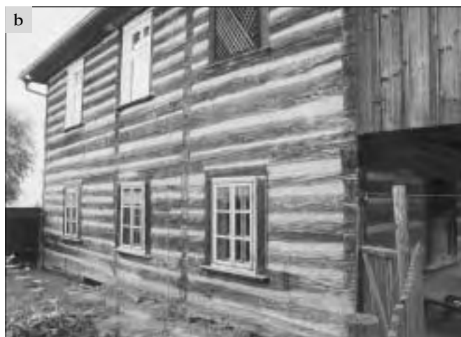
Mnichovo Hradiště (okres Mladá Boleslav), detail stěny domu čp. 7; a – v rámci celkové konzervace a obnovy vnějšího pláště domu byla provedena poměrně náročná výměna vyblitého trámu s parapetními římsami v severním průčelí. Nová protěza byla provedena ze dvou částí fixovaných ocelovými svorníky, překrytými dřevěnými víčky. Do ní byly vsazeny čepy ostění oken a nové parapetní římsy, b – stav po dokončení opravy (foto J. Berková, 2002).
