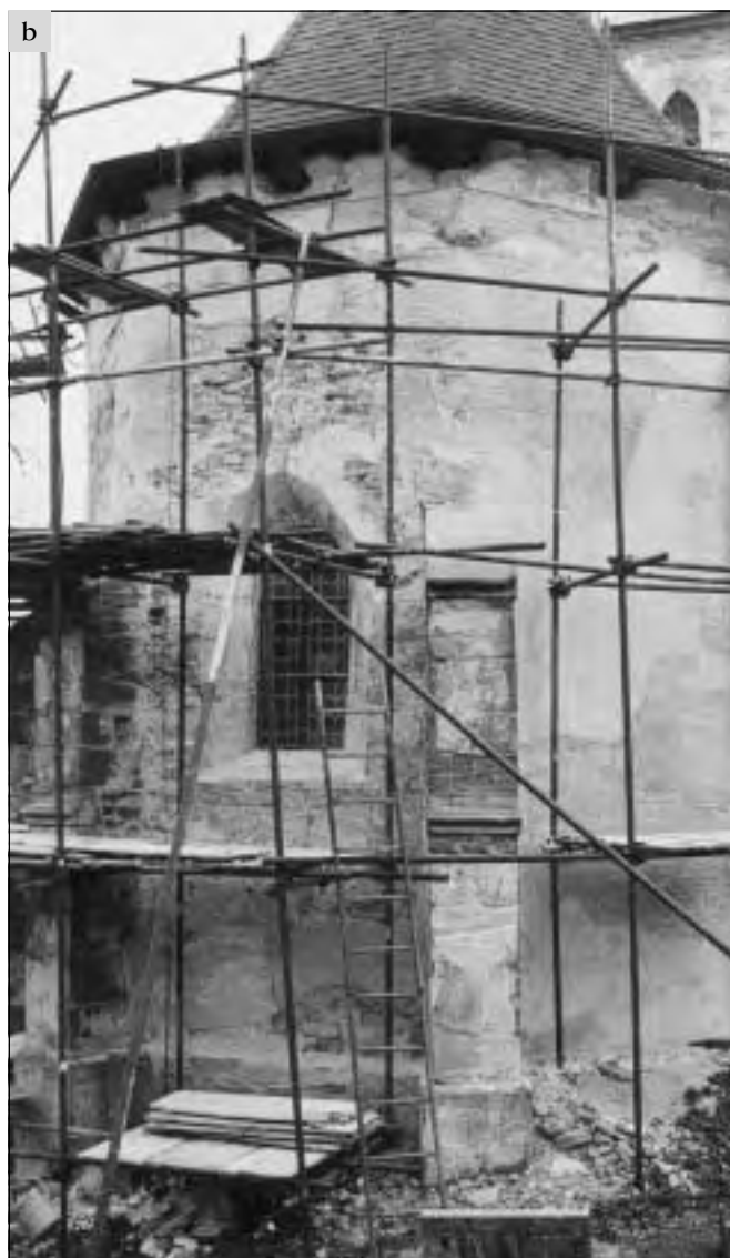
Solec (okres Mladá Boleslav), kostel Nanebevzetí P. Marie; a – detail renesančního sgrafita s dekorativním pásem pod korunní římsou, odhalený restaurátorským průzkumem, b – presbytář po zahájení restaurátorských prací. Na fasádě se uplatňují fragmenty gotických a zejména renesančních omítek včetně barevných úprav, ale i pozdější barokní a regotizační zásahy. Na pravém poli bylo provedeno doplnění omítek v návaznosti na renesanční tak, aby byla v maximální míře respektována autenticita renesančních omítek. Předpokládá se pouze provedení lokálních retuší (foto E. Vyletová, 2002).
