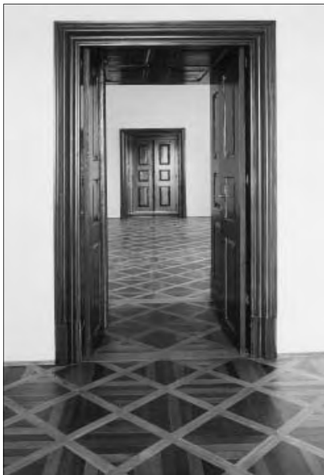
Brandýs nad Labem (okres Praha-východ), pohled do nově rekonstruovaných prostor 1. patra západního křídla a severozápadní věže zámku. V rámci obnovy byly provedeny nové konstrukce podlah, doplněny dveře včetně deštění apod. Prostory budou sloužit pro připravovanou zámeckou expozici (foto J. Žižka, zima 2003).
