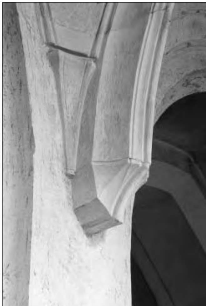
Kutná Hora – Sedlec, bývalý konventní kostel Nanebevzetí P. Marie, detailní pohled na konzolku na sloupu v severním dvoulodí, očištěnou od mladších narušených vrstev. V rámci náročné a rozsáhlé obnovy sedleckého kostela bylo zabájeno i restaurování štukových článků v interiéru (foto J. Žižka, 2002).
