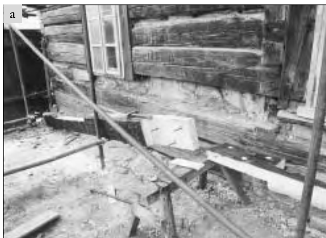
Mnichovo Hradiště (okres Mladá Boleslav), detail stěny domu čp. 7; a – v rámci celkové konzervace a obnovy vnějšího pláště domu byla provedena poměrně náročná výměna vyblitého trámu s parapetními římsami v severním průčelí. Nová protěza byla provedena ze dvou částí fixovaných ocelovými svorníky, překrytými dřevěnými víčky. Do ní byly vsazeny čepy ostění oken a nové parapetní římsy, b – stav po dokončení opravy (foto J. Berková, 2002).
