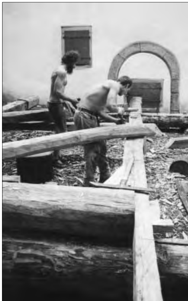
Tesaři firmy Ars Tignaria připravují vazbu nového mostu pro Krakovec na nádvoří hradu Křivoklátu (foto z archivu hradu Křivoklátu).
