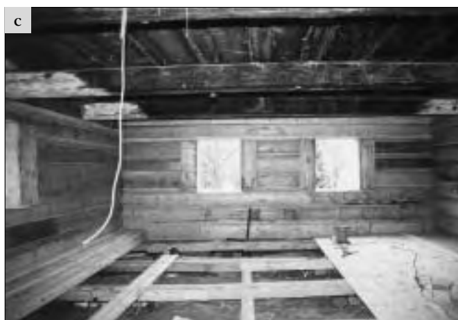
Klucké Chvalovice (okres Kutná Hora), dům čp. 11; a – stěny roubené světnice byly zcela zničené dřevokazným bmyzem a plísněmi, b – stěna dvorního průčelí byla zcela deformovaná, došlo k poklesu stropu a krovu. Před výměnou roubených stěn byla konstrukce stropu a krovu vyrovnána do původní polohy, c – při obnově roubených stěn byly použity tradiční tesařské postupy. Strop byl poté osazen na nové roubené stěny, d – celkový pohled po opravě (foto J. Berková, 2002).
