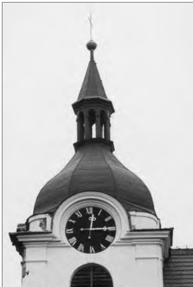
Liblice (okres Mělník), pohled na horní část věže kostela sv. Václava. V nutném rozsahu byly opraveny klempířské konstrukce, atiky i profilace římsy a bylo provedeno jejich překrytí (foto J. Žižka, zima 2003).
