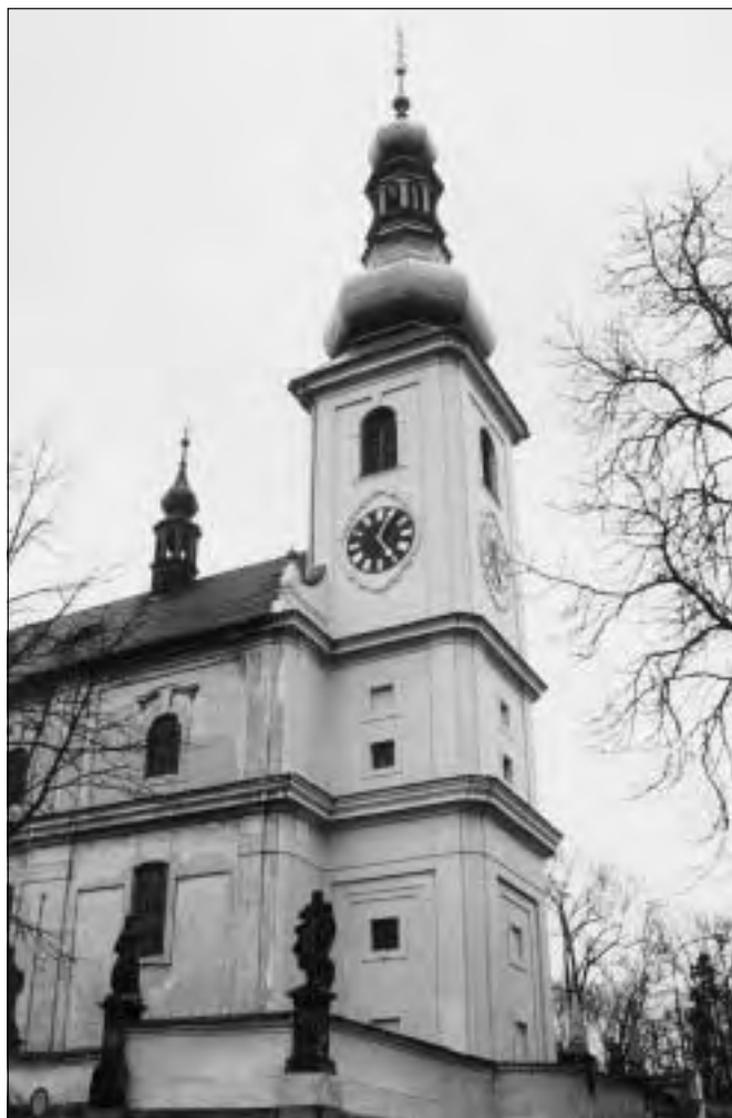
Lysá nad Labem (okres Nymburk), východní věž kostela sv. Jana Křtitele po opravě fasád a bání, jejíž krov byl rozebrán a znovu sestaven. Z původního krovu se bohužel podařilo využít pouze menší část prvků (foto E. Vyletová, 2002).
