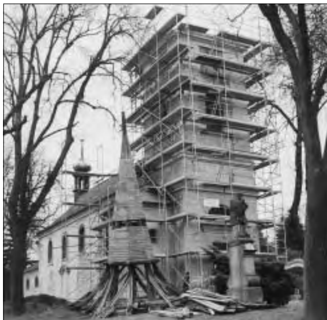
Tuchlovice (okres Kladno), pobled na kostel sv. Havla při opravě věže. Oprava byla prováděna za přispění z bavarijního střešního programu. Konstrukce krovu byla jako celek sejmuta, na zemi opravena a doplněna a vrácena na své místo (foto E. Volfová 2002).
