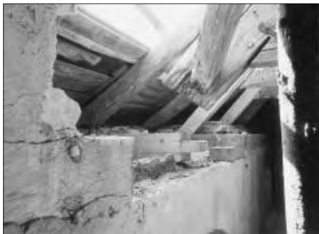
Tuchoměřice (okres Praha-západ), detailní pohled na část krovu s půdní nadezdívkou v křídle se sýpkou. V roce 2002 pokračovala za podpory z Programu záchrany architektonického dědictví oprava bývalé jezuitské rezidence v Tuchoměřicích. Zejména byla realizována oprava krovu nad křídlem se sýpkou. Pozednice i část krokvi zde dodatečně překryla část půdní nadezdívkou, související z úpravami při přestavbě původně obytné stavby na sýpku. Nadezdívky bylo nutné postupně opatrně rozebírat a provádět obnovu a protézování zcela shnilých prvků krovu (foto J. Žižka, 2002)
