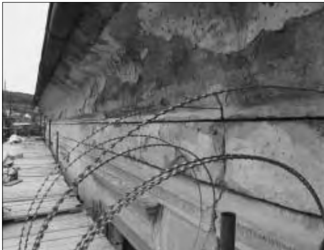
Zámek v Mníšku pod Brdy, kde pokračovaly práce na zajištění stability severního a západního křídla. Snímek zachycuje práce na stažení objektu pomocí uložených prutů Heli-systému (foto M. Dropka).
