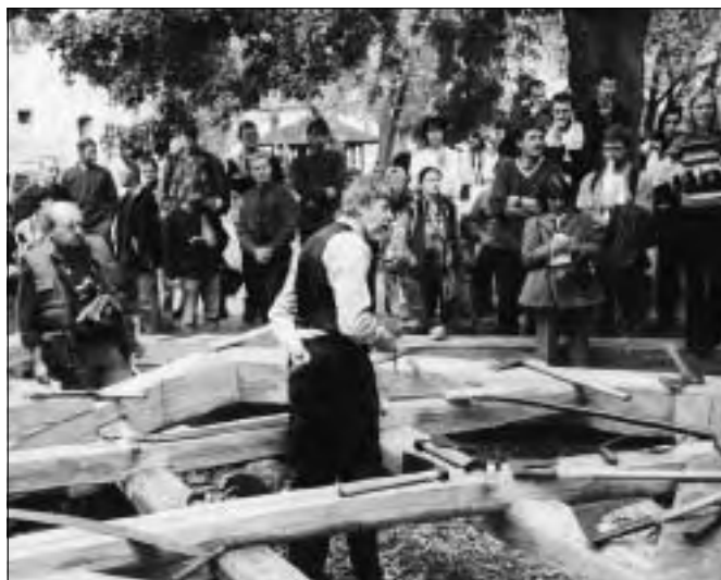
Odborný seminář společnosti STOP, který proběhl na hradě Křivoklátě 19. 9. 2002 na téma „Netradiční způsoby oprav tesařských konstrukcí“ – ukázka tesání konstrukce nového mostu na hrad Krakovec (foto z archivu hradu Křivoklátu).
