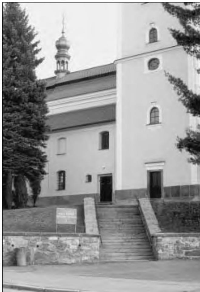
Votice (okres Benešov), detailní pohled na část severní fasády kostela sv. Václava. Ve dvou stavebních sezónách se za vydatné podpory z Programu záchrany architektonického dědictví podařilo obnovit střechu věže i celého kostela a provést opravu fasád. Fasády si zachovaly poměrně jednoduchou úpravu, danou relativně novodobou kompletní výměnou někdejších barokních omítek (foto J. Žížka, zima 2003).
