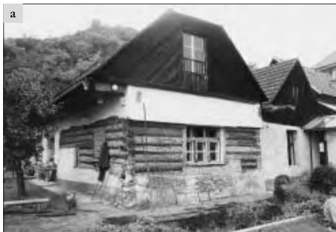
Roztoky (okres Rakovník), a – celkový pohled na dům čp. 17 po odstranění mladších plent a omítek, b – interiér světnice po odstranění mladších úprav povrchu stěn (foto J. Mrázek).
