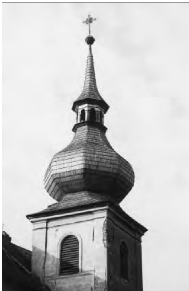
Zbyslav (okres Kutná Hora), střecha věže kostela Nejsvětější Trojice po opravě. Mobutný barokní kostel s dvojicí věží v průčelí se po dlouhé době chátrání dočkal, a to zejména díky přístupu duchovního správce, zabývající opravy, podpořené z havarijního střešního programu. Obnovená šindelová krytina věže patří mezi zdařilé akce v kraji (foto K. Kibic ml., 2002).
