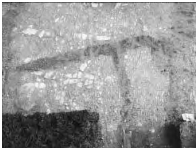
Žleby (okres Kutná Hora), pohled na odkrytou dlažbu v nádvoří zámku. Na začátku stavební sezóny byly realizovány úpravy vnitřního žlebského nádvoří. Po sejmutí vrchních novodobých vrstev byla odkryta ve značném rozsahu štětová dlažba, renesančního nebo barokního původu. Dlažba byla opět překryta mlatovou vrstvou z barevné drti, odpovídající úpravě povrchu z doby romantické přestavby zámku (foto J. Žižka 2002).
