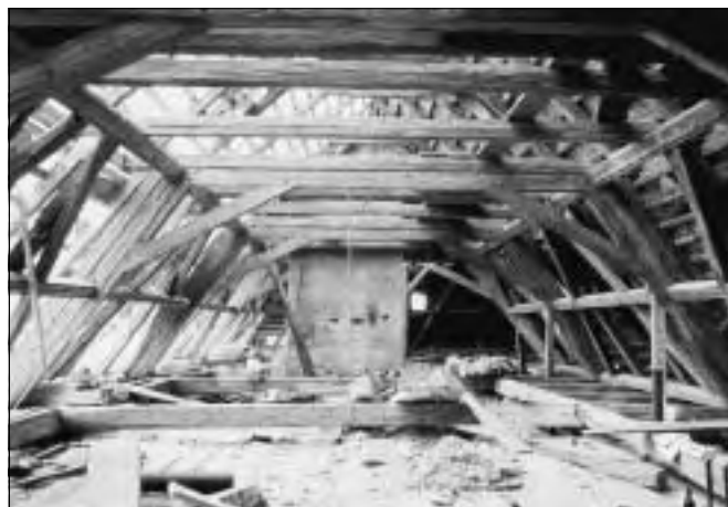
Liteň (okres Beroun), pobled do krovu mansardové střechy západního křídla zámku. V roce 2002 probíhala za určité podpory z havarijního střešního programu oprava krovové konstrukce zámku. Jako obvykle bylo nutné provést rozsáhlé opravy v oblasti pozednice. Při opravě byl prováděn operativní průzkum, který zachytil zbytky renesančních stropů a původní barokní úpravu, kdy fasádu ukončoval rytmus zblaví vazných trámů (foto J. Žižka 2002).
