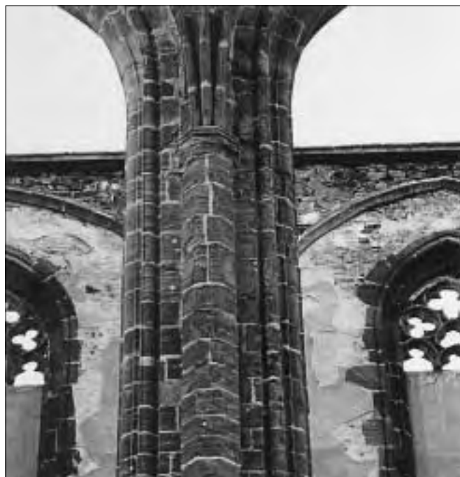
Sázava, torzo kostela sv. Prokopa. Restaurátorské a konzervační práce na kamenném zdivu navázaly na výsledky průzkumu a zkušenosti získané během 1. etapy prací v roce 1999. Práce 2. etapy zahrnovaly zásahy na 1. klenebním poli a 1. sloupu severní části torza kostela, které je zhotoveno z červené nučické arkózy, jež patří k nejméně stabilním borninám s nízkou odolností vůči prostředí. Na snímku je část 1. sloupu po restaurování, které provedli P. Justa a J. Novotný za finančního přispění z Programu záchrany architektonického dědictví (foto restaurátora, 2002).
