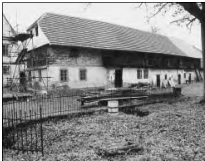
Vrátno (okres Mladá Boleslav), dům čp. 28. Častým problémem při obnově střech je požadavek vlastníků na celkovou výměnu krytiny, ačkoli její větší část by mohla ještě dobře sloužit. Obnova střechy na domě čp. 28 ve Vrátně je příkladem postupu, při kterém byla většina tašek přebrána, očištěna a po obnově krovu opět použita. Pouze menší část plochy byla doplněna novými taškami (foto J. Berková).
