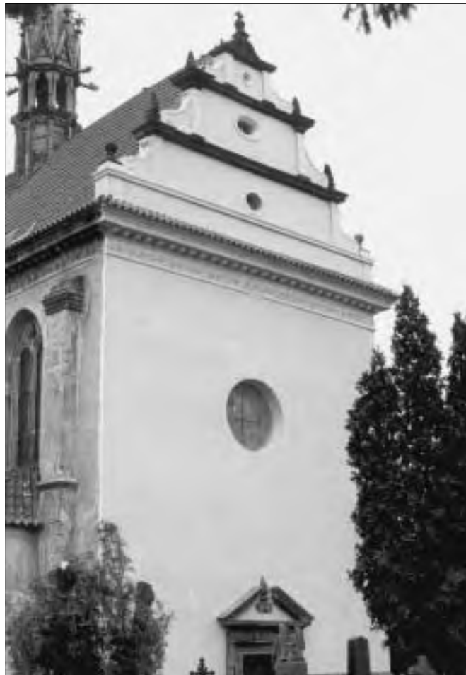
Velvary (okres Kladno), pohled na západní štít kostela sv. Jiří. V roce 2002 byla realizována náročná oprava štítu kostela se zazděnou, zcela zničenou vazbou krovu. Při následující obnově fasády se vcelku kvalitně podařilo opravit štukovou výzdobu vlysu. Ostatní členění západního průčelí již dávno zaniklo. Výsledek nepříznivě poznamenala oprava kamenných říms s přežívajícím a těžko pochopitelným nešvarem – přízpůsobením celého povrchu lokálně zčernalým místům. Úprava, provedená v rozporu s odbornými požadavky a navíc technologicky obtížně odstranitelným způsobem, je ilustrací jednoho z problémů, se kterými se památkář setkává a který ztěžuje jeho práci. S neprofesionálním přístupem pracovníků firmy – tak jako v tomto případě, se lze bohužel stále setkat i tam, kde by vzhledem k dlouhodobé praxi bylo možné očekávat kvalitní výsledek (foto J. Žizka, zima 2003).
